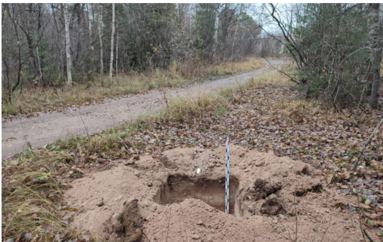
Рис.156. «Газопровод распределительный в пгт Арбаж Арбажского муниципального округа Кировской области» в пгт Арбаж Арбажского муниципального округа Кировской области. Шурф 14. Антураж. Вид с Ю.
