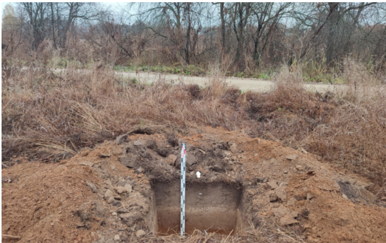
Рис.121. «Газопровод распределительный в пгт Арбаж Арбажского муниципального округа Кировской области» в пгт Арбаж Арбажского муниципального округа Кировской области. Шурф 7. Антураж. Вид с Ю.
