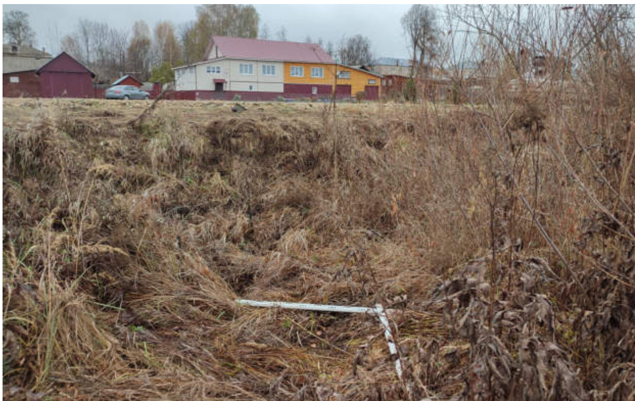
Рис.160. «Газопровод распределительный в пгт Арбаж Арбажского муниципального округа Кировской области» в пгт Арбаж Арбажского муниципального округа Кировской области. Шурф 15. Закладка. Вид с Ю.
