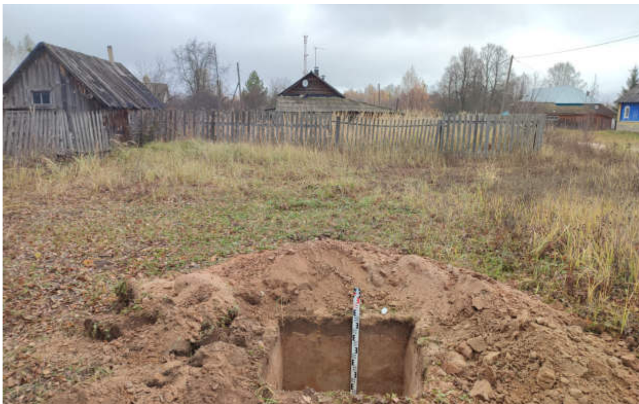
Рис.136. «Газопровод распределительный в пгт Арбаж Арбажского муниципального округа Кировской области» в пгт Арбаж Арбажского муниципального округа Кировской области. Шурф 10. Антураж. Вид с Ю.
