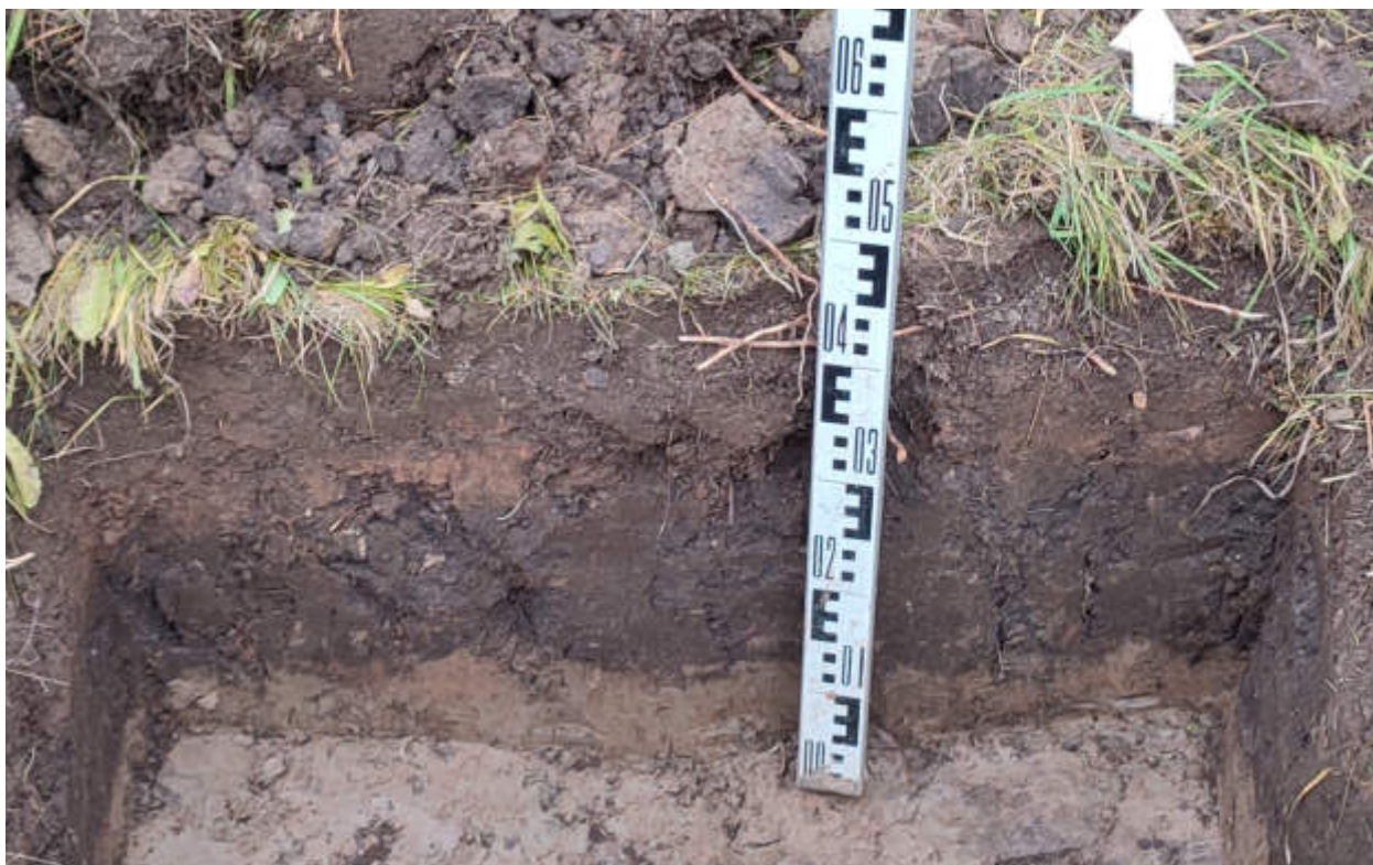
Рис.202. «Газопровод распределительный в пгт Арбаж Арбажского муниципального округа Кировской области» в пгт Арбаж Арбажского муниципального округа Кировской области. Шурф 23. Северный борт. Вид с Ю.
