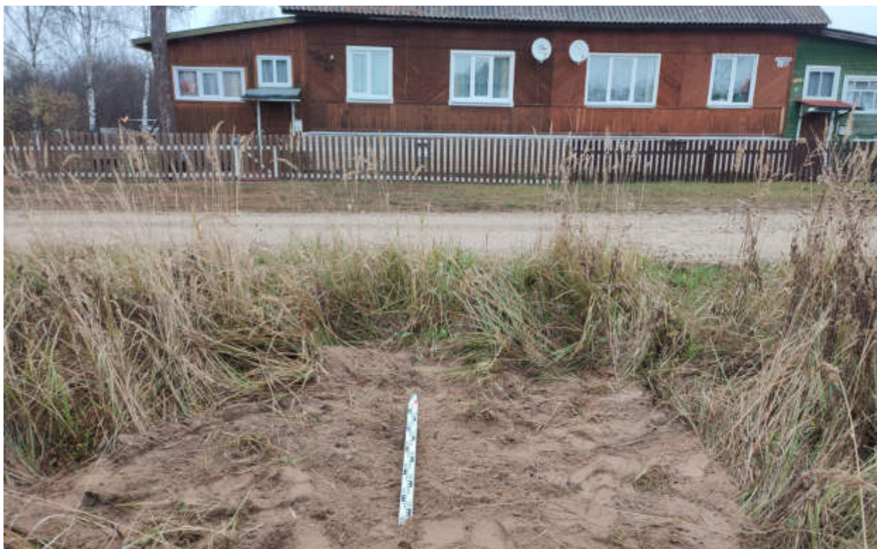
Рис.129. «Газопровод распределительный в пгт Арбаж Арбажского муниципального округа Кировской области» в пгт Арбаж Арбажского муниципального округа Кировской области. Шурф 8. Рекультивация. Вид с Ю.
