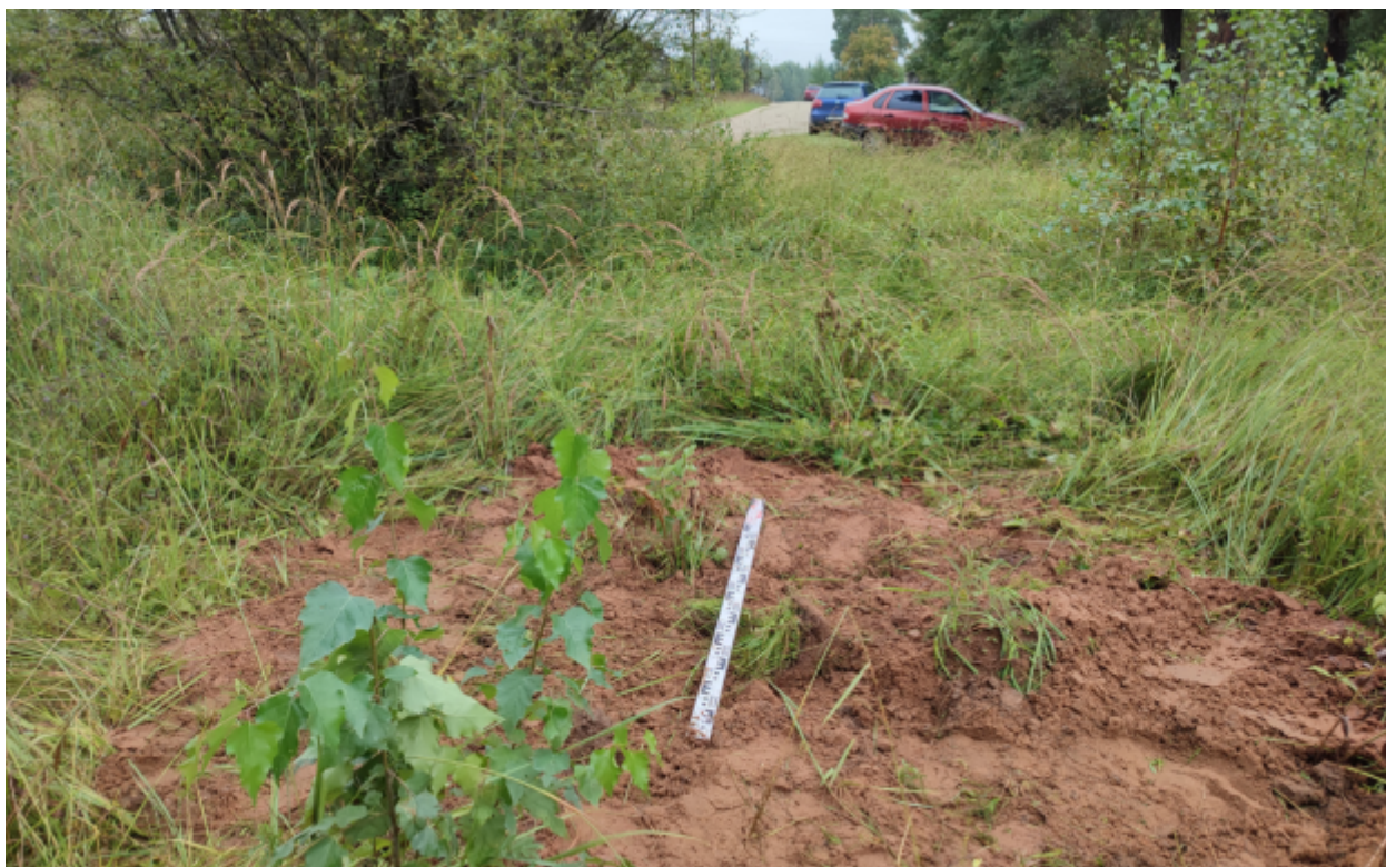
Рис.254. «Газопровод распределительный в пгт Арбаж Арбажского муниципального округа Кировской области» в пгт Арбаж Арбажского муниципального округа Кировской области. Шурф 33. Рекультивация. Вид с Ю.
