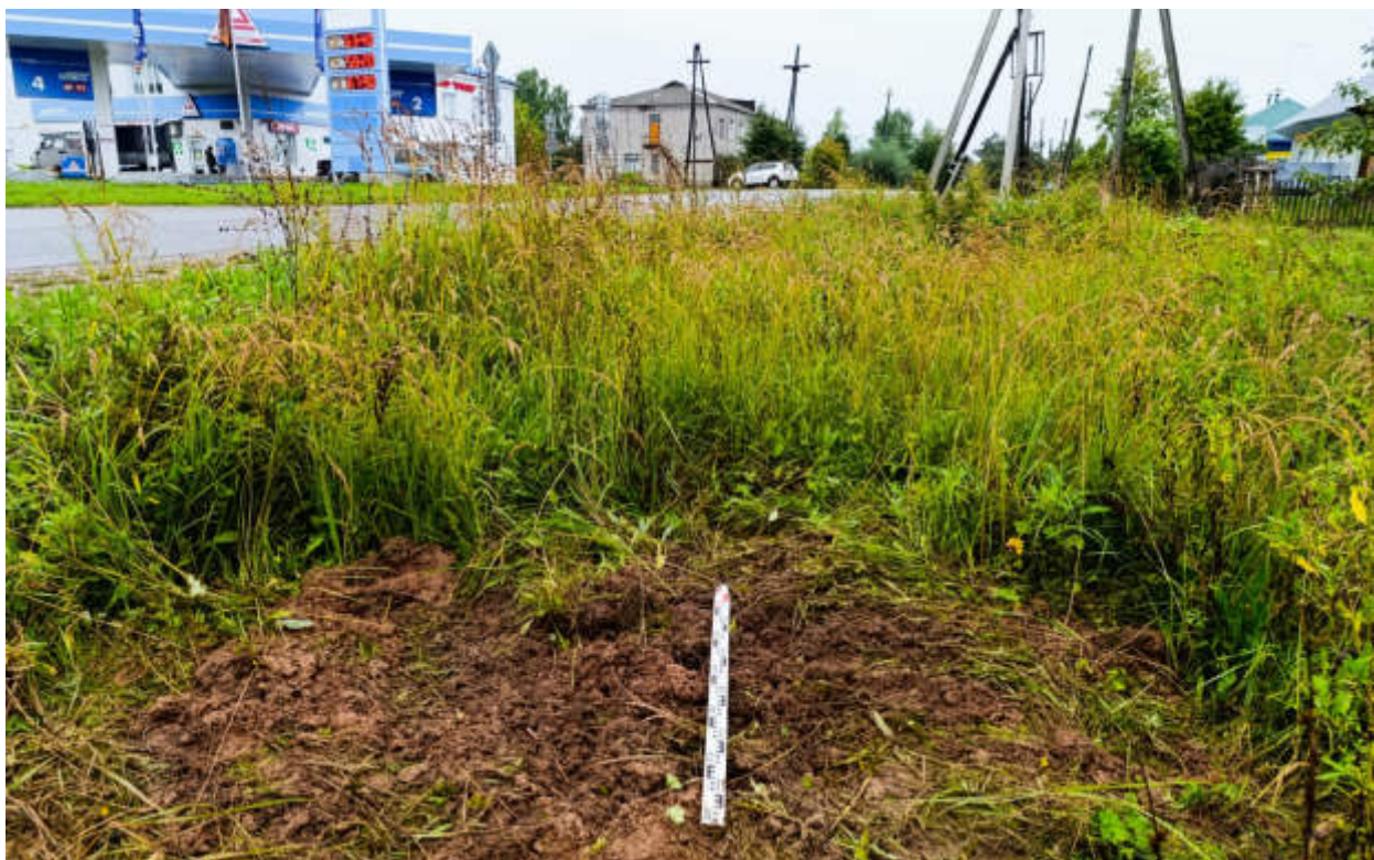
Рис.269. «Газопровод распределительный в пгт Арбаж Арбажского муниципального округа Кировской области» в пгт Арбаж Арбажского муниципального округа Кировской области. Шурф 36. Рекультивация. Вид с Ю.
