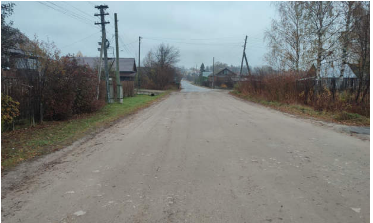
Рис.32. «Газопровод распределительный в пгт Арбаж Арбажского муниципального округа Кировской области» в пгт Арбаж Арбажского муниципального округа Кировской области. Рельеф местности и характер растительности участка обследования. Точка фотофиксации 3, вид с ССВ.
