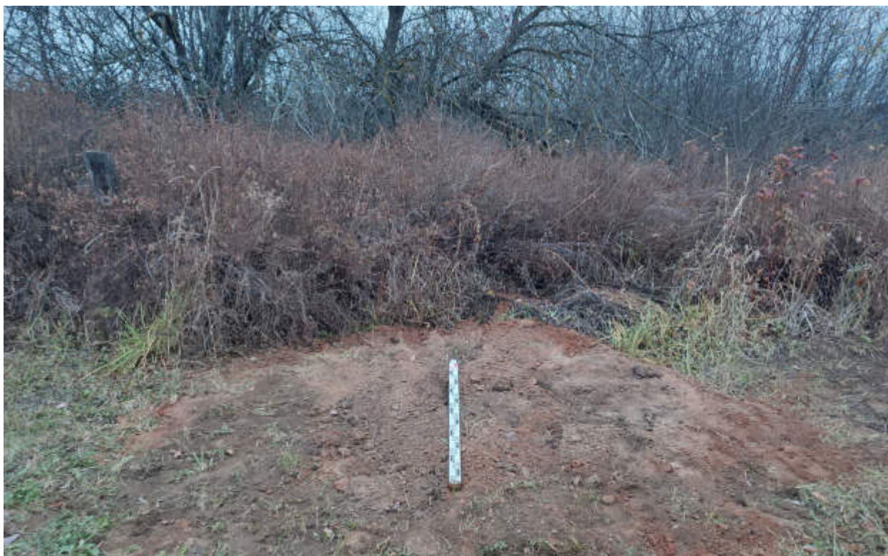
Рис.224. «Газопровод распределительный в пгт Арбаж Арбажского муниципального округа Кировской области» в пгт Арбаж Арбажского муниципального округа Кировской области. Шурф 27. Рекультивация. Вид с Ю.
