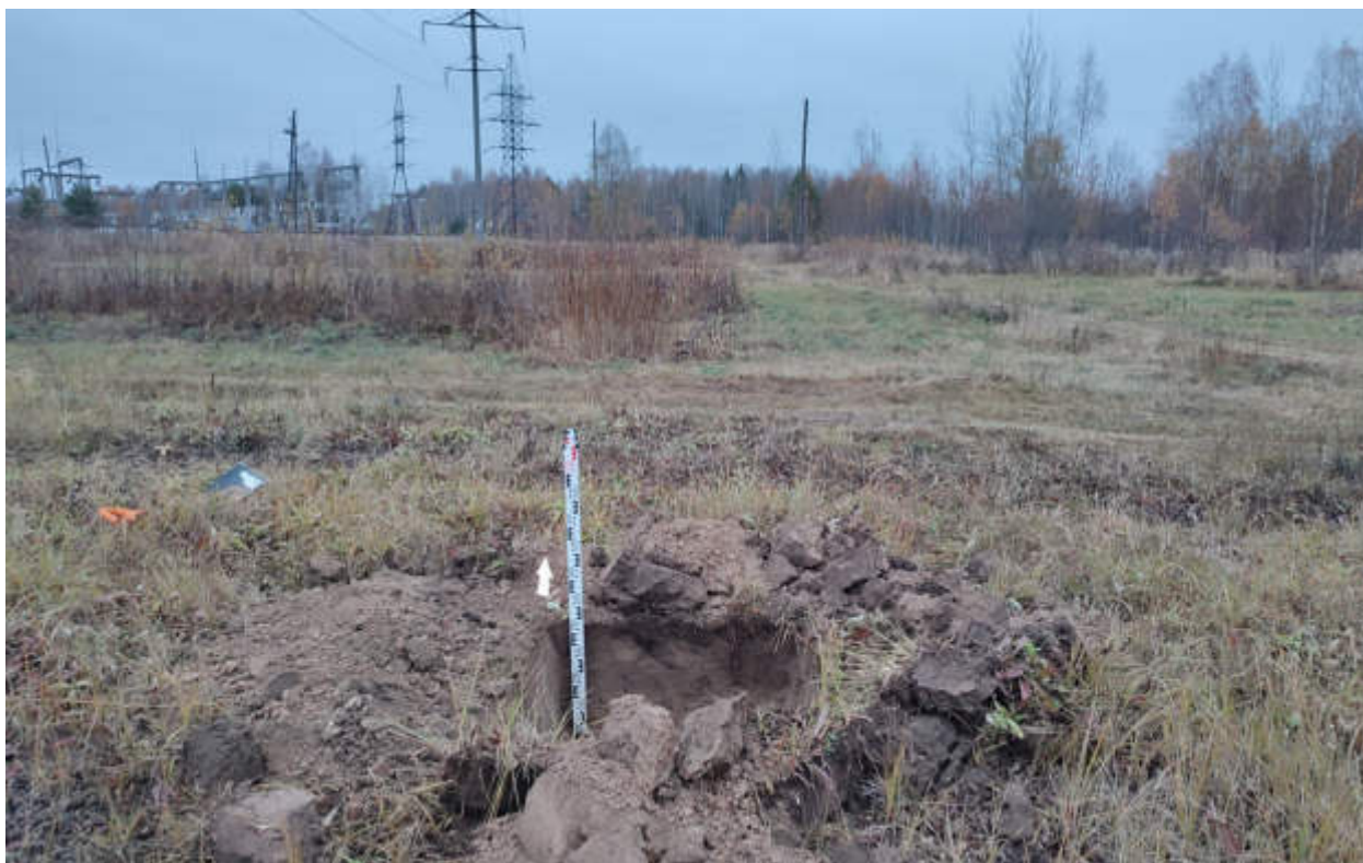
Рис.191. «Газопровод распределительный в пгт Арбаж Арбажского муниципального округа Кировской области» в пгт Арбаж Арбажского муниципального округа Кировской области. Шурф 21. Антураж. Вид с Ю.
