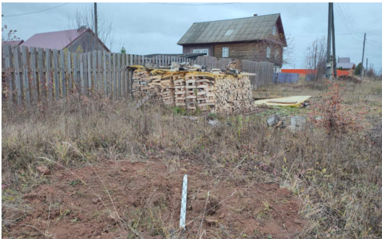
Рис.219. «Газопровод распределительный в пгт Арбаж Арбажского муниципального округа Кировской области» в пгт Арбаж Арбажского муниципального округа Кировской области. Шурф 26. Рекультивация. Вид с Ю.
