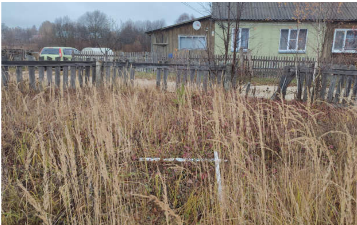
Рис.115. «Газопровод распределительный в пгт Арбаж Арбажского муниципального округа Кировской области» в пгт Арбаж Арбажского муниципального округа Кировской области. Шурф 6. Закладка. Вид с Ю.
