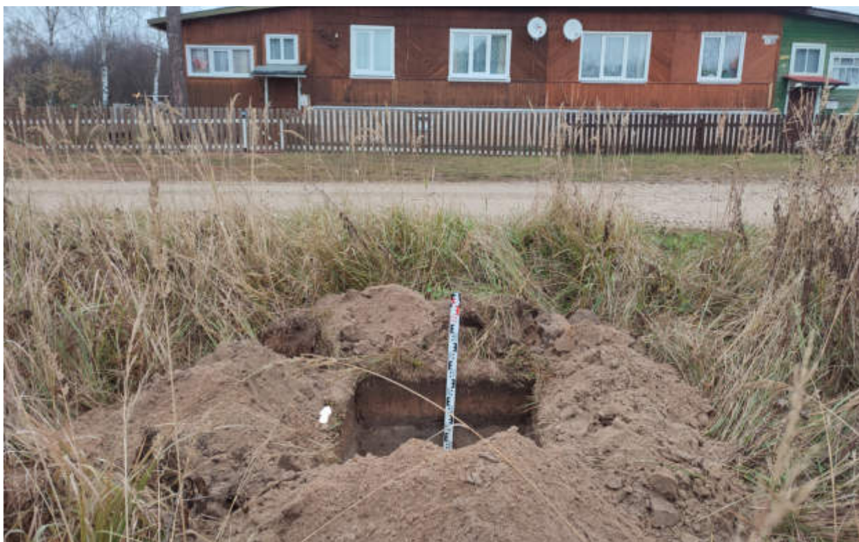
Рис.126. «Газопровод распределительный в пгт Арбаж Арбажского муниципального округа Кировской области» в пгт Арбаж Арбажского муниципального округа Кировской области. Шурф 8. Антураж. Вид с Ю.
