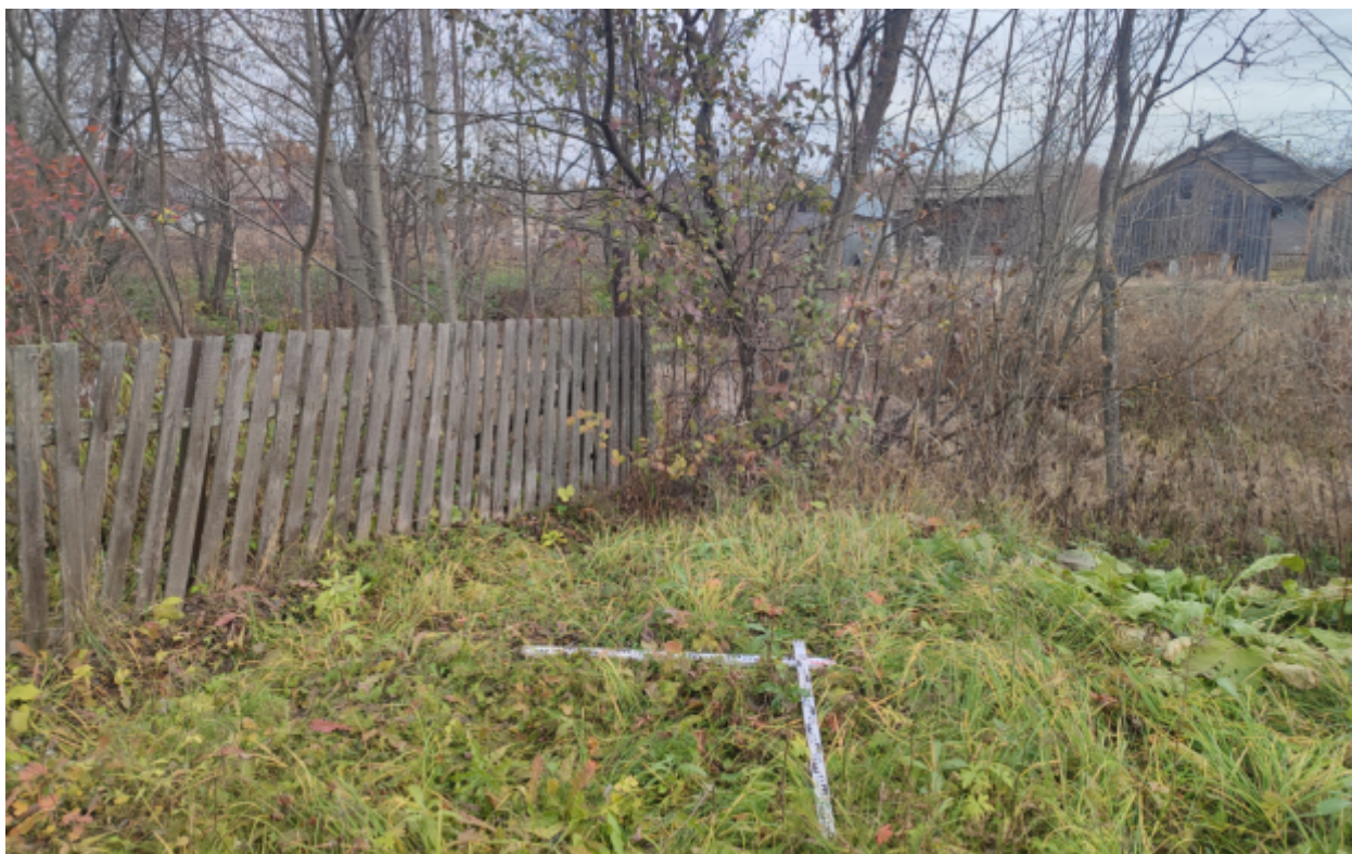
Рис.230. «Газопровод распределительный в пгт Арбаж Арбажского муниципального округа Кировской области» в пгт Арбаж Арбажского муниципального округа Кировской области. Шурф 29. Закладка. Вид с Ю.
