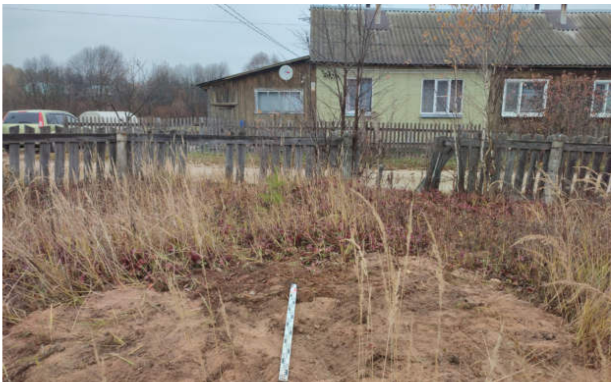
Рис.119. «Газопровод распределительный в пгт Арбаж Арбажского муниципального округа Кировской области» в пгт Арбаж Арбажского муниципального округа Кировской области. Шурф 6. Рекультивация. Вид с Ю.
