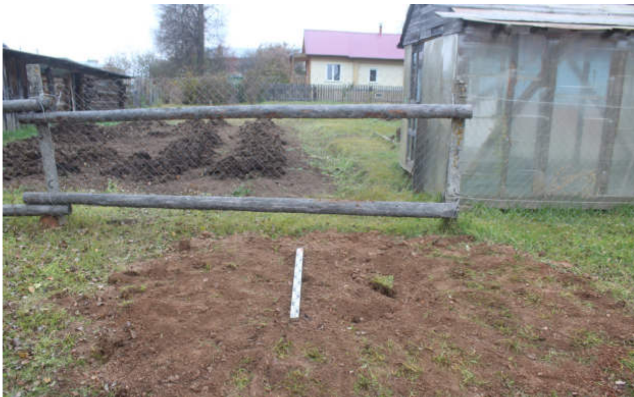
Рис.199. «Газопровод распределительный в пгт Арбаж Арбажского муниципального округа Кировской области» в пгт Арбаж Арбажского муниципального округа Кировской области. Шурф 22. Рекультивация. Вид с Ю.
