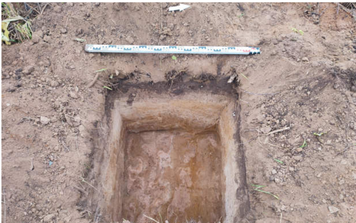
Рис.183. «Газопровод распределительный в пгт Арбаж Арбажского муниципального округа Кировской области» в пгт Арбаж Арбажского муниципального округа Кировской области. Шурф 19. Материк. Вид с В.
