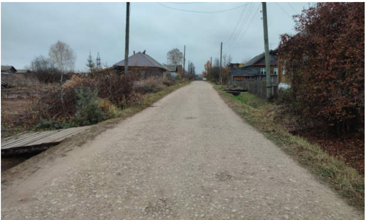
Рис.59. «Газопровод распределительный в пгт Арбаж Арбажского муниципального округа Кировской области» в пгт Арбаж Арбажского муниципального округа Кировской области. Рельеф местности и характер растительности участка обследования. Точка фотофиксации 30, вид с ЗСЗ.
