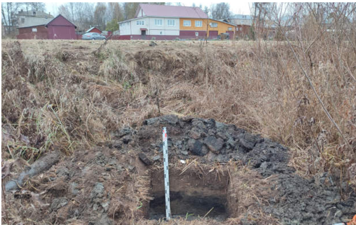
Рис.161. «Газопровод распределительный в пгт Арбаж Арбажского муниципального округа Кировской области» в пгт Арбаж Арбажского муниципального округа Кировской области. Шурф 15. Антураж. Вид с Ю.
