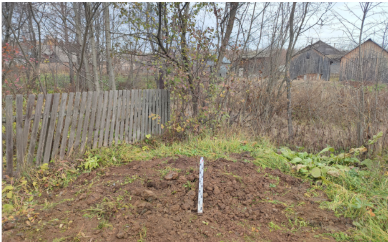
Рис.234. «Газопровод распределительный в пгт Арбаж Арбажского муниципального округа Кировской области» в пгт Арбаж Арбажского муниципального округа Кировской области. Шурф 29. Рекультивация. Вид с Ю.
