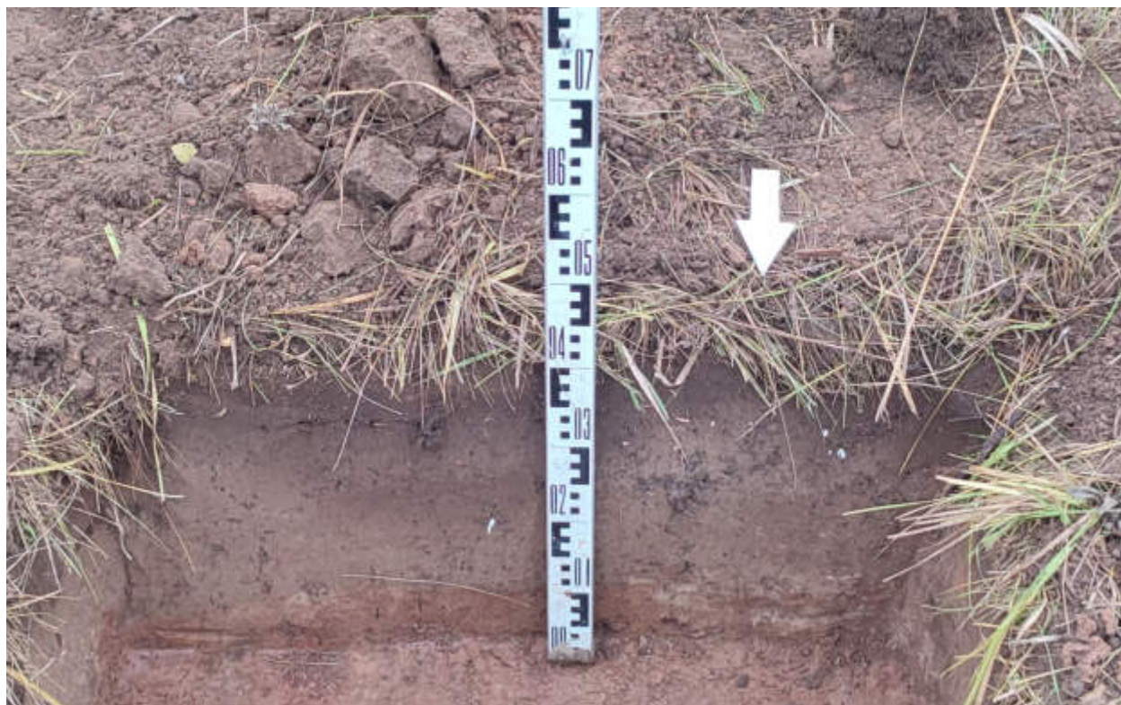
Рис.212. «Газопровод распределительный в пгт Арбаж Арбажского муниципального округа Кировской области» в пгт Арбаж Арбажского муниципального округа Кировской области. Шурф 25. Южный борт. Вид с С.
