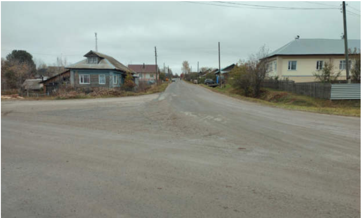
Рис.58. «Газопровод распределительный в пгт Арбаж Арбажского муниципального округа Кировской области» в пгт Арбаж Арбажского муниципального округа Кировской области. Рельеф местности и характер растительности участка обследования. Точка фотофиксации 29, вид с ЮЮВ.
