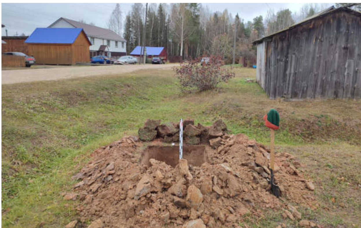
Рис.151. «Газопровод распределительный в пгт Арбаж Арбажского муниципального округа Кировской области» в пгт Арбаж Арбажского муниципального округа Кировской области. Шурф 13. Антураж. Вид с Ю.
