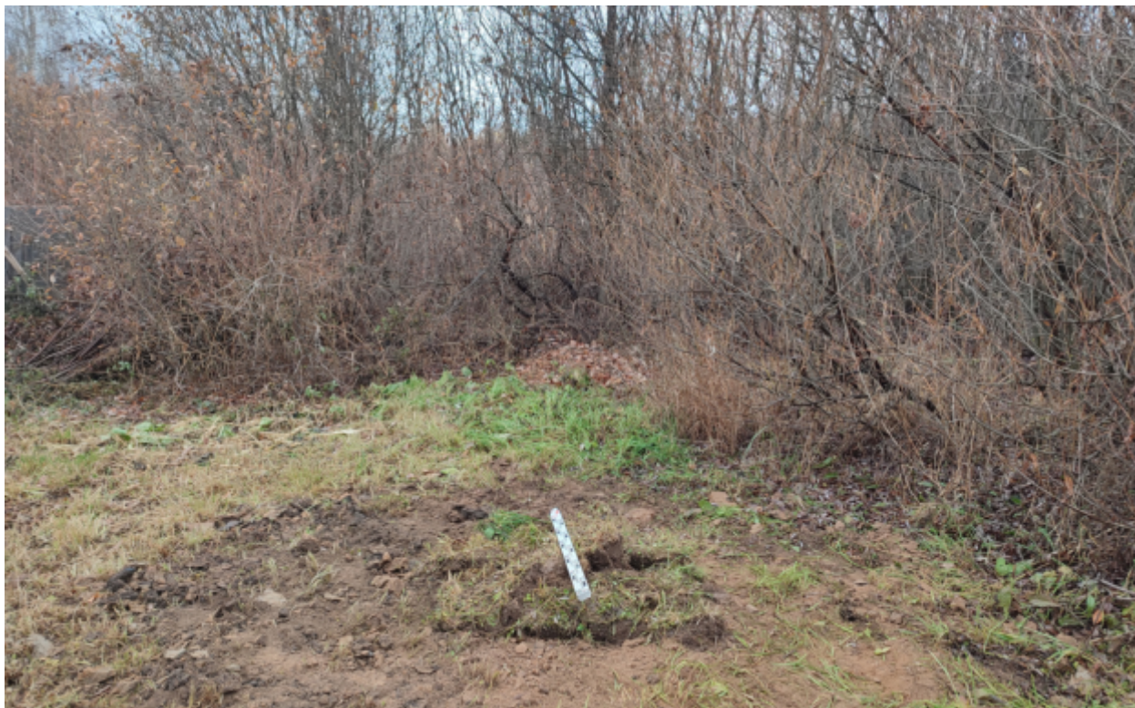
Рис.134. «Газопровод распределительный в пгт Арбаж Арбажского муниципального округа Кировской области» в пгт Арбаж Арбажского муниципального округа Кировской области. Шурф 9. Рекультивация. Вид с Ю.
