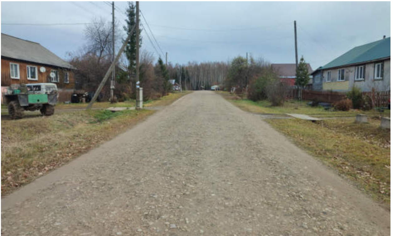
Рис.82. «Газопровод распределительный в пгт Арбаж Арбажского муниципального округа Кировской области» в пгт Арбаж Арбажского муниципального округа Кировской области. Рельеф местности и характер растительности участка обследования. Точка фотофиксации 53, вид с ЮЗ.
