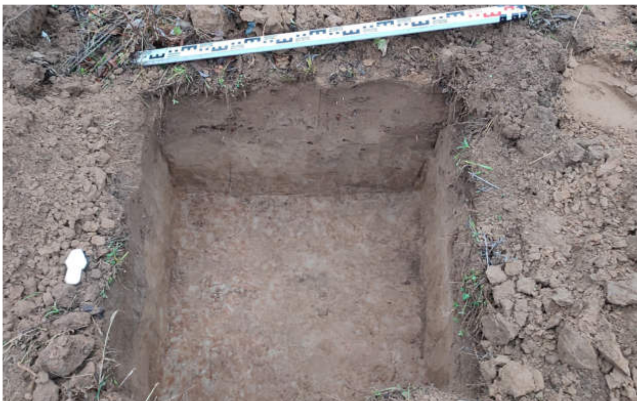
Рис.188. «Газопровод распределительный в пгт Арбаж Арбажского муниципального округа Кировской области» в пгт Арбаж Арбажского муниципального округа Кировской области. Шурф 20. Материк. Вид с Ю.
