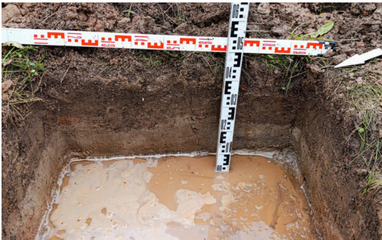
Рис.267. «Газопровод распределительный в пгт Арбаж Арбажского муниципального округа Кировской области» в пгт Арбаж Арбажского муниципального округа Кировской области. Шурф 36. Восточный борт. Вид с 3.
