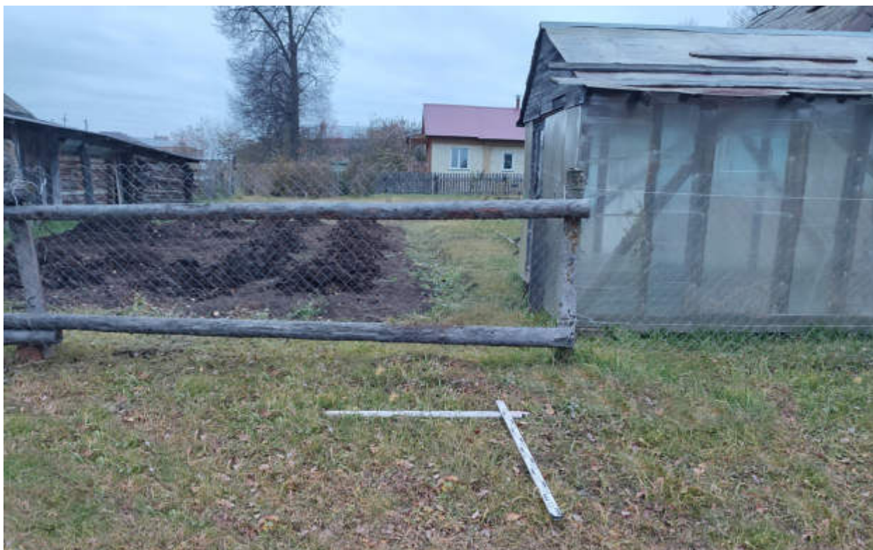
Рис.195. «Газопровод распределительный в пгт Арбаж Арбажского муниципального округа Кировской области» в пгт Арбаж Арбажского муниципального округа Кировской области. Шурф 22. Закладка. Вид с Ю.
