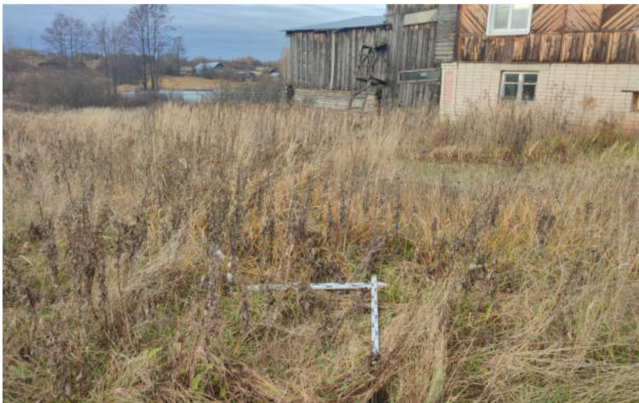
Рис.205. «Газопровод распределительный в пгт Арбаж Арбажского муниципального округа Кировской области» в пгт Арбаж Арбажского муниципального округа Кировской области. Шурф 24. Закладка. Вид с Ю.
