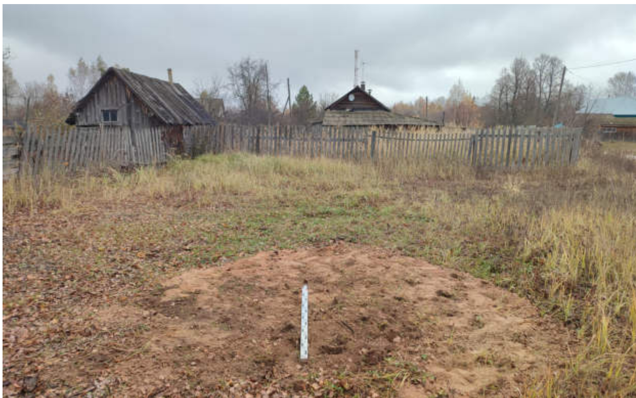
Рис.139. «Газопровод распределительный в пгт Арбаж Арбажского муниципального округа Кировской области» в пгт Арбаж Арбажского муниципального округа Кировской области. Шурф 10. Рекультивация. Вид с Ю.
