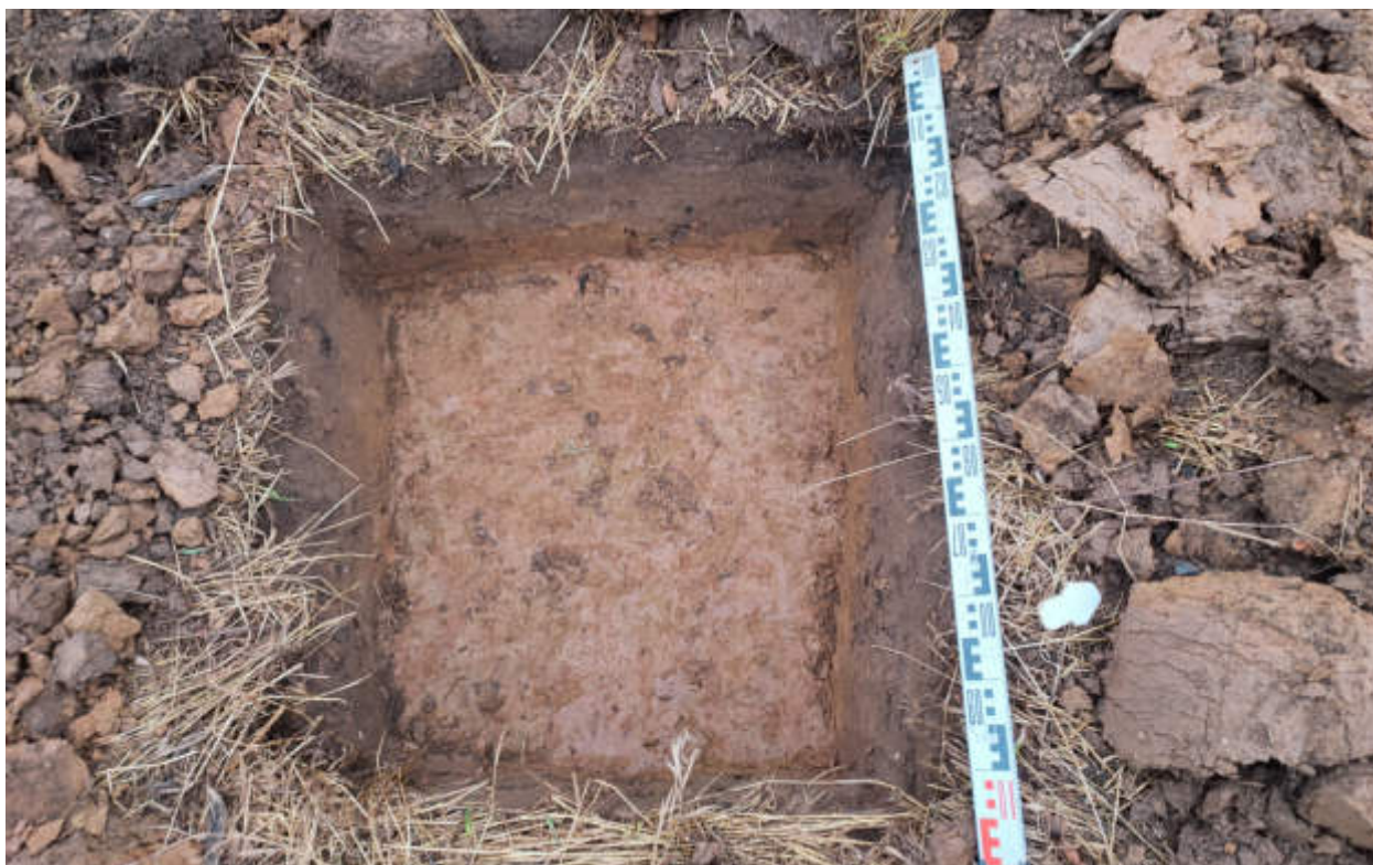
Рис.173. «Газопровод распределительный в пгт Арбаж Арбажского муниципального округа Кировской области» в пгт Арбаж Арбажского муниципального округа Кировской области. Шурф 17. Материк. Вид с В.
