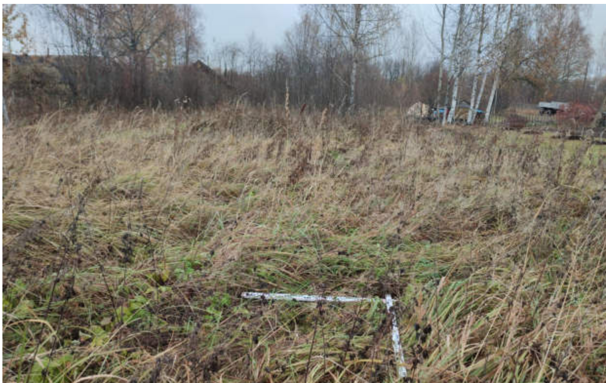
Рис.140. «Газопровод распределительный в пгт Арбаж Арбажского муниципального округа Кировской области» в пгт Арбаж Арбажского муниципального округа Кировской области. Шурф 11. Закладка. Вид с Ю.
