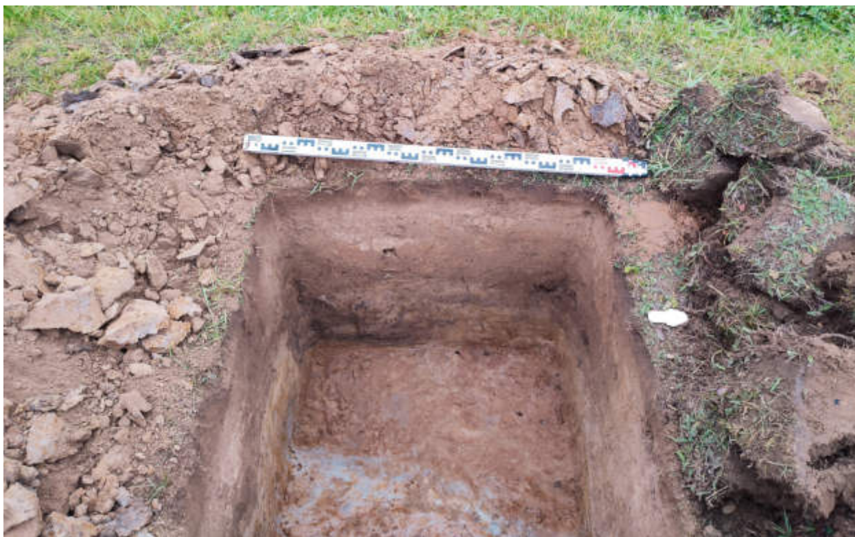
Рис.153. «Газопровод распределительный в пгт Арбаж Арбажского муниципального округа Кировской области» в пгт Арбаж Арбажского муниципального округа Кировской области. Шурф 13. Материк. Вид с В.
