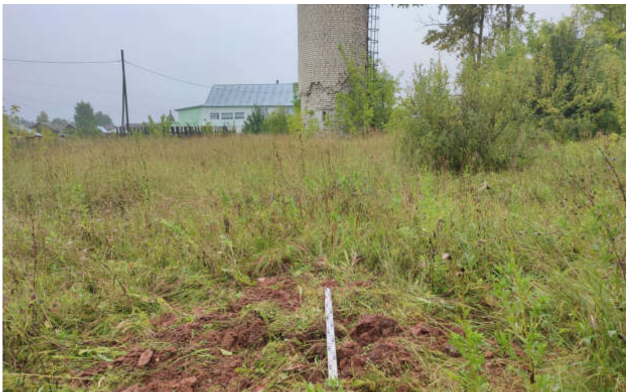
Рис.264. «Газопровод распределительный в пгт Арбаж Арбажского муниципального округа Кировской области» в пгт Арбаж Арбажского муниципального округа Кировской области. Шурф 35. Рекультивация. Вид с Ю.
