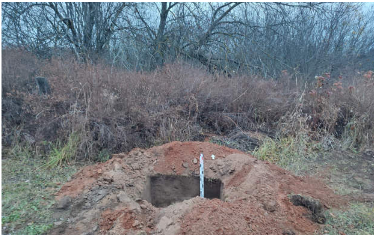
Рис.221. «Газопровод распределительный в пгт Арбаж Арбажского муниципального округа Кировской области» в пгт Арбаж Арбажского муниципального округа Кировской области. Шурф 27. Антураж. Вид с Ю.
