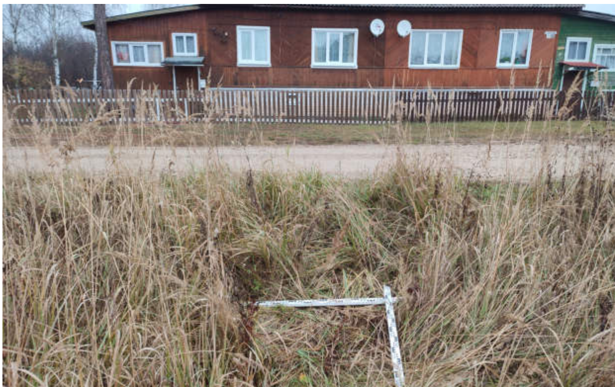
Рис.125. «Газопровод распределительный в пгт Арбаж Арбажского муниципального округа Кировской области» в пгт Арбаж Арбажского муниципального округа Кировской области. Шурф 8. Закладка. Вид с Ю.
