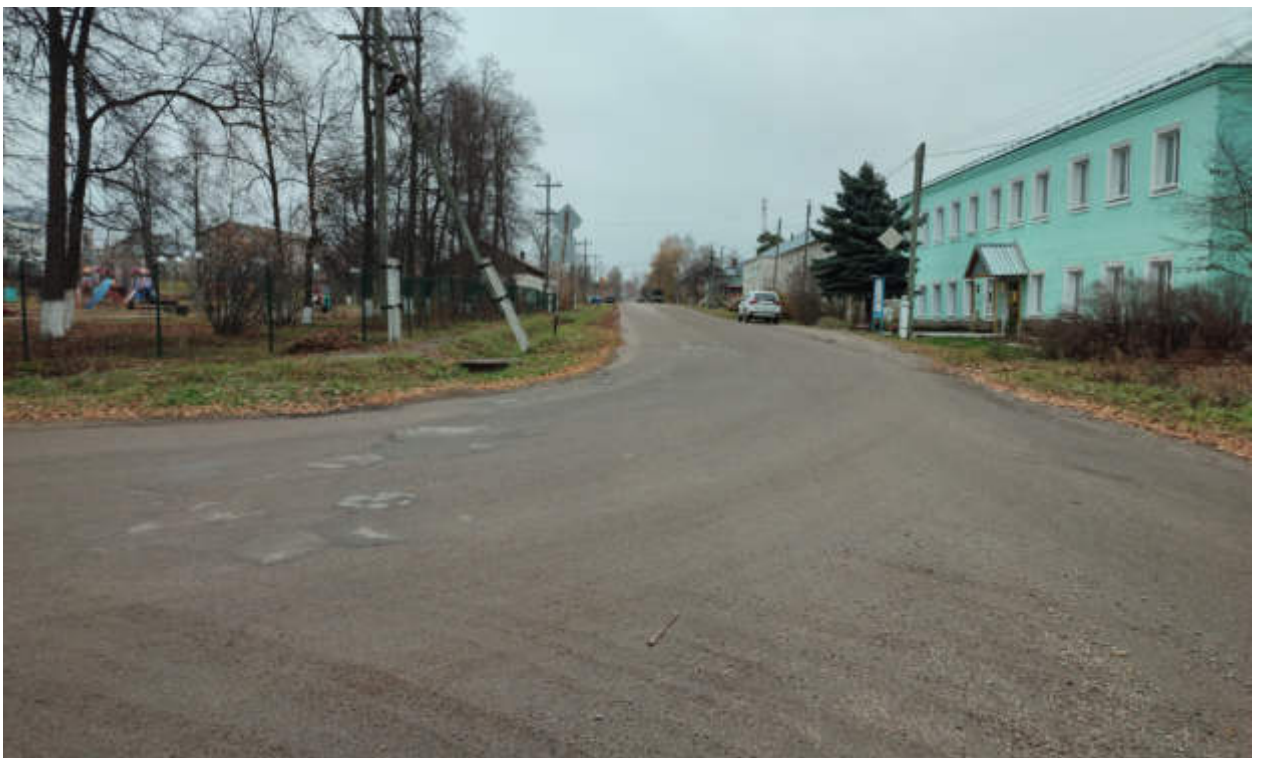
Рис.79. «Газопровод распределительный в пгт Арбаш Арбашского муниципального округа Кировской области» в пгт Арбаш Арбашского муниципального округа Кировской области. Рельеф местности и характер растительности участка обследования. Точка фотофиксации 50, вид с ЗЮЗ.
