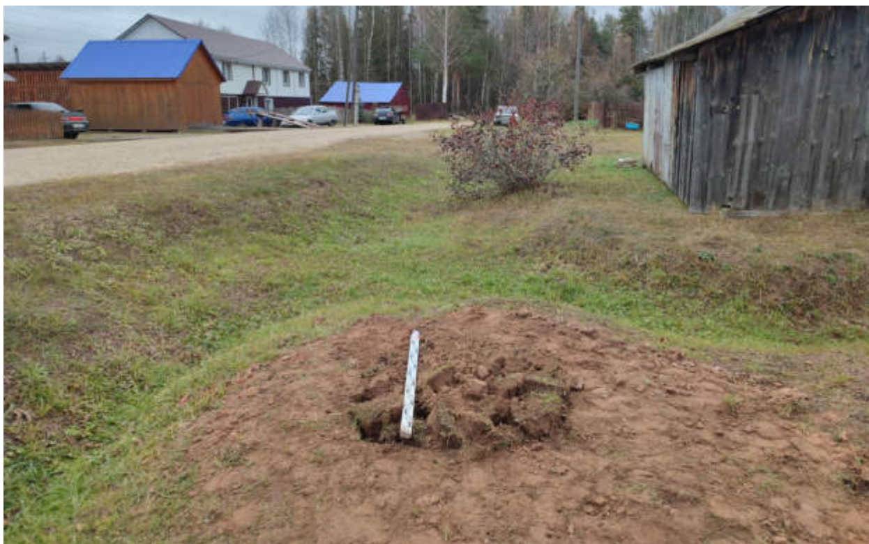
Рис.154. «Газопровод распределительный в пгт Арбаж Арбажского муниципального округа Кировской области» в пгт Арбаж Арбажского муниципального округа Кировской области. Шурф 13. Рекультивация. Вид с Ю.
