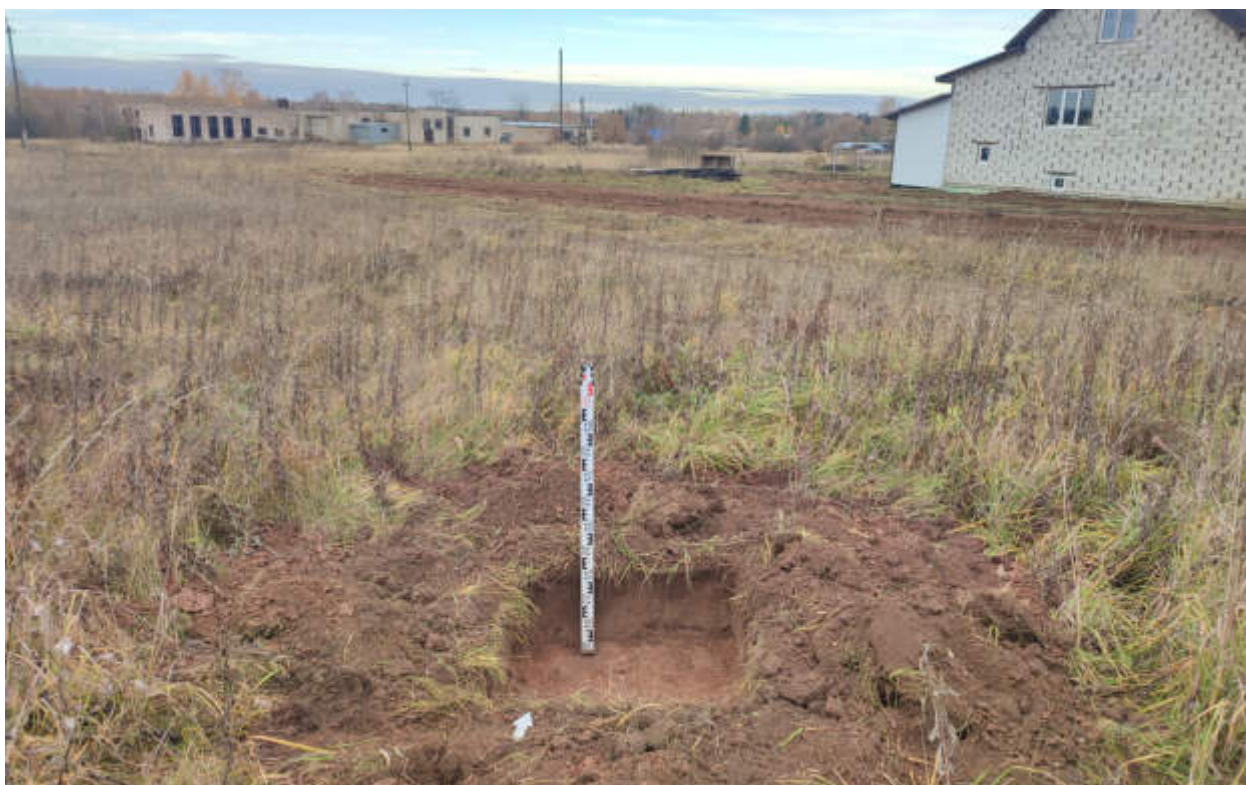
Рис.211. «Газопровод распределительный в пгт Арбаж Арбажского муниципального округа Кировской области» в пгт Арбаж Арбажского муниципального округа Кировской области. Шурф 25. Антураж. Вид с Ю.
