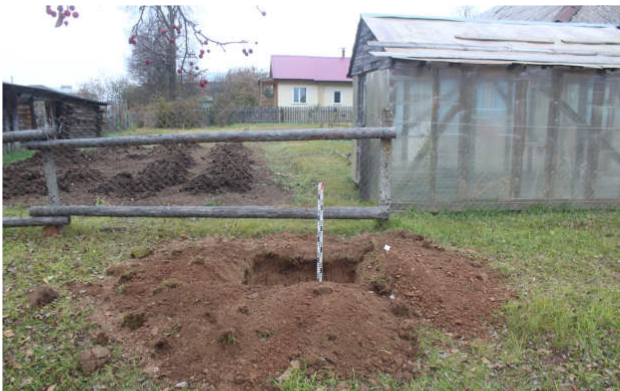
Рис.196. «Газопровод распределительный в пгт Арбаж Арбажского муниципального округа Кировской области» в пгт Арбаж Арбажского муниципального округа Кировской области. Шурф 22. Антураж. Вид с Ю.
