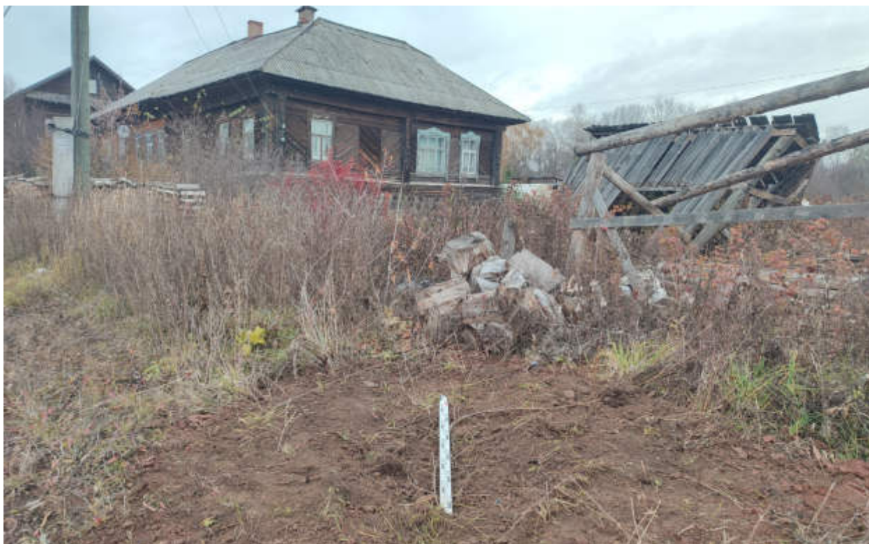
Рис.179. «Газопровод распределительный в пгт Арбаз Арбазского муниципального округа Кировской области» в пгт Арбаз Арбазского муниципального округа Кировской области. Шурф 18. Рекультивация. Вид с Ю.
