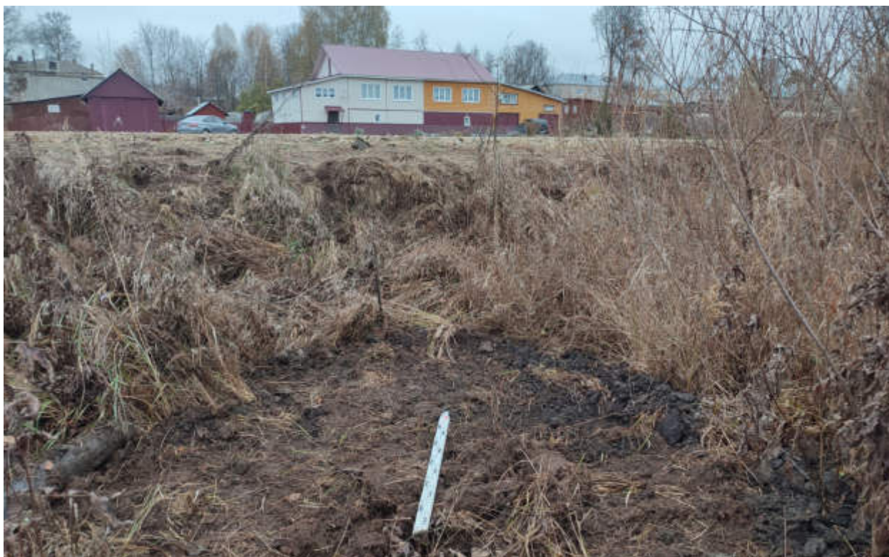
Рис.164. «Газопровод распределительный в пгт Арбаж Арбажского муниципального округа Кировской области» в пгт Арбаж Арбажского муниципального округа Кировской области. Шурф 15. Рекультивация. Вид с Ю.
