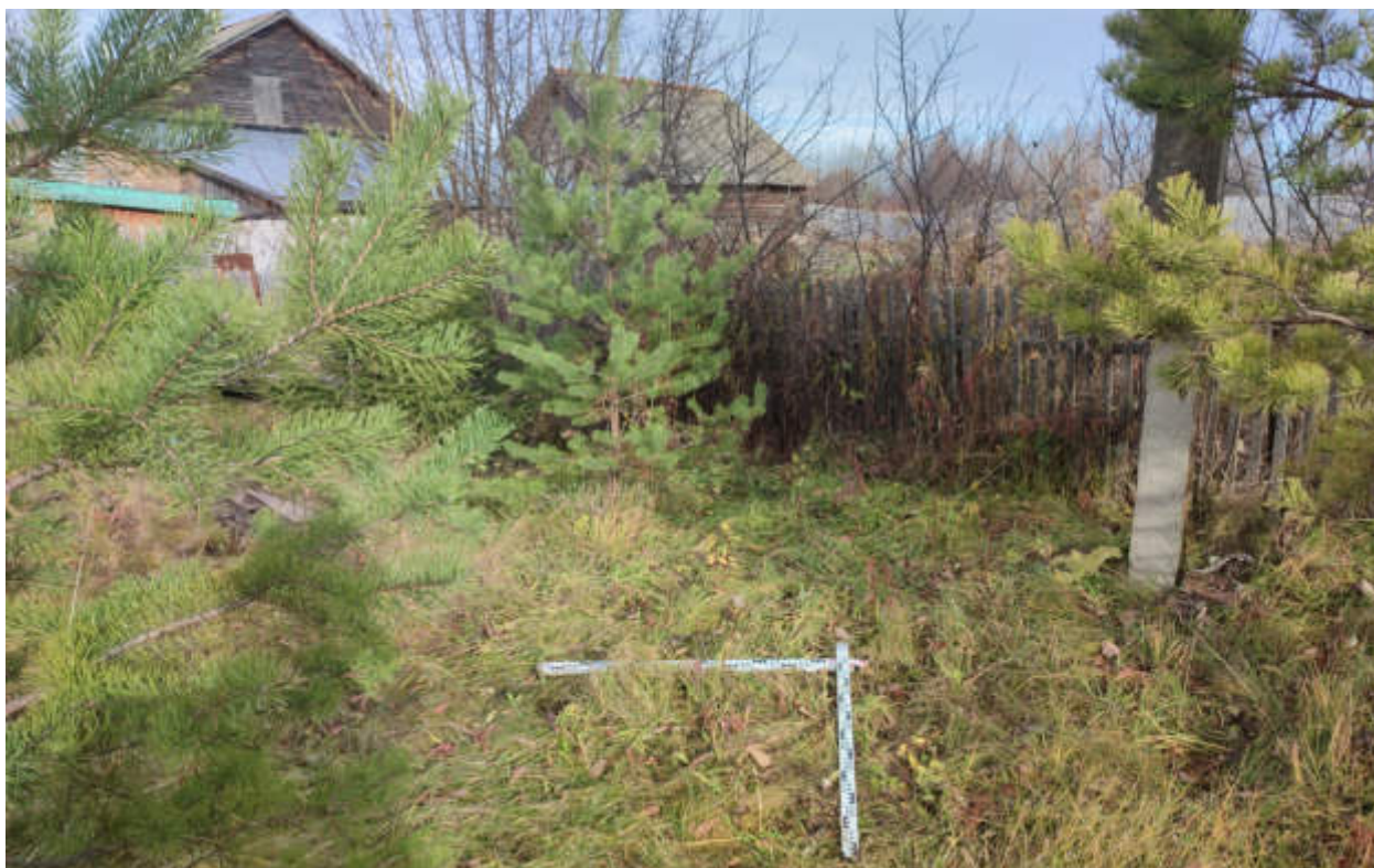
Рис.200. «Газопровод распределительный в пгт Арбаж Арбажского муниципального округа Кировской области» в пгт Арбаж Арбажского муниципального округа Кировской области. Шурф 23. Закладка. Вид с Ю.
