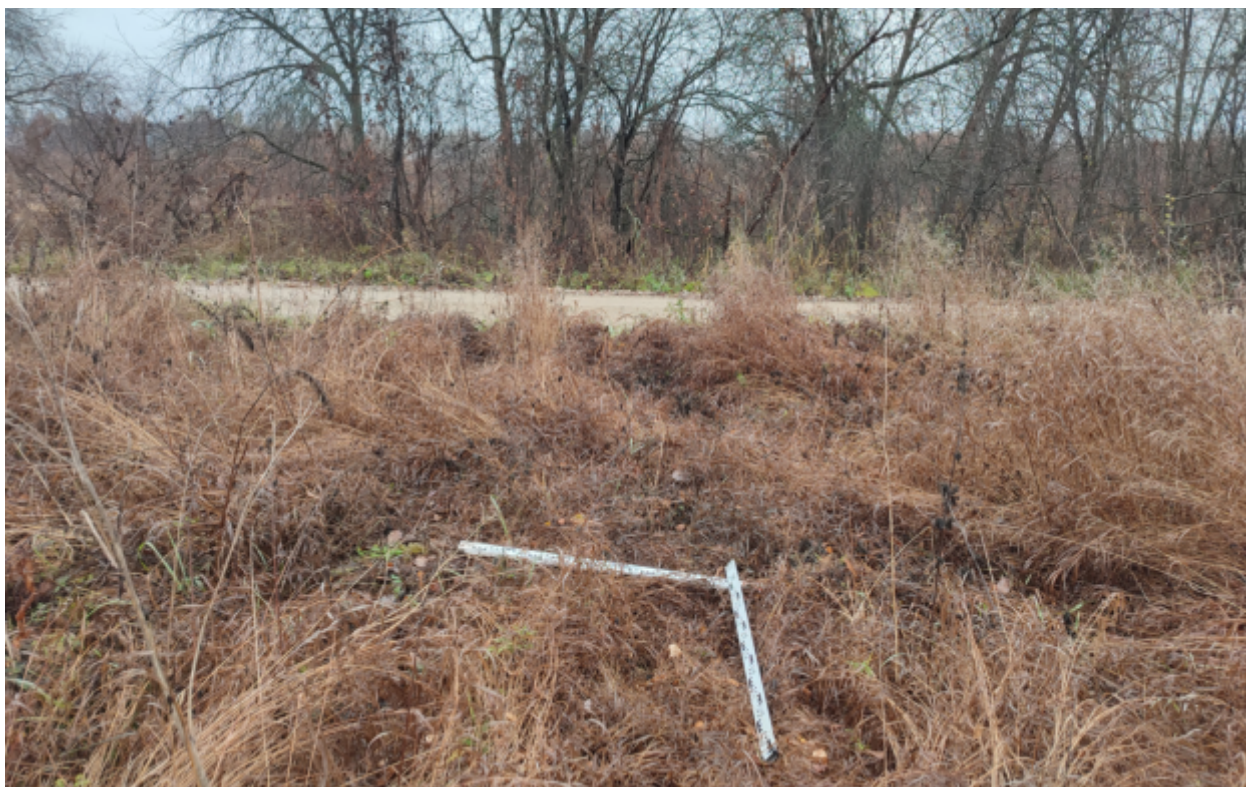
Рис.120. «Газопровод распределительный в пгт Арбаж Арбажского муниципального округа Кировской области» в пгт Арбаж Арбажского муниципального округа Кировской области. Шурф 7. Закладка. Вид с Ю.
