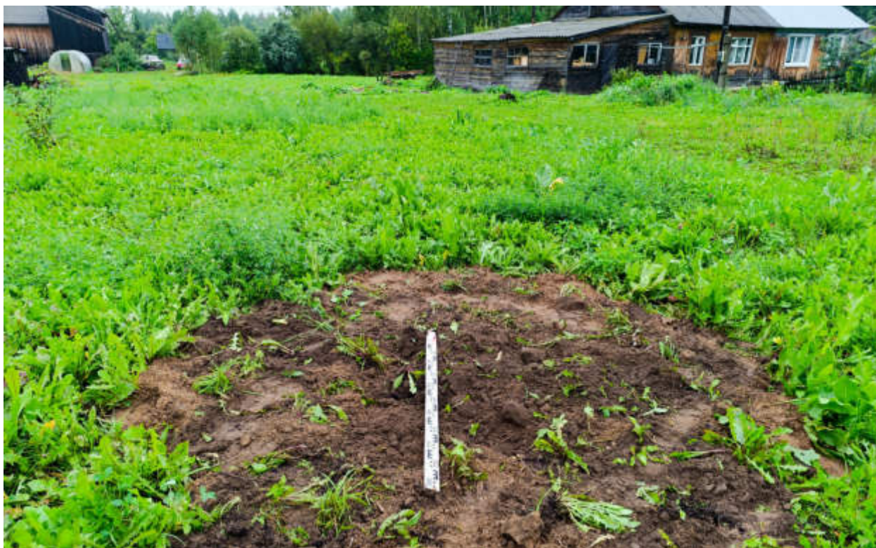
Рис.259. «Газопровод распределительный в пгт Арбаж Арбажского муниципального округа Кировской области» в пгт Арбаж Арбажского муниципального округа Кировской области. Шурф 34. Рекультивация. Вид с Ю.
