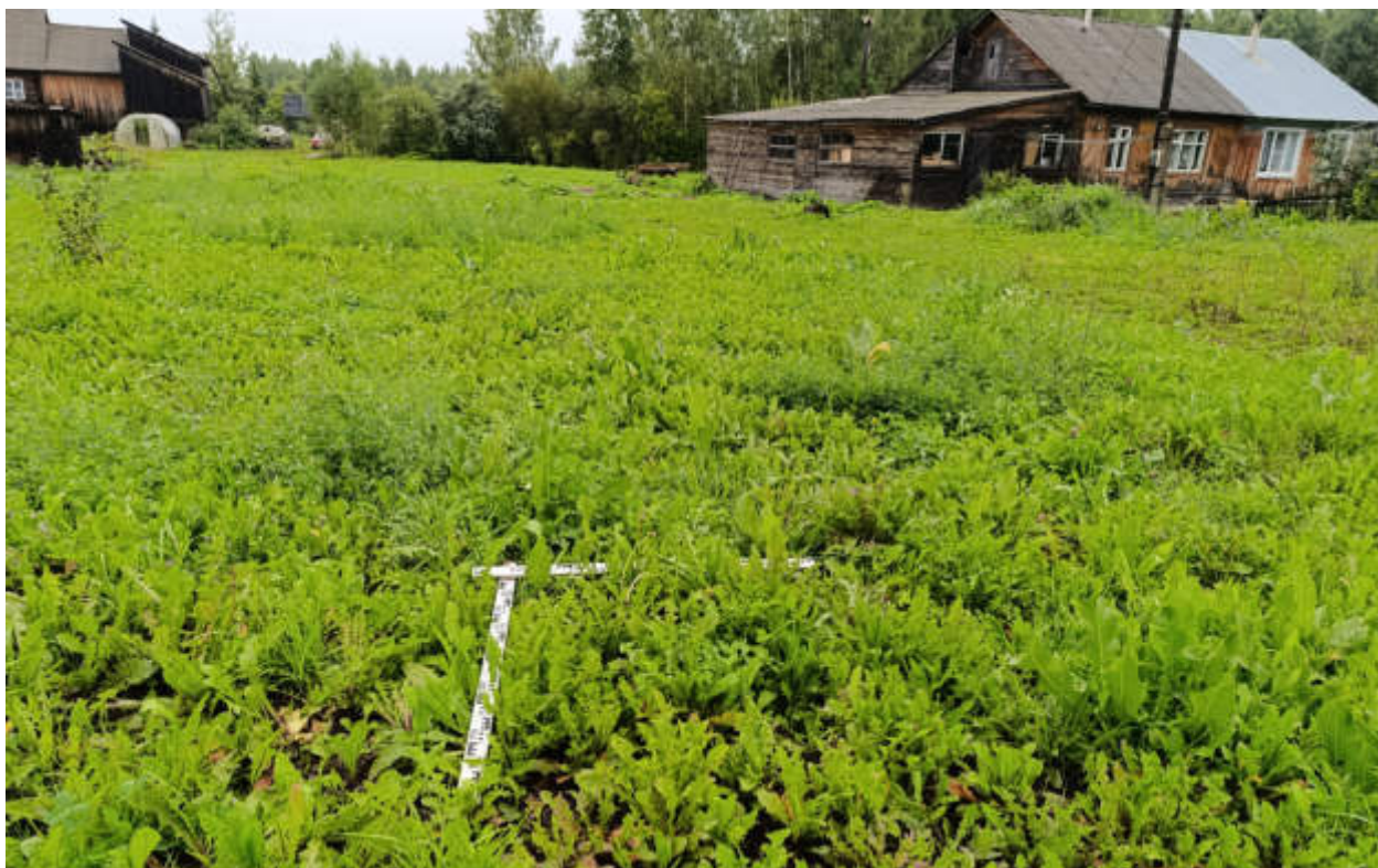
Рис.255. «Газопровод распределительный в пгт Арбаж Арбажского муниципального округа Кировской области» в пгт Арбаж Арбажского муниципального округа Кировской области. Шурф 34. Закладка. Вид с Ю.
