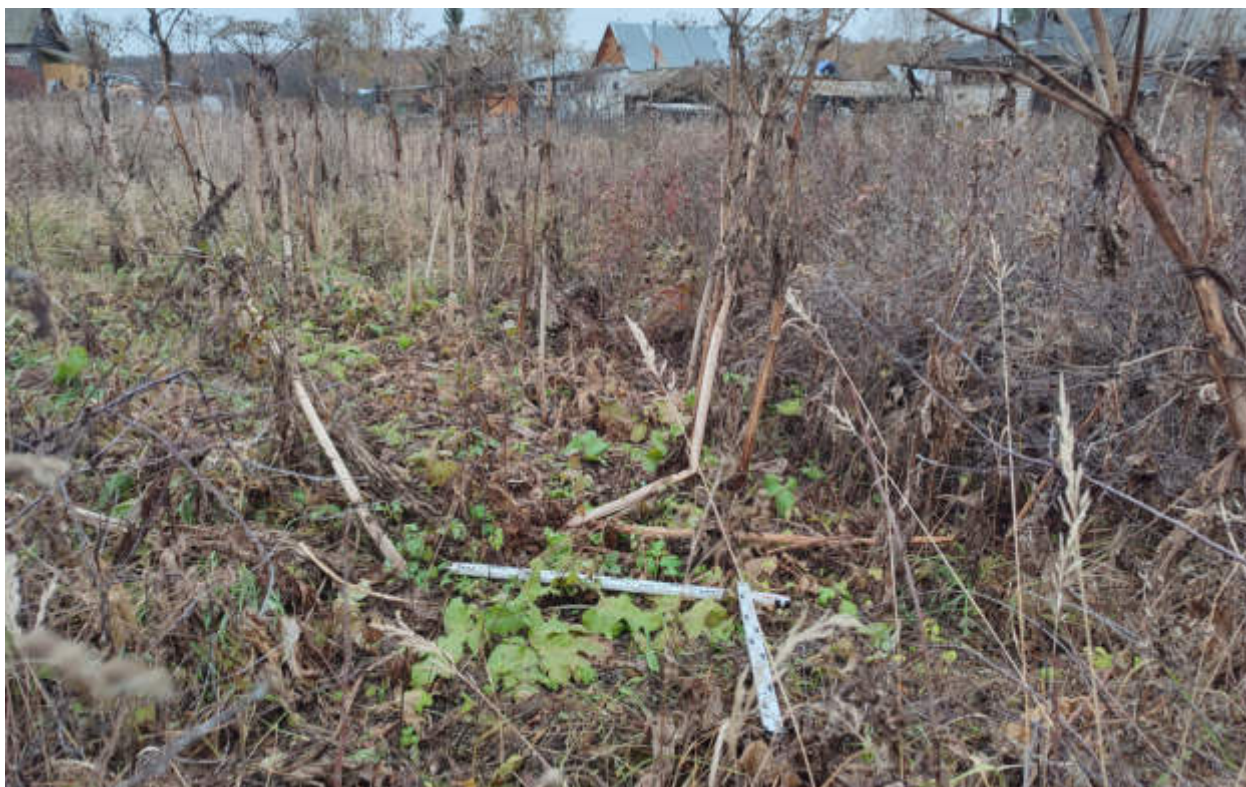
Рис.180. «Газопровод распределительный в пгт Арбаж Арбажского муниципального округа Кировской области» в пгт Арбаж Арбажского муниципального округа Кировской области. Шурф 19. Закладка. Вид с Ю.
