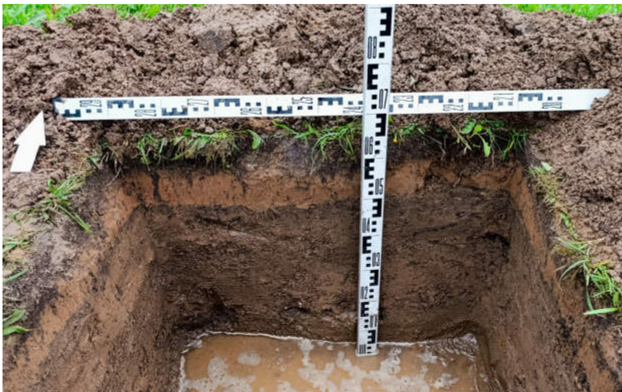
Рис.247. «Газопровод распределительный в пгт Арбаж Арбажского муниципального округа Кировской области» в пгт Арбаж Арбажского муниципального округа Кировской области. Шурф 32. Северный борт. Вид с Ю.
