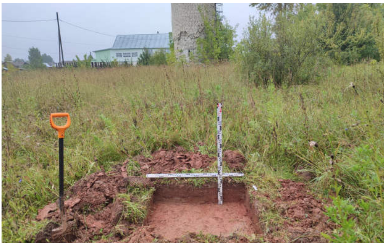
Рис.261. «Газопровод распределительный в пгт Арбаж Арбажского муниципального округа Кировской области» в пгт Арбаж Арбажского муниципального округа Кировской области. Шурф 35. Антураж. Вид с Ю.
