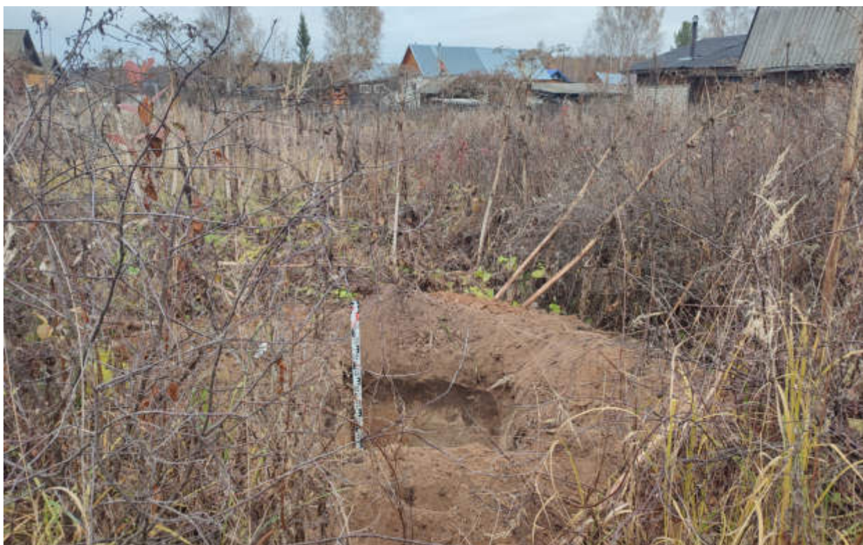
Рис.181. «Газопровод распределительный в пгт Арбаж Арбажского муниципального округа Кировской области» в пгт Арбаж Арбажского муниципального округа Кировской области. Шурф 19. Антураж. Вид с Ю.
