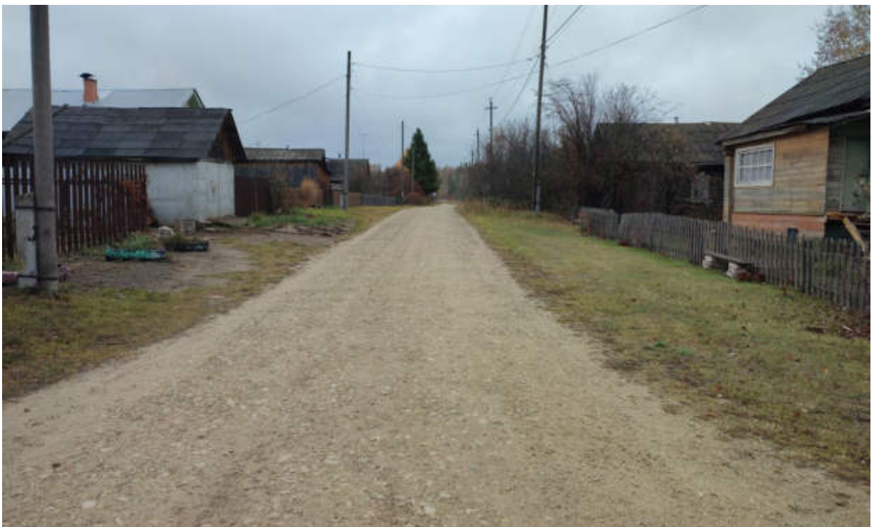
Рис.43. «Газопровод распределительный в пгт Арбаж Арбажского муниципального округа Кировской области» в пгт Арбаж Арбажского муниципального округа Кировской области. Рельеф местности и характер растительности участка обследования. Точка фотофиксации 14, вид с З.
