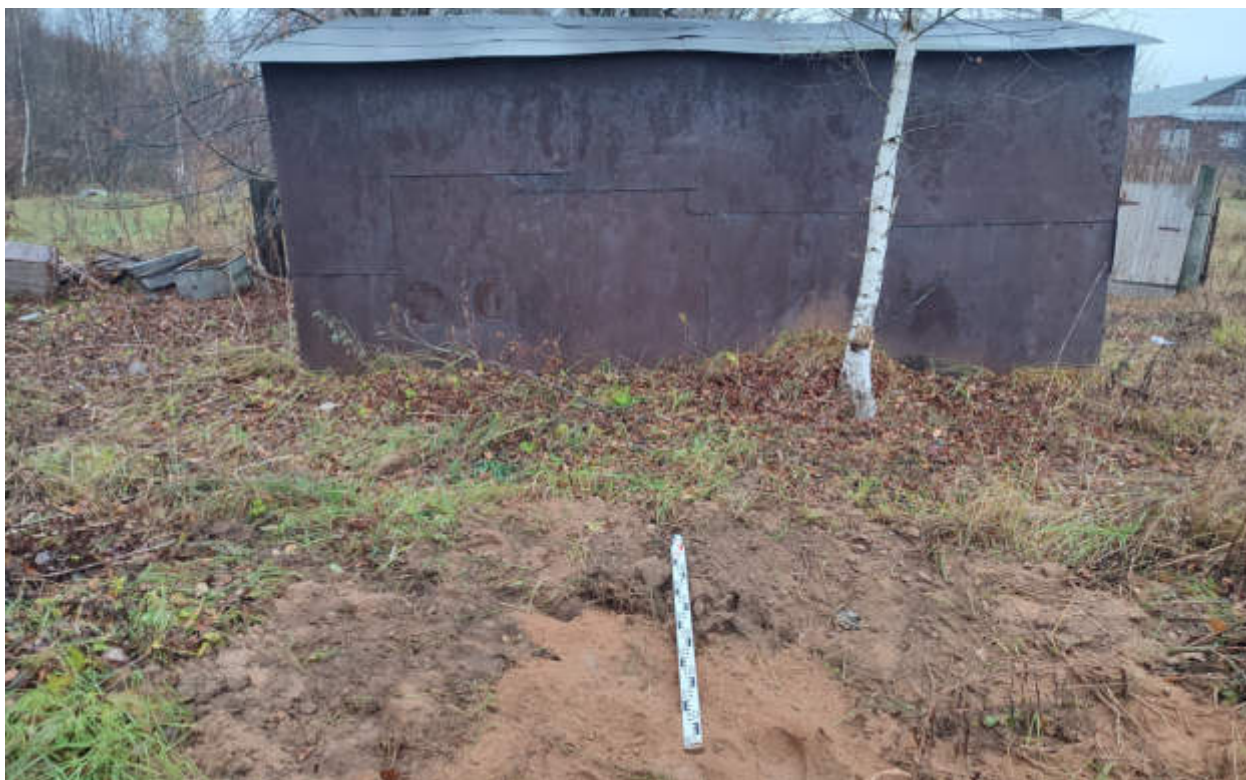
Рис.104. «Газопровод распределительный в пгт Арбаж Арбажского муниципального округа Кировской области» в пгт Арбаж Арбажского муниципального округа Кировской области. Шурф 3. Рекультивация. Вид с Ю.
