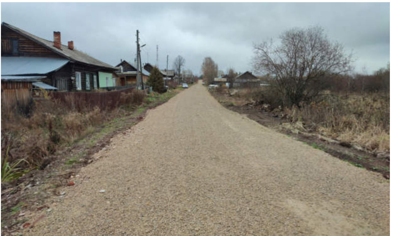
Рис.51. «Газопровод распределительный в пгт Арбаж Арбажского муниципального округа Кировской области» в пгт Арбаж Арбажского муниципального округа Кировской области. Рельеф местности и характер растительности участка обследования. Точка фотофиксации 22, вид с ЗЮЗ.
