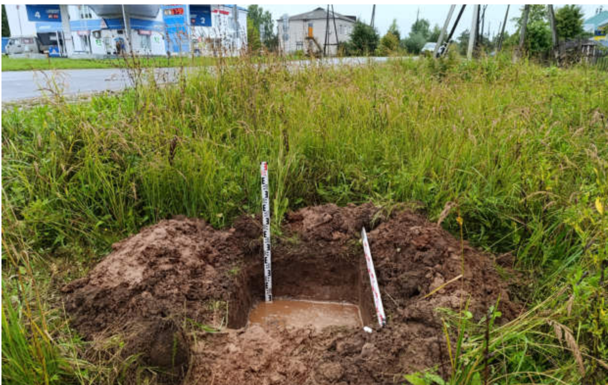
Рис.266. «Газопровод распределительный в пгт Арбаж Арбажского муниципального округа Кировской области» в пгт Арбаж Арбажского муниципального округа Кировской области. Шурф 36. Антураж. Вид с Ю.
