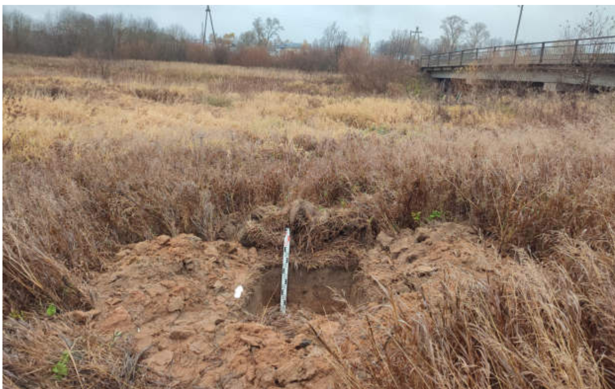
Рис.96. «Газопровод распределительный в пгт Арбаж Арбажского муниципального округа Кировской области» в пгт Арбаж Арбажского муниципального округа Кировской области. Шурф 2. Антураж. Вид с Ю.
