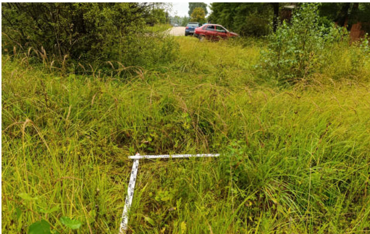
Рис.250. «Газопровод распределительный в пгт Арбаж Арбажского муниципального округа Кировской области» в пгт Арбаж Арбажского муниципального округа Кировской области. Шурф 33. Закладка. Вид с Ю.
