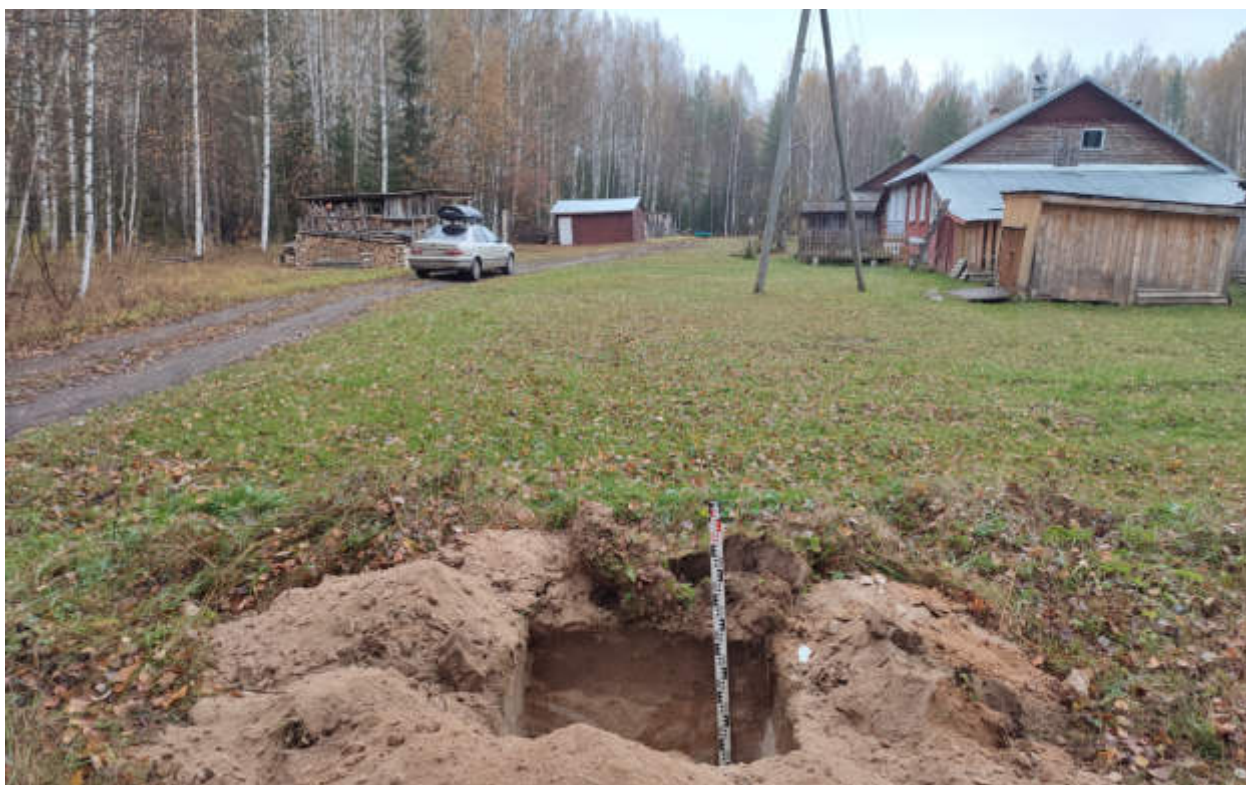
Рис.111. «Газопровод распределительный в пгт Арбаж Арбажского муниципального округа Кировской области» в пгт Арбаж Арбажского муниципального округа Кировской области. Шурф 5. Антураж. Вид с Ю.
