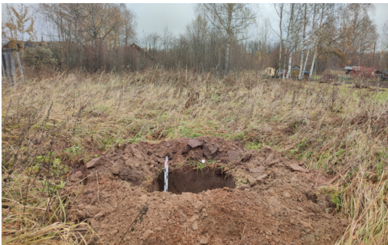
Рис.141. «Газопровод распределительный в пгт Арбаж Арбажского муниципального округа Кировской области» в пгт Арбаж Арбажского муниципального округа Кировской области. Шурф 11. Антураж. Вид с Ю.
