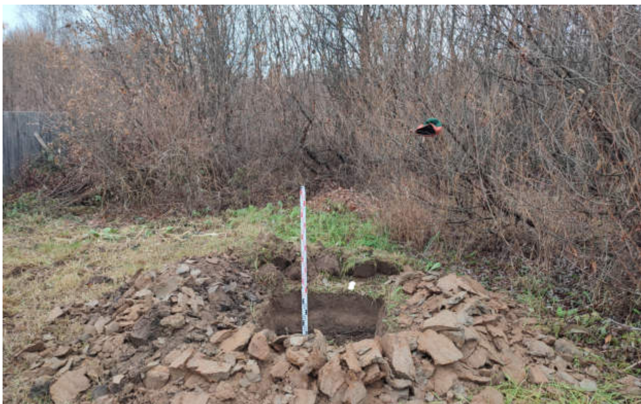
Рис.131. «Газопровод распределительный в пгт Арбаж Арбажского муниципального округа Кировской области» в пгт Арбаж Арбажского муниципального округа Кировской области. Шурф 9. Антураж. Вид с Ю.
