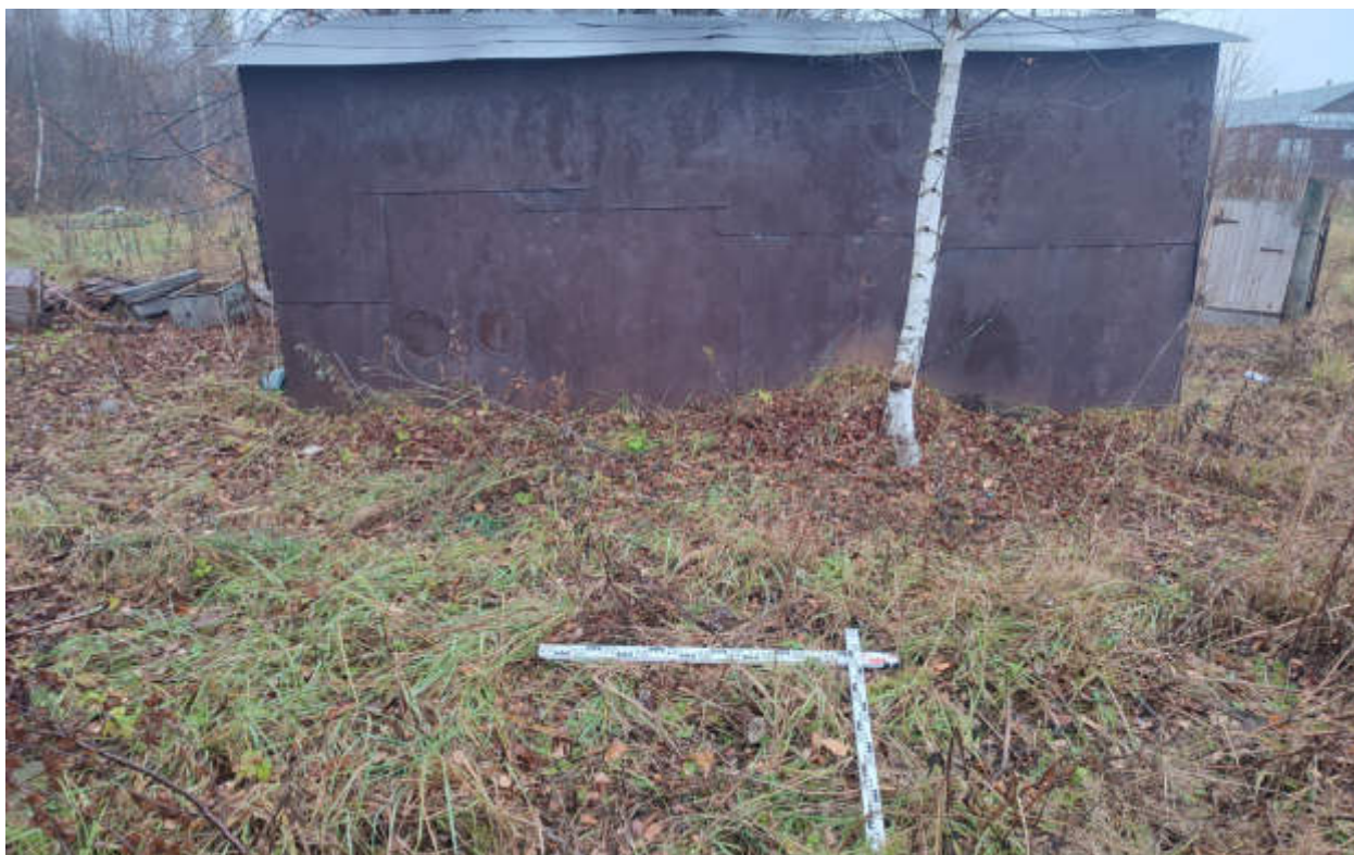
Рис.100. «Газопровод распределительный в пгт Арбаж Арбажского муниципального округа Кировской области» в пгт Арбаж Арбажского муниципального округа Кировской области. Шурф 3. Закладка. Вид с Ю.
