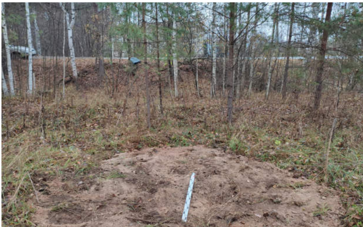
Рис.109. «Газопровод распределительный в пгт Арбаж Арбажского муниципального округа Кировской области» в пгт Арбаж Арбажского муниципального округа Кировской области. Шурф 4. Рекультивация. Вид с Ю.
