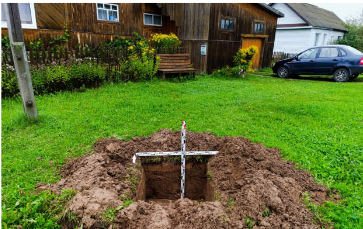
Рис.246. «Газопровод распределительный в пгт Арбаш Арбашского муниципального округа Кировской области» в пгт Арбаш Арбашского муниципального округа Кировской области. Шурф 32. Антураж. Вид с Ю.
