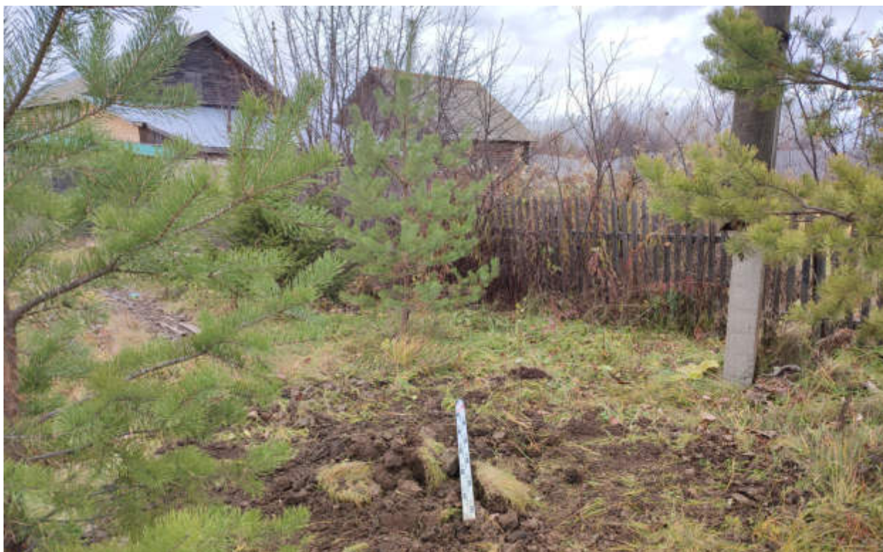
Рис.204. «Газопровод распределительный в пгт Арбаж Арбажского муниципального округа Кировской области» в пгт Арбаж Арбажского муниципального округа Кировской области. Шурф 23. Рекультивация. Вид с Ю.
