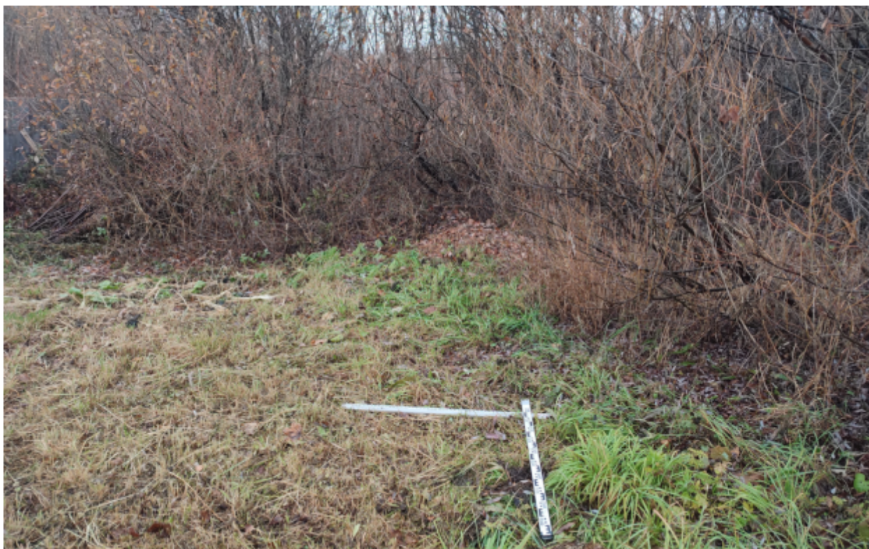
Рис.130. «Газопровод распределительный в пгт Арбаж Арбажского муниципального округа Кировской области» в пгт Арбаж Арбажского муниципального округа Кировской области. Шурф 9. Закладка. Вид с Ю.
