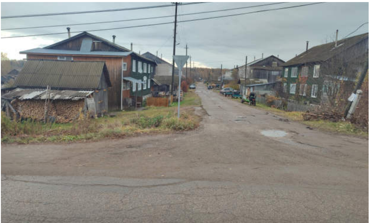
Рис.83. «Газопровод распределительный в пгт Арбаж Арбажского муниципального округа Кировской области» в пгт Арбаж Арбажского муниципального округа Кировской области. Рельеф местности и характер растительности участка обследования. Точка фотофиксации 54, вид с ЗЮЗ.
