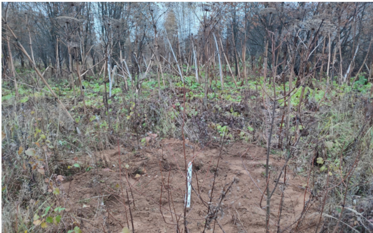
Рис.189. «Газопровод распределительный в пгт Арбаж Арбажского муниципального округа Кировской области» в пгт Арбаж Арбажского муниципального округа Кировской области. Шурф 20. Рекультивация. Вид с Ю.
