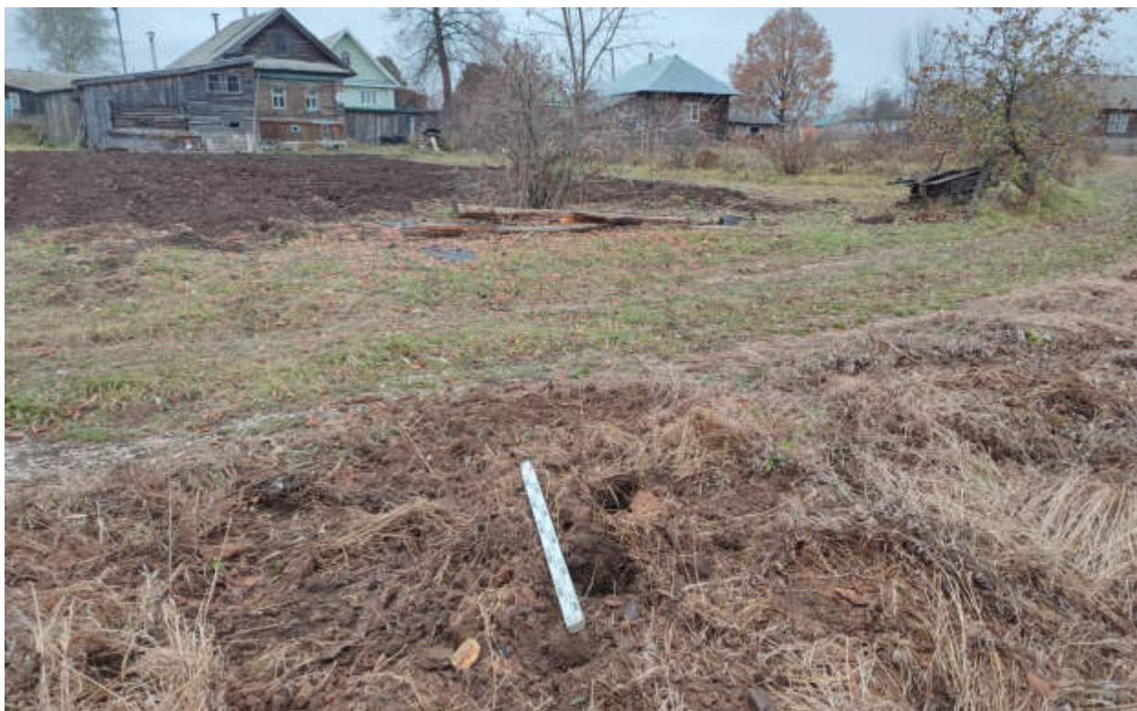
Рис.174. «Газопровод распределительный в пгт Арбаж Арбажского муниципального округа Кировской области» в пгт Арбаж Арбажского муниципального округа Кировской области. Шурф 17. Рекультивация. Вид с Ю.
