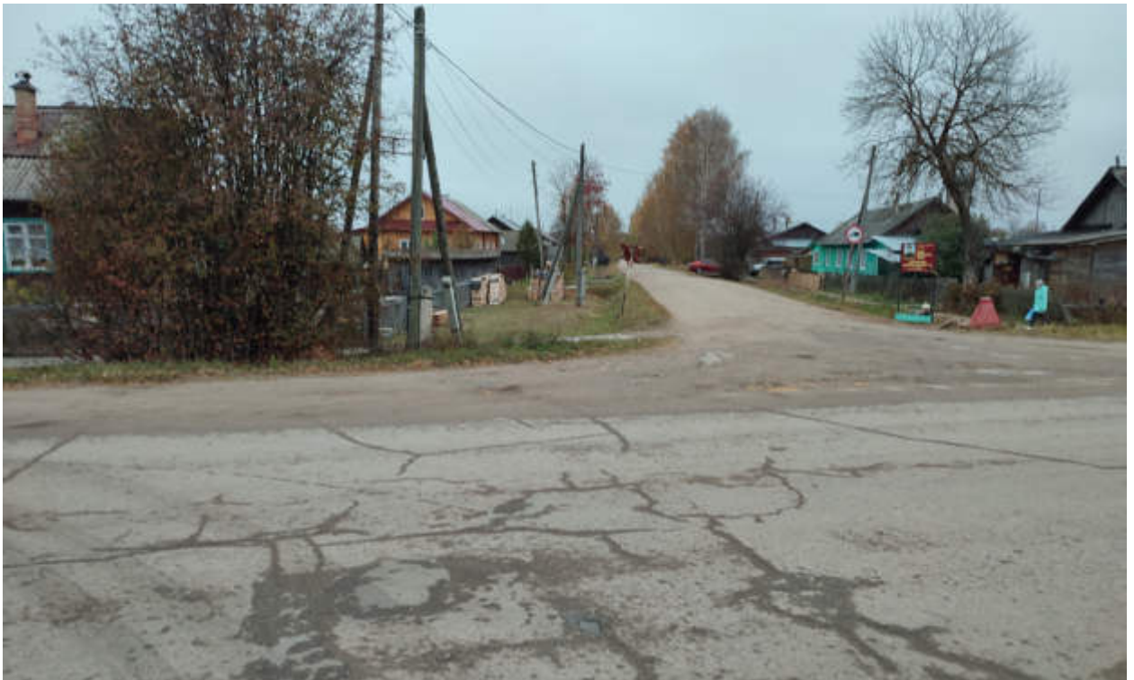
Рис.66. «Газопровод распределительный в пгт Арбaj Арбajского муниципального округа Кировской области» в пгт Арбaj Арбajского муниципального округа Кировской области. Рельеф местности и характер растительности участка обследования. Точка фотофиксации 37, вид с З.
