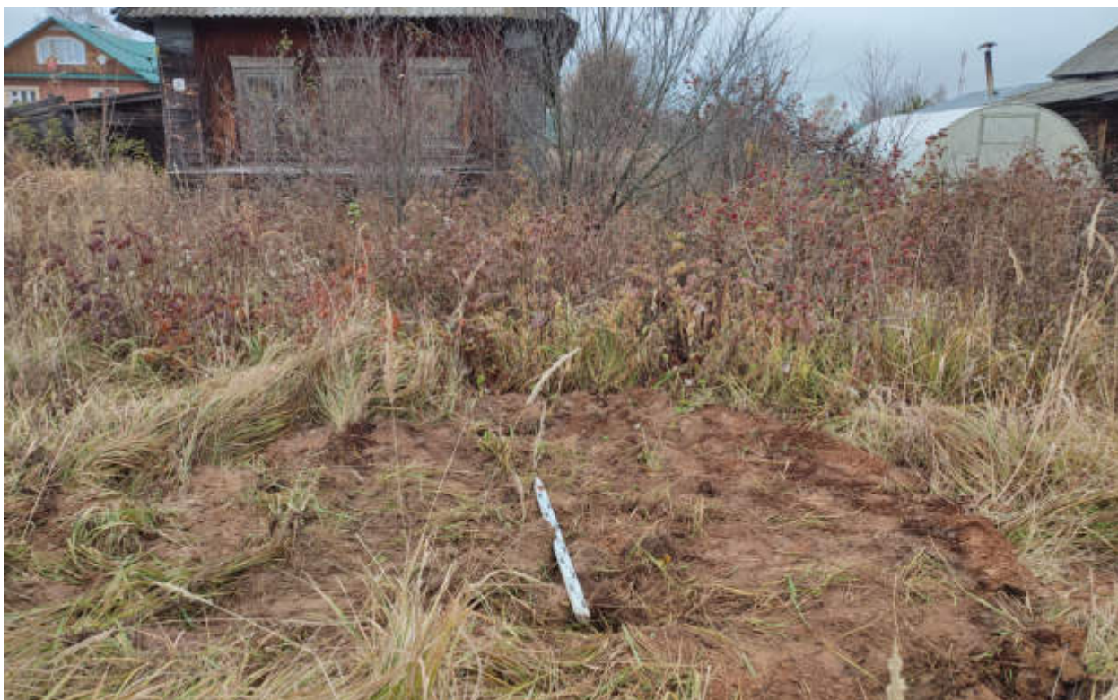
Рис.149. «Газопровод распределительный в пгт Арбаж Арбажского муниципального округа Кировской области» в пгт Арбаж Арбажского муниципального округа Кировской области. Шурф 12. Рекультивация. Вид с Ю.
