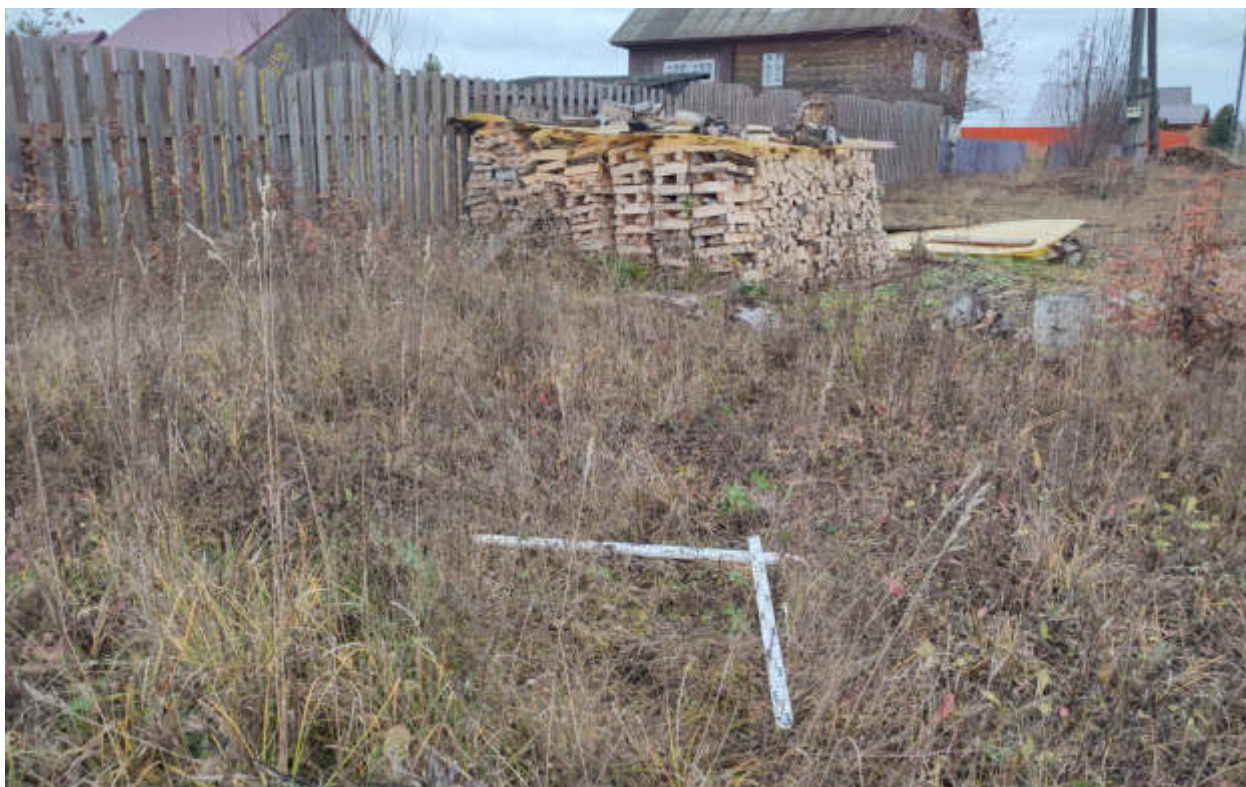
Рис.215. «Газопровод распределительный в пгт Арбаж Арбажского муниципального округа Кировской области» в пгт Арбаж Арбажского муниципального округа Кировской области. Шурф 26. Закладка. Вид с Ю.
