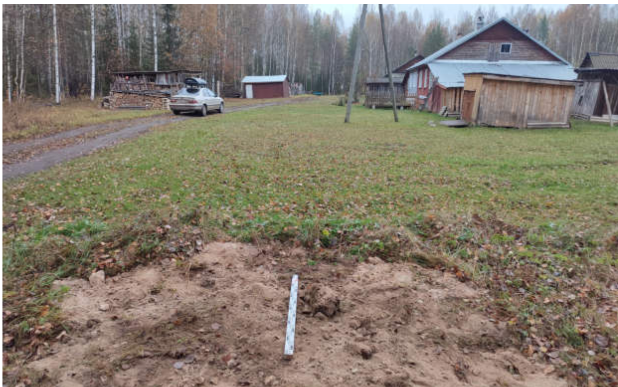
Рис.114. «Газопровод распределительный в пгт Арбаж Арбажского муниципального округа Кировской области» в пгт Арбаж Арбажского муниципального округа Кировской области. Шурф 5. Рекультивация. Вид с Ю.
