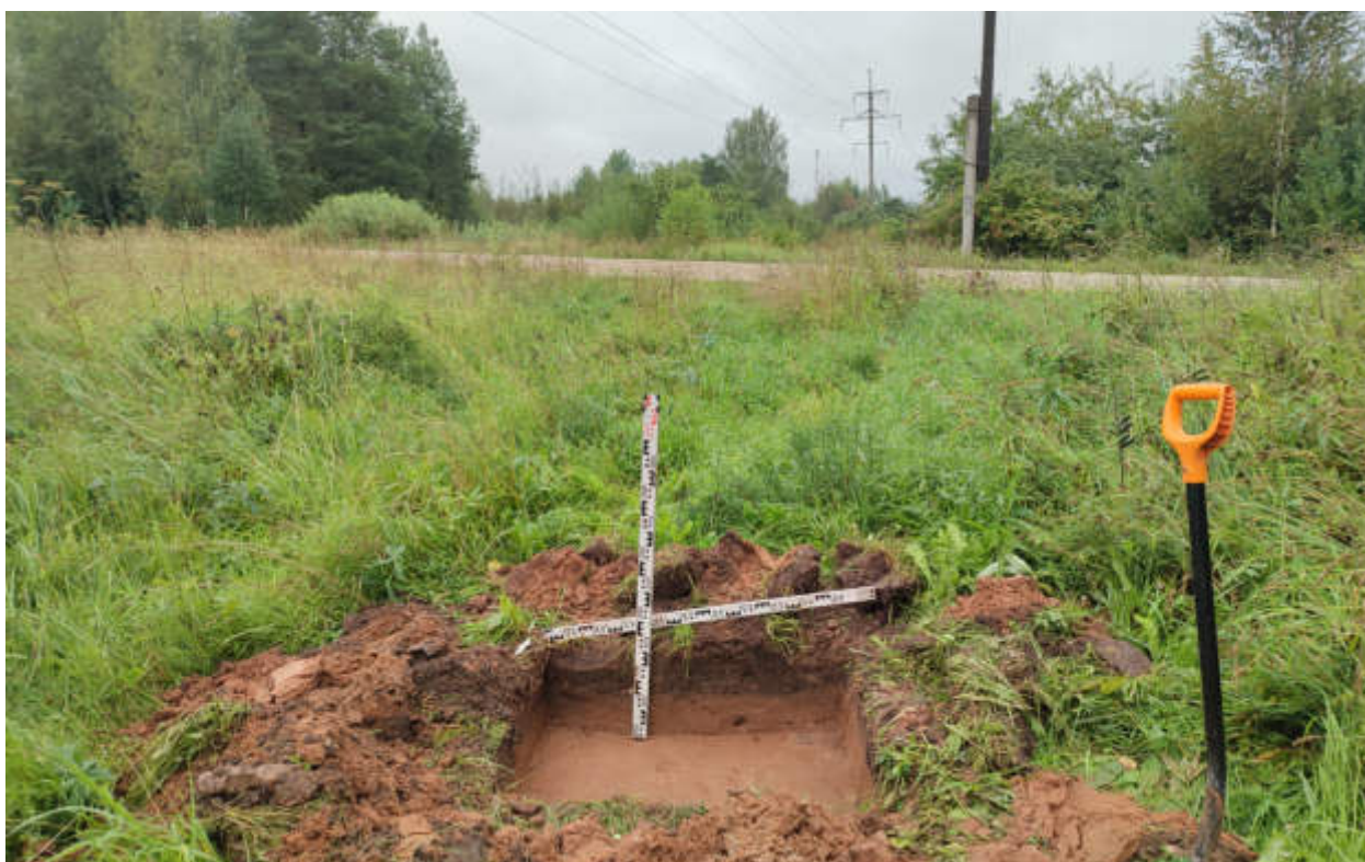
Рис.241. «Газопровод распределительный в пгт Арбаж Арбажского муниципального округа Кировской области» в пгт Арбаж Арбажского муниципального округа Кировской области. Шурф 31. Антураж. Вид с Ю.
