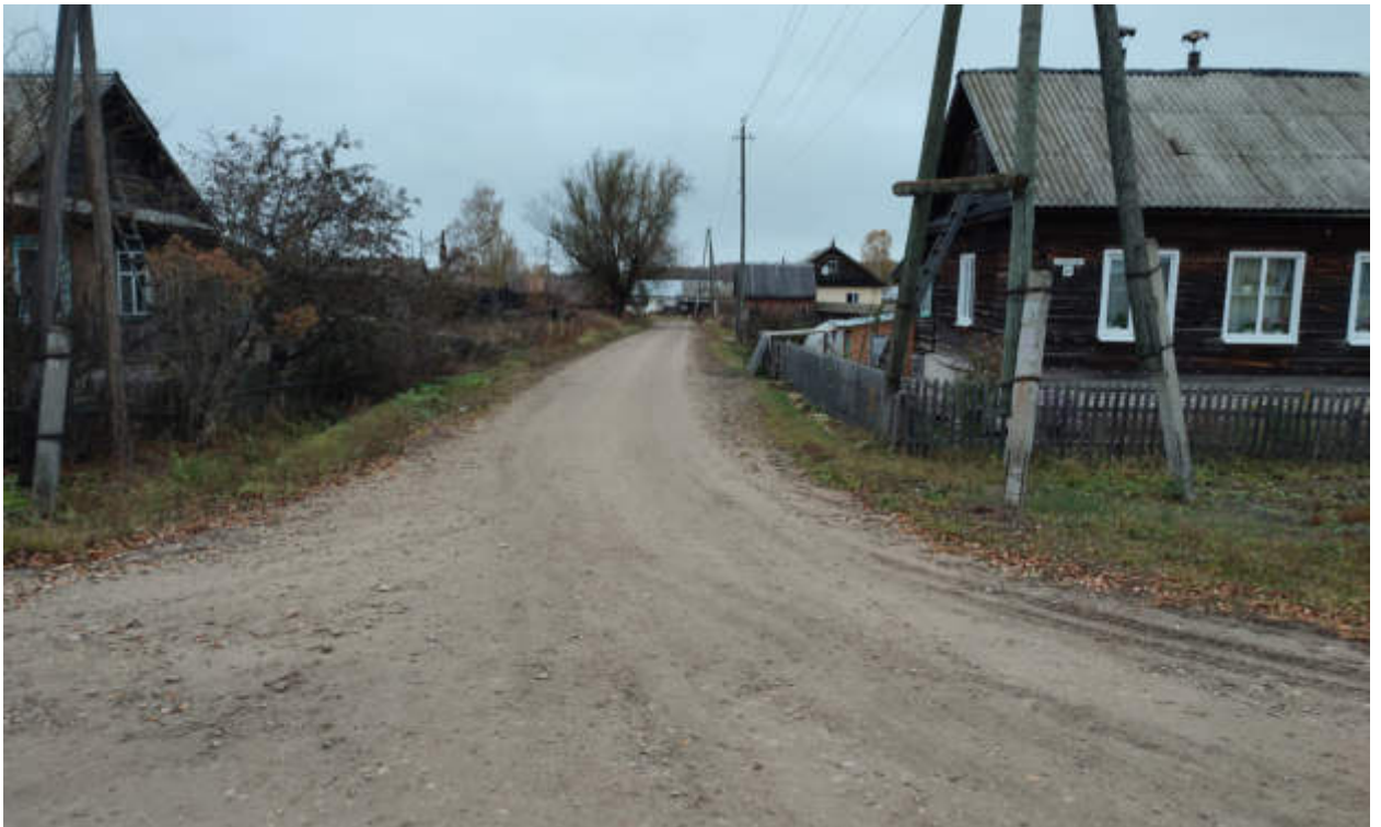
Рис.68. «Газопровод распределительный в пгт Арбаж Арбажского муниципального округа Кировской области» в пгт Арбаж Арбажского муниципального округа Кировской области. Рельеф местности и характер растительности участка обследования. Точка фотофиксации 39, вид с СЗ.
