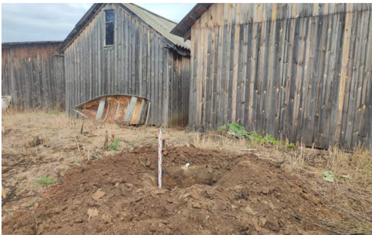
Рис.236. «Газопровод распределительный в пгт Арбаж Арбажского муниципального округа Кировской области» в пгт Арбаж Арбажского муниципального округа Кировской области. Шурф 30. Антураж. Вид с Ю.
