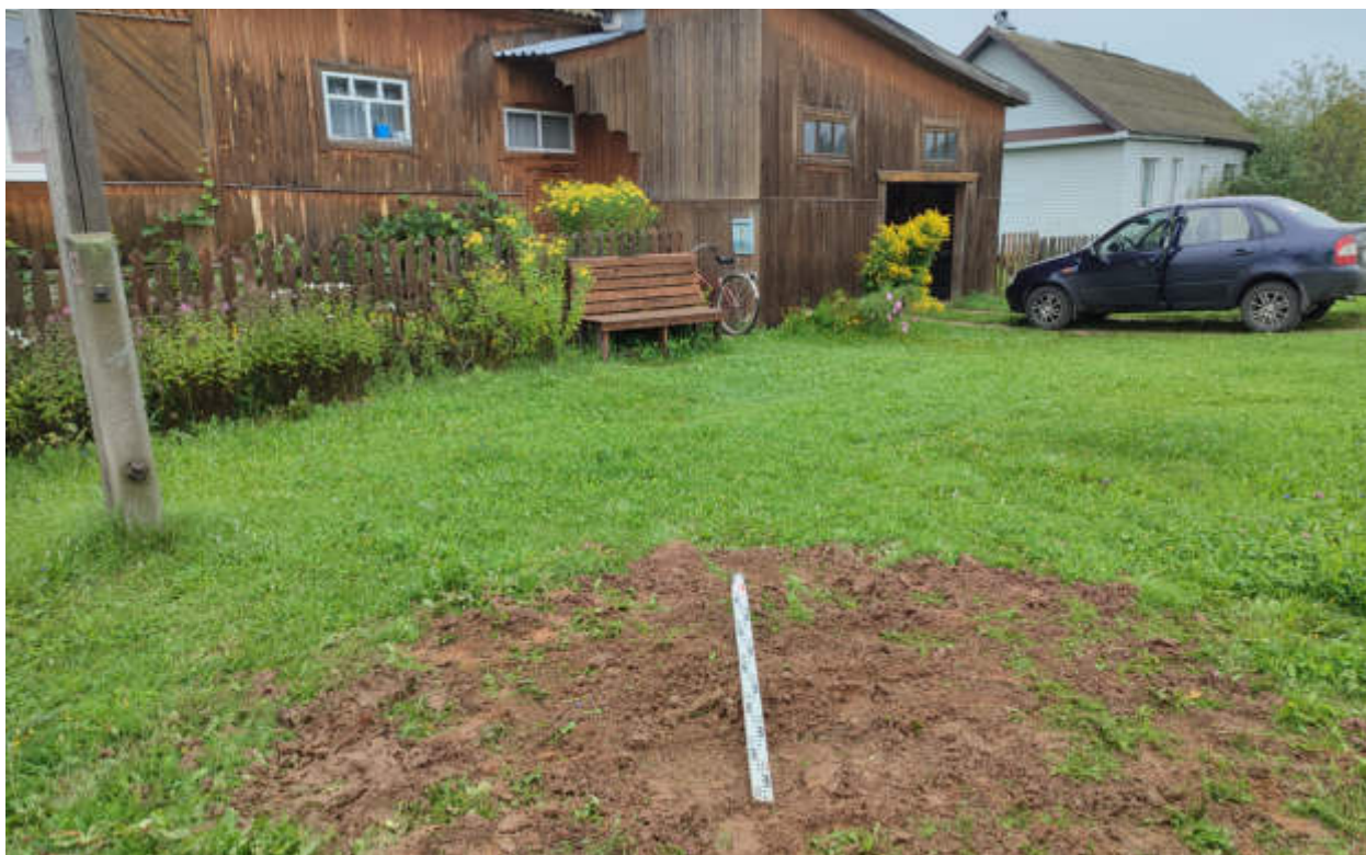
Рис.249. «Газопровод распределительный в пгт Арбаж Арбажского муниципального округа Кировской области» в пгт Арбаж Арбажского муниципального округа Кировской области. Шурф 32. Рекультивация. Вид с Ю.
