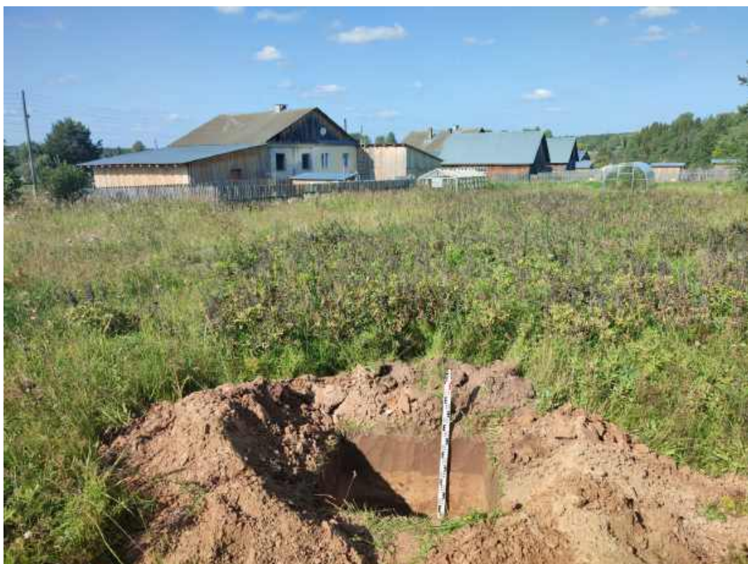
Рис.55. «Строительство распределительного газопровода в д. Угор Верхошижемского района Кировской области» в Верхошижемском районе Кировской области. Шурф 7. Антураж. Вид с Ю.
