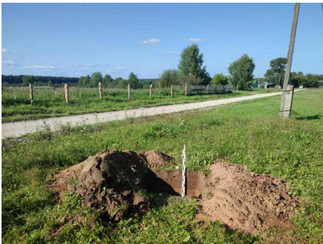
Рис.45. «Строительство распределительного газопровода в д. Угор Верхошижемского района Кировской области» в Верхошижемском районе Кировской области. Шурф 5. Антураж. Вид с Ю.
