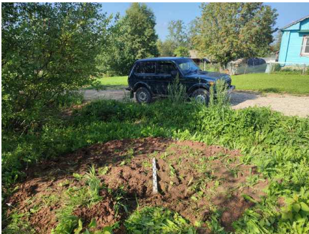
Рис.53. «Строительство распределительного газопровода в д. Угор Верхошижемского района Кировской области» в Верхошижемском районе Кировской области. Шурф 6. Рекультивация. Вид с Ю.
