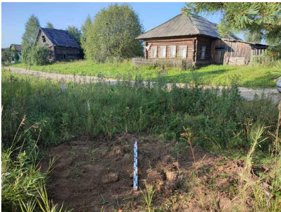
Рис.43. «Строительство распределительного газопровода в д. Угор Верхошижемского района Кировской области» в Верхошижемском районе Кировской области. Шурф 4. Рекультивация. Вид с Ю.
