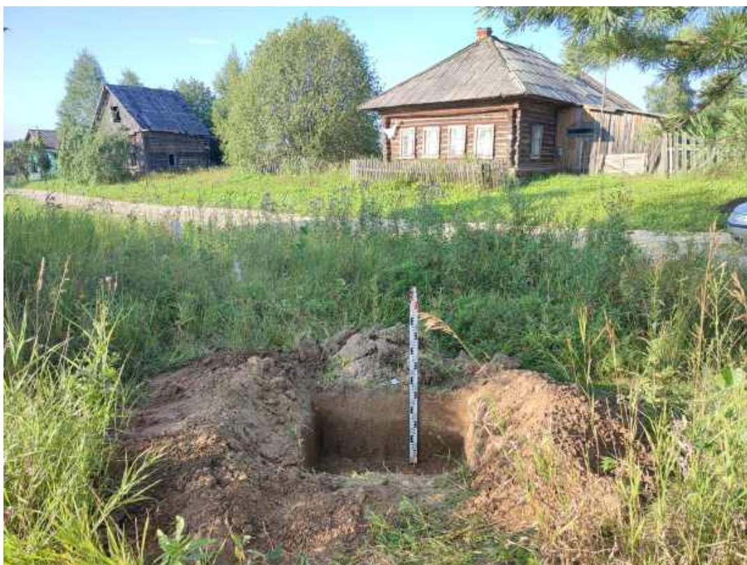
Рис.40. «Строительство распределительного газопровода в д. Угор Верхошижемского района Кировской области» в Верхошижемском районе Кировской области. Шурф 4. Антураж. Вид с Ю.
