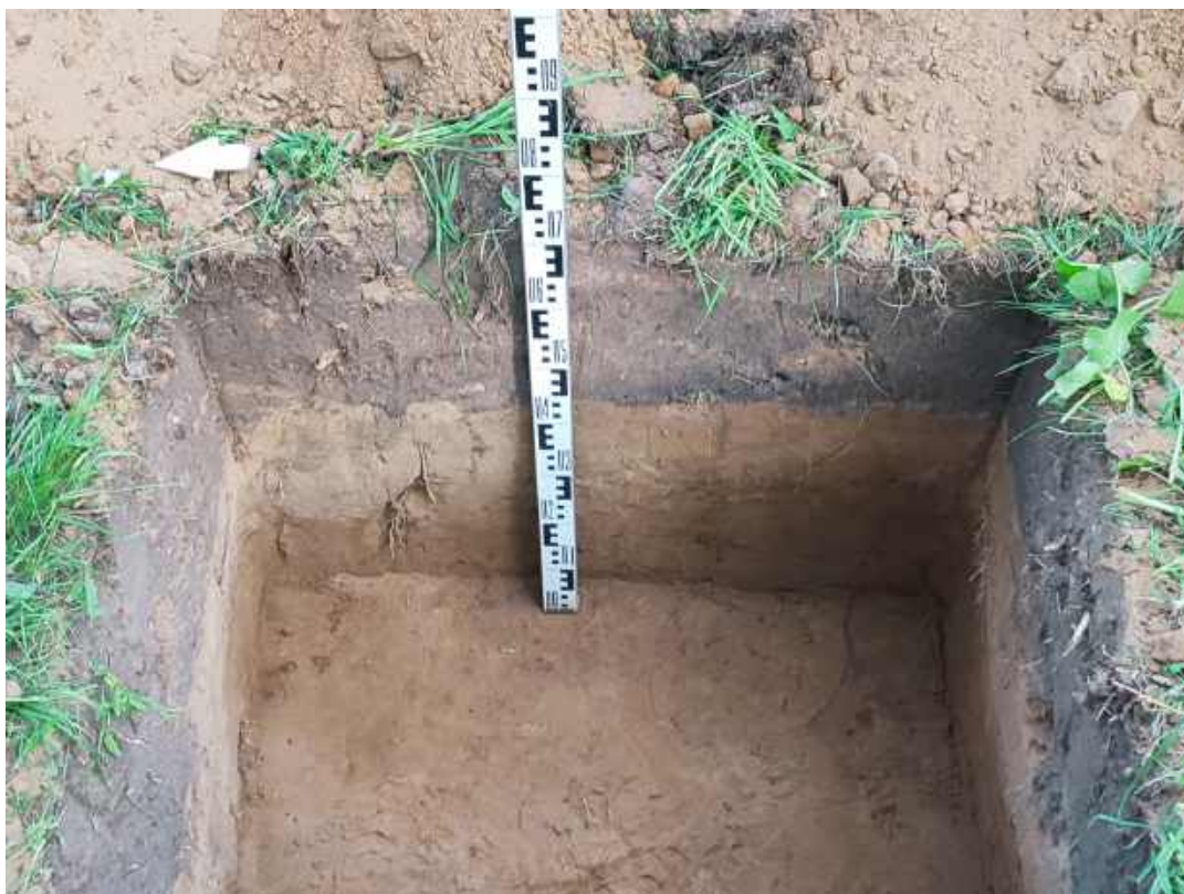
Рис.36. «Строительство распределительного газопровода в д. Угор Верхошижемского района Кировской области» в Верхошижемском районе Кировской области. Шурф 3. Восточный борт. Вид с 3.
