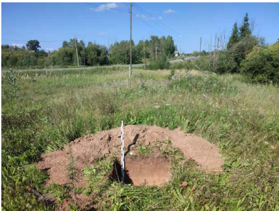
Рис.65. «Строительство распределительного газопровода в д. Угор Верхошижемского района Кировской области» в Верхошижемском районе Кировской области. Шурф 9. Антураж. Вид с Ю.
