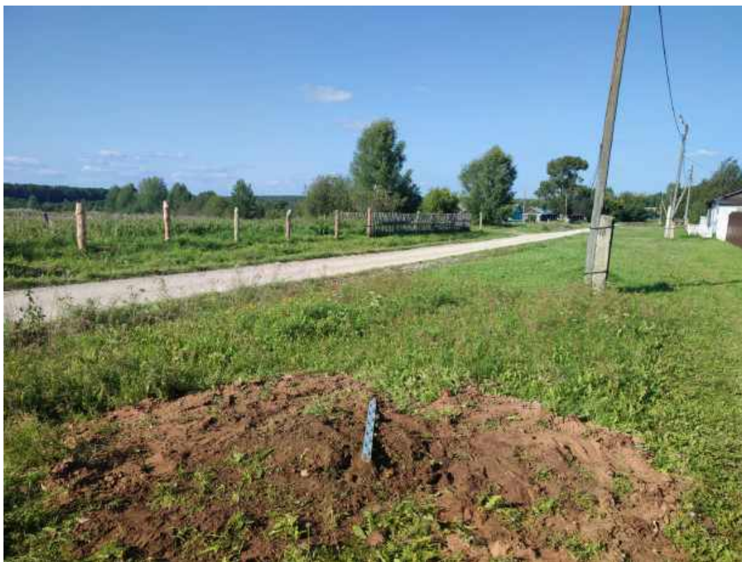
Рис.48. «Строительство распределительного газопровода в д. Угор Верхошижемского района Кировской области» в Верхошижемском районе Кировской области. Шурф 5. Рекультивация. Вид с Ю.
