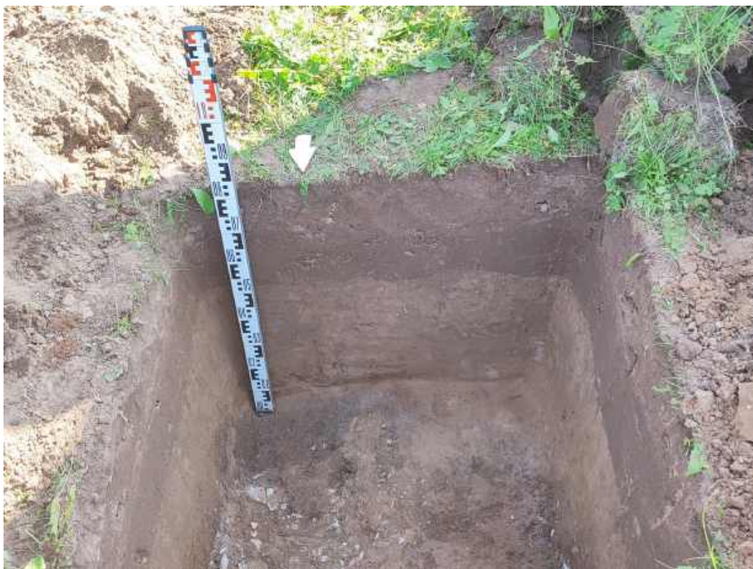
Рис.46. «Строительство распределительного газопровода в д. Угор Верхошижемского района Кировской области» в Верхошижемском районе Кировской области. Шурф 5. Южный борт. Вид с С.
