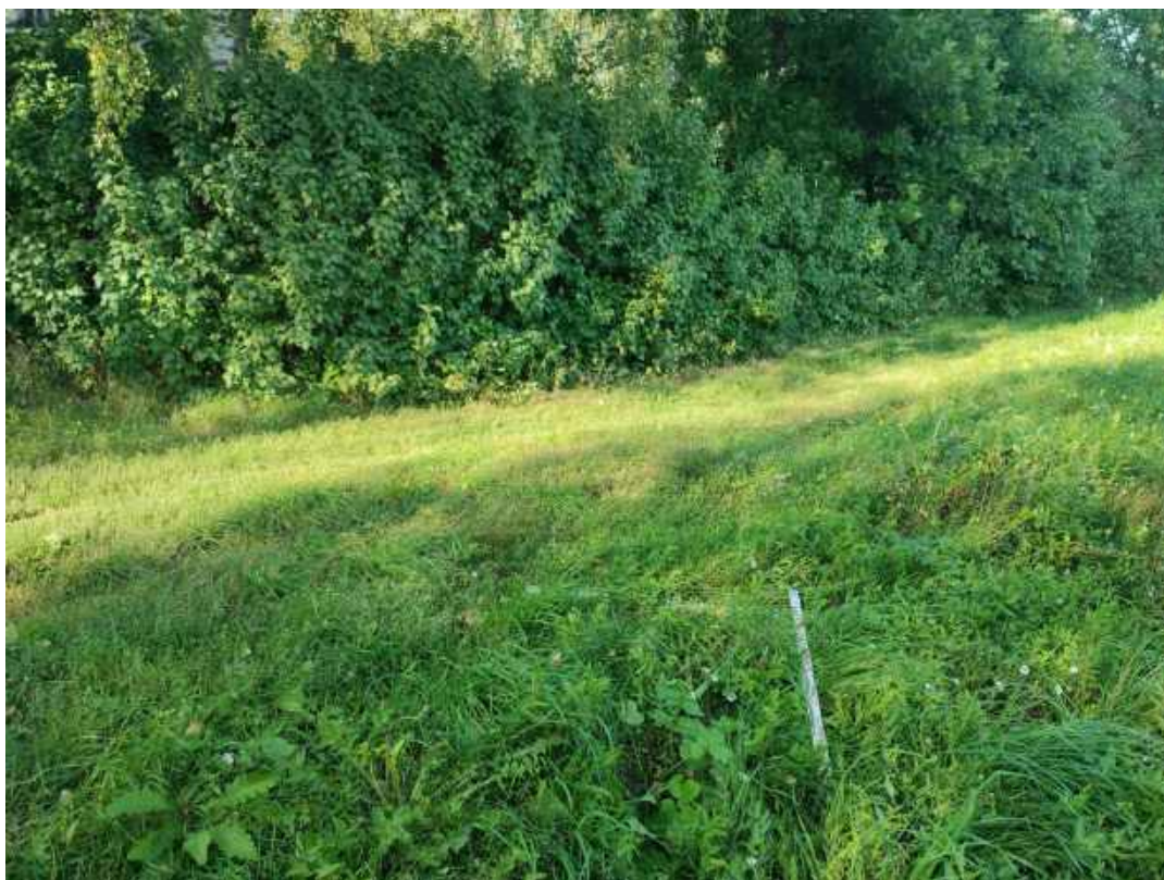
Рис.34. «Строительство распределительного газопровода в д. Угор Верхошижемского района Кировской области» в Верхошижемском районе Кировской области. Шурф 3. Закладка. Вид с Ю.
