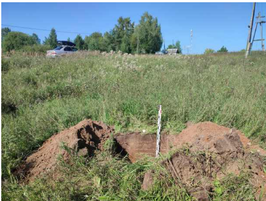
Рис.60. «Строительство распределительного газопровода в д. Угор Верхошижемского района Кировской области» в Верхошижемском районе Кировской области. Шурф 8. Антураж. Вид с Ю.
