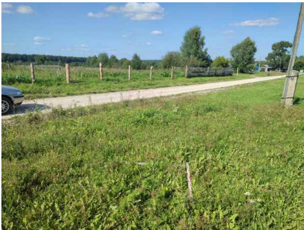
Рис.44. «Строительство распределительного газопровода в д. Угор Верхошижемского района Кировской области» в Верхошижемском районе Кировской области. Шурф 5. Закладка. Вид с Ю.
