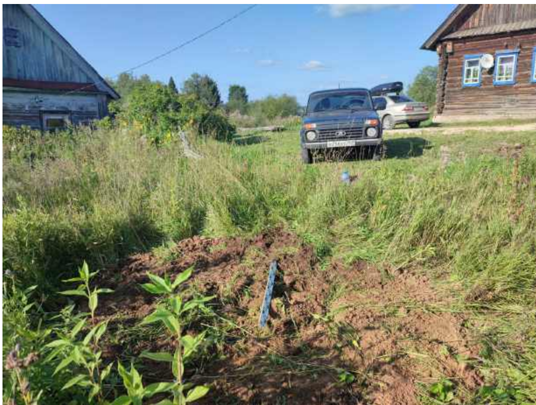
Рис.33. «Строительство распределительного газопровода в д. Угор Верхошижемского района Кировской области» в Верхошижемском районе Кировской области. Шурф 2. Рекультивация. Вид с Ю.
