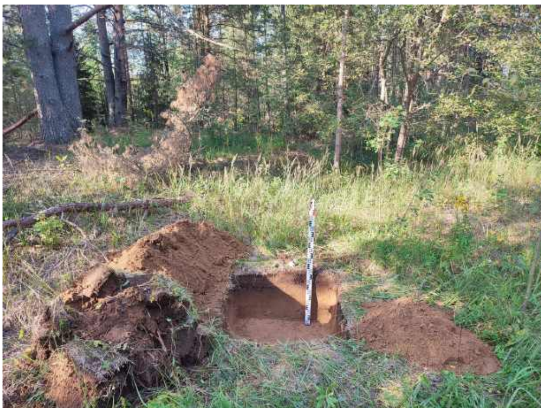
Рис.25. «Строительство распределительного газопровода в д. Угор Верхошижемского района Кировской области» в Верхошижемском районе Кировской области. Шурф 1. Антураж. Вид с Ю.
