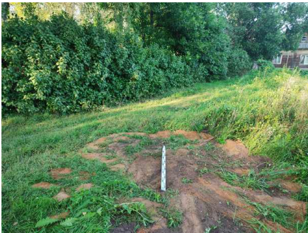
Рис.38. «Строительство распределительного газопровода в д. Угор Верхошижемского района Кировской области» в Верхошижемском районе Кировской области. Шурф 3. Рекультивация. Вид с Ю.
