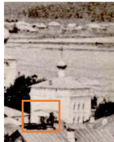
Ил.6 Историческое фото на начало XIX века. «Вид на кафедральный собор в Вятке с южной стороны» На фото зафиксирована Трехсвятительская церковь с утраченным тамбуром на западном фасаде.
