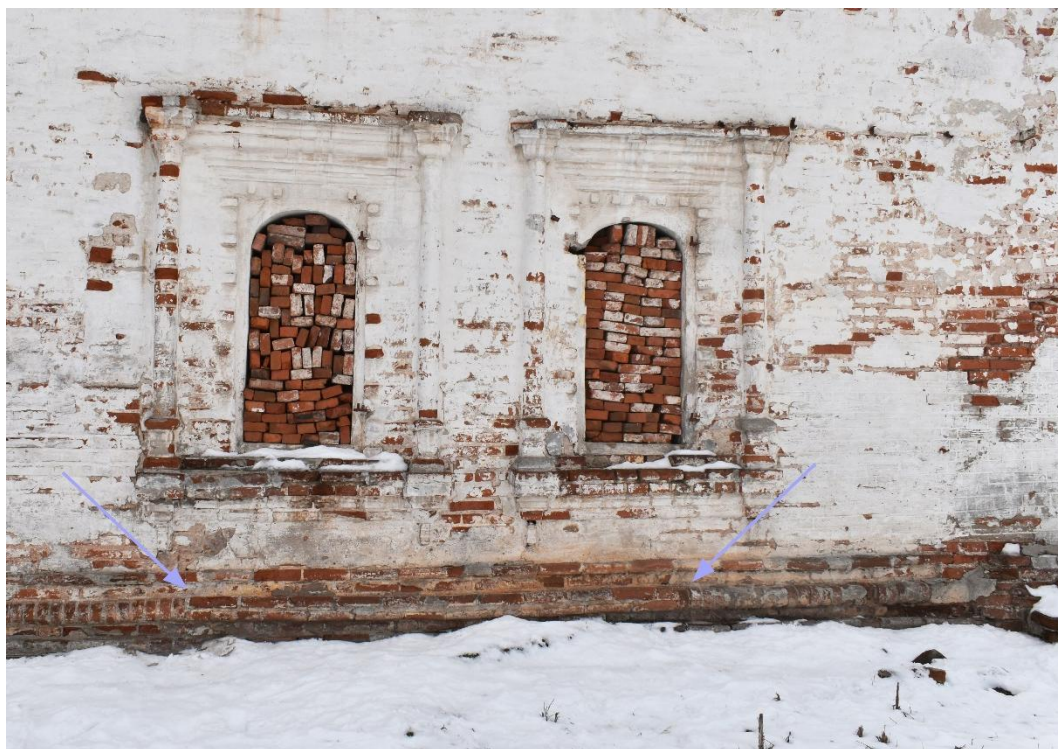
Ил.15. Фрагмент северного фасада, окна первого этажа. Изменение расположения рядов цоколя, следы заложенного дверного проема.
