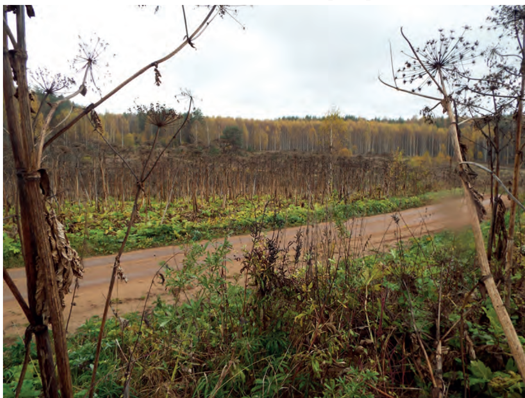
Рис.16. Строительство межпоселкового газопровода к д. Сметанники Кирово-Чепецкого района Кировской области. Рельеф местности и характер растительности участка обследования. Точка фотофиксации 2, вид с В.
