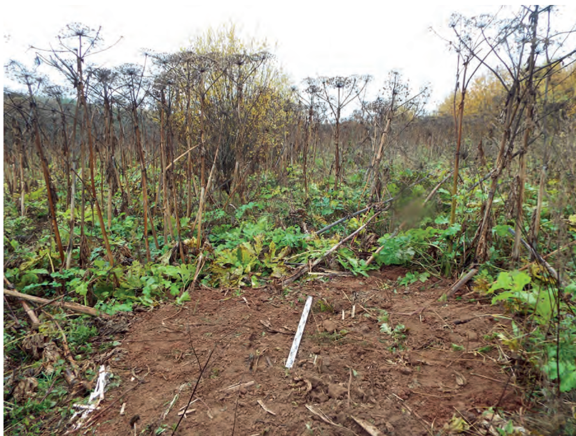
Рис.24. Строительство межпоселкового газопровода к д. Сметанники Кирово-Чепецкого района Кировской области. Шурф 1. Рекультивация. Вид с Ю.
