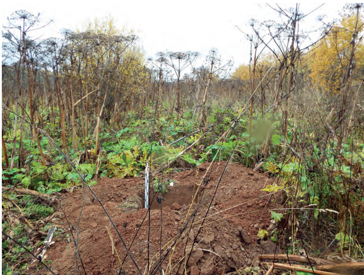
Рис.22. Строительство межпоселкового газопровода к д. Сметанники Кирово-Чепецкого района Кировской области. Шурф 1. Антураж. Вид с Ю.
