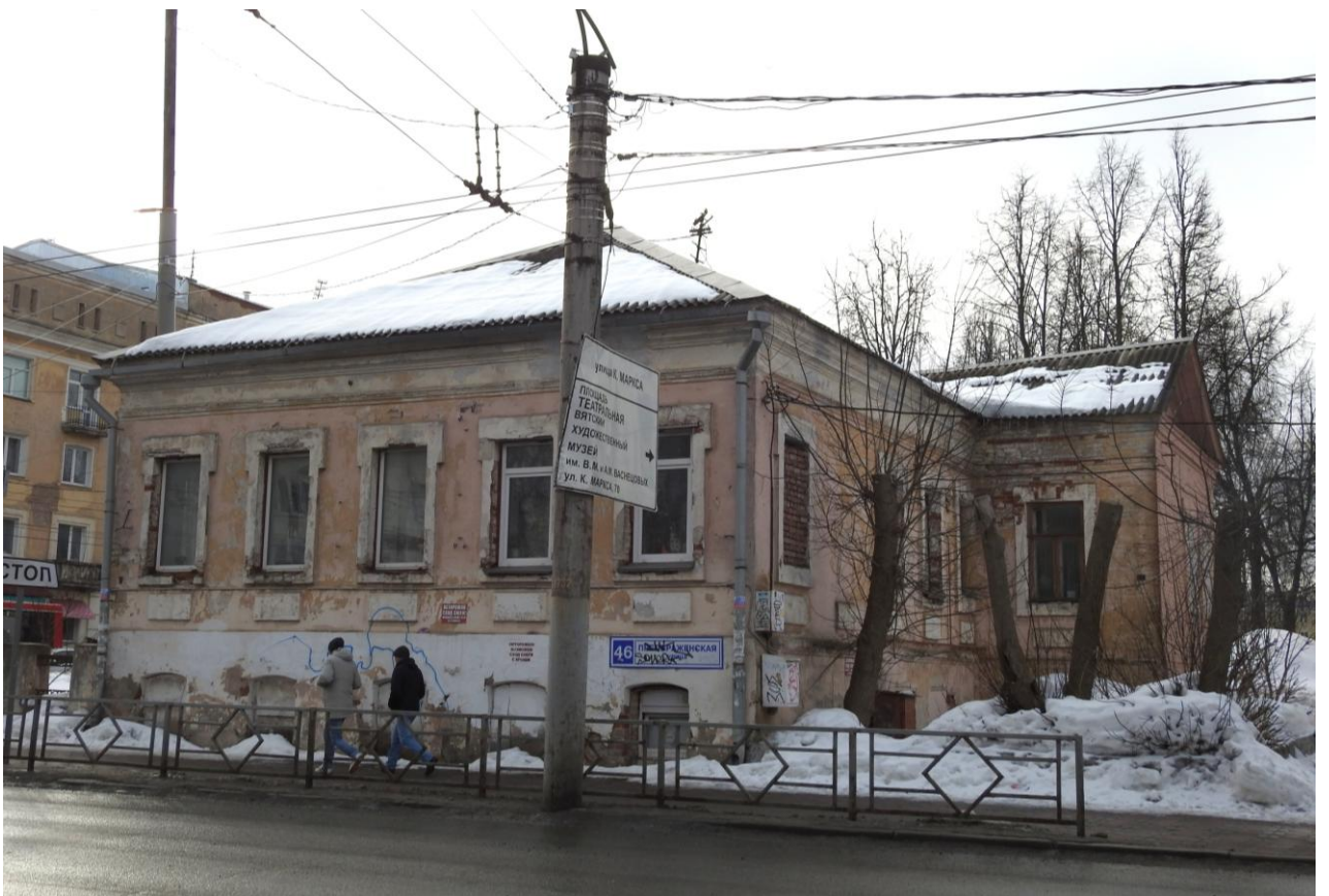
Фото 8. Северный и западный фасады Дома А.И. Пыхтеева. Вид с северо-запада. Автор съемки – Ошурков А.Н., дата съемки – 2022 г.
