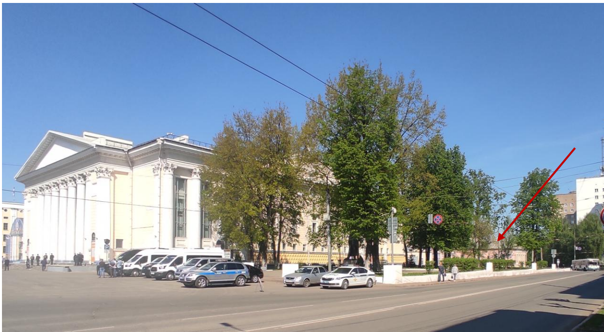
Фото 3. Общий вид на «Дом А.И. Пыхтеева» в застройке улицы К. Маркса. Вид с юго-востока. Автор съемки – Баруткина Е.Е., дата съемки – 2022 г.
