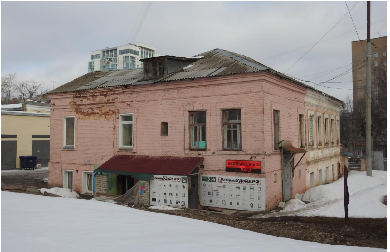
Фото 7. Южный и восточный фасады Дома А.И. Пыхтеева. Вид с юго-востока. Автор съемки – Ошурков А.Н., дата съемки – 2022 г.
