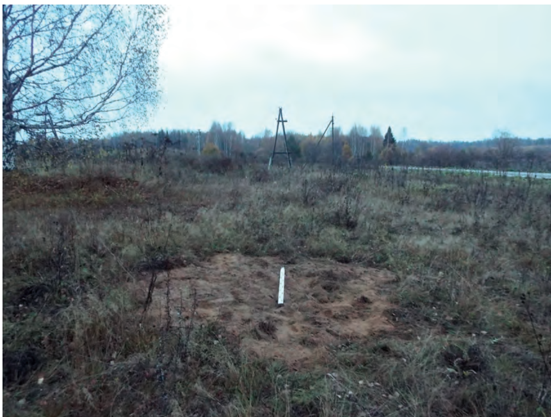
Рис.16. Строительство межпоселкового газопровода к д. Солоково Кирово-Чепецкого района Кировской области. Шурф 1. Рекультивация. Вид с Ю.
