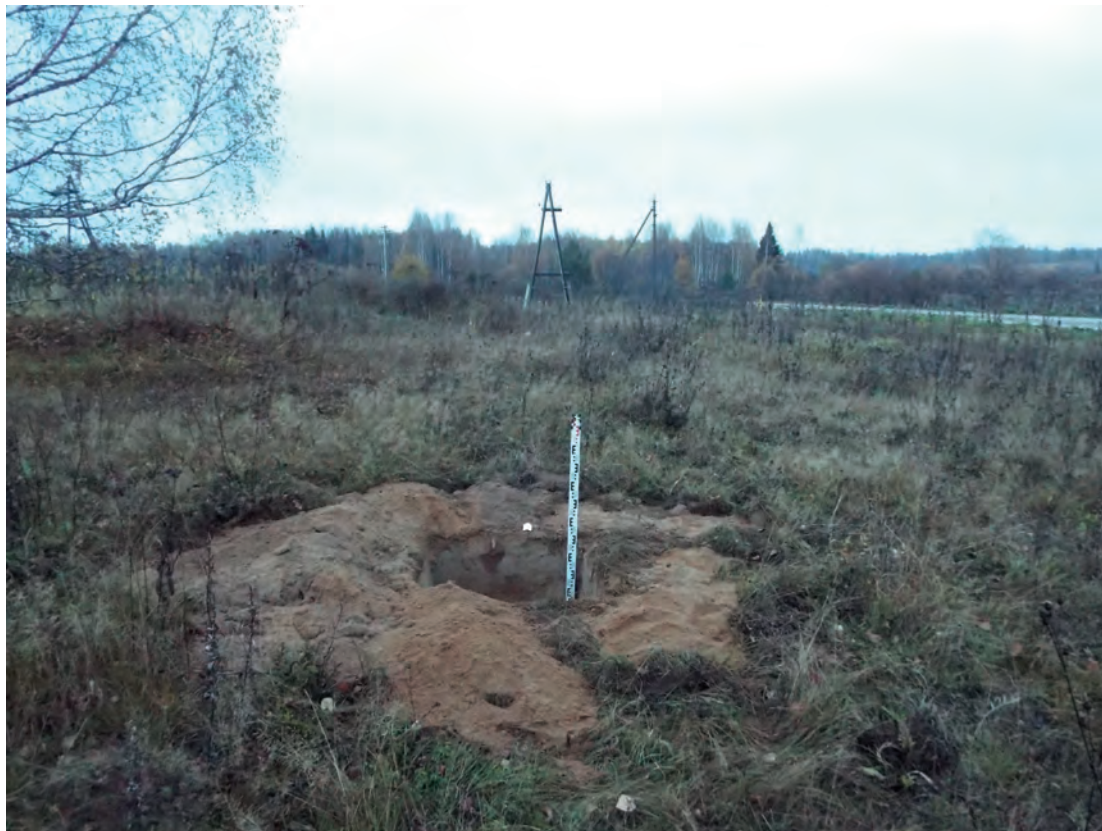
Рис.14. Строительство межпоселкового газопровода к д. Солоково Кирово-Чепецкого района Кировской области. Шурф 1. Антураж. Вид с Ю.
