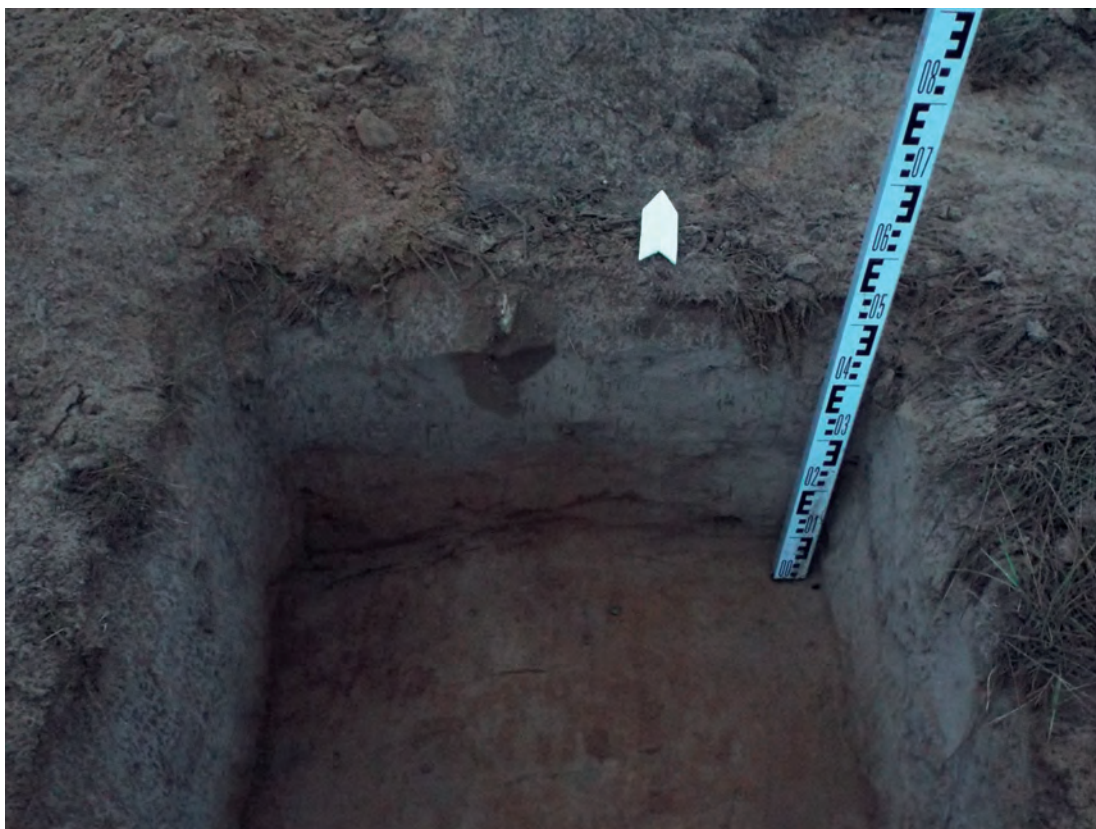
Рис.15. Строительство межпоселкового газопровода к д. Солоково Кирово-Чепецкого района Кировской области. Шурф 1. Северный борт. Вид с Ю.
