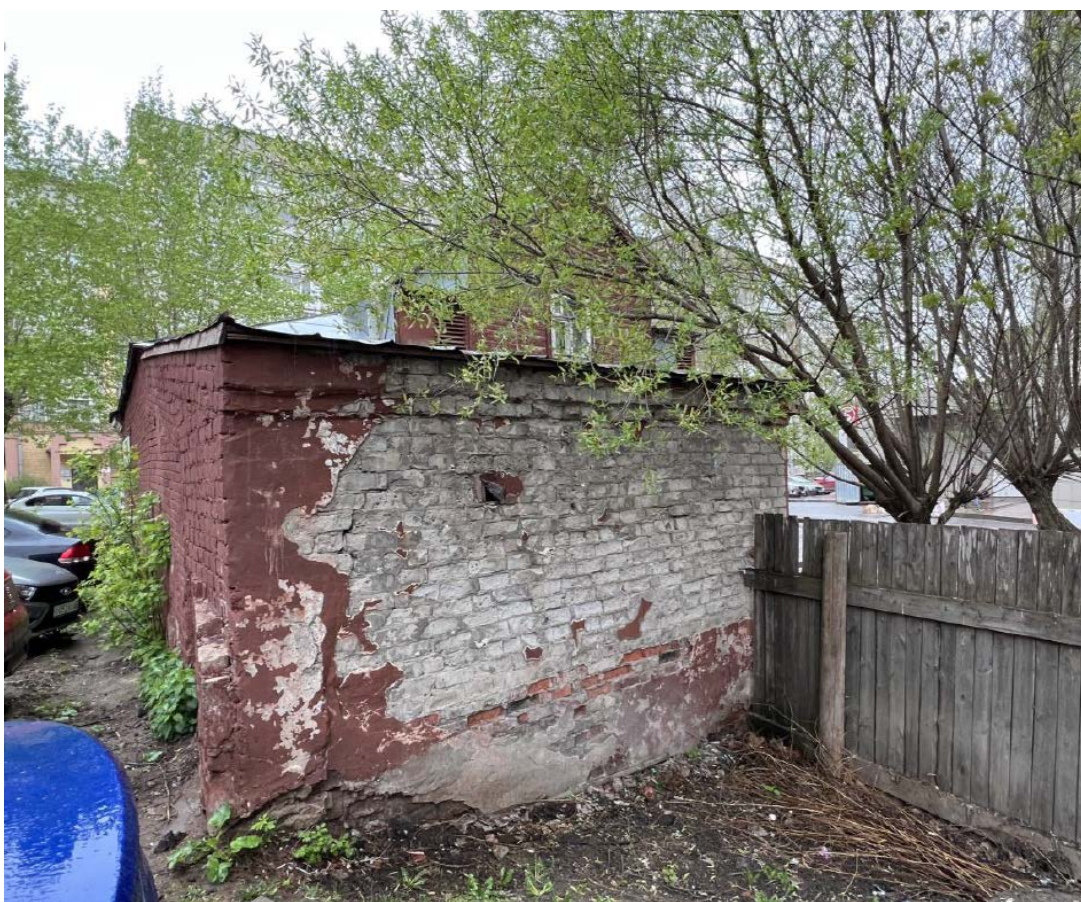
Фото 4. Фрагмент дворового фасада.
