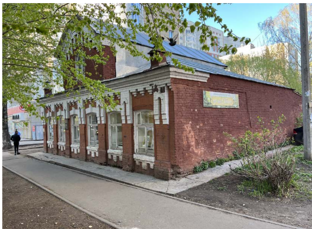
Фото 2. Общий вид Объекта с юго-западной стороны
