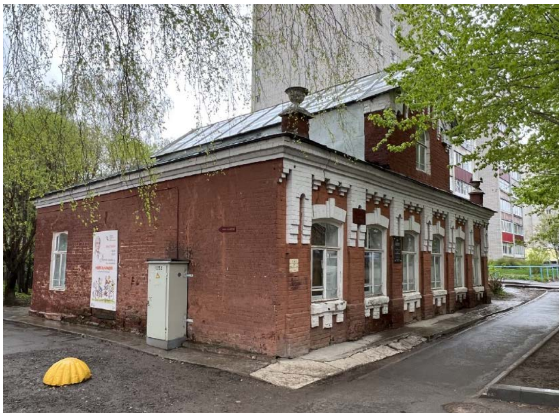
Фото 1. Общий вид Объекта с северо-западной стороны.
