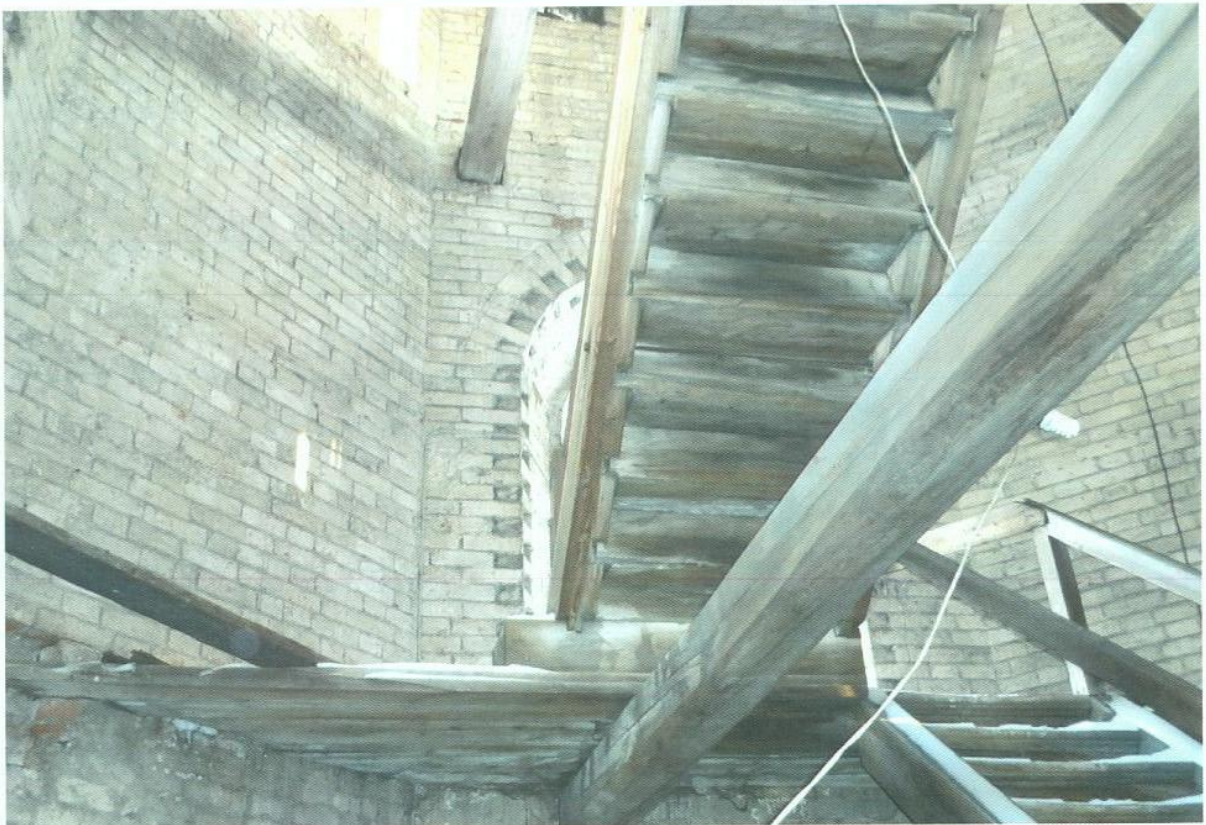
Фото 4. «Ансамбль бывшего Христорождественского женского монастыря: колокольня», Слободской район, г. Слободской, улицы Большевиков, Вятская, Гоголя, Ленина. Фото Брызгалов Ю.П. Дата – 27.01.2016.
