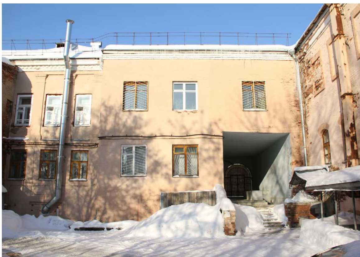
Фото 4. Фрагмент дворового фасада.
