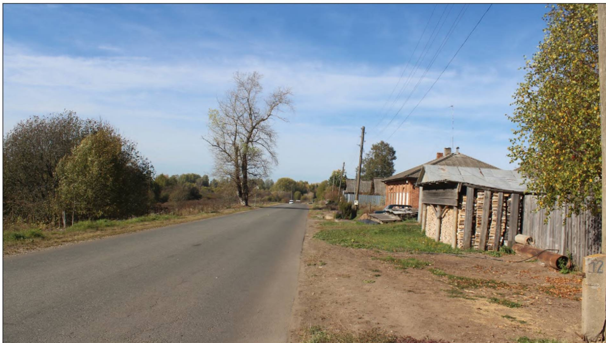
Рис. 14. Кировская область, Кирово-Чепецкий район. «Газопровод распределительный в дер. Ванихинцы Кирово-Чепецкого муниципального района Кировской области». Точка фотофиксации 2. Вид с востока-юго-востока.
