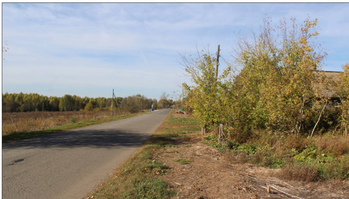
Рис. 15. Кировская область, Кирово-Чепецкий район. «Газопровод распределительный в дер. Ванихинцы Кирово-Чепецкого муниципального района Кировской области». Точка фотофиксации 3. Вид с востока-юго-востока.
