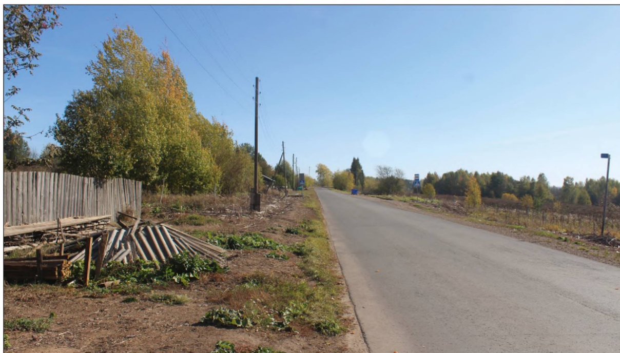
Рис. 13. Кировская область, Кирово-Чепецкий район. «Газопровод распределительный в дер. Ванихинцы Кирово-Чепецкого муниципального района Кировской области». Точка фотофиксации 2. Вид с запада-северо-запада.
