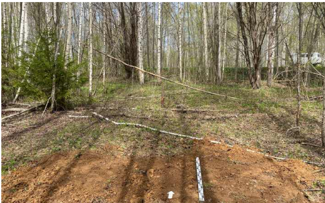
Рис.233. "Газопровод межпоселковый к пгт Арбаж Арбажского муниципального округа Кировской области" в Арбажском и Советском муниципальных округах Кировской области. Шурф 7. Рекультивация. Вид с Ю.
