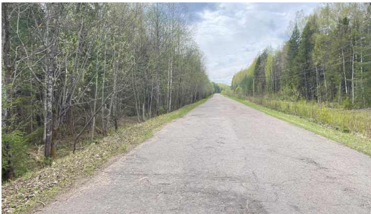
Рис.92. "Газопровод межпоселковый к пгт Арбаж Арбажского муниципального округа Кировской области" в Арбажском и Советском муниципальных округах Кировской области. Рельеф местности и характер растительности участка обследования. Точка фотофиксации 9, вид с СВ.
