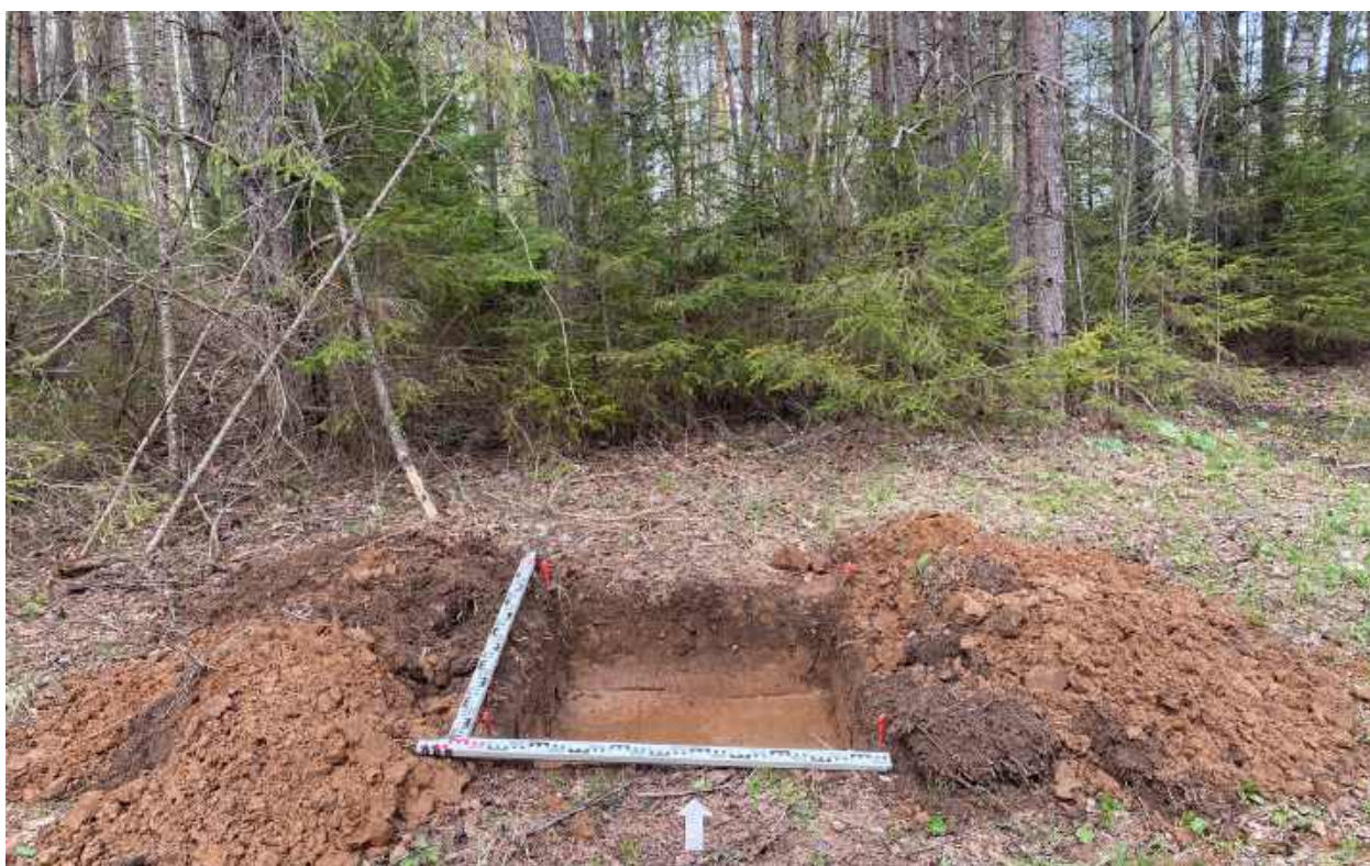
Рис.220. "Газопровод межпоселковый к пгт Арбаж Арбажского муниципального округа Кировской области" в Арбажском и Советском муниципальных округах Кировской области. Шурф 5. Антураж. Вид с Ю.
