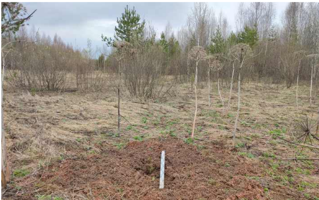
Рис.313. "Газопровод межпоселковый к пгт Арбаж Арбажского муниципального округа Кировской области" в Арбажском и Советском муниципальных округах Кировской области. Шурф 23. Рекультивация. Вид с Ю.
