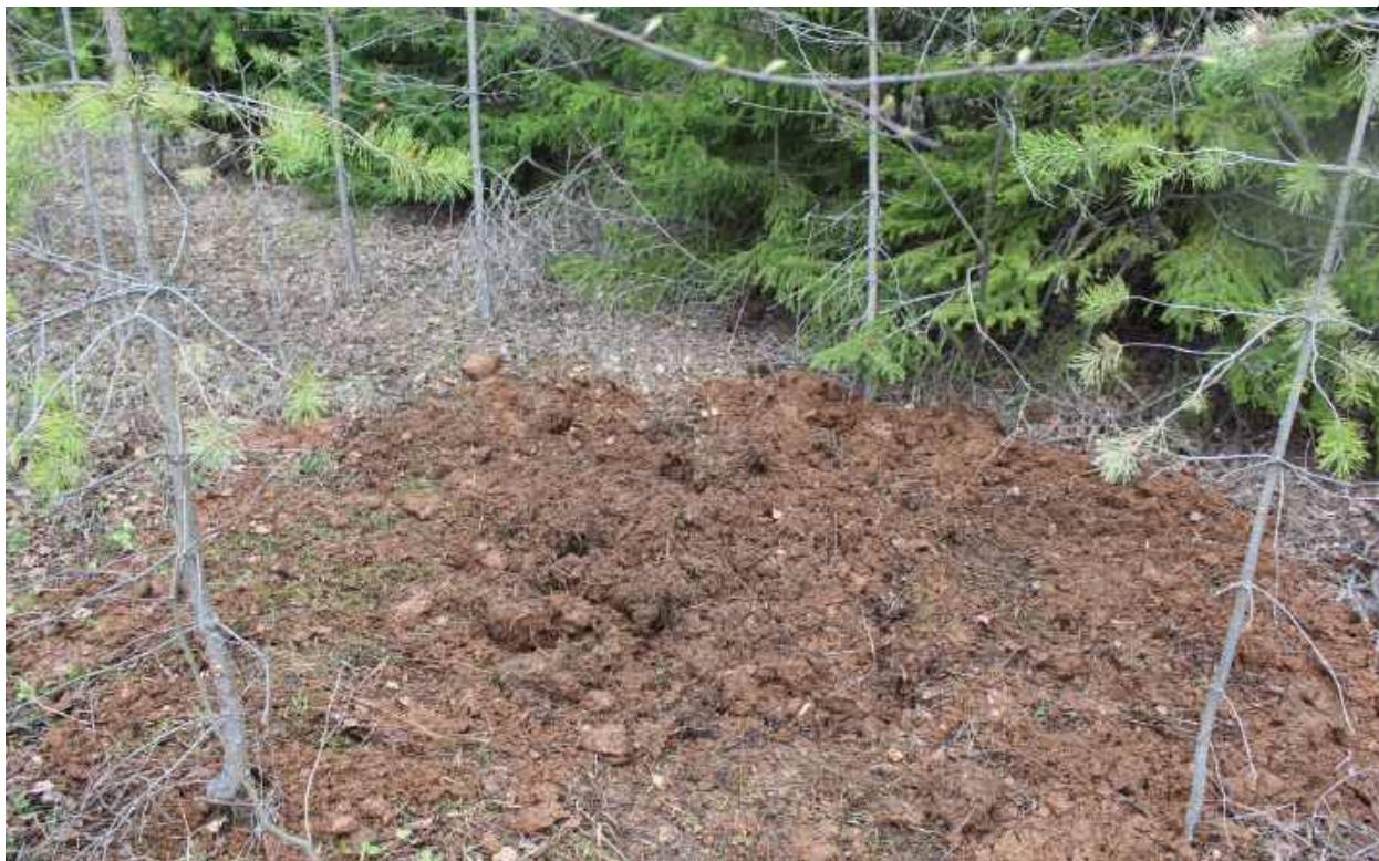
Рис.413. "Газопровод межпоселковый к пгт Арбаж Арбажского муниципального округа Кировской области" в Арбажском и Советском муниципальных округах Кировской области. Шурф 43. Рекультивация. Вид с Ю.
