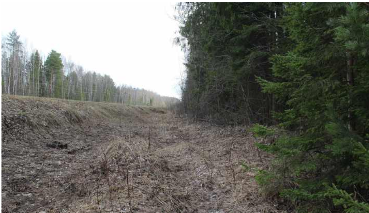
Рис.153. "Газопровод межпоселковый к пгт Арбаж Арбажского муниципального округа Кировской области" в Арбажском и Советском муниципальных округах Кировской области. Рельеф местности и характер растительности участка обследования. Точка фотофиксации 70, вид с ССЗ.
