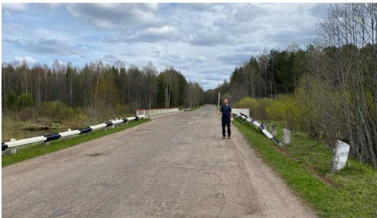
Рис.95. "Газопровод межпоселковый к пгт Арбаж Арбажского муниципального округа Кировской области" в Арбажском и Советском муниципальных округах Кировской области. Рельеф местности и характер растительности участка обследования. Точка фотофиксации 12, Вид с З.
