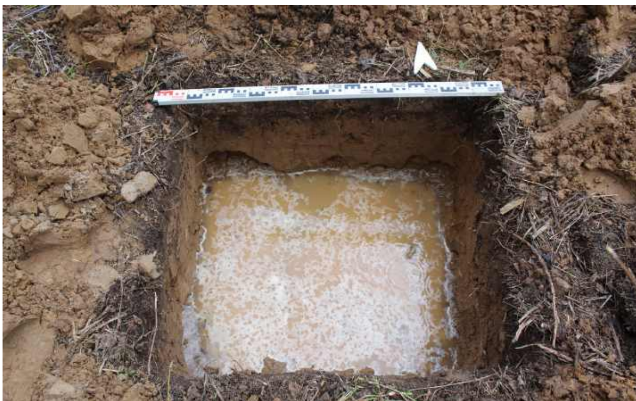
Рис.387. "Газопровод межпоселковый к пгт Арбаж Арбажского муниципального округа Кировской области" в Арбажском и Советском муниципальных округах Кировской области. Шурф 38. Материк. Вид с Ю.
