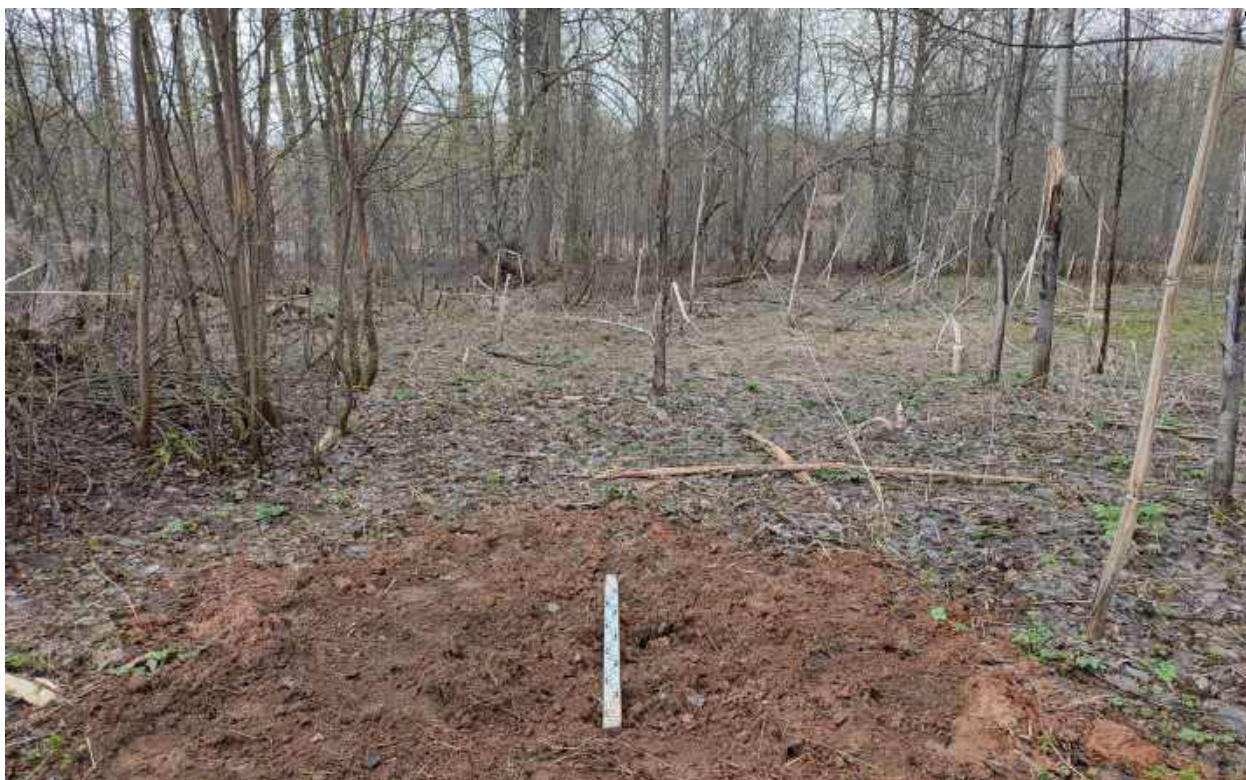
Рис.318. "Газопровод межпоселковый к пгт Арбаж Арбажского муниципального округа Кировской области" в Арбажском и Советском муниципальных округах Кировской области. Шурф 24. Рекультивация. Вид с Ю.
