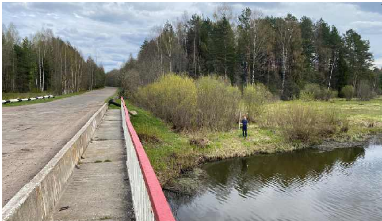
Рис.96. "Газопровод межпоселковый к пгт Арбаж Арбажского муниципального округа Кировской области" в Арбажском и Советском муниципальных округах Кировской области. Рельеф местности и характер растительности участка обследования. Точка фотофиксации 13, вид с З.
