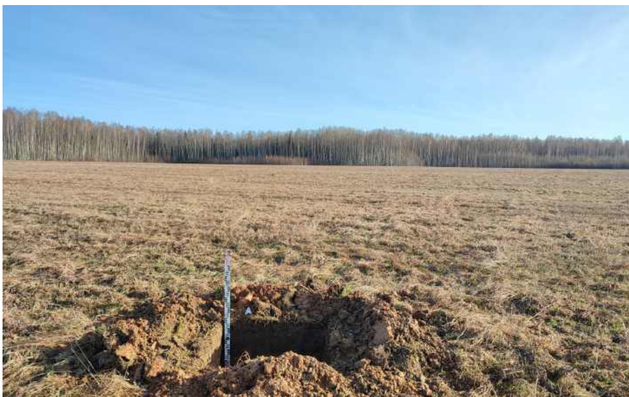
Рис.245. "Газопровод межпоселковый к пгт Арбаж Арбажского муниципального округа Кировской области" в Арбажском и Советском муниципальных округах Кировской области. Шурф 10. Антураж. Вид с Ю.
