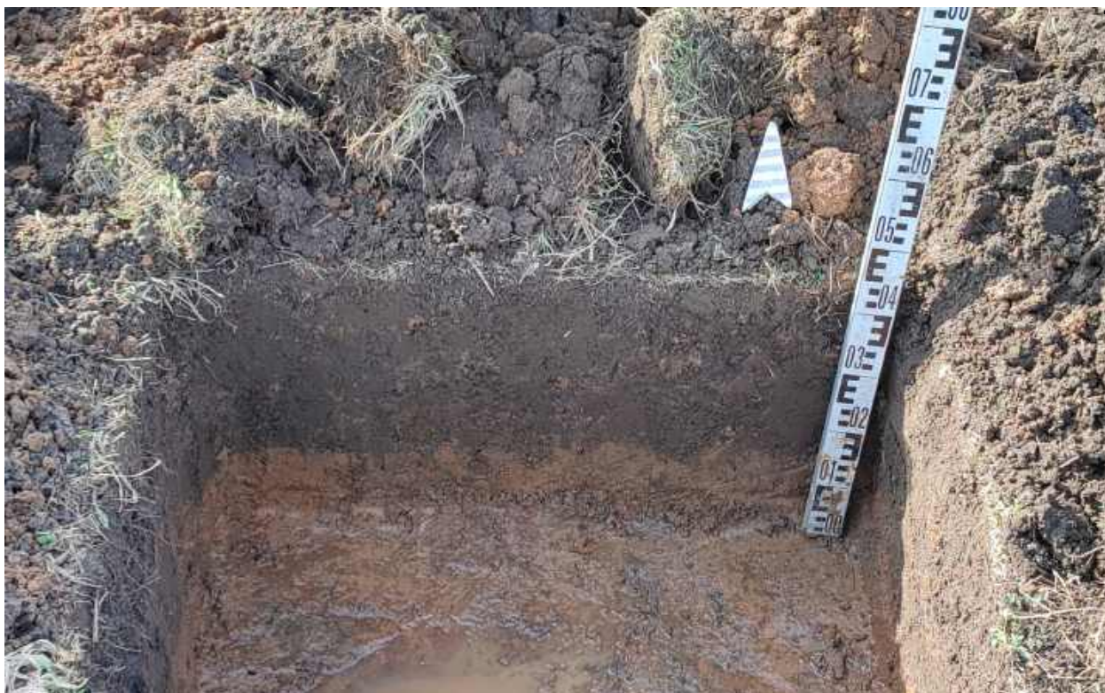
Рис.291. "Газопровод межпоселковый к пгт Арбаж Арбажского муниципального округа Кировской области" в Арбажском и Советском муниципальных округах Кировской области. Шурф 19. Северный борт. Вид с Ю.
