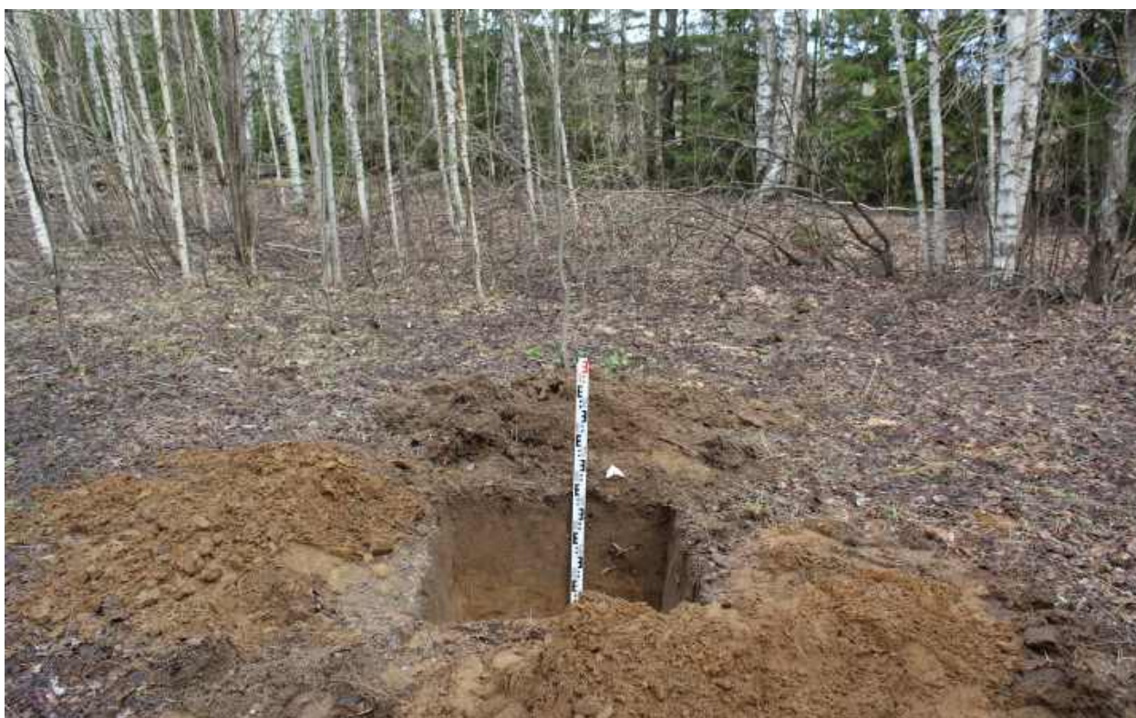
Рис.405. "Газопровод межпоселковый к пгт Арбаж Арбажского муниципального округа Кировской области" в Арбажском и Советском муниципальных округах Кировской области. Шурф 42. Антураж. Вид с Ю.
