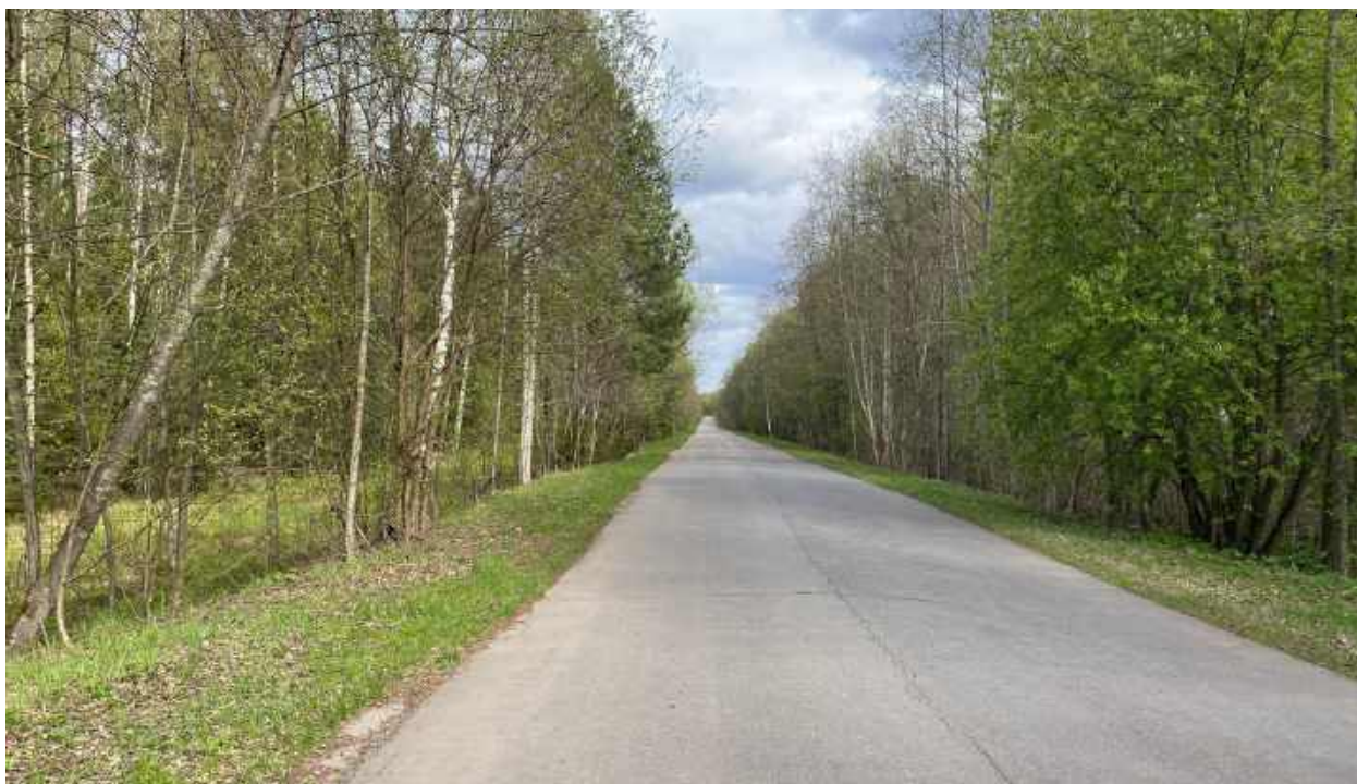
Рис.86. "Газопровод межпоселковый к пгт Арбаж Арбажского муниципального округа Кировской области" в Арбажском и Советском муниципальных округах Кировской области. Рельеф местности и характер растительности участка обследования. Точка фотофиксации 3, вид с СЗ.
