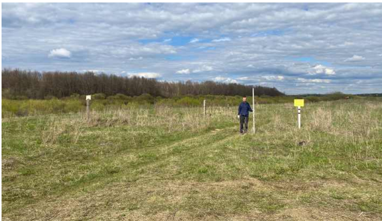
Рис.185. "Газопровод межпоселковый к пгт Арбаж Арбажского муниципального округа Кировской области" в Арбажском и Советском муниципальных округах Кировской области. Рельеф местности и характер растительности участка обследования. Точка фотофиксации 102, вид с ЮЗ.
