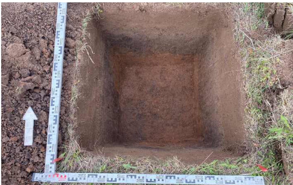
Рис.457. "Газопровод межпоселковый к пгт Арбаж Арбажского муниципального округа Кировской области" в Арбажском и Советском муниципальных округах Кировской области. Шурф 52. Материк. Вид с Ю.
