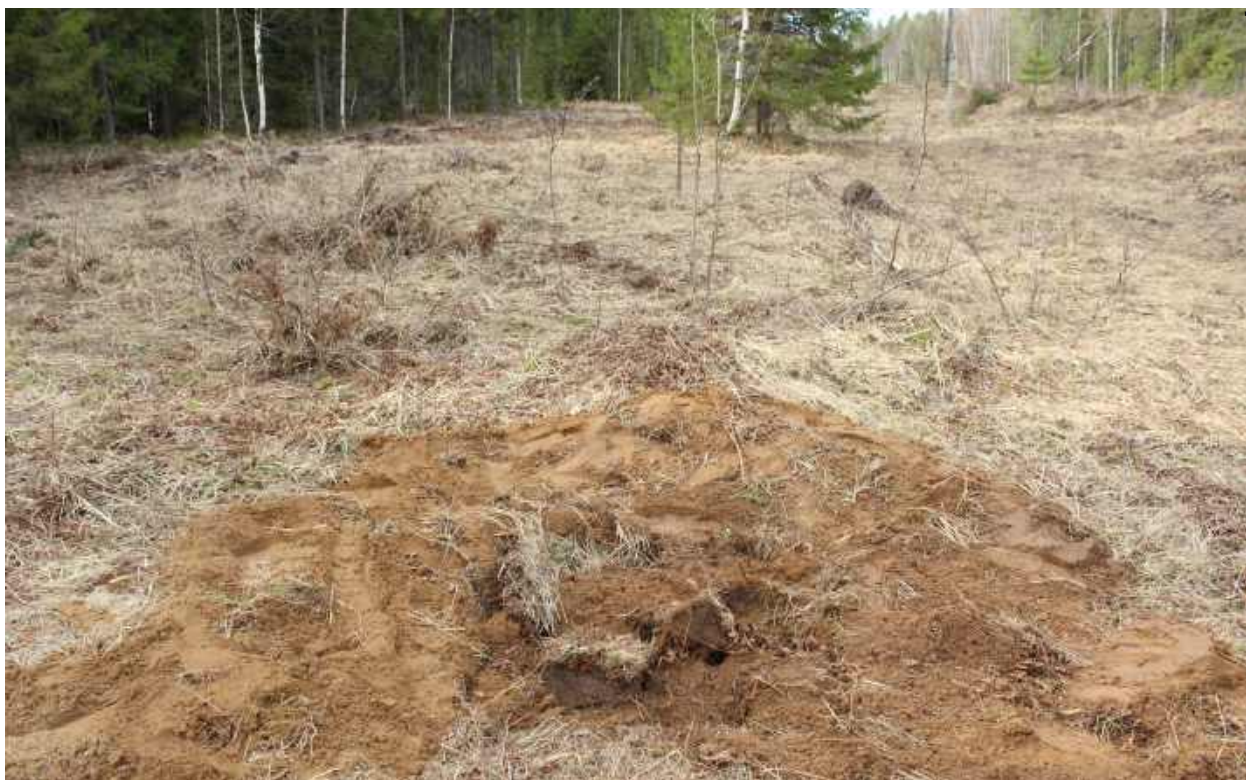
Рис.358. "Газопровод межпоселковый к пгт Арбаж Арбажского муниципального округа Кировской области" в Арбажском и Советском муниципальных округах Кировской области. Шурф 32. Рекультивация. Вид с Ю.
