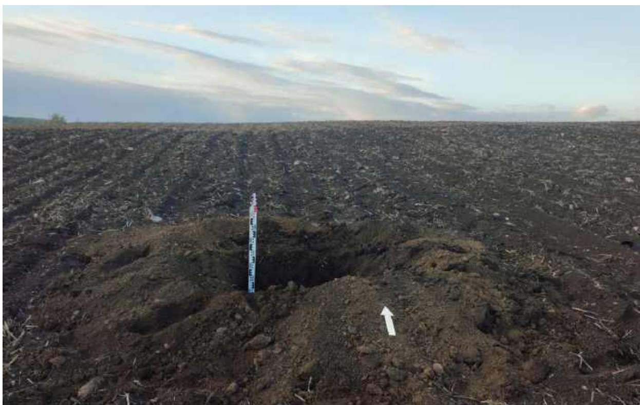
Рис.470. "Газопровод межпоселковый к пгт Арбаж Арбажского муниципального округа Кировской области" в Арбажском и Советском муниципальных округах Кировской области. Шурф 55. Антураж. Вид с Ю.
