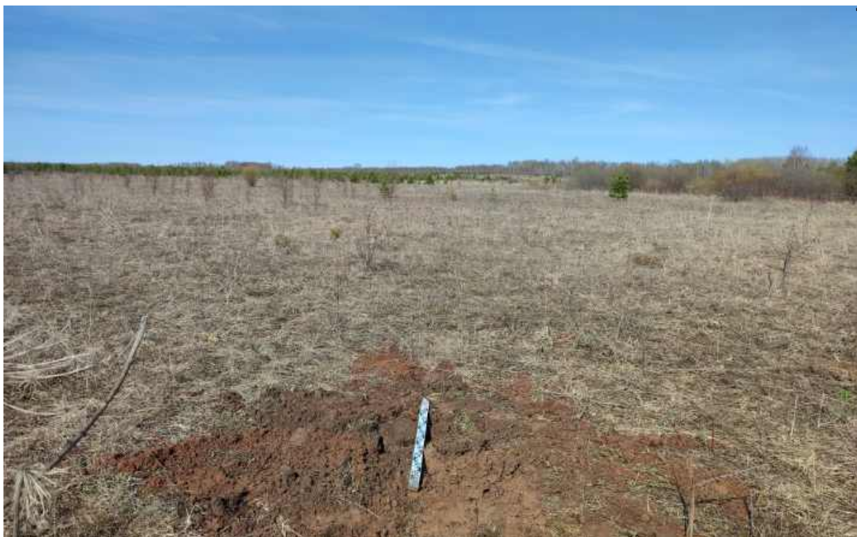
Рис.283. "Газопровод межпоселковый к пгт Арбаж Арбажского муниципального округа Кировской области" в Арбажском и Советском муниципальных округах Кировской области. Шурф 17. Рекультивация. Вид с Ю.
