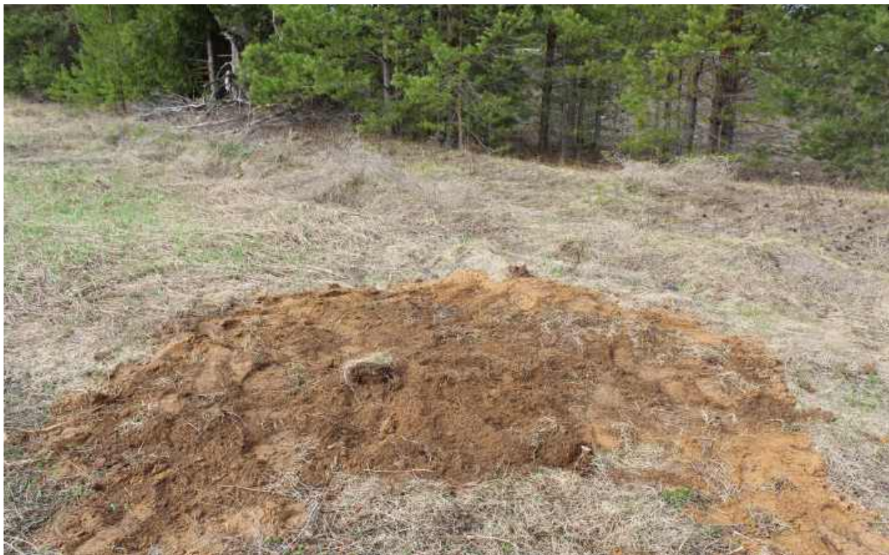
Рис.353. "Газопровод межпоселковый к пгт Арбаж Арбажского муниципального округа Кировской области" в Арбажском и Советском муниципальных округах Кировской области. Шурф 31. Рекультивация. Вид с Ю.
