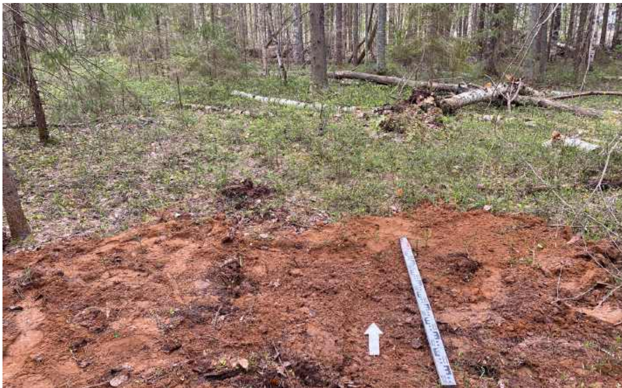
Рис.218. "Газопровод межпоселковый к пгт Арбаж Арбажского муниципального округа Кировской области" в Арбажском и Советском муниципальных округах Кировской области. Шурф 4. Рекультивация. Вид с Ю.
