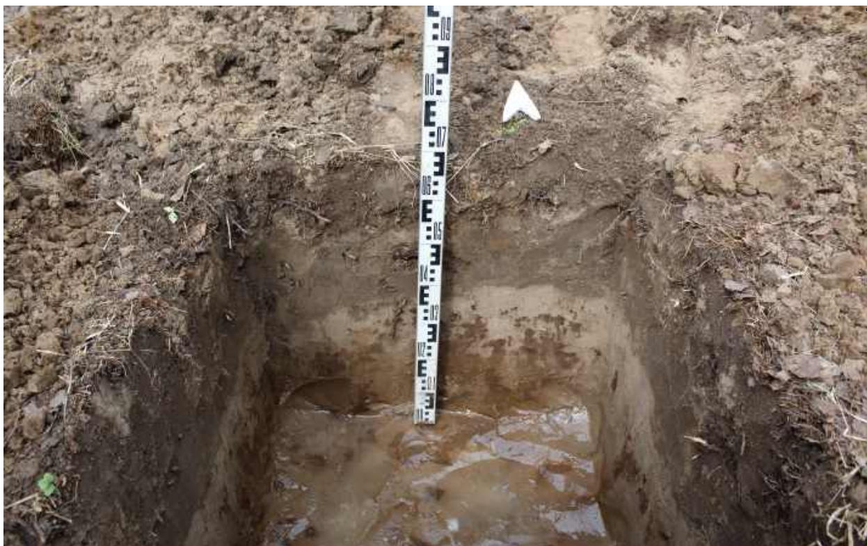
Рис.376. "Газопровод межпоселковый к пгт Арбаж Арбажского муниципального округа Кировской области" в Арбажском и Советском муниципальных округах Кировской области. Шурф 36. Северный борт. Вид с Ю.
