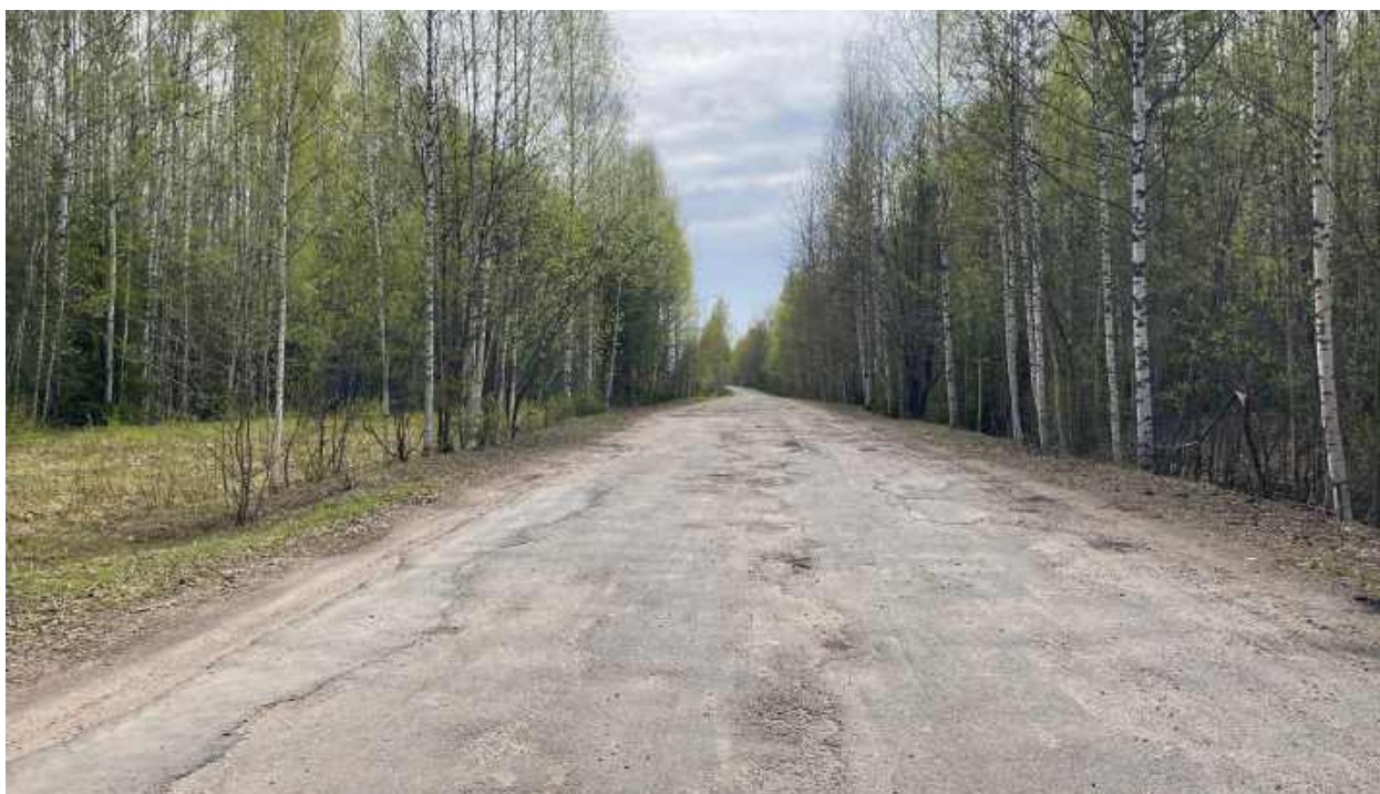
Рис.105. "Газопровод межпоселковый к пгт Арбаж Арбажского муниципального округа Кировской области" в Арбажском и Советском муниципальных округах Кировской области. Рельеф местности и характер растительности участка обследования. Точка фотофиксации 22, вид с СЗ.
