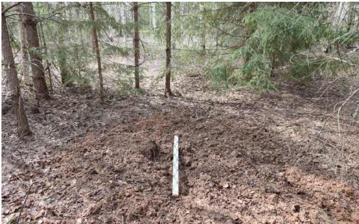
Рис.298. "Газопровод межпоселковый к пгт Арбаж Арбажского муниципального округа Кировской области" в Арбажском и Советском муниципальных округах Кировской области. Шурф 20. Рекультивация. Вид с Ю.
