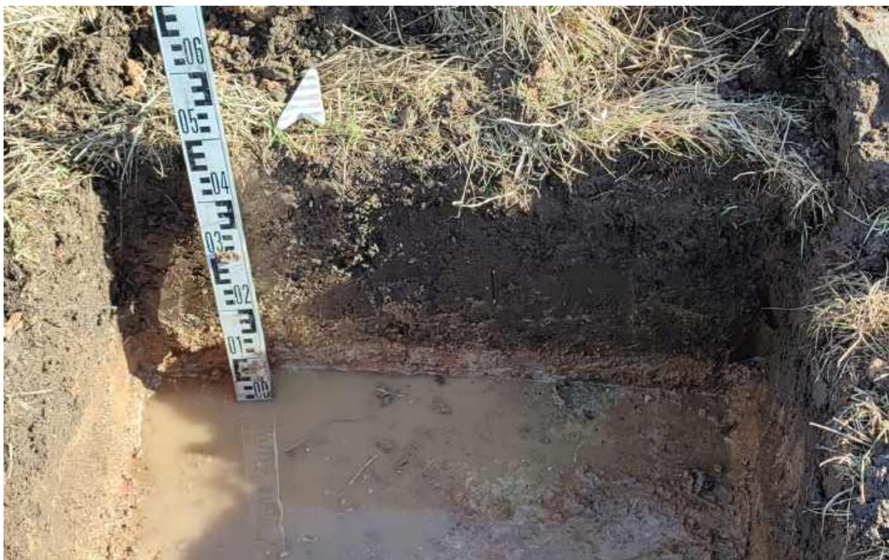
Рис.261. "Газопровод межпоселковый к пгт Арбаж Арбажского муниципального округа Кировской области" в Арбажском и Советском муниципальных округах Кировской области. Шурф 13. Северный борт. Вид с Ю.
