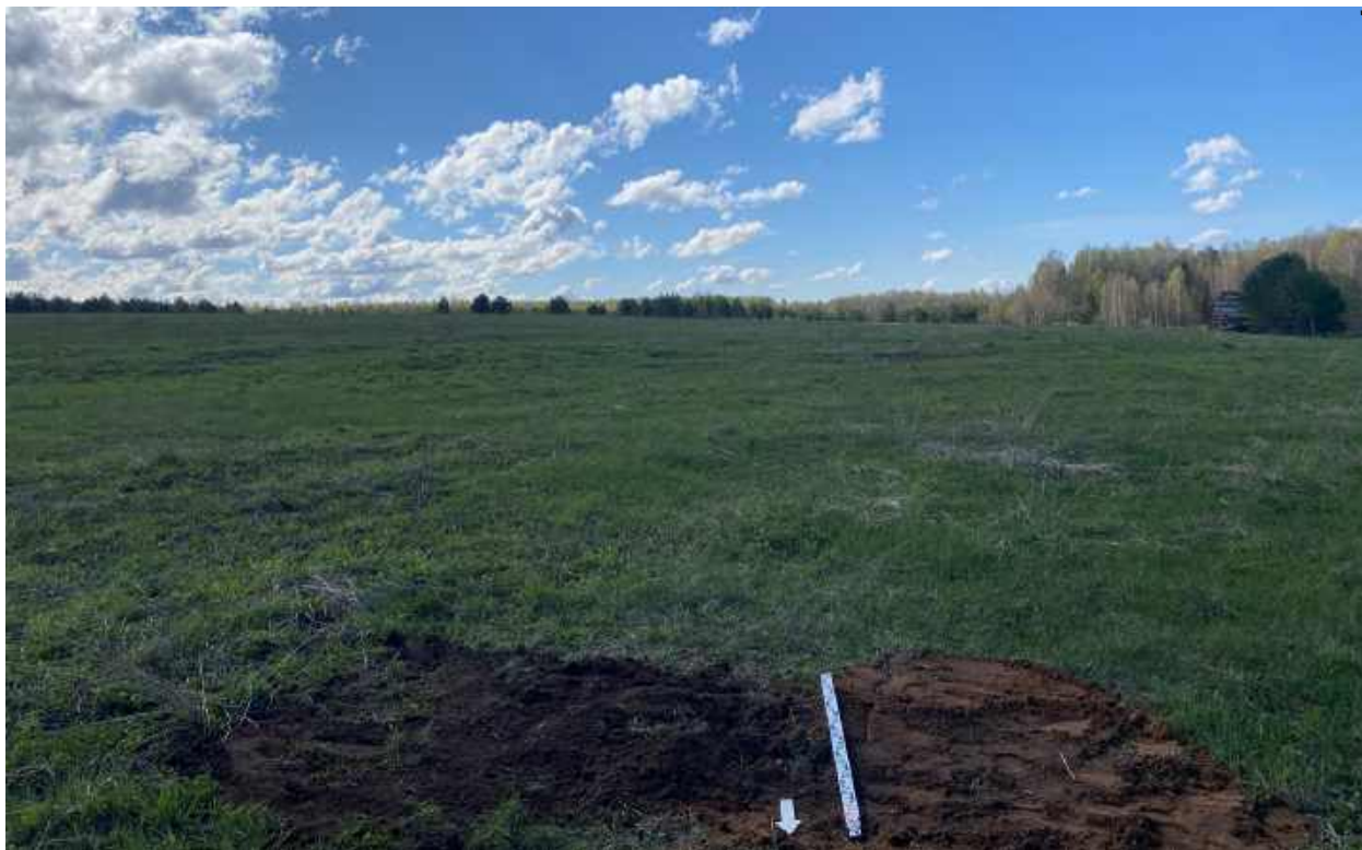
Рис.328. "Газопровод межпоселковый к пгт Арбаж Арбажского муниципального округа Кировской области" в Арбажском и Советском муниципальных округах Кировской области. Шурф 26. Рекультивация. Вид с Ю.
