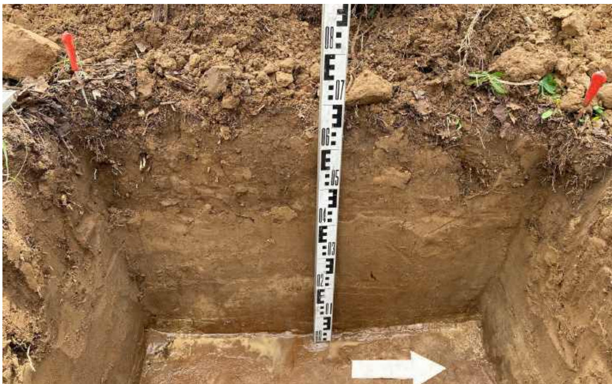
Рис.206. "Газопровод межпоселковый к пгт Арбаж Арбажского муниципального округа Кировской области" в Арбажском и Советском муниципальных округах Кировской области. Шурф 2. Западный борт. Вид с В.
