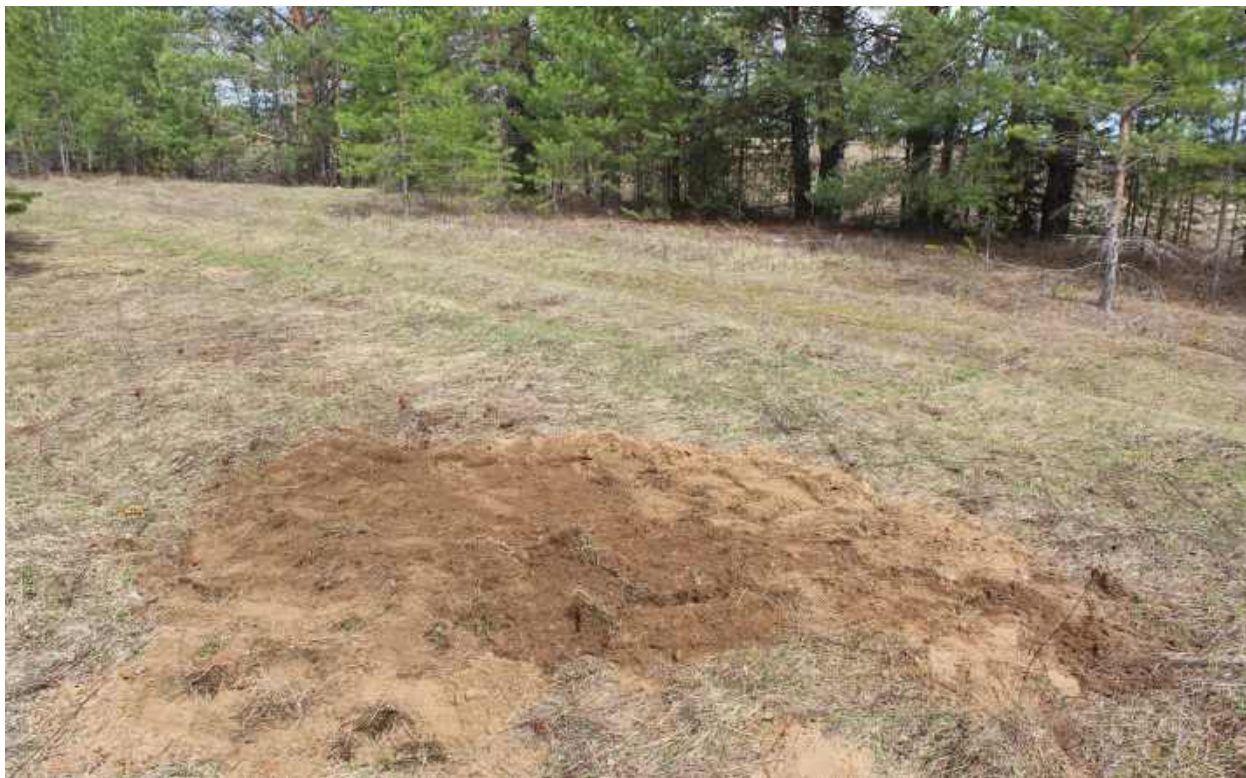
Рис.398. "Газопровод межпоселковый к пгт Арбаж Арбажского муниципального округа Кировской области" в Арбажском и Советском муниципальных округах Кировской области. Шурф 40. Рекультивация. Вид с Ю.
