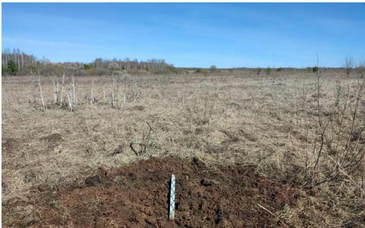
Рис.273. "Газопровод межпоселковый к пгт Арбаж Арбажского муниципального округа Кировской области" в Арбажском и Советском муниципальных округах Кировской области. Шурф 15. Рекультивация. Вид с Ю.
