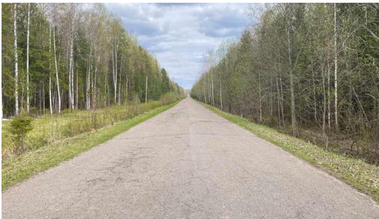
Рис.93. "Газопровод межпоселковый к пгт Арбаж Арбажского муниципального округа Кировской области" в Арбажском и Советском муниципальных округах Кировской области. Рельеф местности и характер растительности участка обследования. Точка фотофиксации 10, вид с З.
