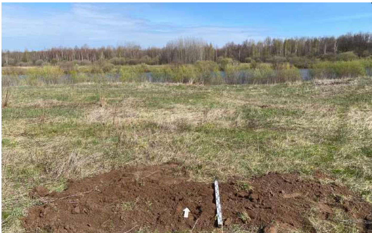
Рис.453. "Газопровод межпоселковый к пгт Арбаж Арбажского муниципального округа Кировской области" в Арбажском и Советском муниципальных округах Кировской области. Шурф 51. Рекультивация. Вид с Ю.
