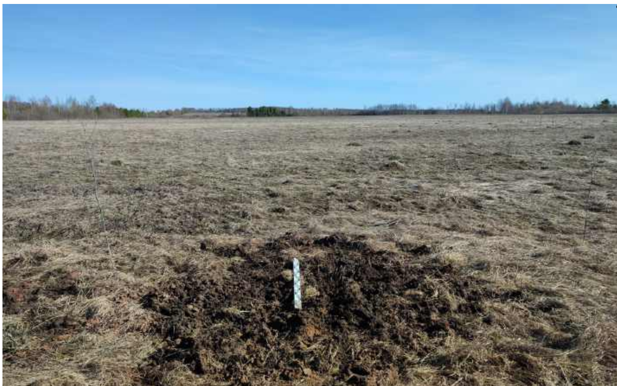
Рис.263. "Газопровод межпоселковый к пгт Арбаж Арбажского муниципального округа Кировской области" в Арбажском и Советском муниципальных округах Кировской области. Шурф 13. Рекультивация. Вид с Ю.
