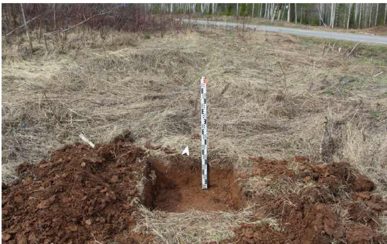
Рис.360. "Газопровод межпоселковый к пгт Арбаж Арбажского муниципального округа Кировской области" в Арбажском и Советском муниципальных округах Кировской области. Шурф 33. Антураж. Вид с Ю.
