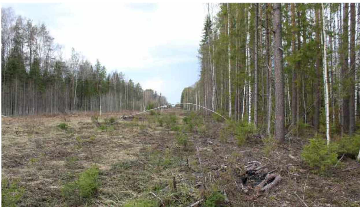
Рис.149. "Газопровод межпоселковый к пгт Арбаж Арбажского муниципального округа Кировской области" в Арбажском и Советском муниципальных округах Кировской области. Рельеф местности и характер растительности участка обследования. Точка фотофиксации 66, вид с СЗ.
