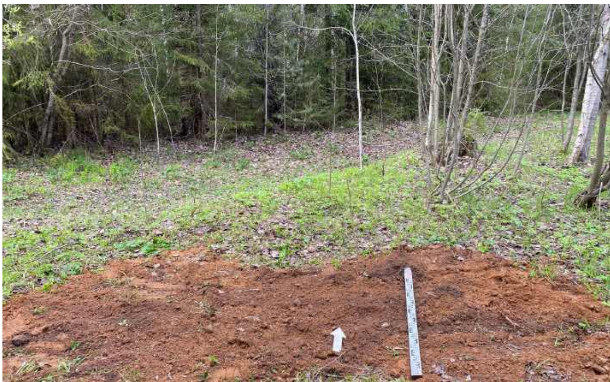
Рис.213. "Газопровод межпоселковый к пгт Арбаж Арбажского муниципального округа Кировской области" в Арбажском и Советском муниципальных округах Кировской области. Шурф 3. Рекультивация. Вид с Ю.
