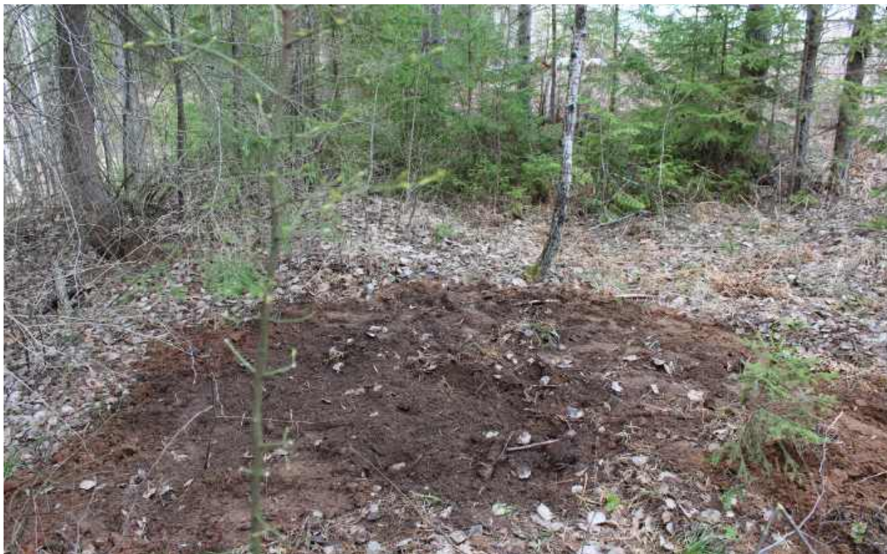
Рис.368. "Газопровод межпоселковый к пгт Арбаж Арбажского муниципального округа Кировской области" в Арбажском и Советском муниципальных округах Кировской области. Шурф 34. Рекультивация. Вид с Ю.
