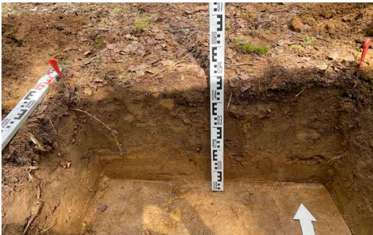
Рис.236. "Газопровод межпоселковый к пгт Арбаж Арбажского муниципального округа Кировской области" в Арбажском и Советском муниципальных округах Кировской области. Шурф 8. Северный борт. Вид с Ю.
