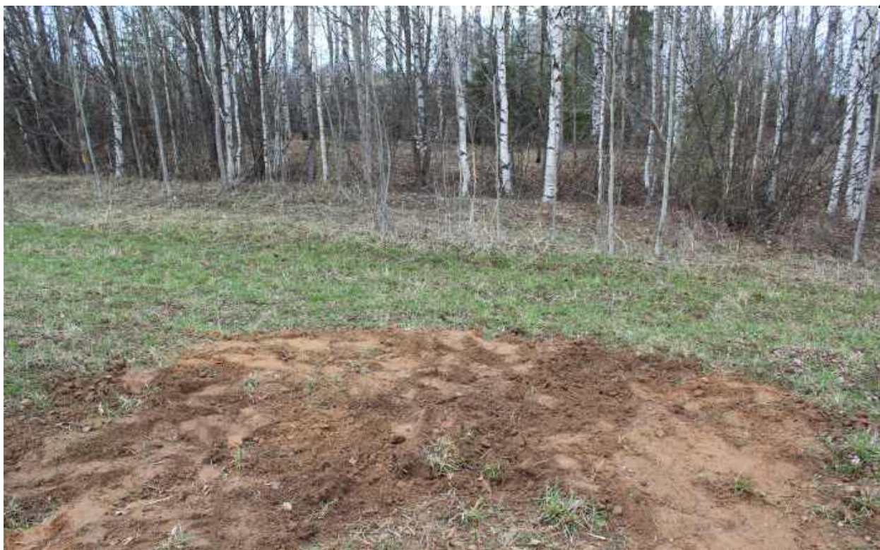
Рис.423. "Газопровод межпоселковый к пгт Арбаж Арбажского муниципального округа Кировской области" в Арбажском и Советском муниципальных округах Кировской области. Шурф 45. Рекультивация. Вид с Ю.
