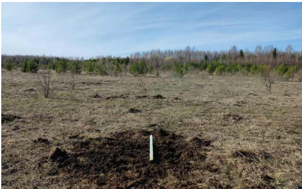
Рис.293. "Газопровод межпоселковый к пгт Арбаж Арбажского муниципального округа Кировской области" в Арбажском и Советском муниципальных округах Кировской области. Шурф 19. Рекультивация. Вид с Ю.
