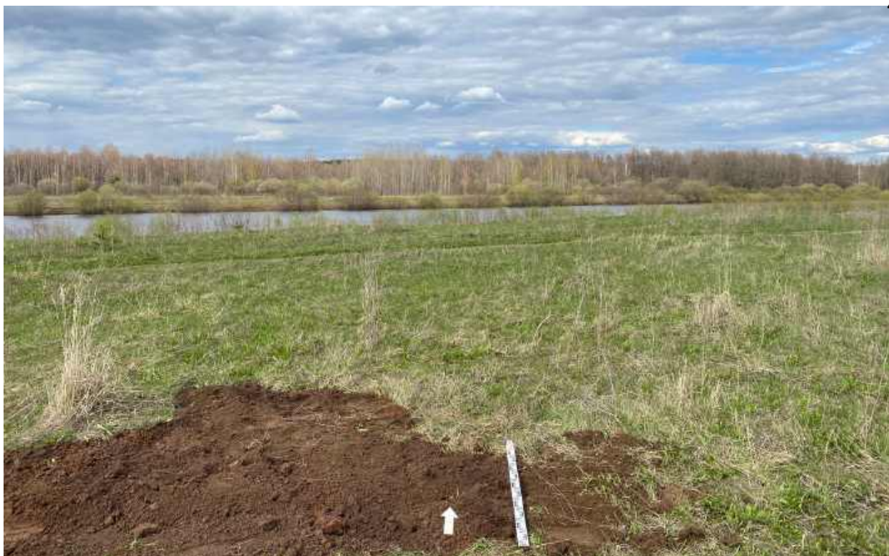
Рис.458. "Газопровод межпоселковый к пгт Арбаж Арбажского муниципального округа Кировской области" в Арбажском и Советском муниципальных округах Кировской области. Шурф 52. Рекультивация. Вид с Ю.
