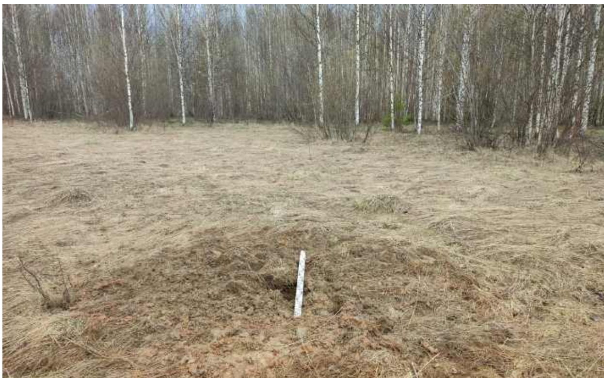
Рис.308. "Газопровод межпоселковый к пгт Арбаж Арбажского муниципального округа Кировской области" в Арбажском и Советском муниципальных округах Кировской области. Шурф 22. Рекультивация. Вид с Ю.
