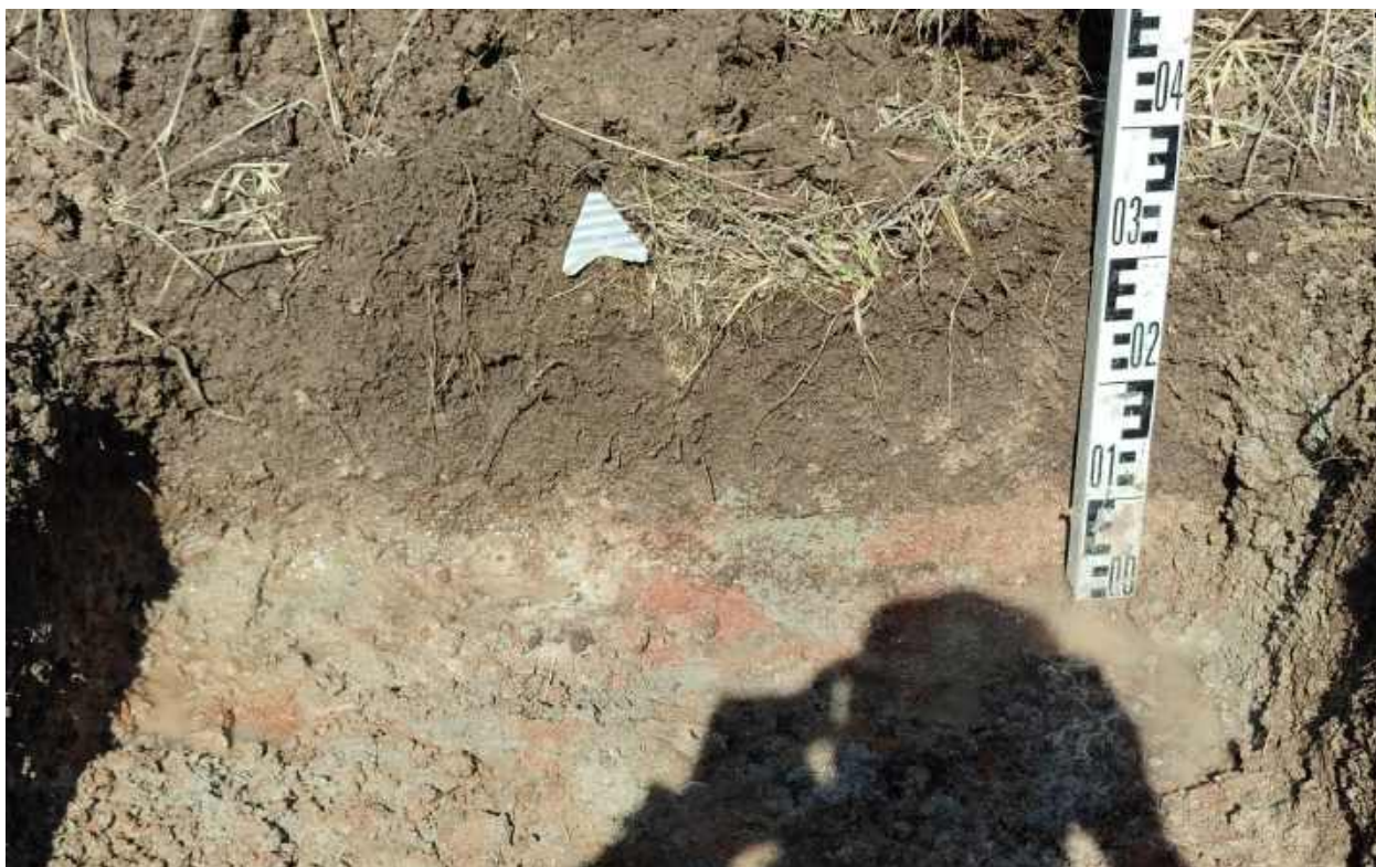
Рис.276. "Газопровод межпоселковый к пгт Арбаж Арбажского муниципального округа Кировской области" в Арбажском и Советском муниципальных округах Кировской области. Шурф 16. Северный борт. Вид с Ю.
