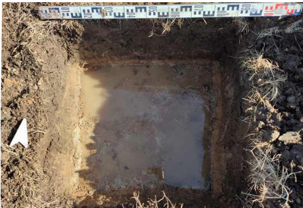
Рис.262. "Газопровод межпоселковый к пгт Арбаж Арбажского муниципального округа Кировской области" в Арбажском и Советском муниципальных округах Кировской области. Шурф 13. Материк. Вид с Ю.
