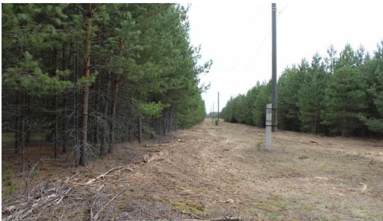
Рис.151. "Газопровод межпоселковый к пгт Арбаз Арбазского муниципального округа Кировской области" в Арбазском и Советском муниципальных округах Кировской области. Рельеф местности и характер растительности участка обследования. Точка фотофиксации 68, вид с ССЗ.
