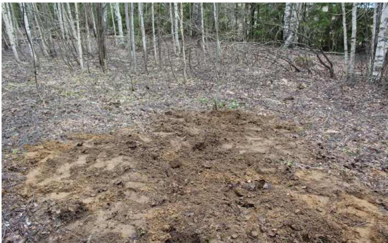
Рис.408. "Газопровод межпоселковый к пгт Арбаж Арбажского муниципального округа Кировской области" в Арбажском и Советском муниципальных округах Кировской области. Шурф 42. Рекультивация. Вид с Ю.
