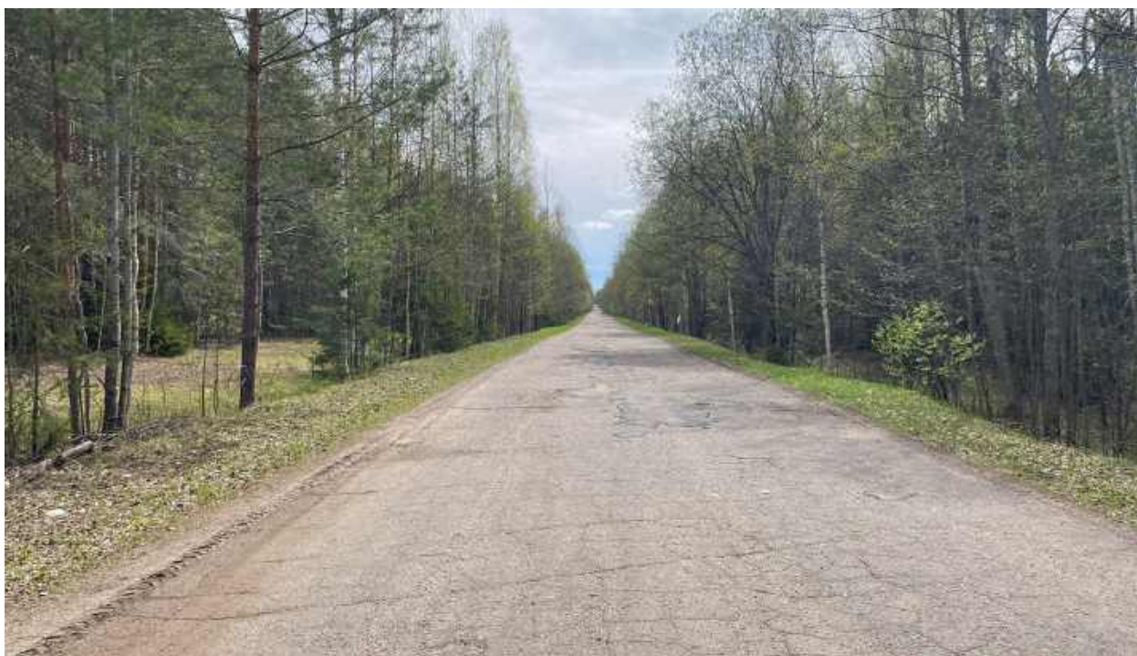
Рис.103. "Газопровод межпоселковый к пгт Арбаж Арбажского муниципального округа Кировской области" в Арбажском и Советском муниципальных округах Кировской области. Рельеф местности и характер растительности участка обследования. Точка фотофиксации 20, вид с СЗ.
