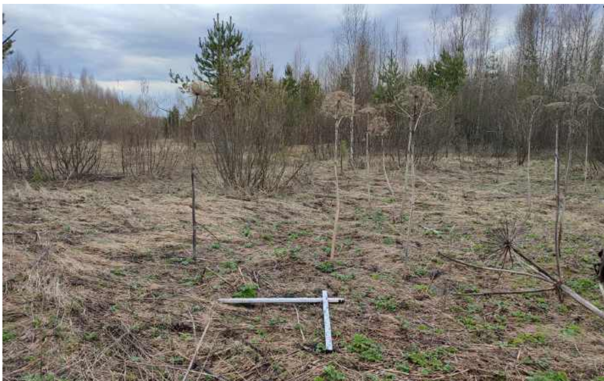
Рис.309. "Газопровод межпоселковый к пгт Арбаж Арбажского муниципального округа Кировской области" в Арбажском и Советском муниципальных округах Кировской области. Шурф 23. Закладка. Вид с Ю.
