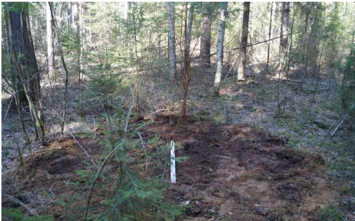
Рис.443. "Газопровод межпоселковый к пгт Арбаж Арбажского муниципального округа Кировской области" в Арбажском и Советском муниципальных округах Кировской области. Шурф 49. Рекультивация. Вид с Ю.
