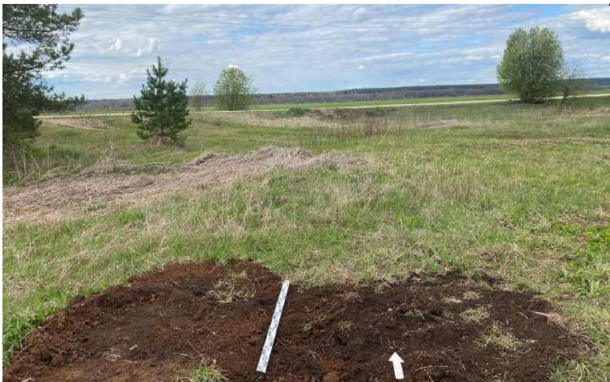
Рис.468. "Газопровод межпоселковый к пгт Арбаж Арбажского муниципального округа Кировской области" в Арбажском и Советском муниципальных округах Кировской области. Шурф 54. Рекультивация. Вид с Ю.
