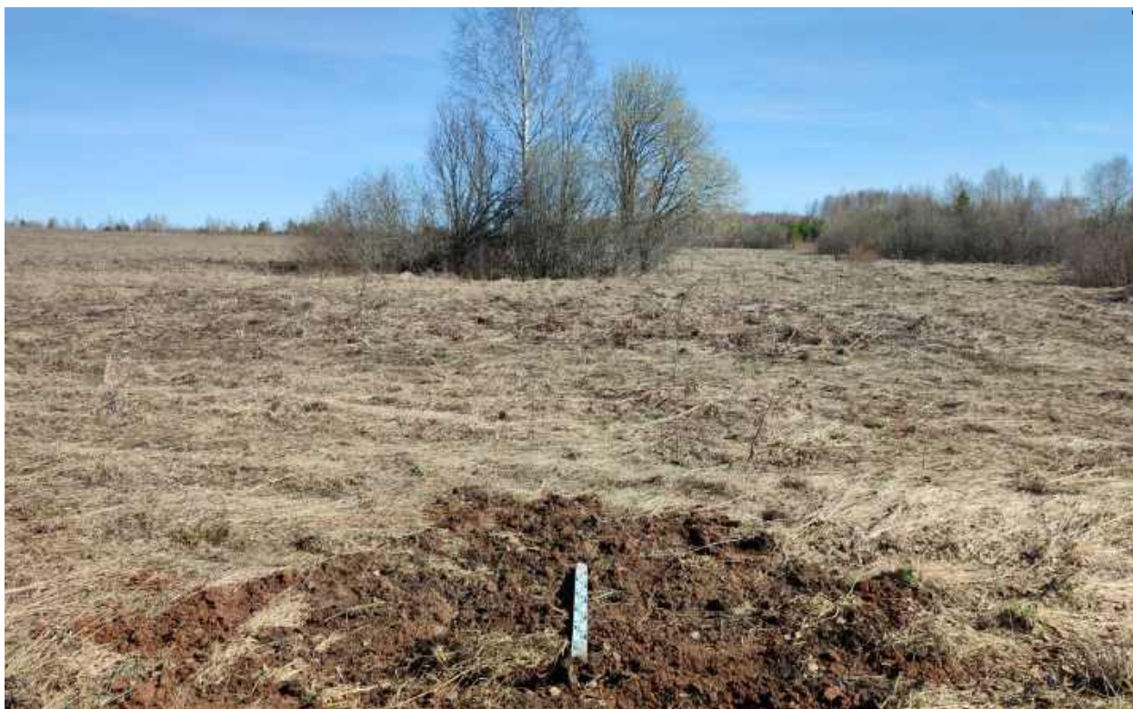
Рис.268. "Газопровод межпоселковый к пгт Арбаж Арбажского муниципального округа Кировской области" в Арбажском и Советском муниципальных округах Кировской области. Шурф 14. Рекультивация. Вид с Ю.
