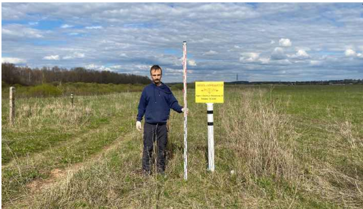
Рис.186. "Газопровод межпоселковый к пгт Арбаж Арбажского муниципального округа Кировской области" в Арбажском и Советском муниципальных округах Кировской области. Рельеф местности и характер растительности участка обследования. Точка фотофиксации 103, вид с ЮЗ.
