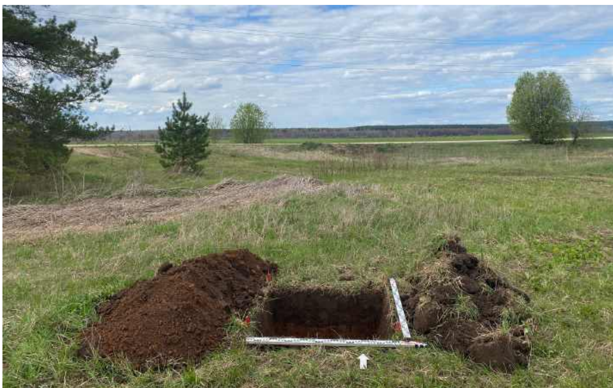
Рис.465. "Газопровод межпоселковый к пгт Арбаж Арбажского муниципального округа Кировской области" в Арбажском и Советском муниципальных округах Кировской области. Шурф 54. Антураж. Вид с Ю.
