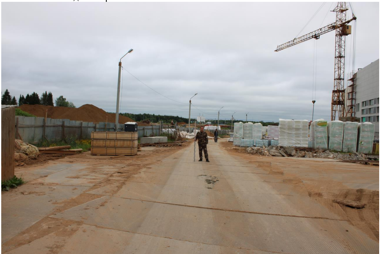
Рис. 21. Археологическая разведка на территории земельных участков, выделенных под строительство объекта "Улично-дорожная сеть для подъезда к детскому саду и школе по ул. Дорофеева г. Кирова" в 2024 г. Общий вид на северный участок проведения работ. Вид с запада.
