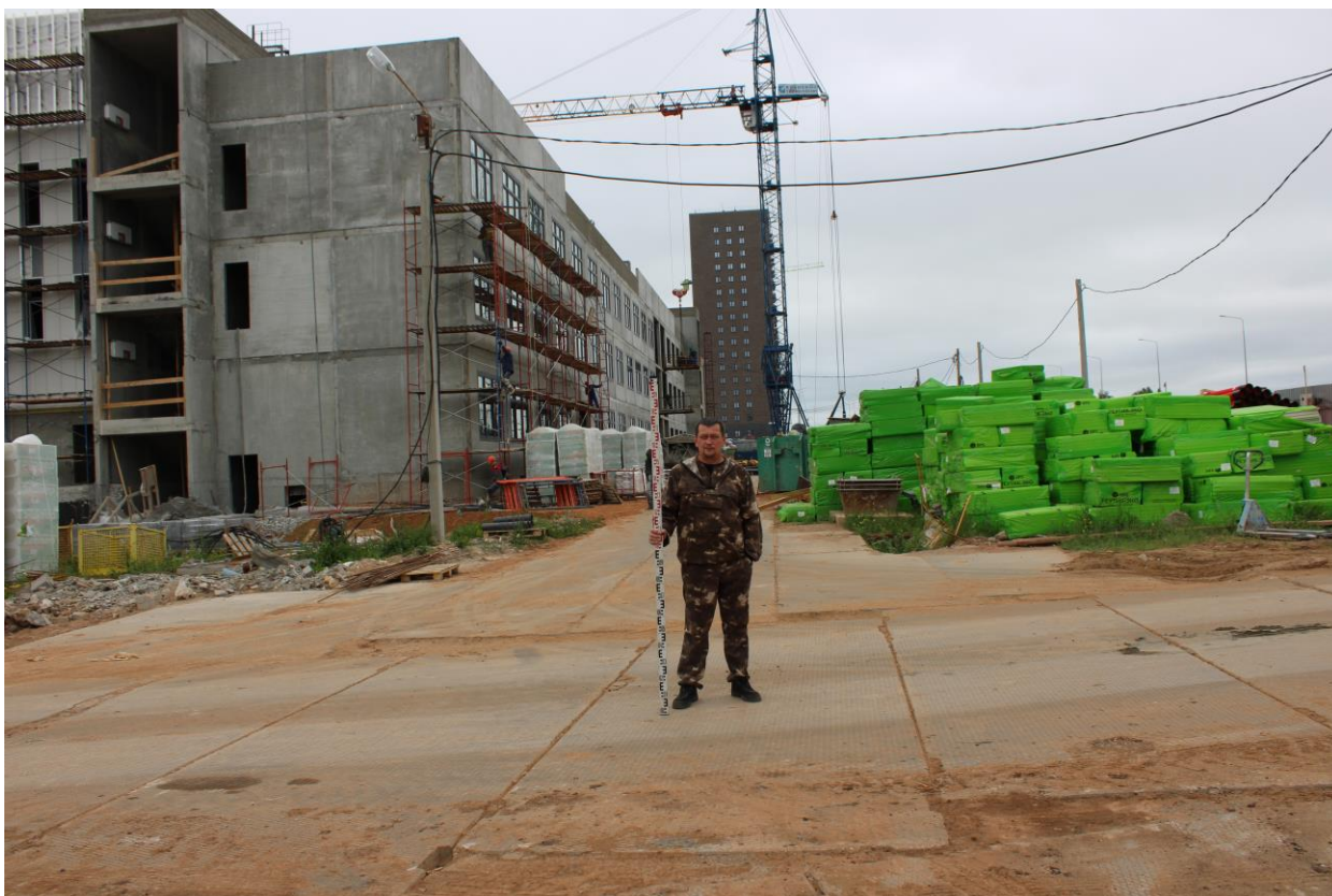
Рис. 22. Археологическая разведка на территории земельных участков, выделенных под строительство объекта "Улично-дорожная сеть для подъезда к детскому саду и школе по ул. Дорофеева г. Кирова" в 2024 г. Общий вид на северный участок проведения работ. Вид с севера.
