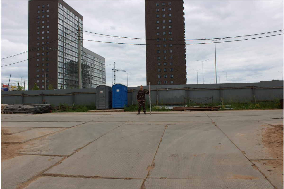
Рис. 9. Археологическая разведка на территории земельных участков, выделенных под строительство объекта "Улично-дорожная сеть для подъезда к детскому саду и школе по ул. Дорофеева г. Кирова" в 2024 г. Общий вид на южный участок проведения работ. Вид с севера.
