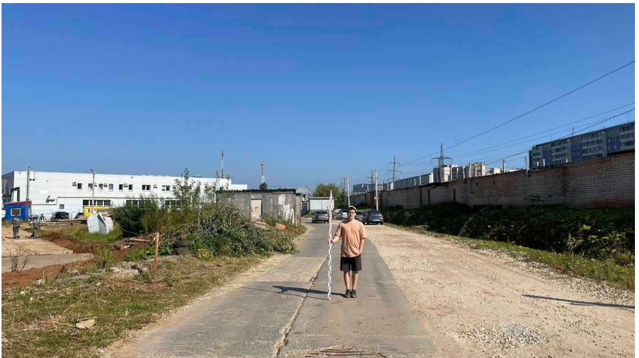
Рис. 38. Фото. Фотофиксация местности в зоне строительства жилого комплекса со встроенными помещениями общественного назначения и парковкой по ул. Московской в г. Кирове Кировской области. ТФ 11. Вид с юга.
