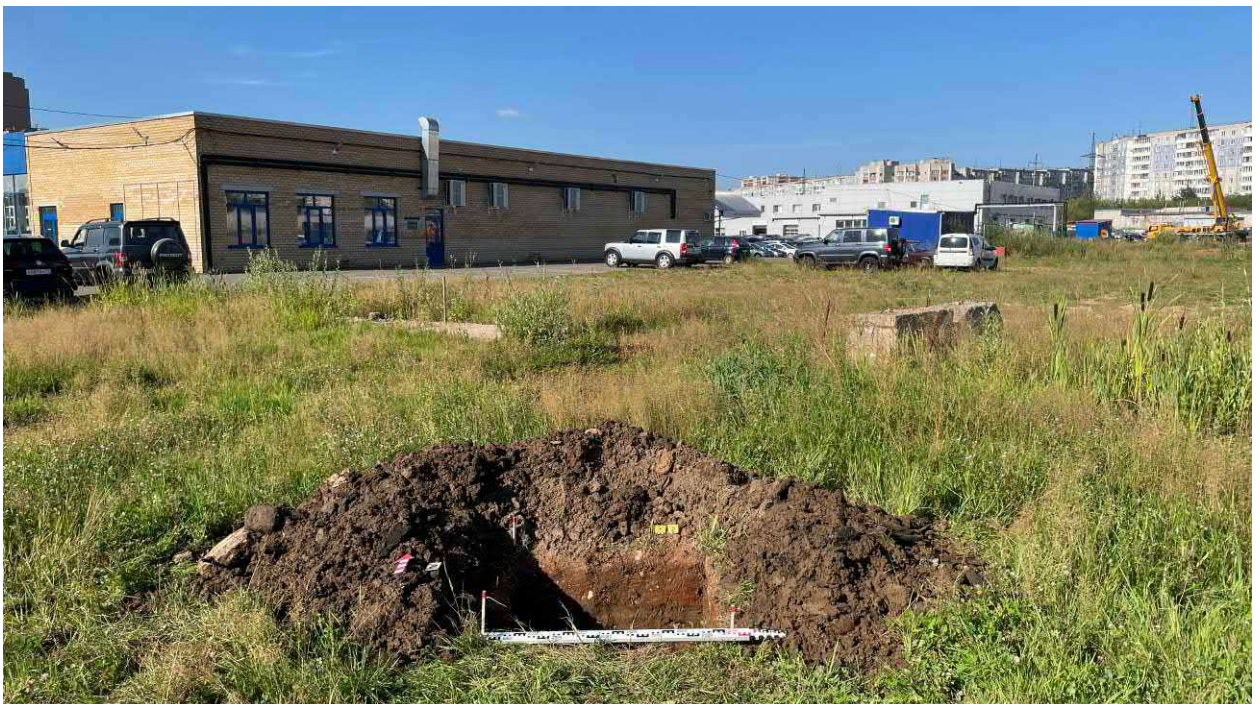
Рис. 54. Фото. Археологическая разведка в зоне строительства жилого комплекса со встроенными помещениями общественного назначения и парковкой по ул. Московской в г. Кирове Кировской области. Шурф № 2. Вид на шурф при снятии 7 пласта с включением окружающего пейзажа. Приостановление работ. Вид с юга.
