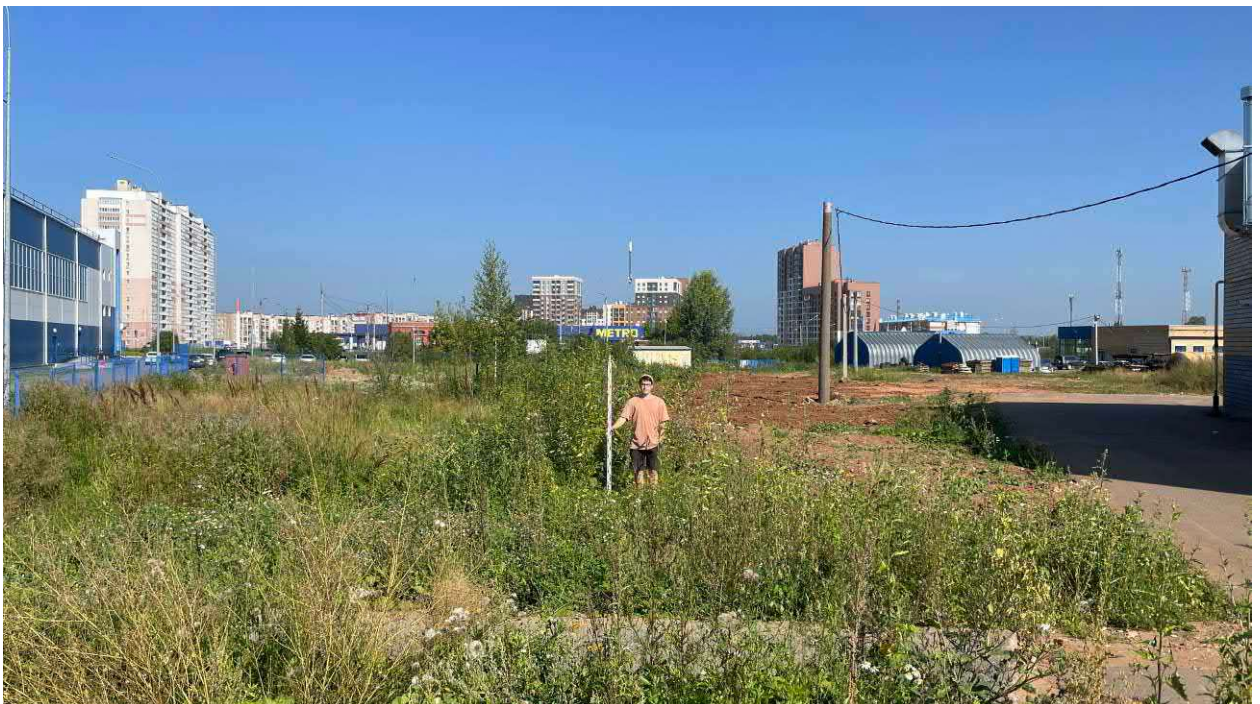
Рис. 26. Фото. Фотофиксация местности в зоне строительства жилого комплекса со встроенными помещениями общественного назначения и парковкой по ул. Московской в г. Кирове Кировской области.
