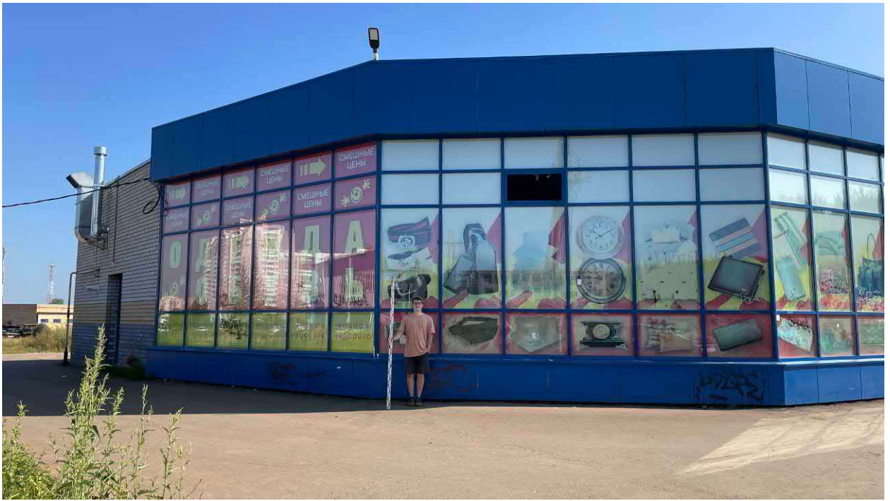
Рис. 25. Фото. Фотофиксация местности в зоне строительства жилого комплекса со встроенными помещениями общественного назначения и парковкой по ул. Московской в г. Кирове Кировской области.
