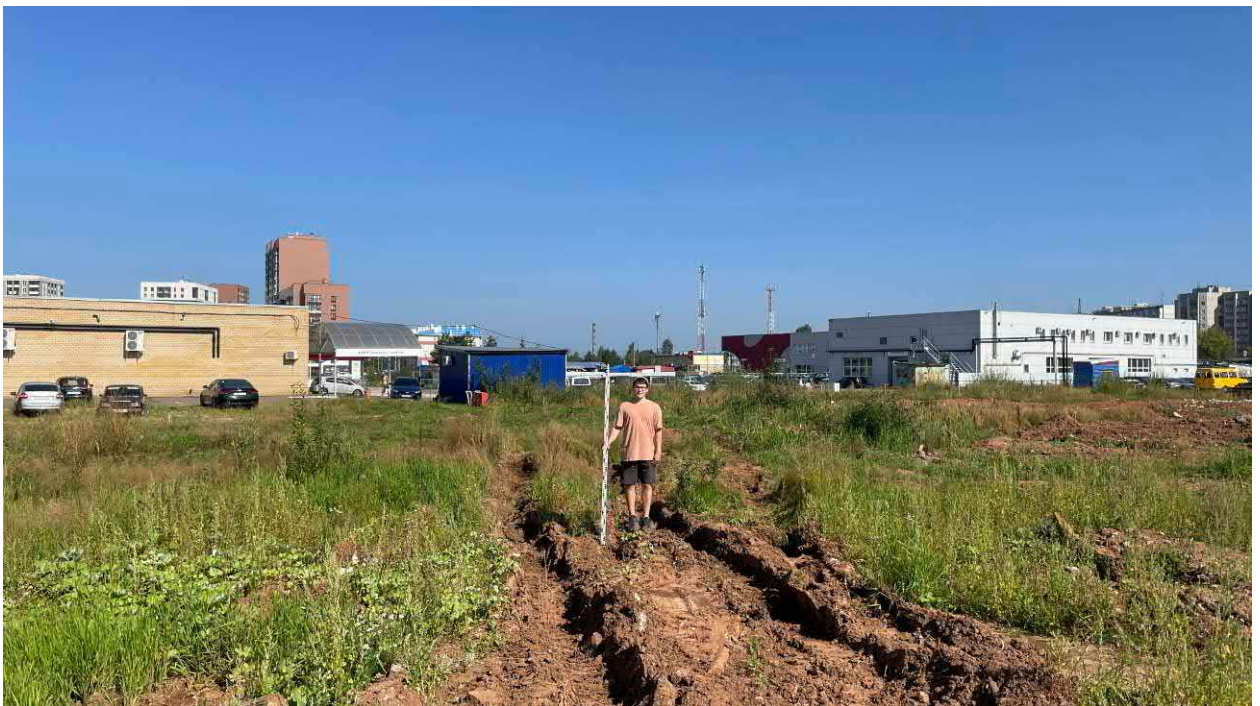
Рис. 42. Фото. Фотофиксация местности в зоне строительства жилого комплекса со встроенными помещениями общественного назначения и парковкой по ул. Московской в г. Кирове Кировской области. ТФ 12. Вид с юга.
