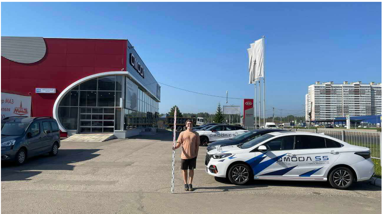
Рис. 34. Фото. Фотофиксация местности в зоне строительства жилого комплекса со встроенными помещениями общественного назначения и парковкой по ул. Московской в г. Кирове Кировской области.
