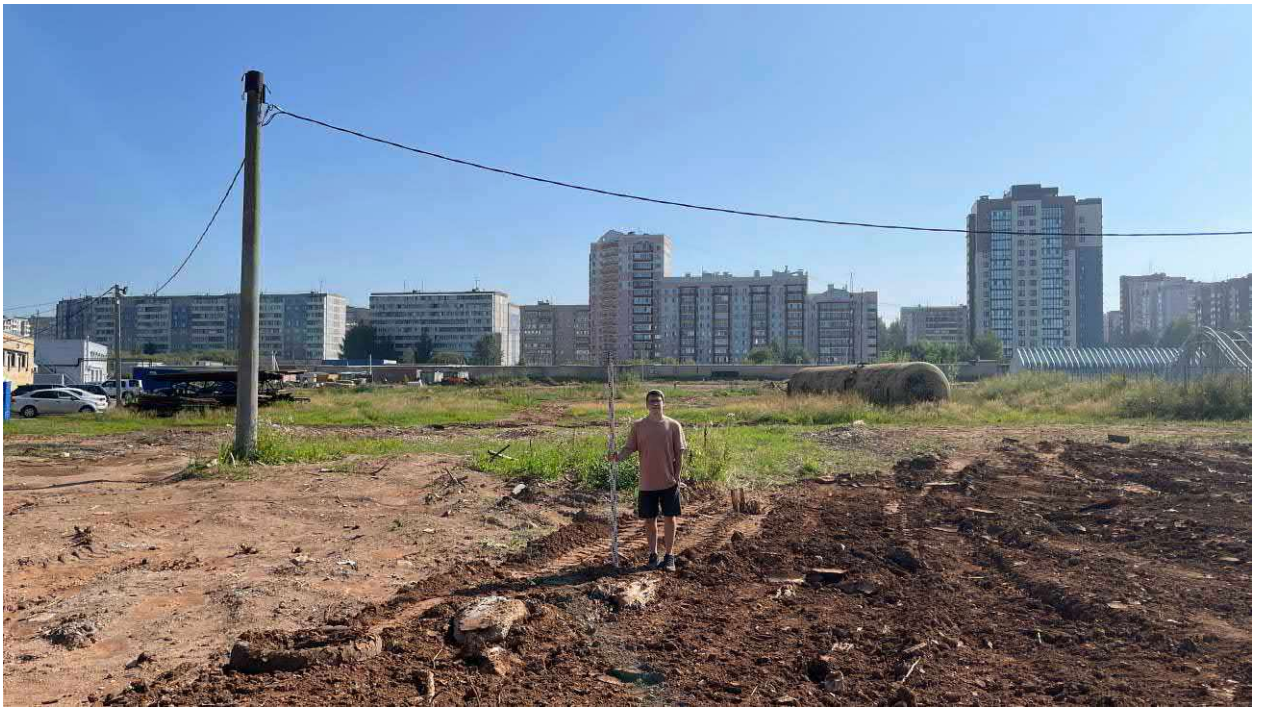
Рис. 27. Фото. Фотофиксация местности в зоне строительства жилого комплекса со встроенными помещениями общественного назначения и парковкой по ул. Московской в г. Кирове Кировской области. ТФ 4. Вид с запада.
