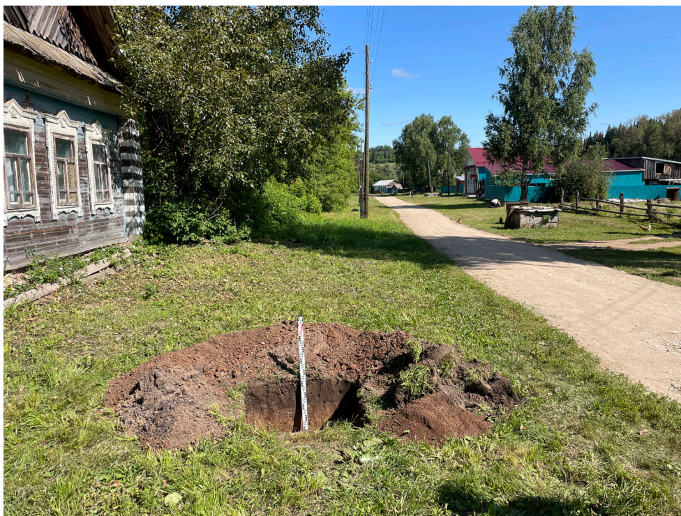
Рис. 30. Объект: «Газопровод распределительный в дер. Акбатырево Малмыжского муниципального района Кировской области». Общий вид с Ю на шурф 2.
