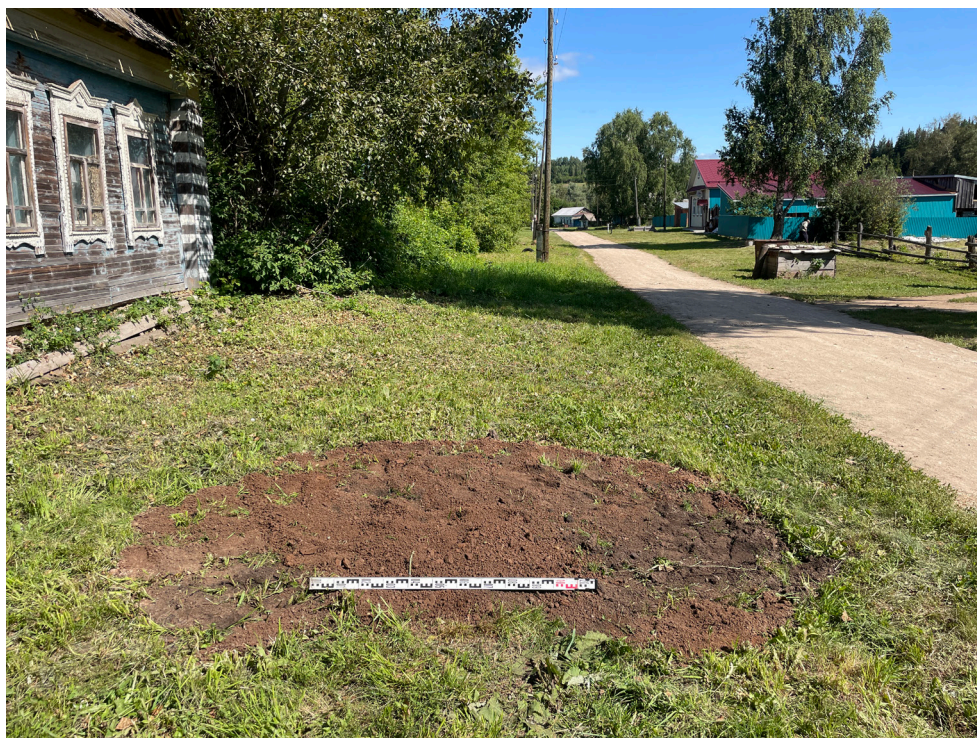
Рис. 31. Объект: «Газопровод распределительный в дер. Акбатырево Малмыжского муниципального района Кировской области». Вид с Ю на рекультивацию шурфа 2.
