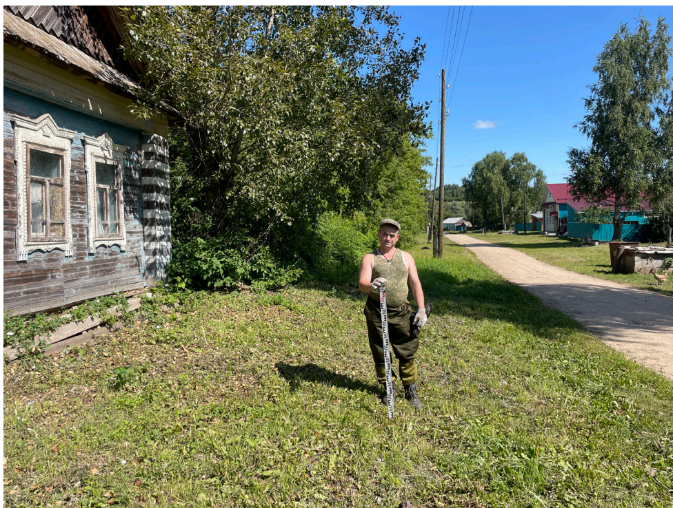
Рис. 27. Объект: «Газопровод распределительный в дер. Акбатырево Малмыжского муниципального района Кировской области». Вид с Ю на разбивку шурфа 2.
