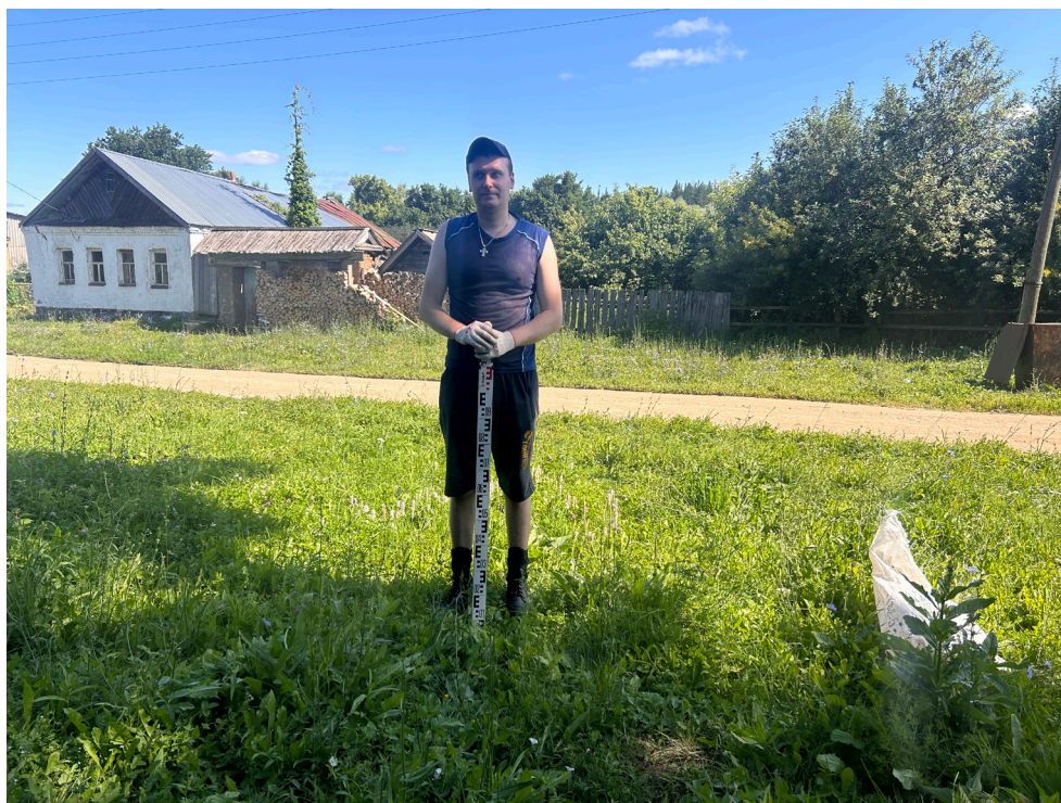
Рис. 32. Объект: «Газопровод распределительный в дер. Акбатырево Малмыжского муниципального района Кировской области». Вид с Ю на разбивку шурфа 3.
