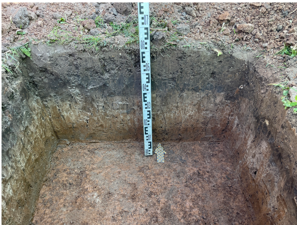
Рис. 28. Объект: «Газопровод распределительный в дер. Акбатырево Малмыжского муниципального района Кировской области». Вид с Ю на северную стенку шурфа 2.
