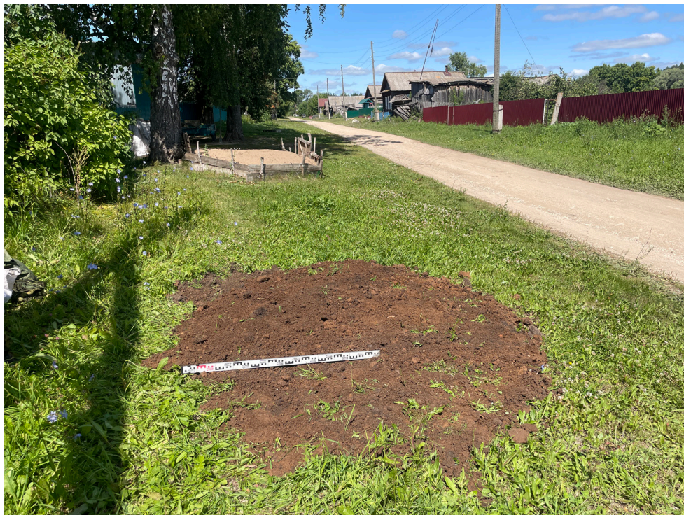
Рис. 41. Объект: «Газопровод распределительный в дер. Акбатырево Малмыжского муниципального района Кировской области». Вид с В на рекультивацию шурфа 4.
