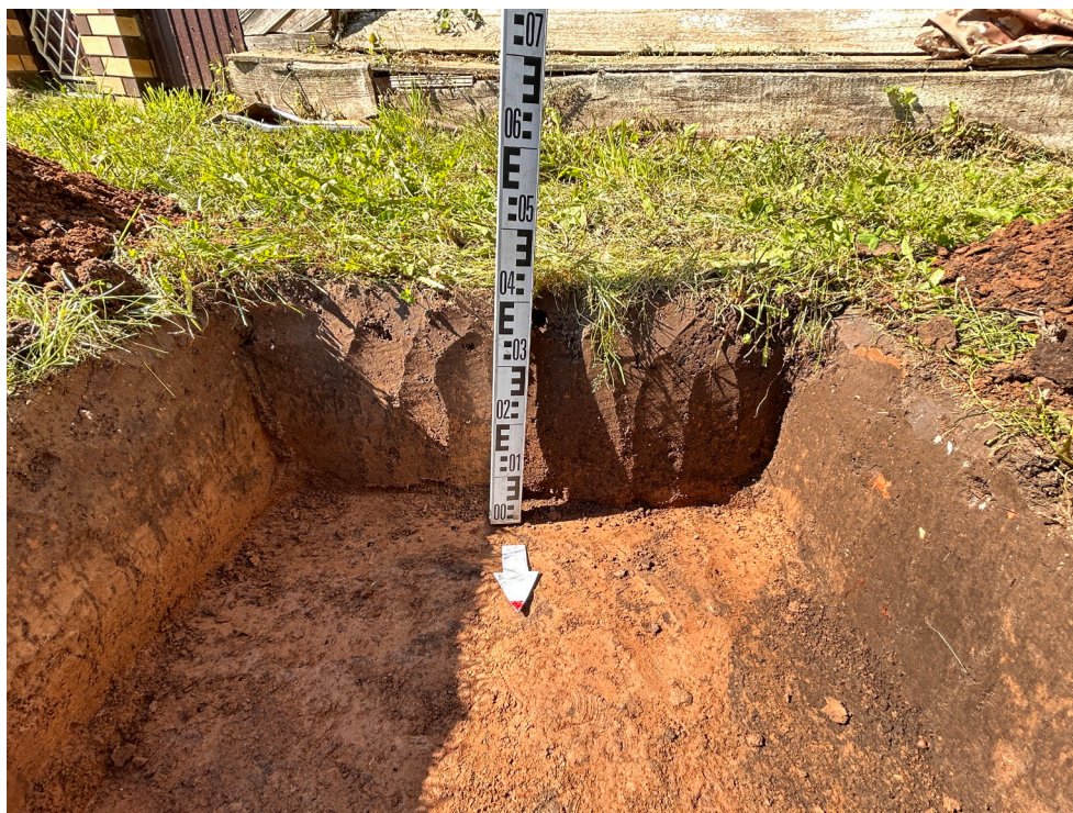
Рис. 20. Объект: «Газопровод распределительный в дер. Акбатырево Малмыжского муниципального района Кировской области». Вид с С на южную стенку шурфа 1.
