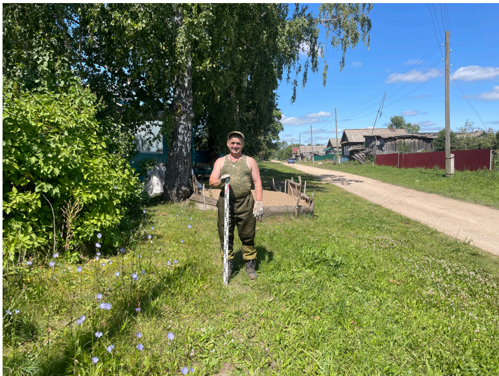
Рис. 37. Объект: «Газопровод распределительный в дер. Акбатырево Малмыжского муниципального района Кировской области». Вид с В на разбивку шурфа 4.
