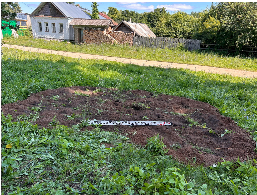
Рис. 36. Объект: «Газопровод распределительный в дер. Акбатырево Малмыжского муниципального района Кировской области». Вид с Ю на рекультивацию шурфа 3.
