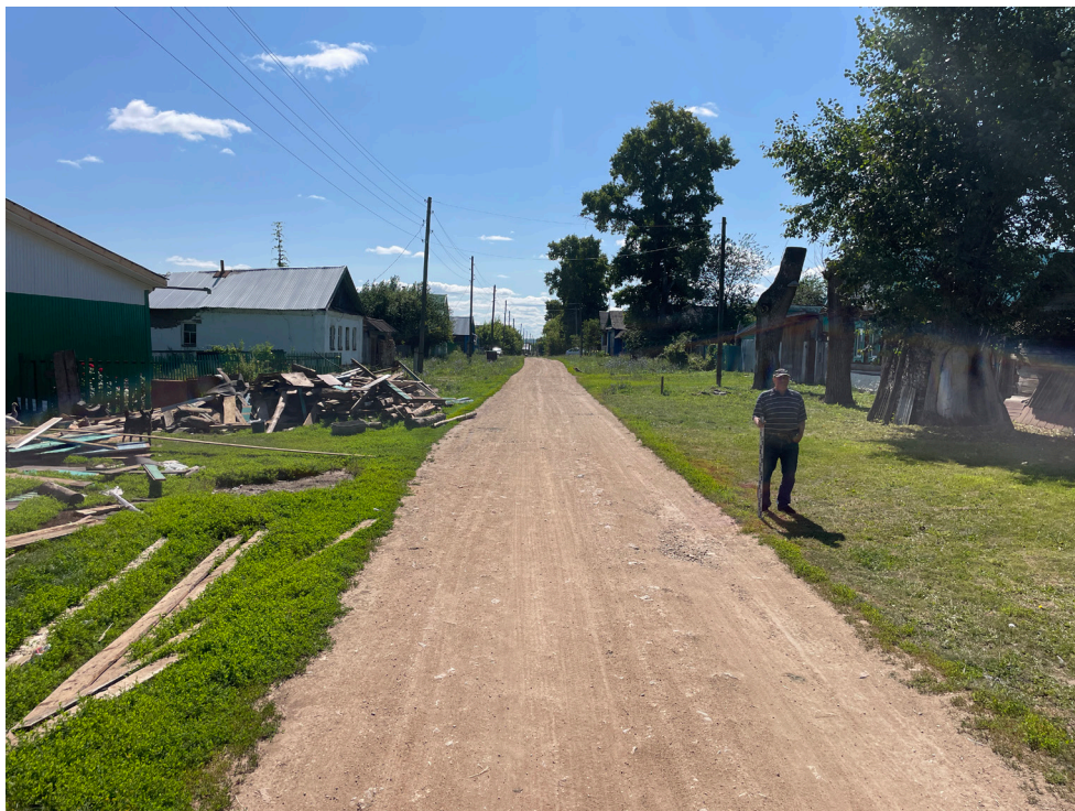
Рис. 15. Объект: «Газопровод распределительный в дер. Акбатырево Малмыжского муниципального района Кировской области». Вид из тф 3 на ЮВ.
