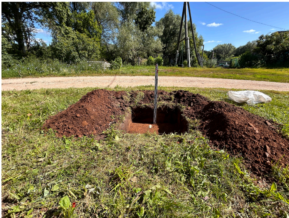
Рис. 23. Объект: «Газопровод распределительный в дер. Акбатырево Малмыжского муниципального района Кировской области». Общий вид с Ю на шурф 1.
