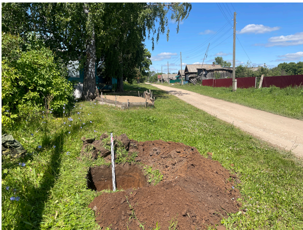
Рис. 40. Объект: «Газопровод распределительный в дер. Акбатырево Малмыжского муниципального района Кировской области». Общий вид с В на шурф 4.
