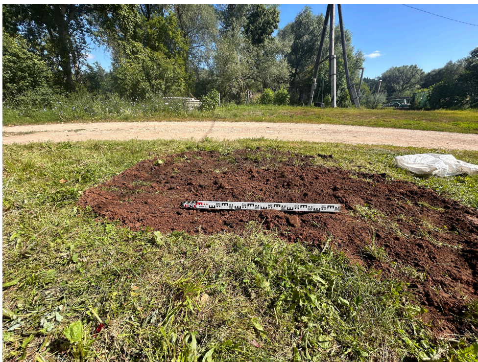
Рис. 24. Объект: «Газопровод распределительный в дер. Акбатырево Малмыжского муниципального района Кировской области». Вид с Ю на консервацию шурфа 1.
