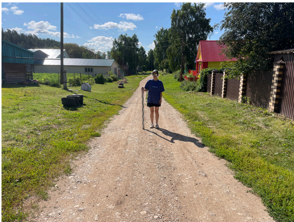
Рис. 14. Объект: «Газопровод распределительный в дер. Акбатырево Малмыжского муниципального района Кировской области». Вид из тф 2 на ЮВ.
