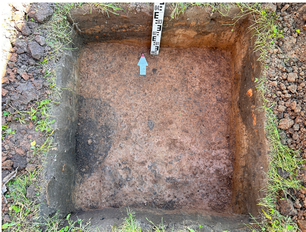
Рис. 22. Объект: «Газопровод распределительный в дер. Акбатырево Малмыжского муниципального района Кировской области». Вид с Ю на дно шурфа 1.
