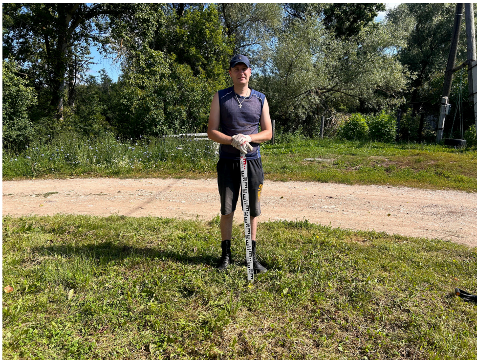
Рис. 17. Объект: «Газопровод распределительный в дер. Акбатырево Малмыжского муниципального района Кировской области». Вид с Ю на разбивку шурфа 1.
