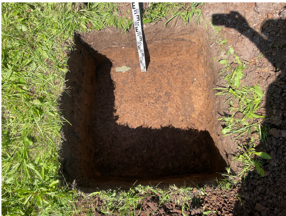
Рис. 39. Объект: «Газопровод распределительный в дер. Акбатырево Малмыжского муниципального района Кировской области». Вид с В на дно шурфа 4.
