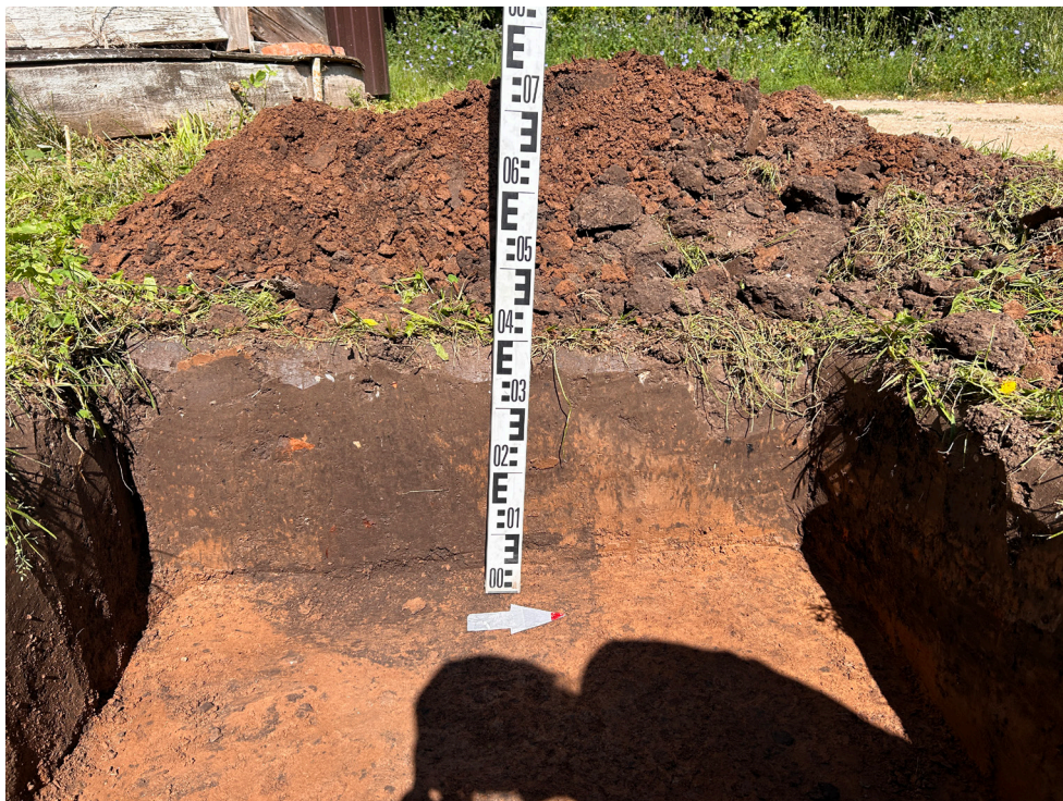
Рис. 21. Объект: «Газопровод распределительный в дер. Акбатырево Малмыжского муниципального района Кировской области». Вид с В на западную стенку шурфа 1.
