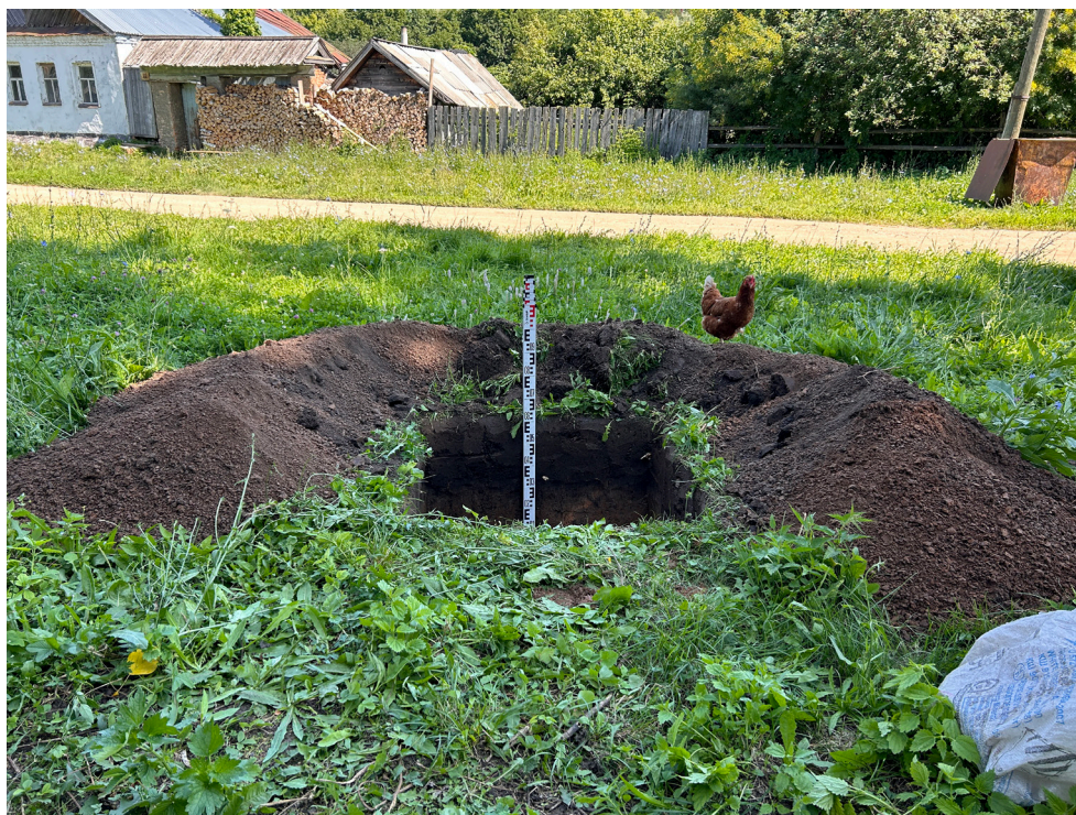
Рис. 34. Объект: «Газопровод распределительный в дер. Акбатырево Малмыжского муниципального района Кировской области». Вид с Ю на дно шурфа 3.
