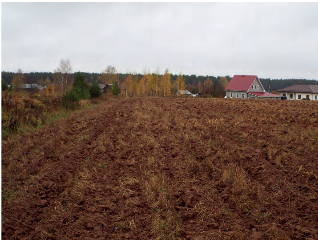
Рис.12. Строительство межпоселкового газопровода к д. Нижние Булдаки Слободского района Кировской области. Рельеф местности и характер растительности участка обследования. Точка фотофиксации 1, вид с З.
