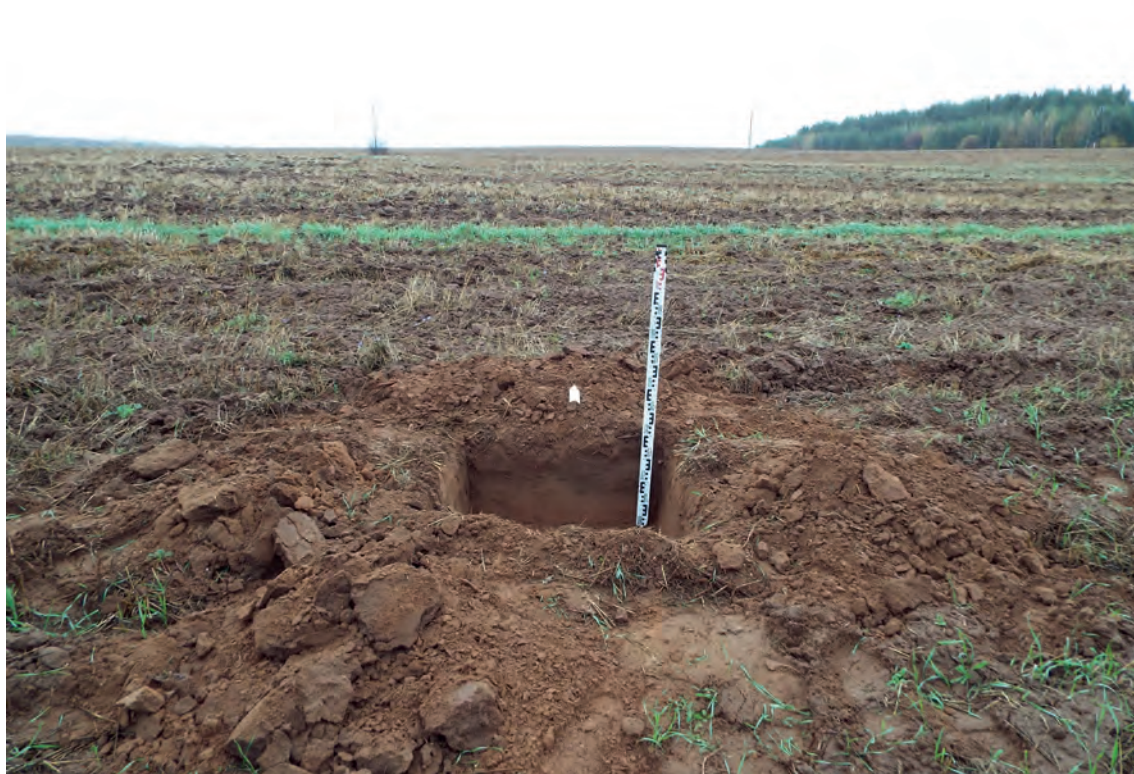
Рис.14. Строительство межпоселкового газопровода к д. Нижние Булдаки Слободского района Кировской области. Шурф 1. Антураж. Вид с Ю.
