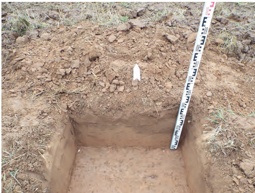
Рис.15. Строительство межпоселкового газопровода к д. Нижние Булдаки Слободского района Кировской области. Шурф 1. Северный борт. Вид с Ю.
