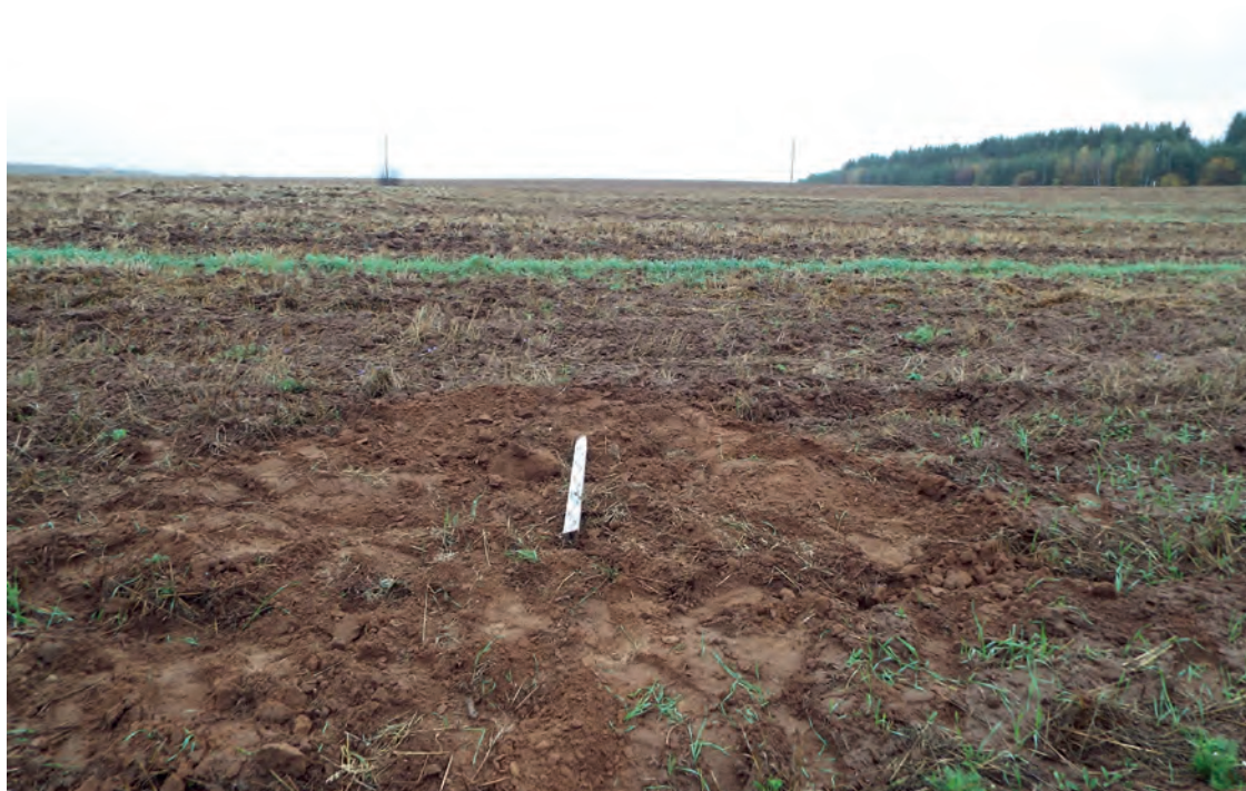
Рис.16. Строительство межпоселкового газопровода к д. Нижние Булдаки Слободского района Кировской области. Шурф 1. Рекультивация. Вид с Ю.
