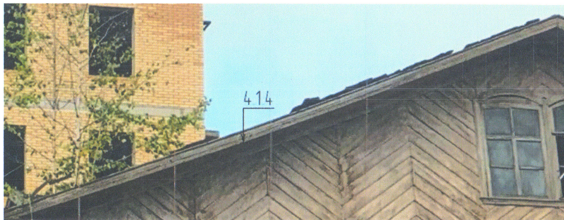
Фото 2. Наборный ступенчатый карниз фронтона. Фотосъемка 2019 г.
