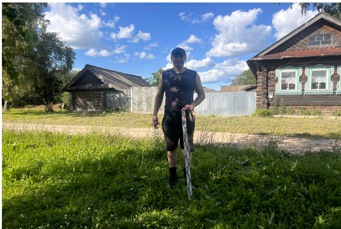
Рис. 18. Объект: «Газопровод распределительный в дер. Марьял Малмыжского муниципального района Кировской области». Вид с Ю на разбивку шурфа 2.
