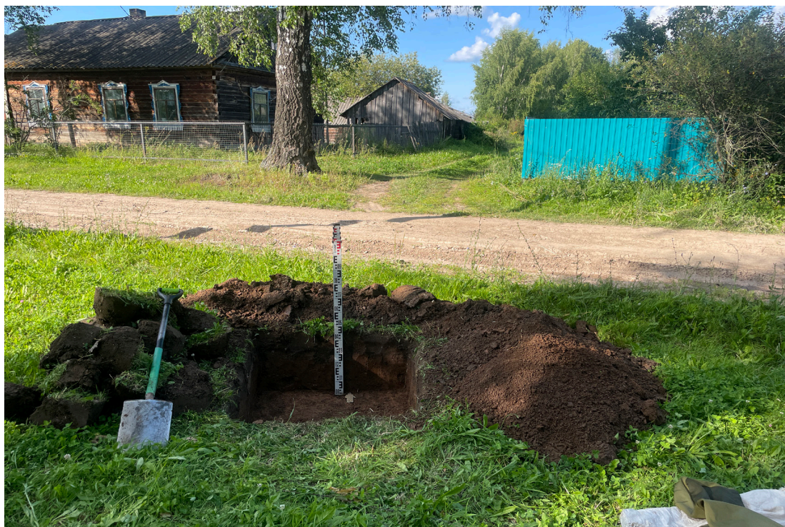
Рис. 16. Объект: «Газопровод распределительный в дер. Марьял Малмыжского муниципального района Кировской области». Общий вид с Ю на шурф 1.
