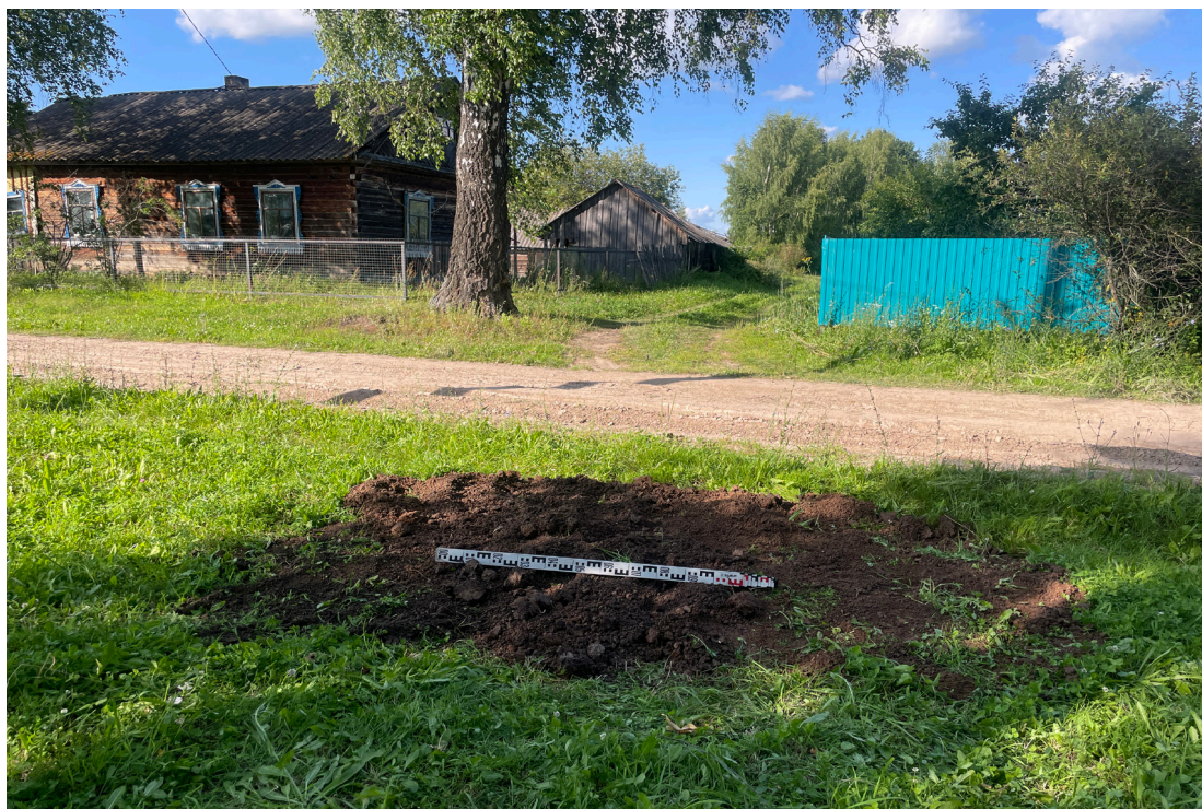
Рис. 17. Объект: «Газопровод распределительный в дер. Марьял Малмыжского муниципального района Кировской области». Вид с Ю на рекультивацию шурфа 1.
