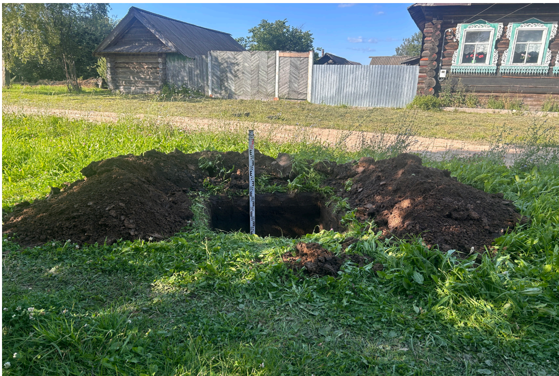
Рис. 21. Объект: «Газопровод распределительный в дер. Марьял Малмыжского муниципального района Кировской области». Общий вид с Ю на шурф 2.
