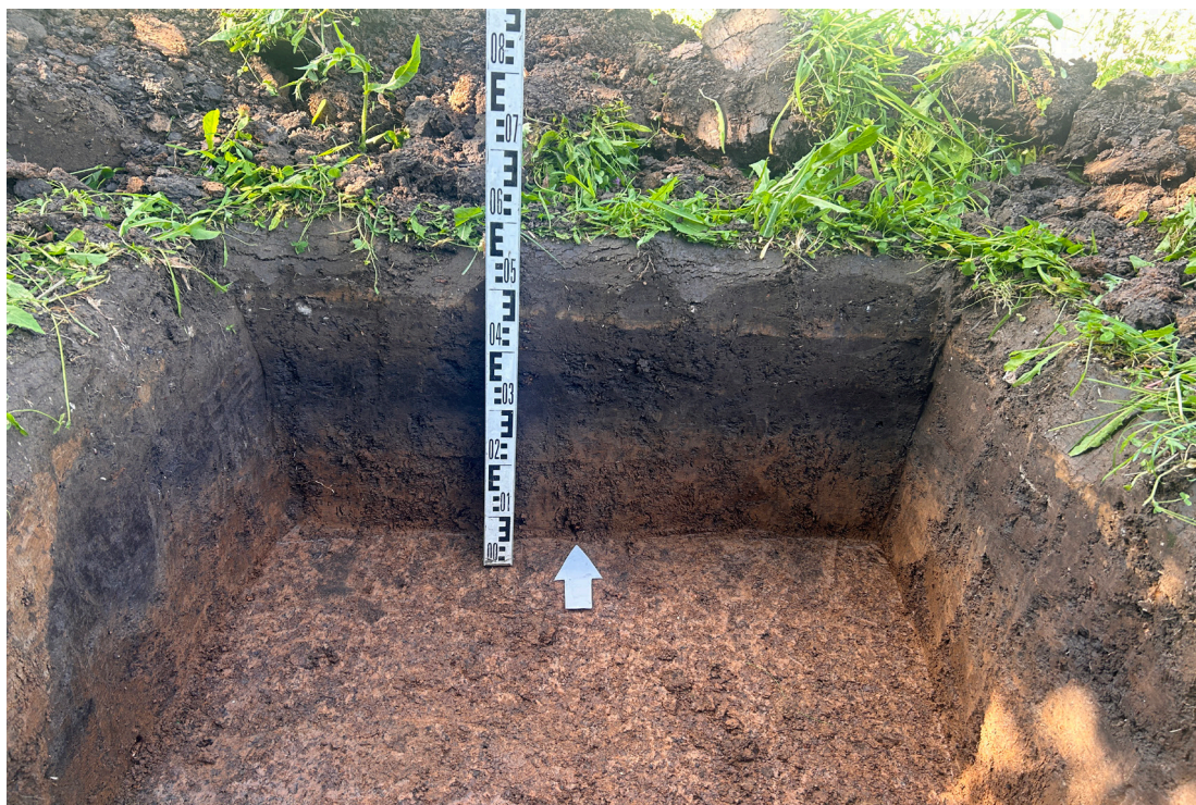
Рис. 19. Объект: «Газопровод распределительный в дер. Марьял Малмыжского муниципального района Кировской области». Вид с Ю на северную стенку шурфа 2.
