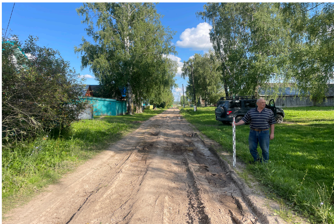
Рис. 12. Объект: «Газопровод распределительный в дер. Марьял Малмыжского муниципального района Кировской области». Вид из тф 3 на ЮВ.
