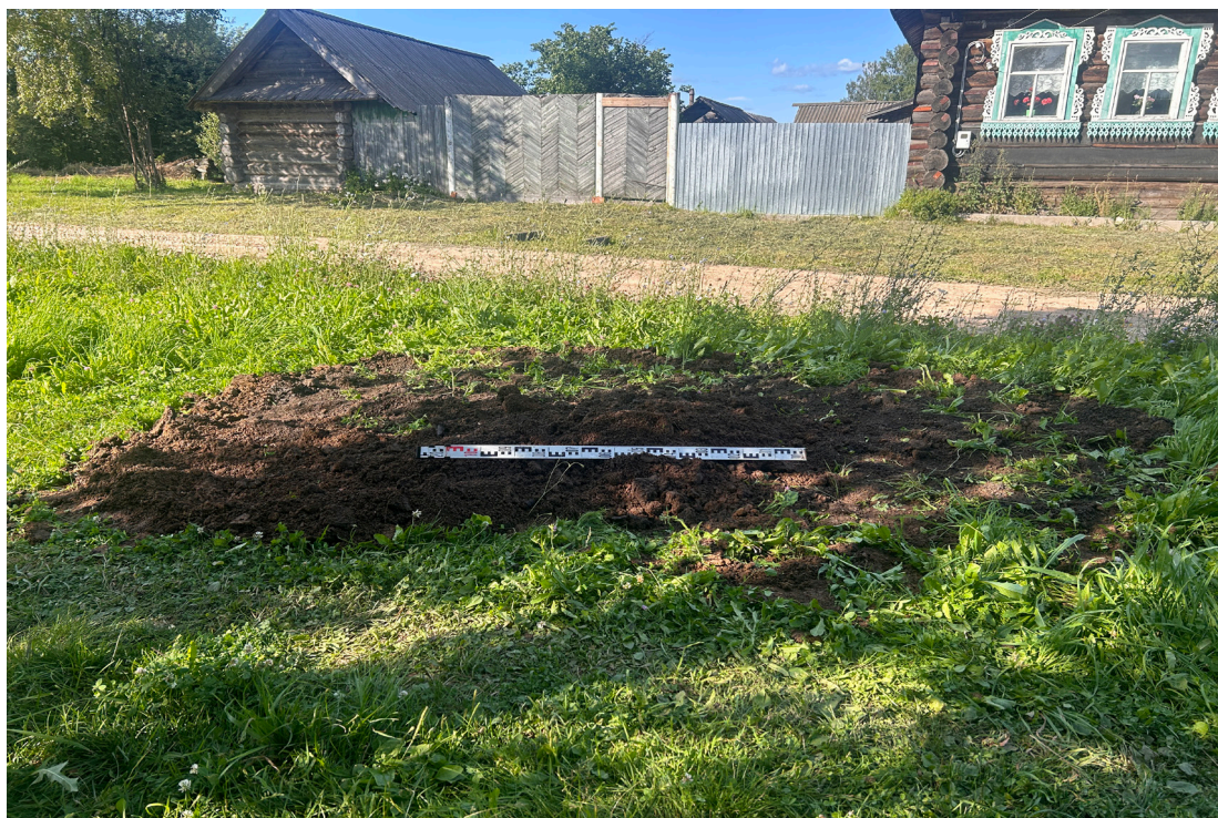
Рис. 22. Объект: «Газопровод распределительный в дер. Марьял Малмыжского муниципального района Кировской области». Вид с Ю на рекультивацию шурфа 2.
