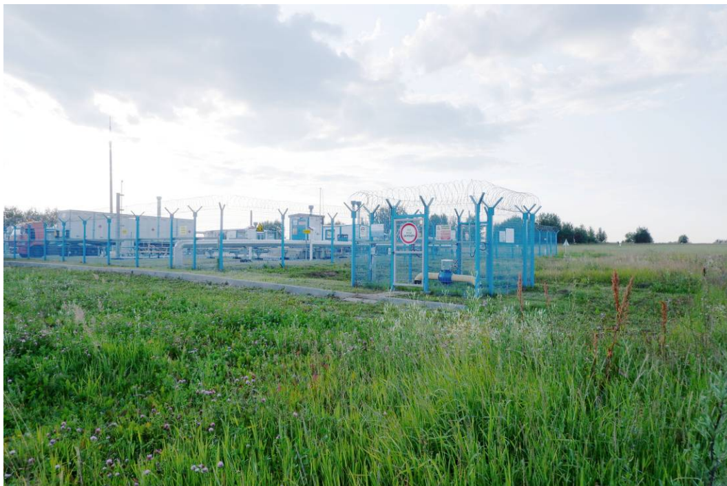
Илл.23. Кировская область, Куменский район. Земельный участок, отводимый под объект: «Оснащение ИТСО ГРС Кировского ЛПУМГ и Моркинского ЛПУМГ». Пикет фотосъемки 6. Вид с ЮВ.
