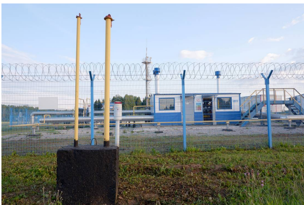
Илл.20. Кировская область, Куменский район. Земельный участок, отводимый под объект: «Оснащение ИТСО ГРС Кировского ЛПУМГ и Моркинского ЛПУМГ». Пикет фотосъемки 4. Вид с С.
