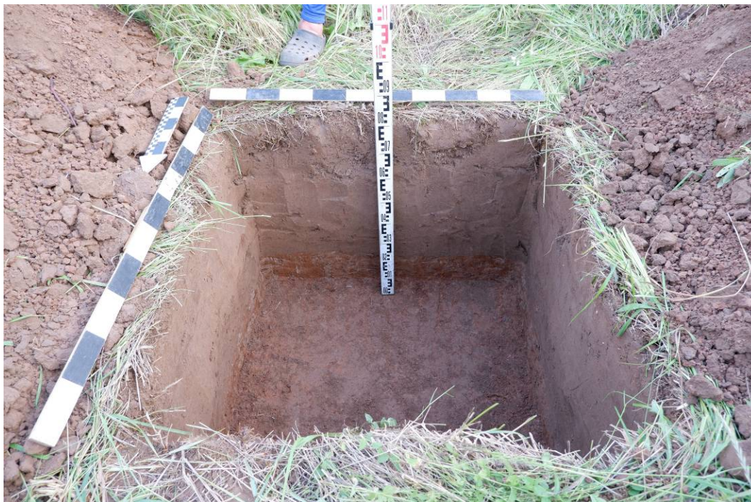
Илл.27. Кировская область, Куменский район. Земельный участок, отводимый под объект: «Оснащение ИТСО ГРС Кировского ЛПУМГ и Моркинского ЛПУМГ». Шурф 1. Стратиграфический борт. Вид с С.
