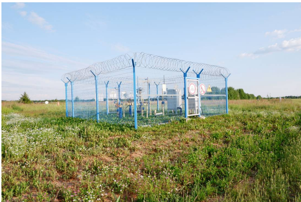
Илл.7. Кировская область, Куменский район. Земельный участок, отводимый под объект: ««Оснащение ИТСО ГРС Кировского ЛПУМГ и Моркинского ЛПУМГ». Пикет фотосъемки 1. Вид с С.
