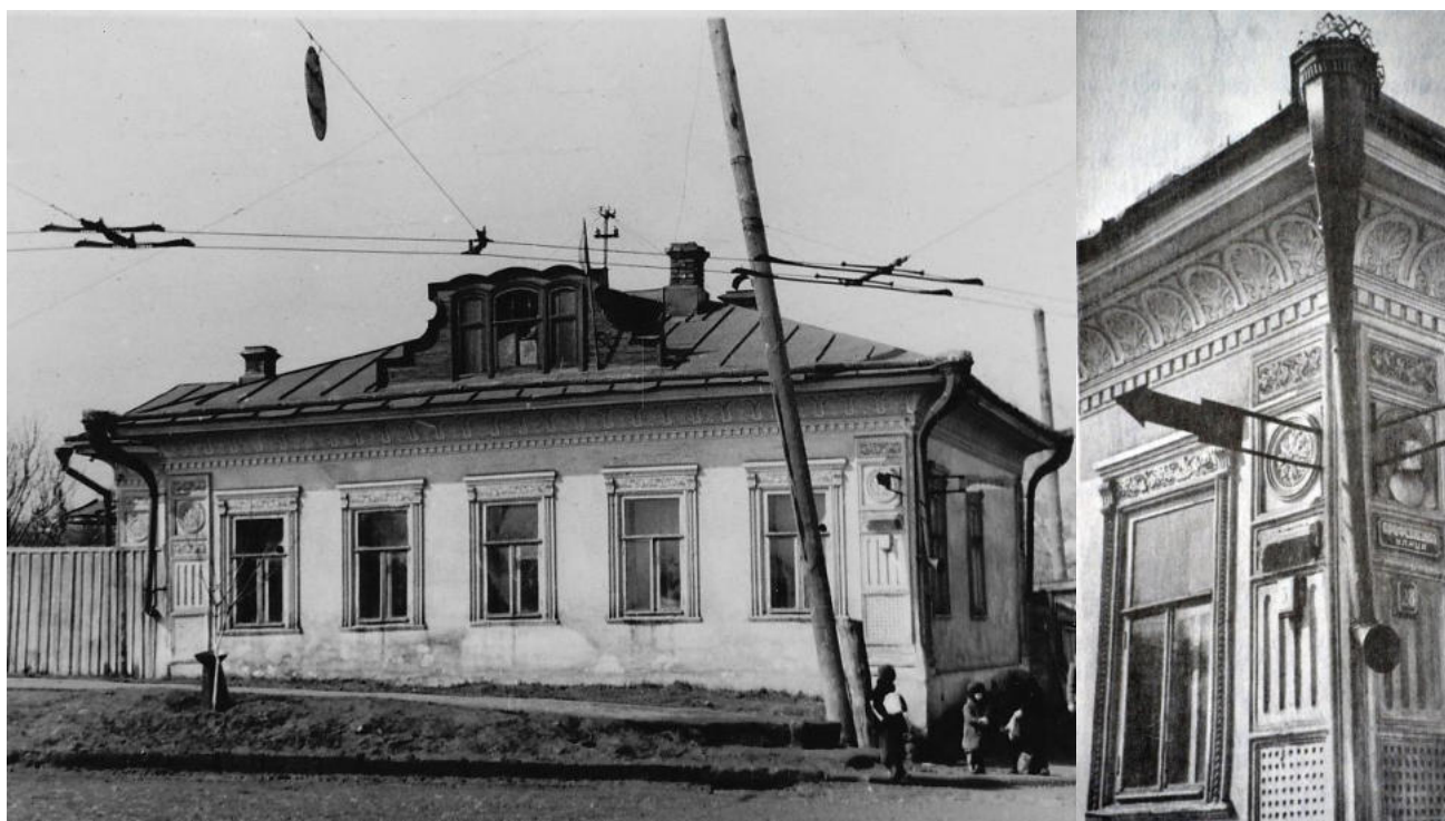
Илл. 19, 20. Дом мещанина М.Я. Петухова (1910 г.), ул. Ленина/Профсоюзная, д.3/28 (снесен). Дата съемки – 1958 г., 1967 г., автор съемки – А.Г. Тинский
