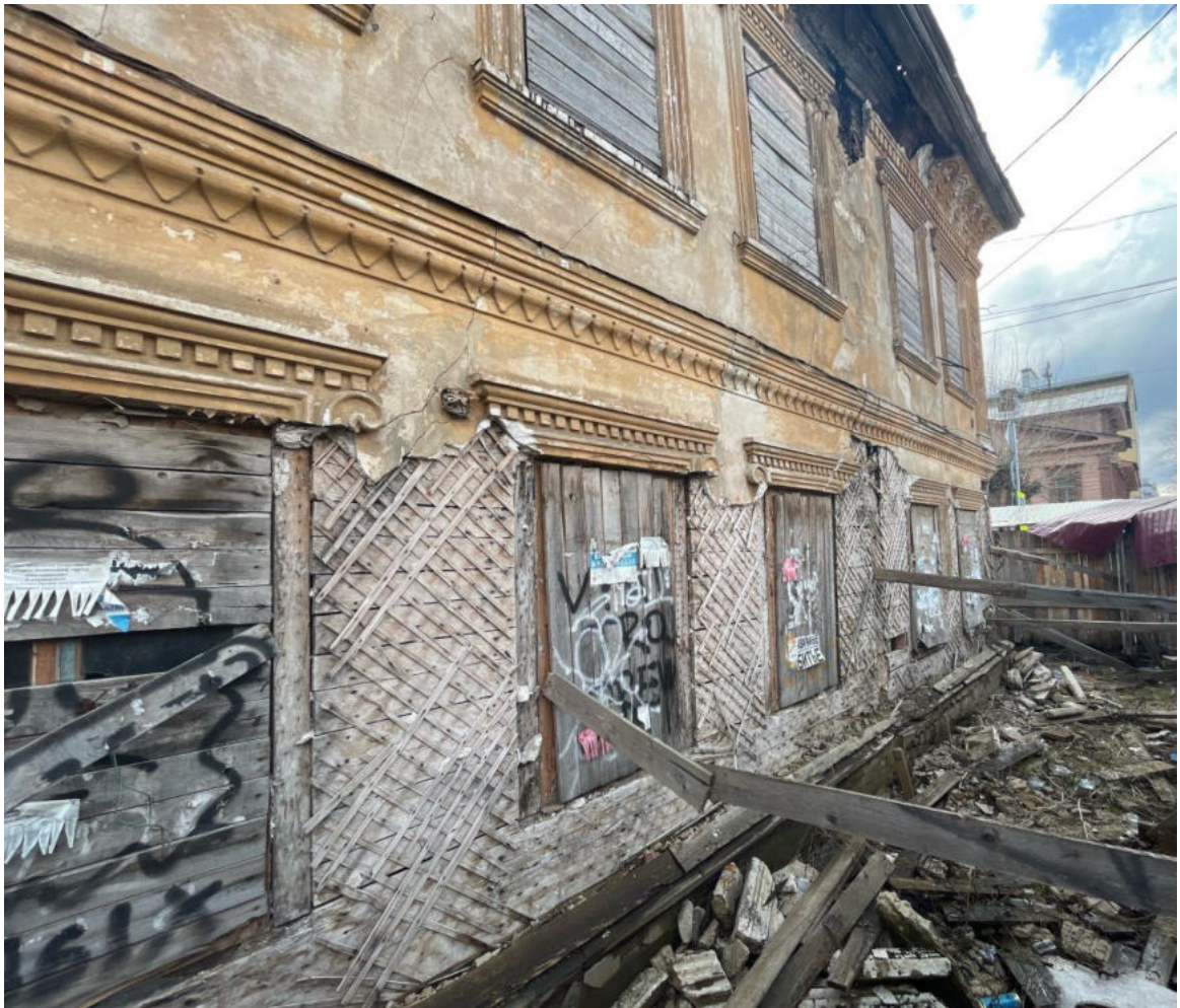
Илл. 35. Облицовка северного фасада на момент обследования. Дата съемки – 2026 г., автор съемки – Д.В. Марьин
