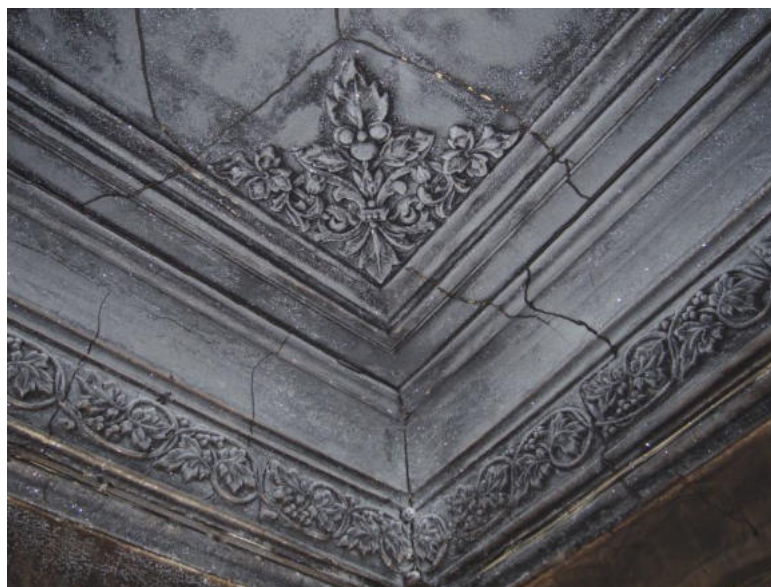
Илл. 29. Фрагмент карниза типа 1 с угловой лепным угловым элементом (лепнина типа 1). Дата съемки – 2017 г.
