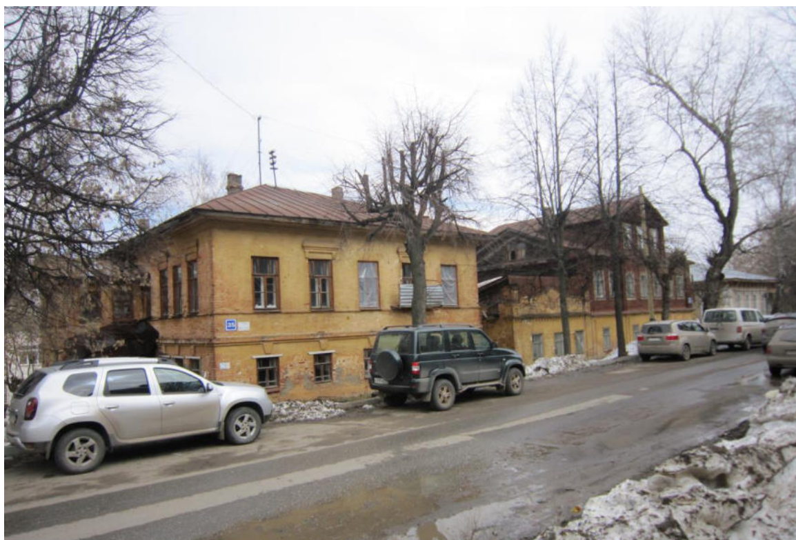
Илл. 44. «Дом жилой», ул. Орловская, 35. Дата съемки – 2017 г., автор съемки – Д.В. Марьин
