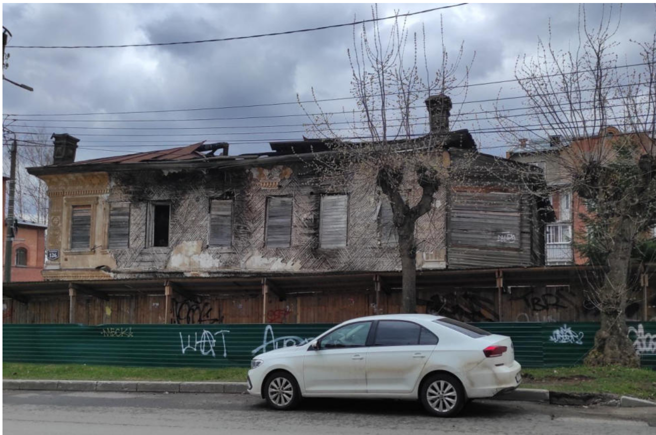
Фото 17. Западный фасад. Вид с улицы Никитской. Дата съемки – 2026 г., автор съемки – Баруткина Е.Е.
