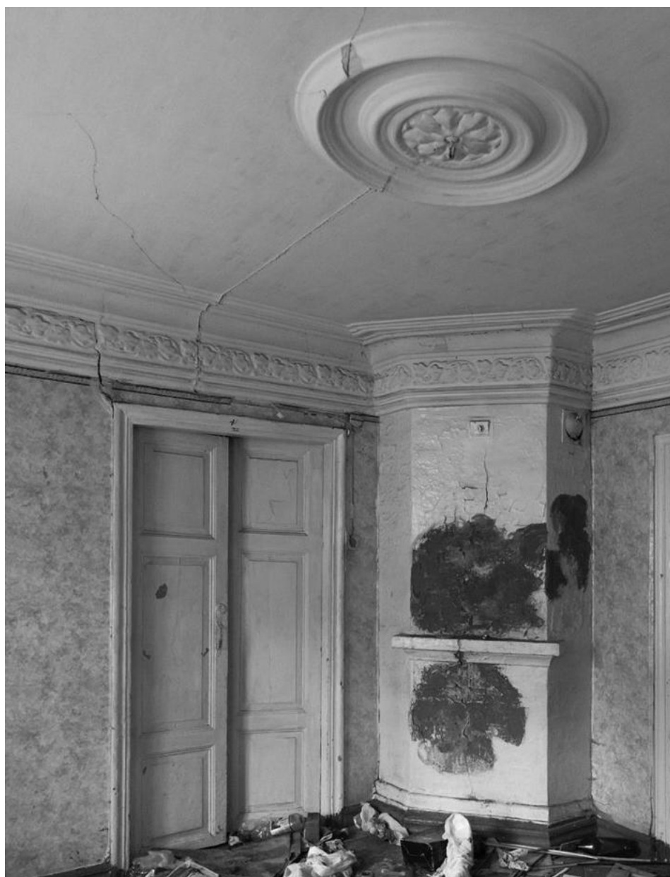
Илл 26. Фрагмент карниза, розетка в помещениях Объекта. Дата съемки – 2016 г.
