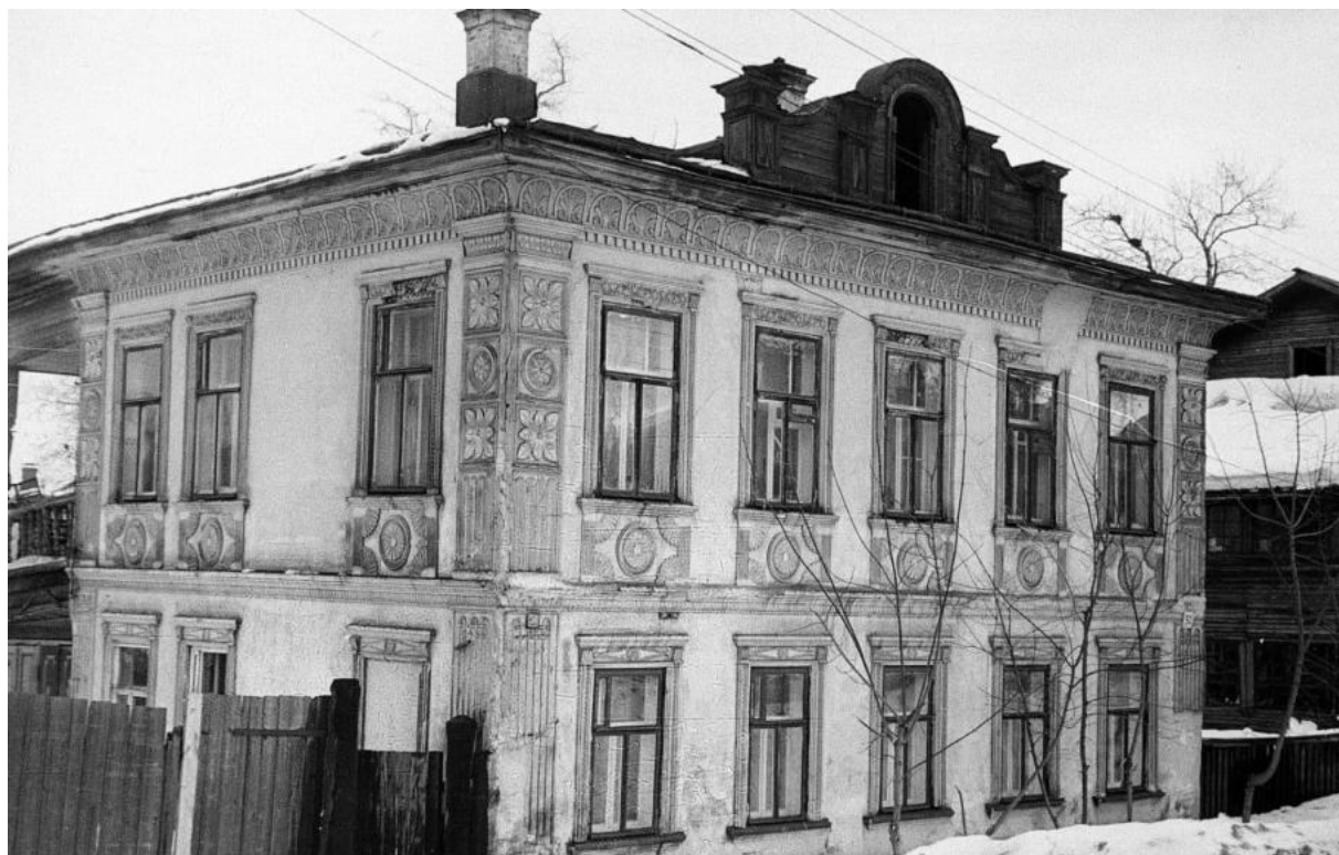
Илл. 18. Флигель Н. И. Семакова (1910-1911 гг.), ул. Дерендяева, 50 (снесен в 1987 г.). Дом с наружной отделкой лепными украшениями, выполненной артелью Н. Г. Джмухадзе. Дата съемки – 1975 г., автор съемки – Леонид Горин
