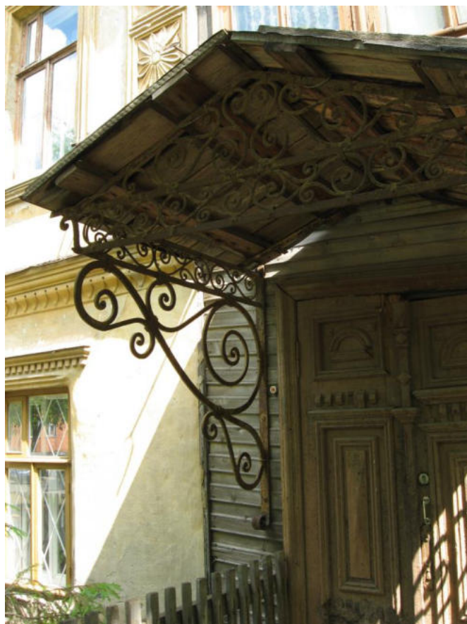
Фото 14. Элементы дверного проема западного фасада объема южного пристроя. Дата съемки – 2007 г., автор съемки – Титова Г.В.
