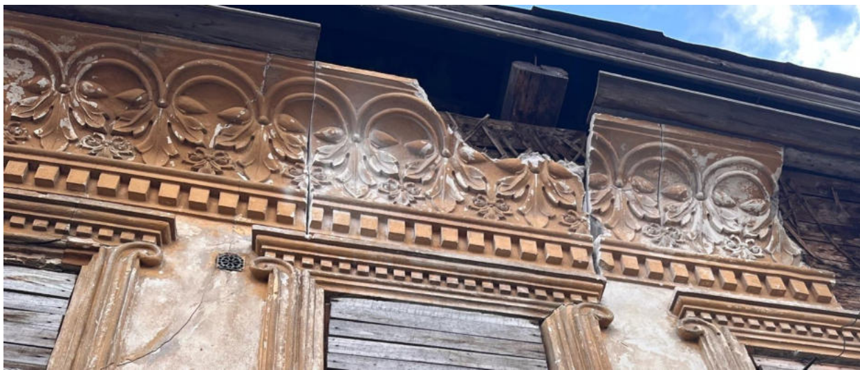
Илл. 33. Северный фасад, следы выпиливания части венчающего карниза.
