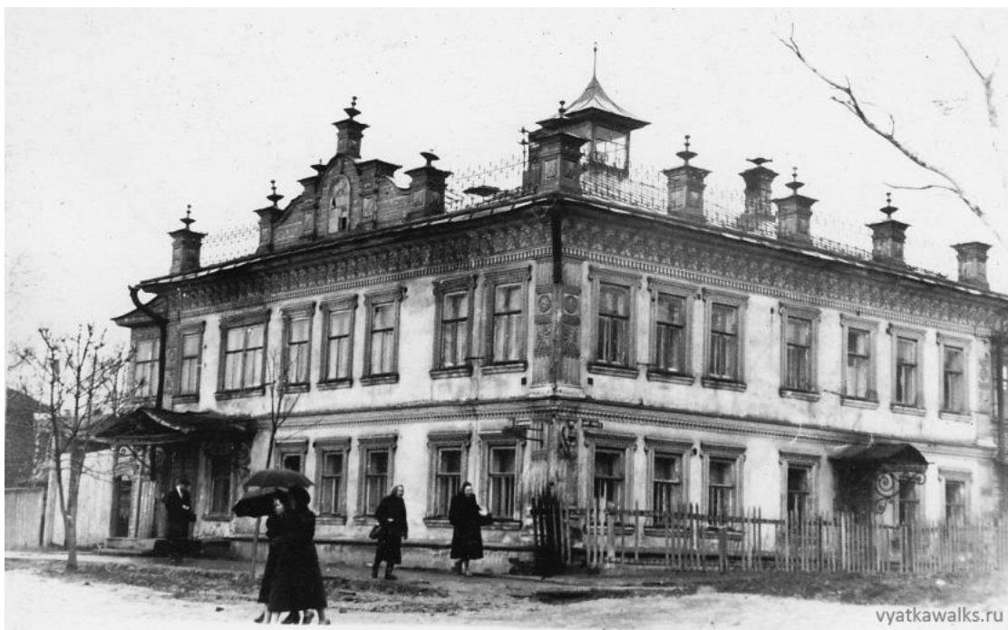
Илл. 12. Объект. Вид с северо-запада. Дата съемки – 1958 г., автор съемки – А.Г. Тинский.
