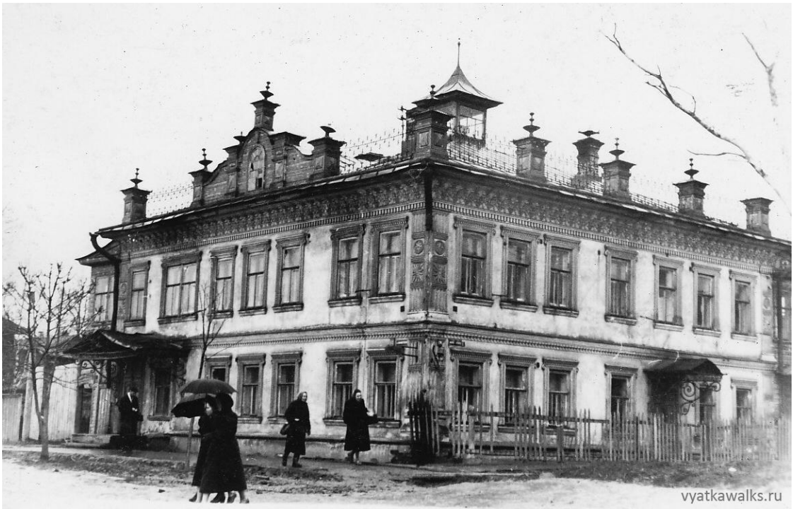
Илл. 21. Дом Мышкина, Алцыбеевой (1870 г.), ул. Володарского, 126 (в аварийном состоянии после пожара в 2016). Дата съемки – 1958 г., автор съемки – Тинский А.Г.
