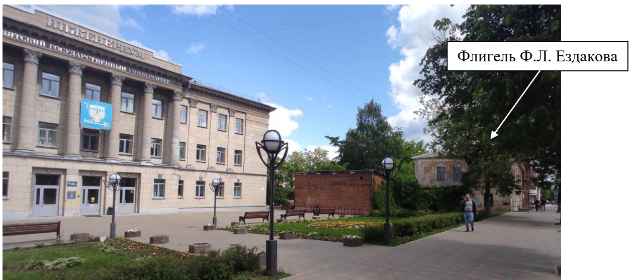
Илл. 33. Застройка ул. Преображенской, граничащая с запада с территорией ОБЪЕКТОВ Слева на фото – Дом политпросвещения. Вид с ул. Преображенской, с юго-запада. Дата съемки – 2022 г., автор съемки – Баруткина Е.Е.
