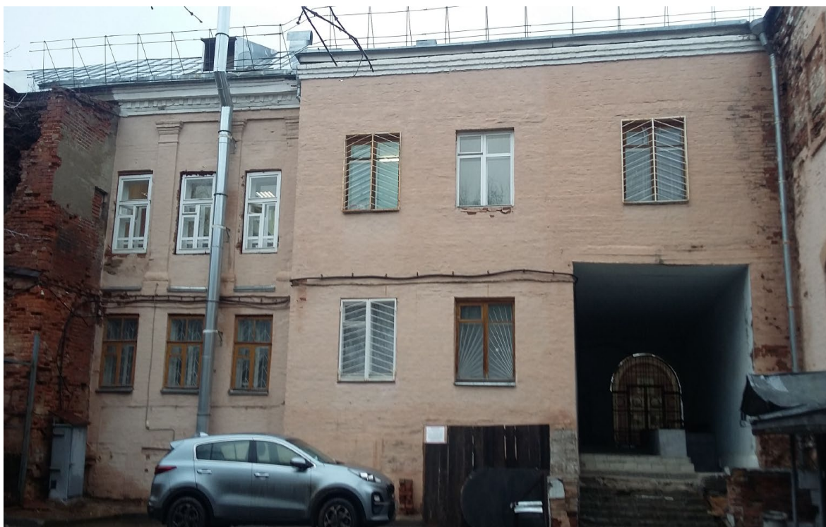
Фото 3. Фрагмент дворового фасада.
