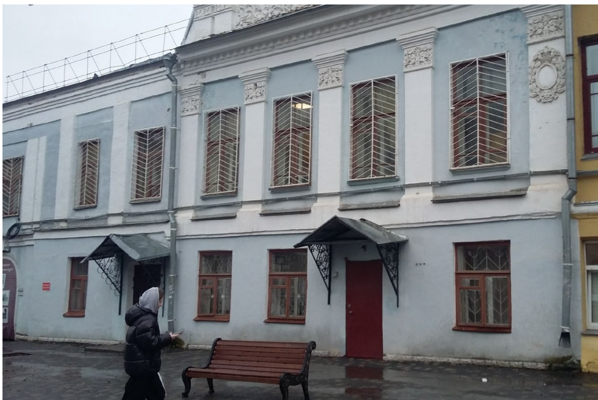
Фото 2. Общий вид главного фасада с ул. Спасской.
