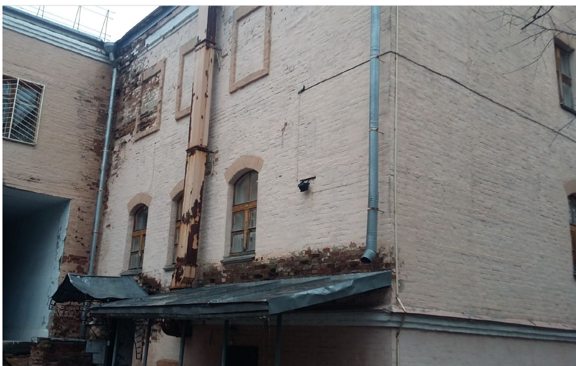
Фото 6. Фрагмент дворового фасада.
