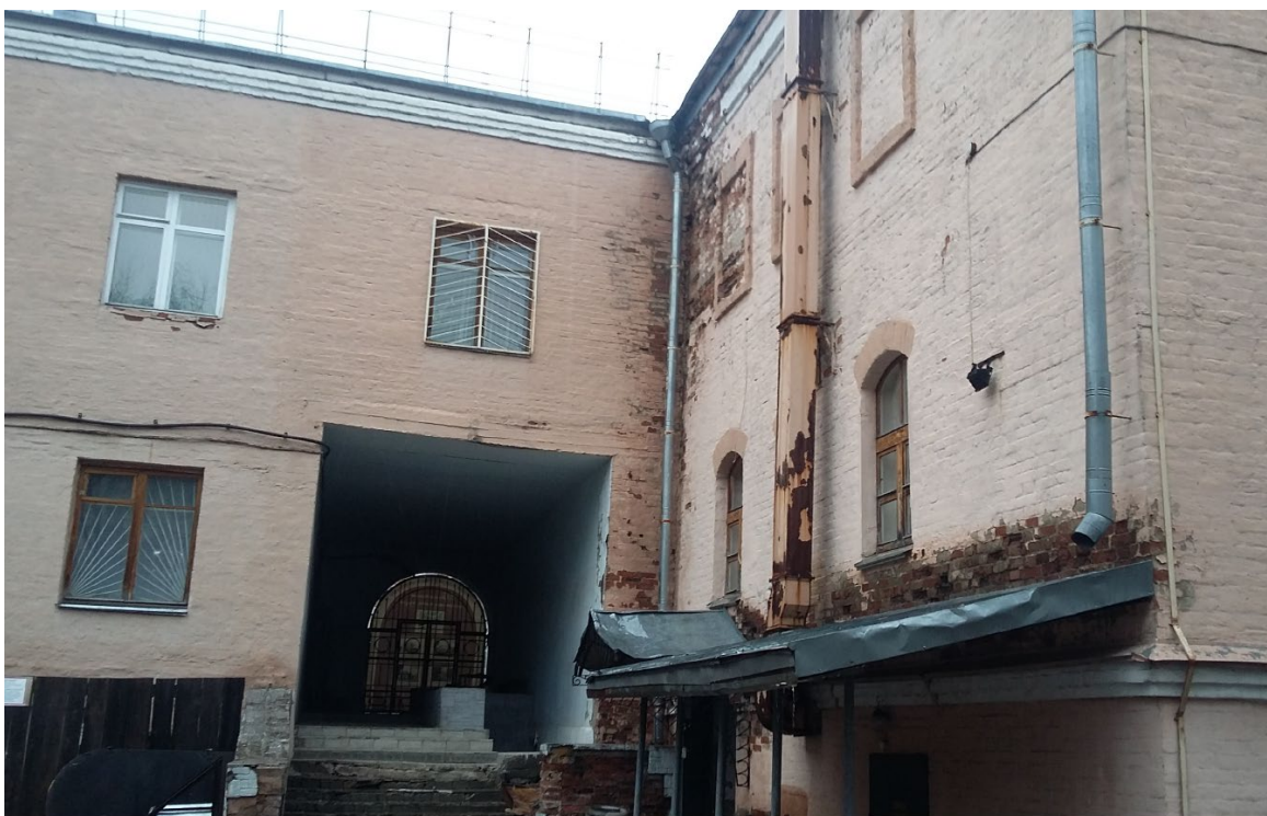
Фото 5. Фрагмент дворового фасада.
