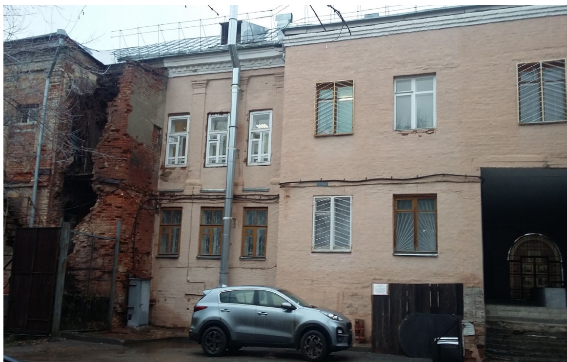
Фото 4. Фрагмент дворового фасада.
