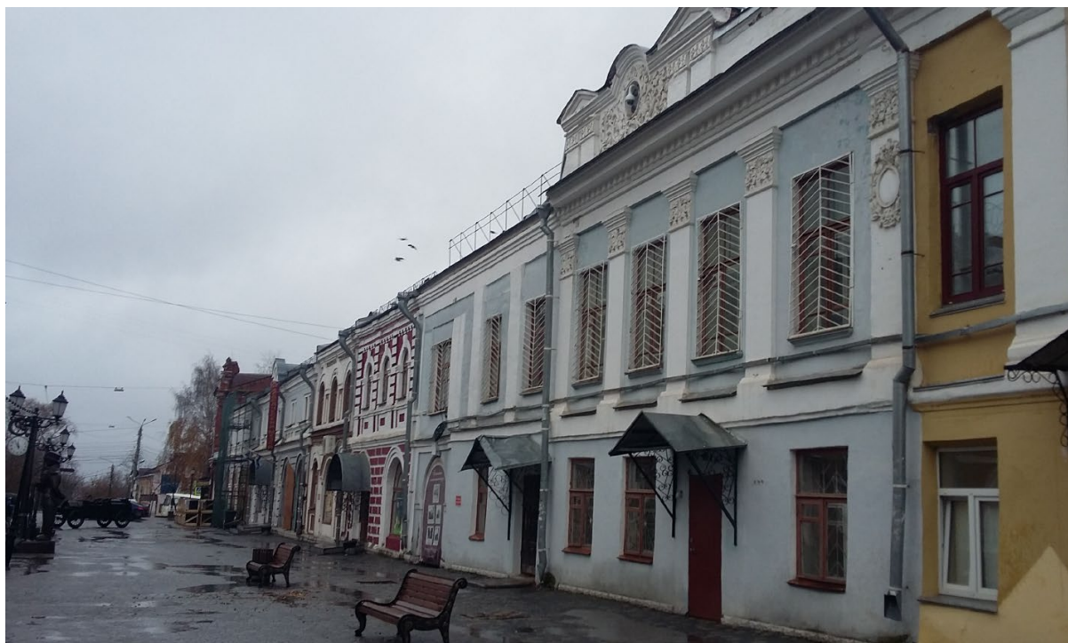
Фото 1. Общий вид Объекта с ул. Спасской.
