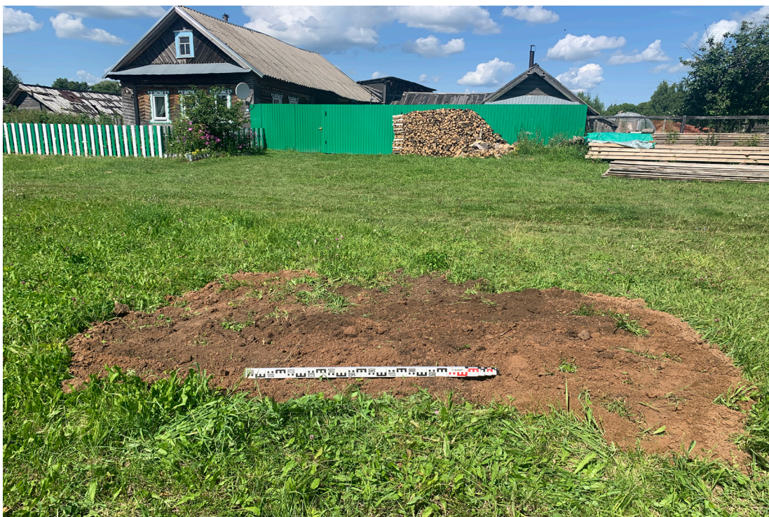
Рис. 17. Объект: «Газопровод распределительный в дер. Пивоварово Малмыжского муниципального района Кировской области». Вид с Ю на рекультивацию шурфа 1.
