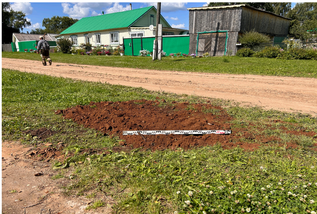
Рис. 22. Объект: «Газопровод распределительный в дер. Пивоварово Малмыжского муниципального района Кировской области». Вид с Ю на рекультивацию шурфа 2.
