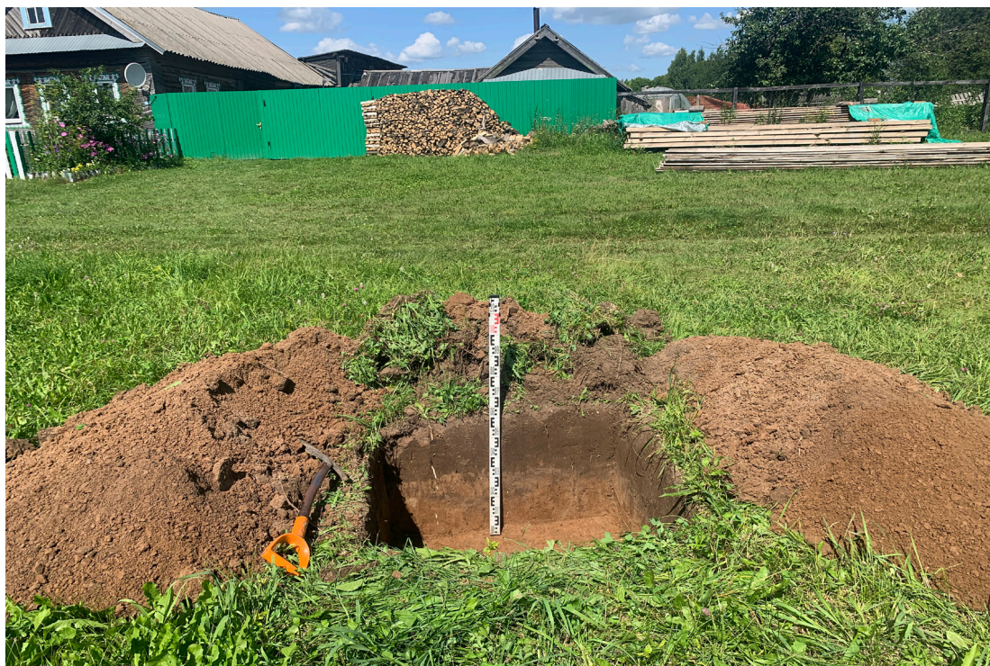
Рис. 16. Объект: «Газопровод распределительный в дер. Пивоварово Малмыжского муниципального района Кировской области». Общий вид с Ю на шурф 1.
