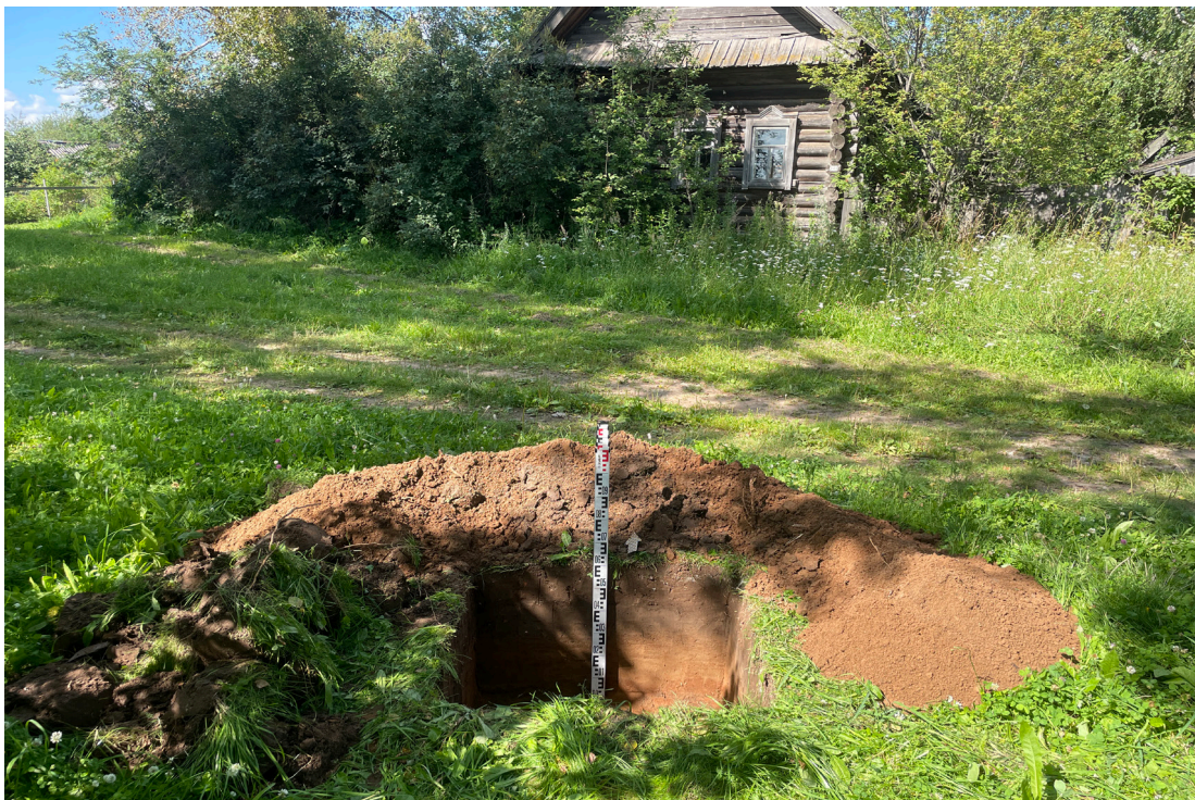
Рис. 31. Объект: «Газопровод распределительный в дер. Пивоварово Малмыжского муниципального района Кировской области». Общий вид с Ю на шурф 4.
