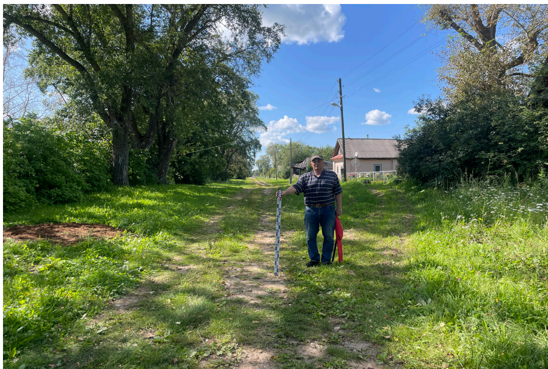
Рис. 12. Объект: «Газопровод распределительный в дер. Пивоварово Малмыжского муниципального района Кировской области». Вид из тф 2 на СЗ.
