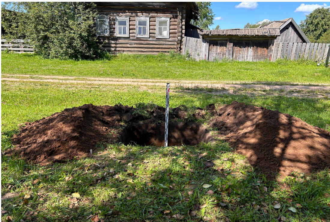
Рис. 26. Объект: «Газопровод распределительный в дер. Пивоварово Малмыжского муниципального района Кировской области». Общий вид с Ю на шурф 3.
