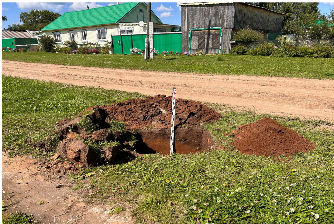
Рис. 21. Объект: «Газопровод распределительный в дер. Пивоварово Малмыжского муниципального района Кировской области». Общий вид с Ю на шурф 2.
