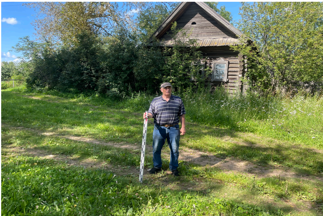
Рис. 28. Объект: «Газопровод распределительный в дер. Пивоварово Малмыжского муниципального района Кировской области». Вид с Ю на разбивку шурфа 4.
