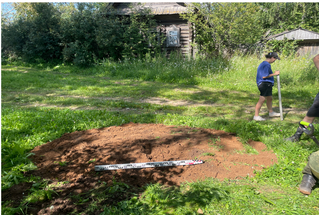
Рис. 32. Объект: «Газопровод распределительный в дер. Пивоварово Малмыжского муниципального района Кировской области». Вид с Ю на рекультивацию шурфа 4.
