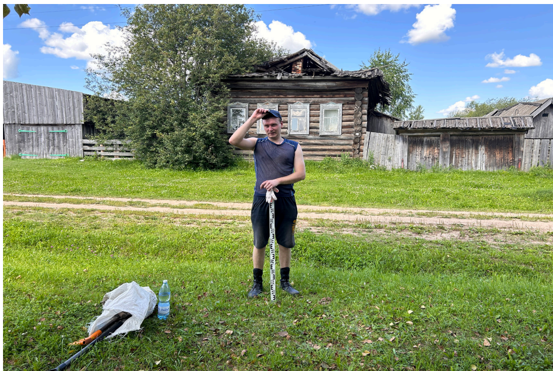
Рис. 23. Объект: «Газопровод распределительный в дер. Пивоварово Малмыжского муниципального района Кировской области». Вид с Ю на разбивку шурфа 3.
