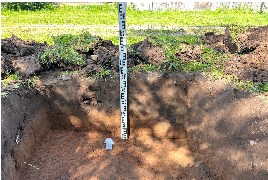
Рис. 24. Объект: «Газопровод распределительный в дер. Пивоварово Малмыжского муниципального района Кировской области». Вид с Ю на северную стенку шурфа 3.
