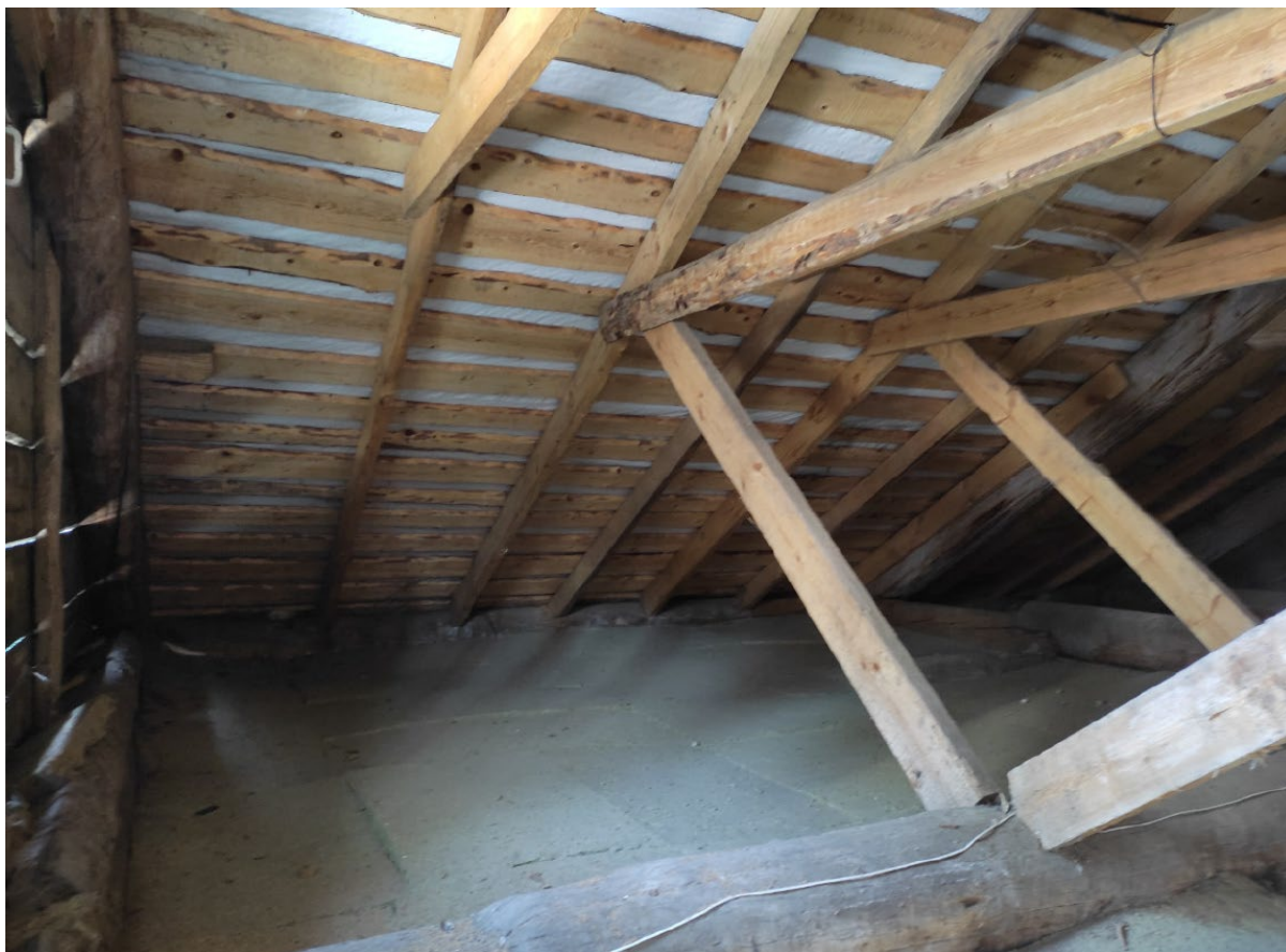
Фото 5. Стропильная система крыши здания.
