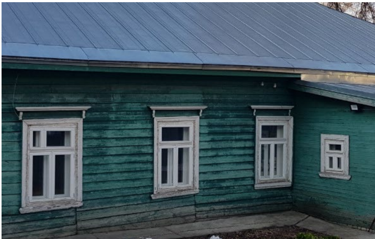
Фото 3. Фрагмент дворового фасада
