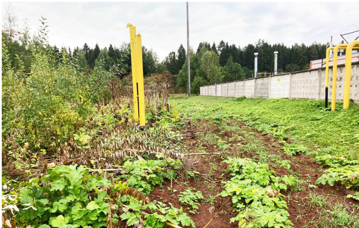
Илл. 15. Кировская область, г. Киров. Территория, отводимая под «Инженерно-технические средства охраны (ИТСО) объектов ООО «Газпром трансгаз Нижний Новгород» в составе ГРС ТЭЦ-5 и прилегающая местность Пикет фотосъемки 1. Вид с севера.
