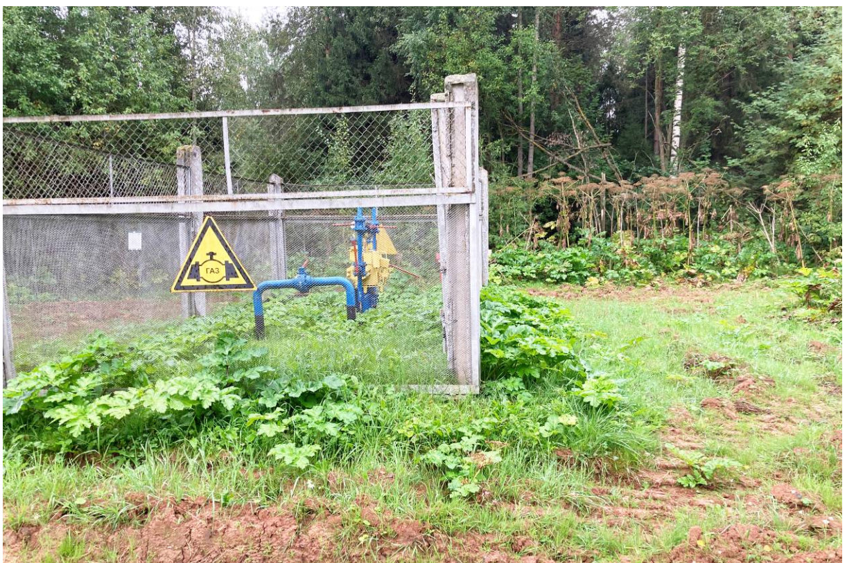
Илл. 20. Кировская область, г. Киров. Территория, отводимая под «Инженерно-технические средства охраны (ИТСО) объектов ООО «Газпром трансгаз Нижний Новгород» в составе ГРС ТЭЦ-5. Пикет фотосъемки 3. Вид с севера.
