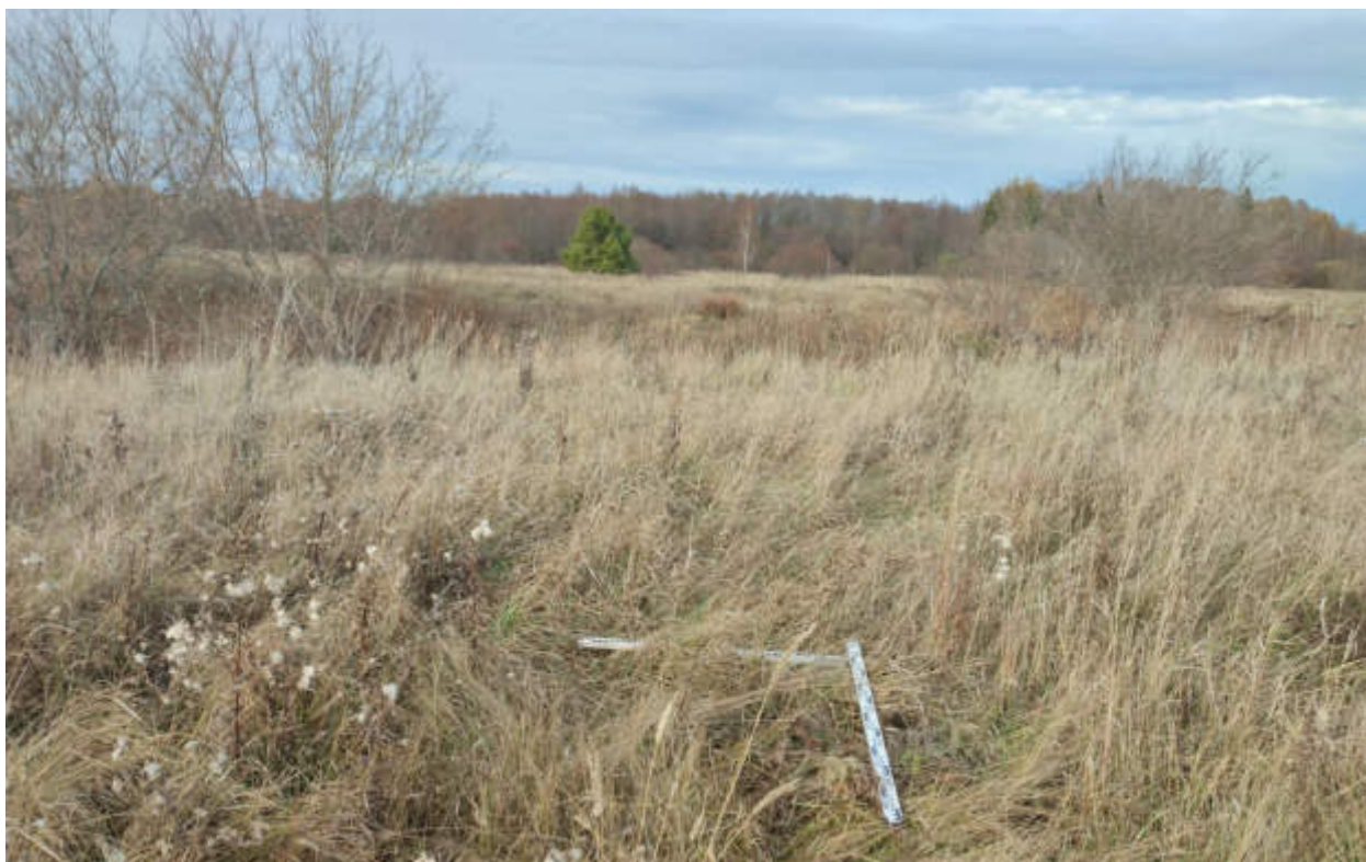
Рис.201. "Газопровод распределительный в пгт Тужа Тужинского муниципального района Кировской области" в пгт Тужа Тужинского муниципального района Кировской области. Шурф 15. Закладка. Вид с Ю.
