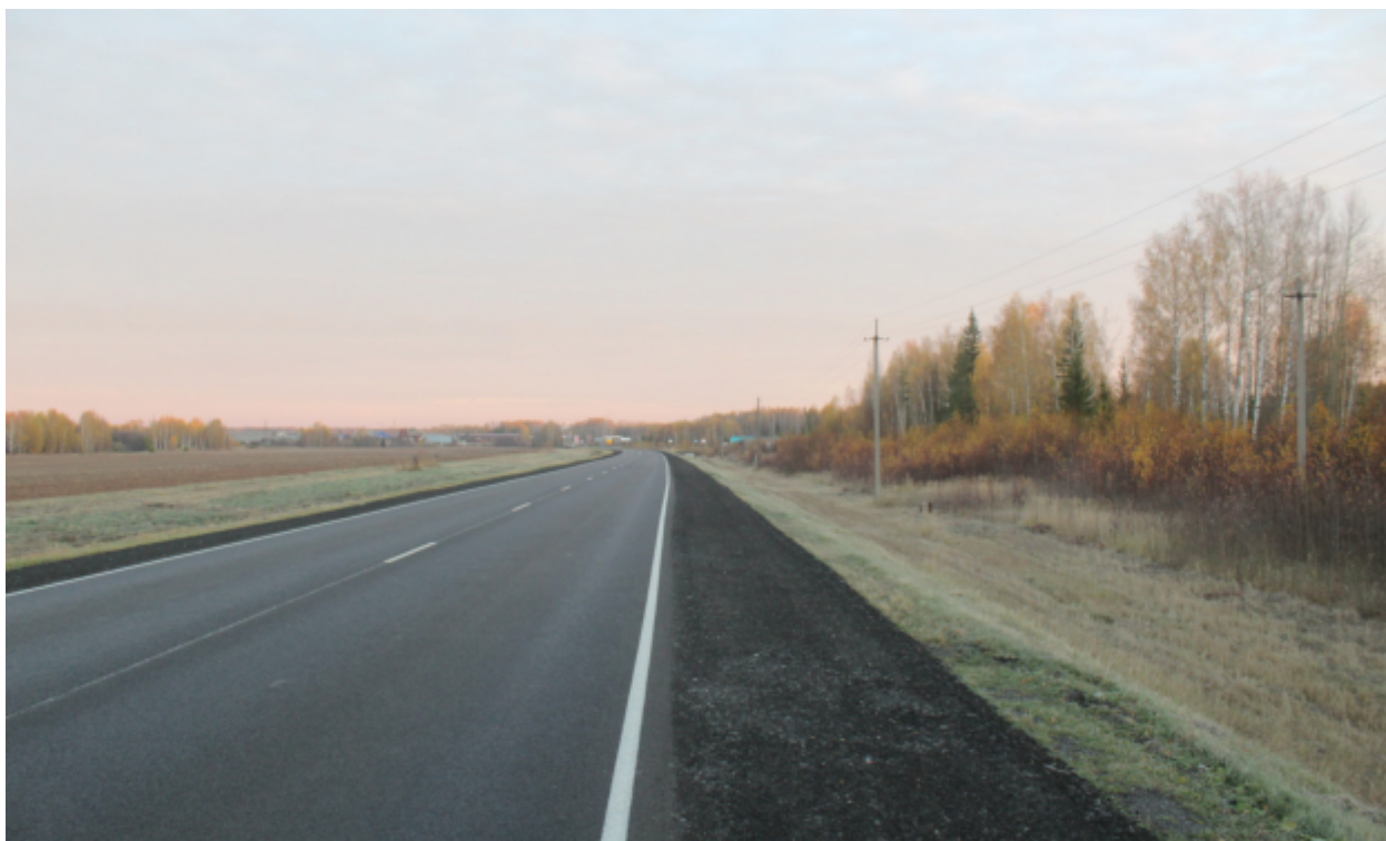
Рис.93. "Газопровод распределительный в пгт Тужа Тужинского муниципального района Кировской области" в пгт Тужа Тужинского муниципального района Кировской области. Рельеф местности и характер растительности участка обследования. Точка фотофиксации 39, вид с Ю.
