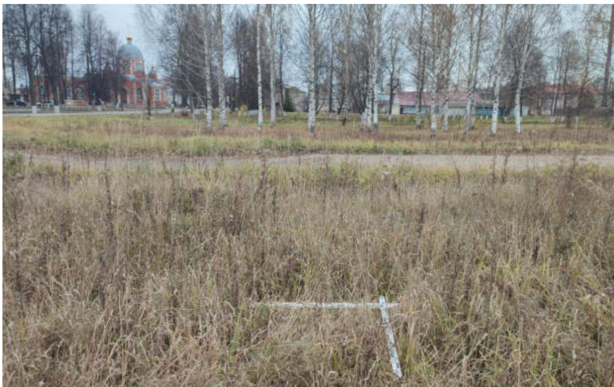
Рис.371. "Газопровод распределительный в пгт Тужа Тужинского муниципального района Кировской области" в пгт Тужа Тужинского муниципального района Кировской области. Шурф 49. Закладка. Вид с Ю.
