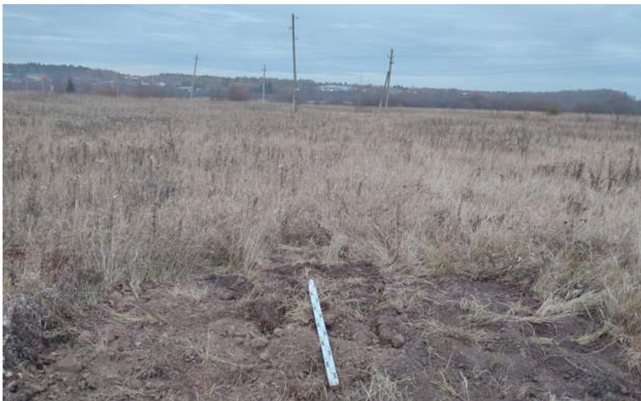
Рис.215. "Газопровод распределительный в пгт Тужа Тужинского муниципального района Кировской области" в пгт Тужа Тужинского муниципального района Кировской области. Шурф 17. Рекультивация. Вид с Ю.
