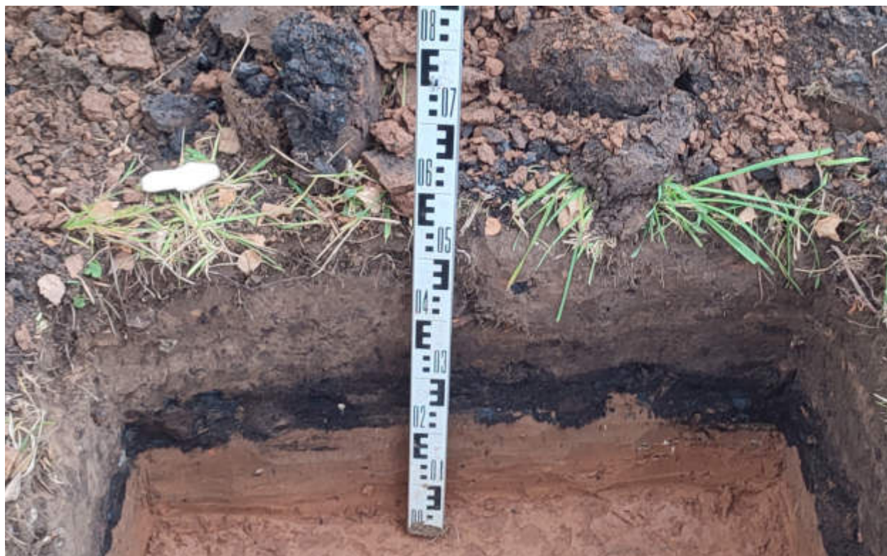
Рис.248. "Газопровод распределительный в пгт Тужа Тужинского муниципального района Кировской области" в пгт Тужа Тужинского муниципального района Кировской области. Шурф 24. Западный борт. Вид с В.
