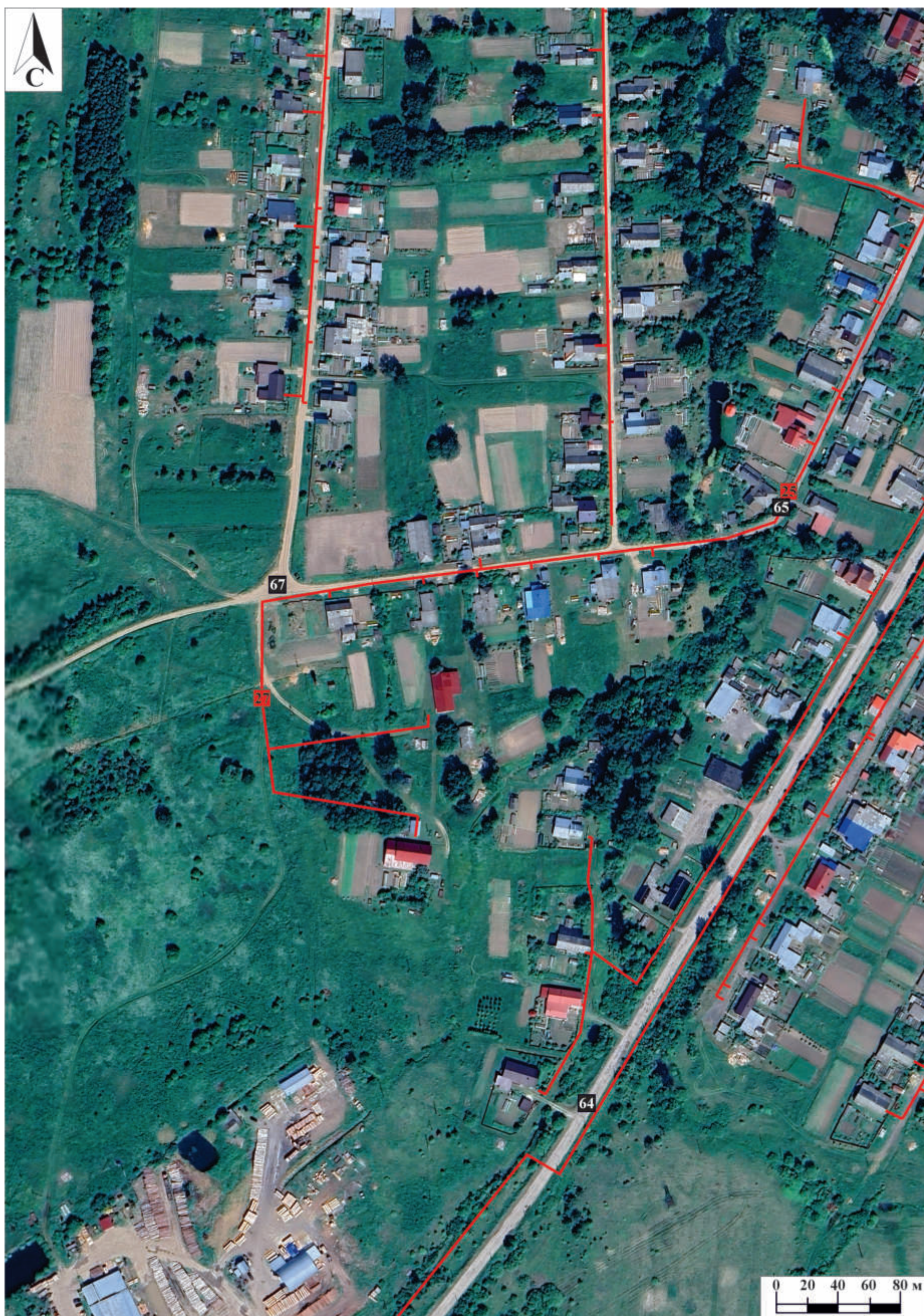
Рис.44. "Газопровод распределительный в пгт Туза Тужинского муниципального района Кировской области" в пгт Туза Тужинского муниципального района Кировской области. Обследованная территория на спутниковом снимке (сервис Google Планета Земля) с указанием точек фотофиксации и местоположения разведочных шурфов (13). Дата обращения: 10.09.2025 г. Дата снимка: июль, 2025 г.
