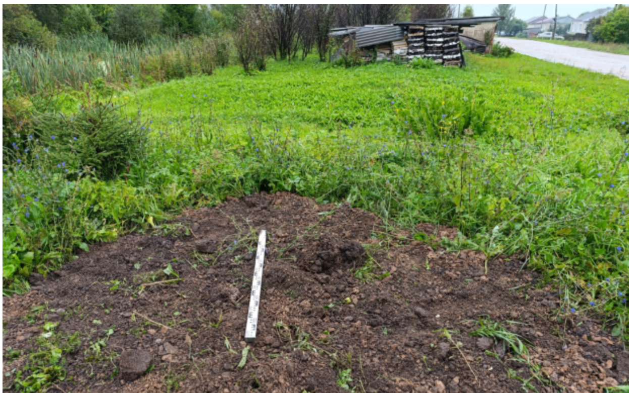
Рис.320. "Газопровод распределительный в пгт Тужа Тужинского муниципального района Кировской области" в пгт Тужа Тужинского муниципального района Кировской области. Шурф 38. Рекультивация. Вид с Ю.
