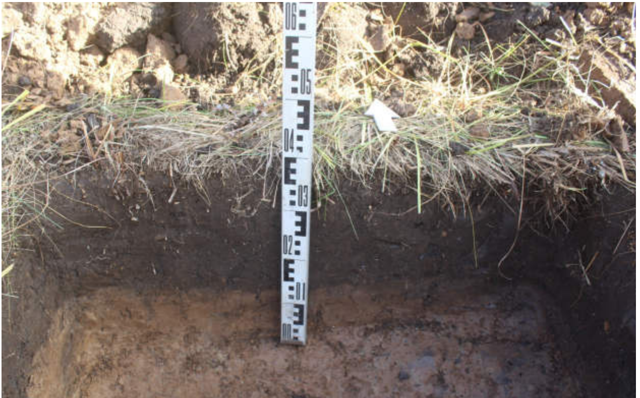
Рис.153. "Газопровод распределительный в пгт Тужа Тужинского муниципального района Кировской области" в пгт Тужа Тужинского муниципального района Кировской области. Шурф 5. Северный борт. Вид с Ю.
