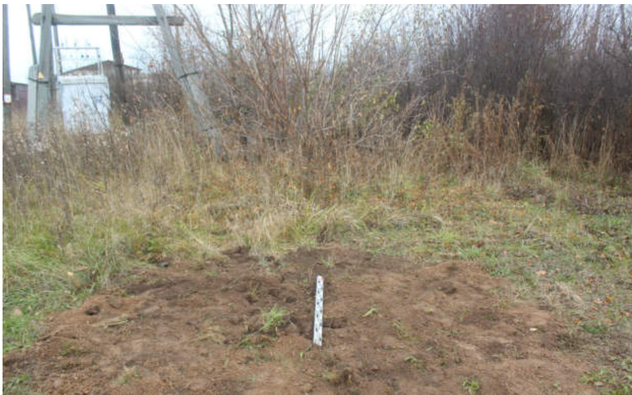
Рис.290. "Газопровод распределительный в пгт Тужа Тужинского муниципального района Кировской области" в пгт Тужа Тужинского муниципального района Кировской области. Шурф 32. Рекультивация. Вид с Ю.
