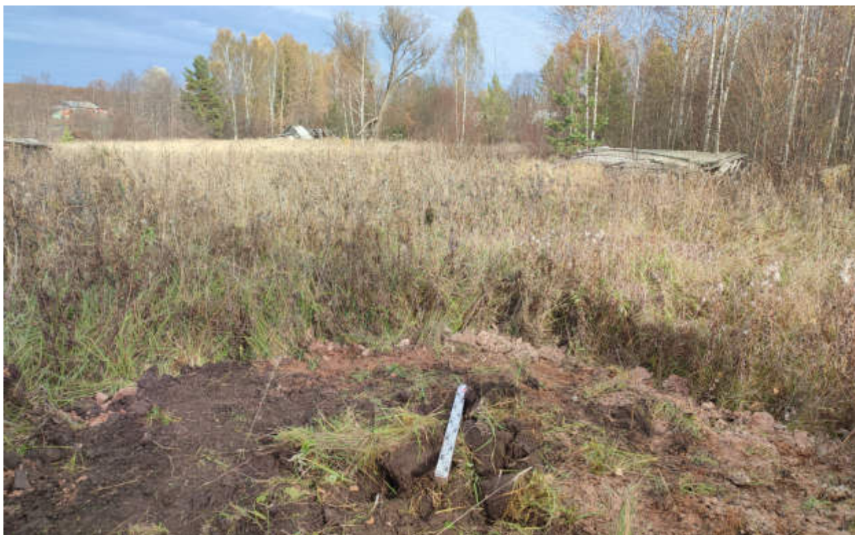
Рис.165. "Газопровод распределительный в пгт Тужа Тужинского муниципального района Кировской области" в пгт Тужа Тужинского муниципального района Кировской области. Шурф 7. Рекультивация. Вид с Ю.
