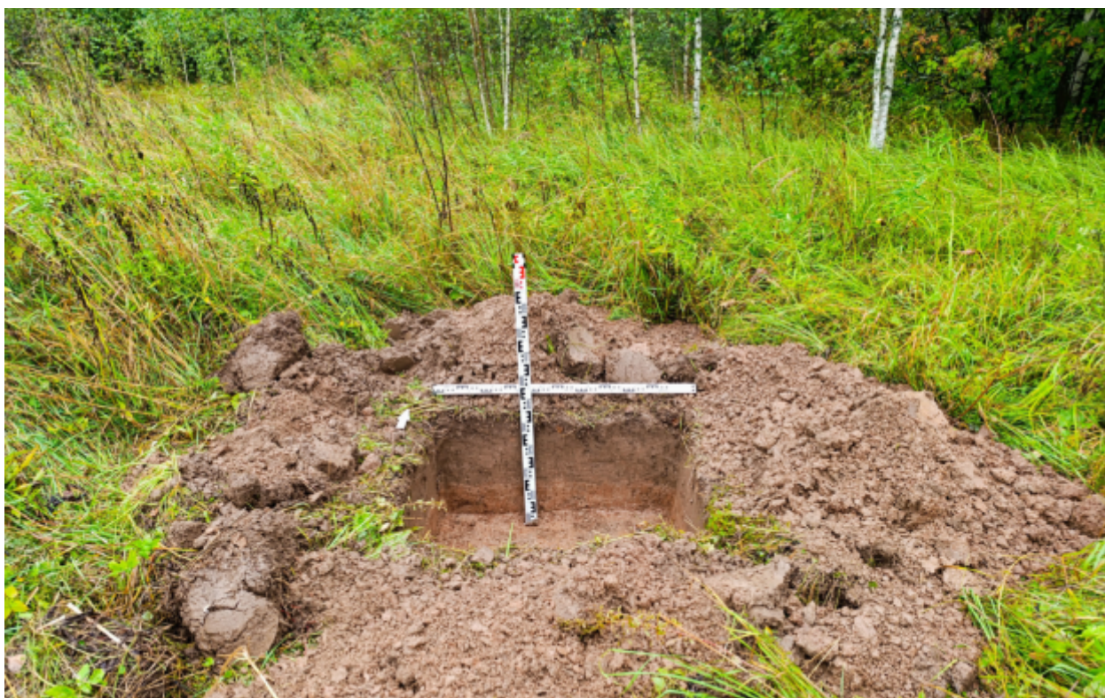
Рис.322. "Газопровод распределительный в пгт Тужа Тужинского муниципального района Кировской области" в пгт Тужа Тужинского муниципального района Кировской области. Шурф 39. Антураж. Вид с Ю.
