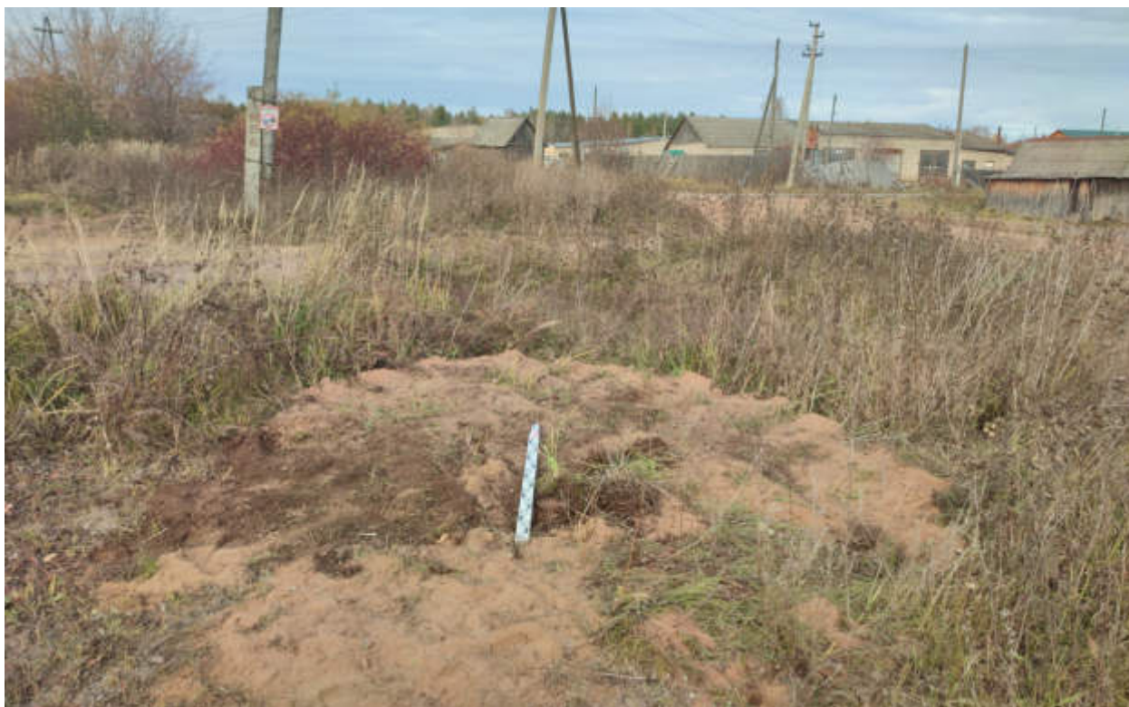
Рис.195. "Газопровод распределительный в пгт Тужа Тужинского муниципального района Кировской области" в пгт Тужа Тужинского муниципального района Кировской области. Шурф 13. Рекультивация. Вид с Ю.
