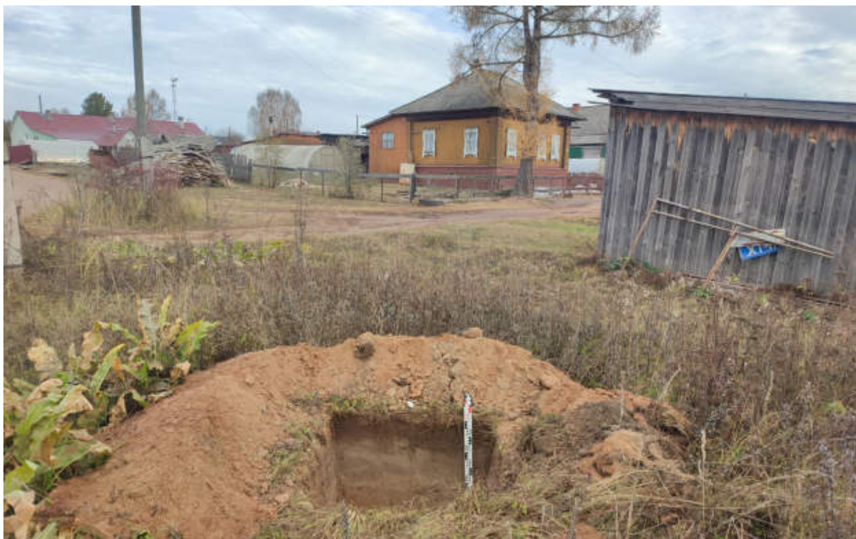
Рис.357. "Газопровод распределительный в пгт Тужа Тужинского муниципального района Кировской области" в пгт Тужа Тужинского муниципального района Кировской области. Шурф 46 Антураж. Вид с Ю.
