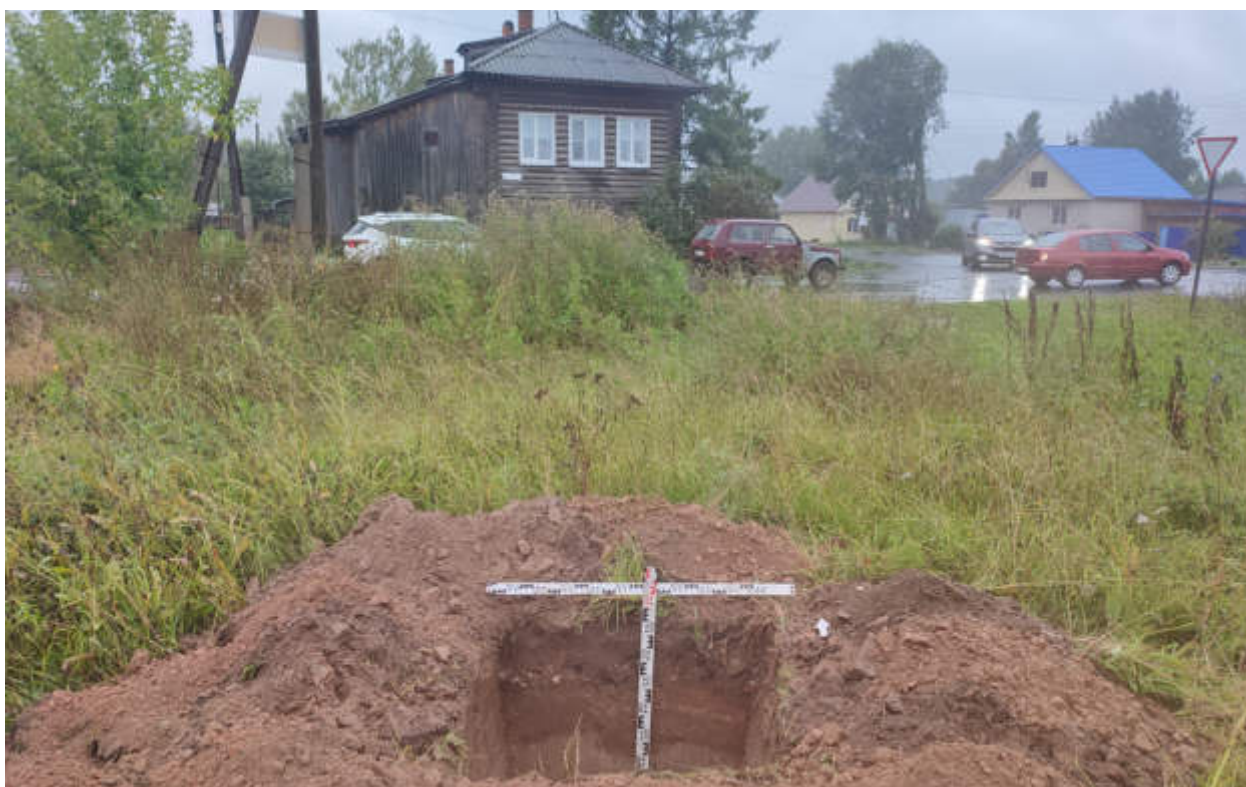
Рис.337. "Газопровод распределительный в пгт Тужа Тужинского муниципального района Кировской области" в пгт Тужа Тужинского муниципального района Кировской области. Шурф 42. Антураж. Вид с Ю.
