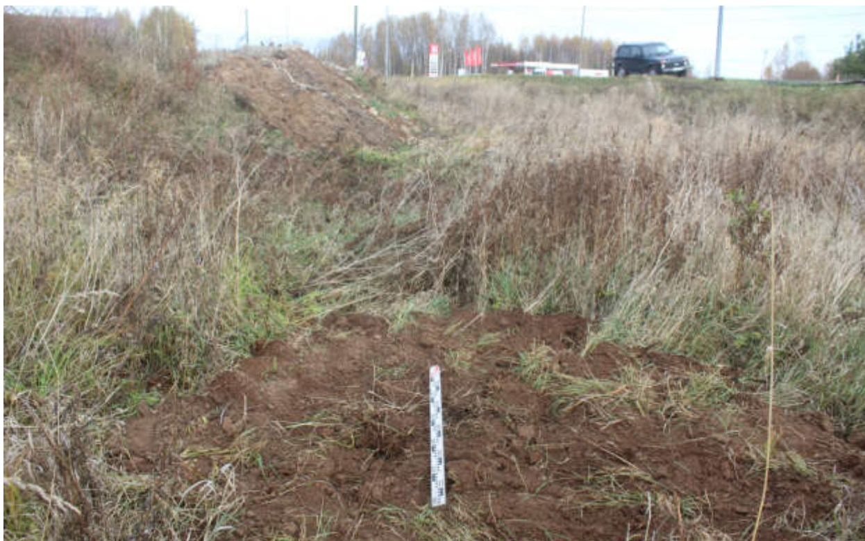
Рис.220. "Газопровод распределительный в пгт Тужа Тужинского муниципального района Кировской области" в пгт Тужа Тужинского муниципального района Кировской области. Шурф 18. Рекультивация. Вид с Ю.
