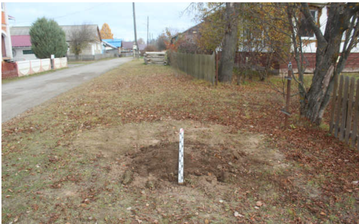
Рис.255. "Газопровод распределительный в пгт Туза Тужинского муниципального района Кировской области" в пгт Туза Тужинского муниципального района Кировской области. Шурф 25. Рекультивация. Вид с Ю.
