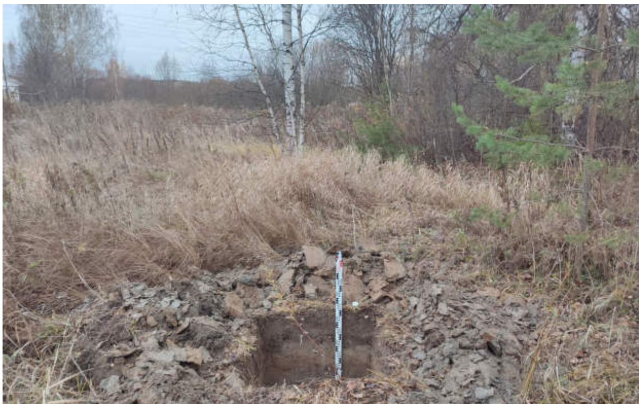
Рис.232. "Газопровод распределительный в пгт Тужа Тужинского муниципального района Кировской области" в пгт Тужа Тужинского муниципального района Кировской области. Шурф 21. Антураж. Вид с Ю.
