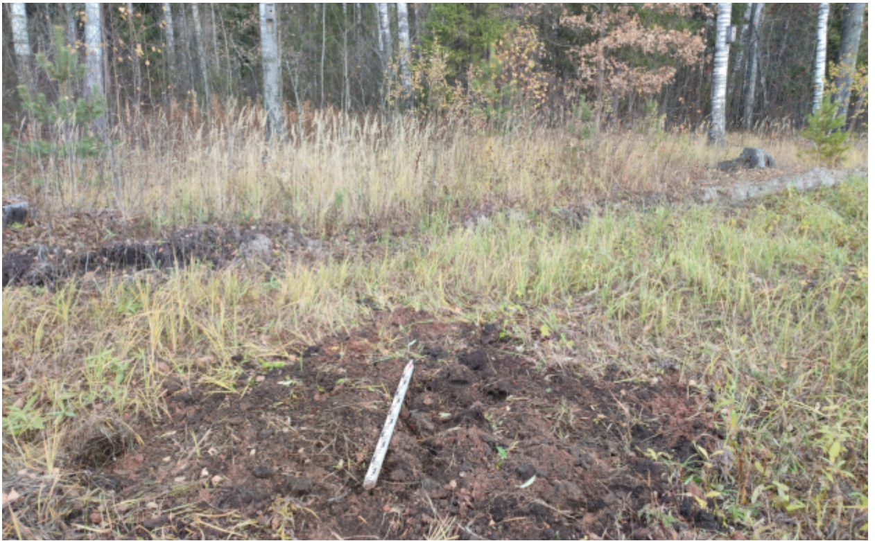
Рис.185. "Газопровод распределительный в пгт Тужа Тужинского муниципального района Кировской области" в пгт Тужа Тужинского муниципального района Кировской области. Шурф 11. Рекультивация. Вид с Ю.
