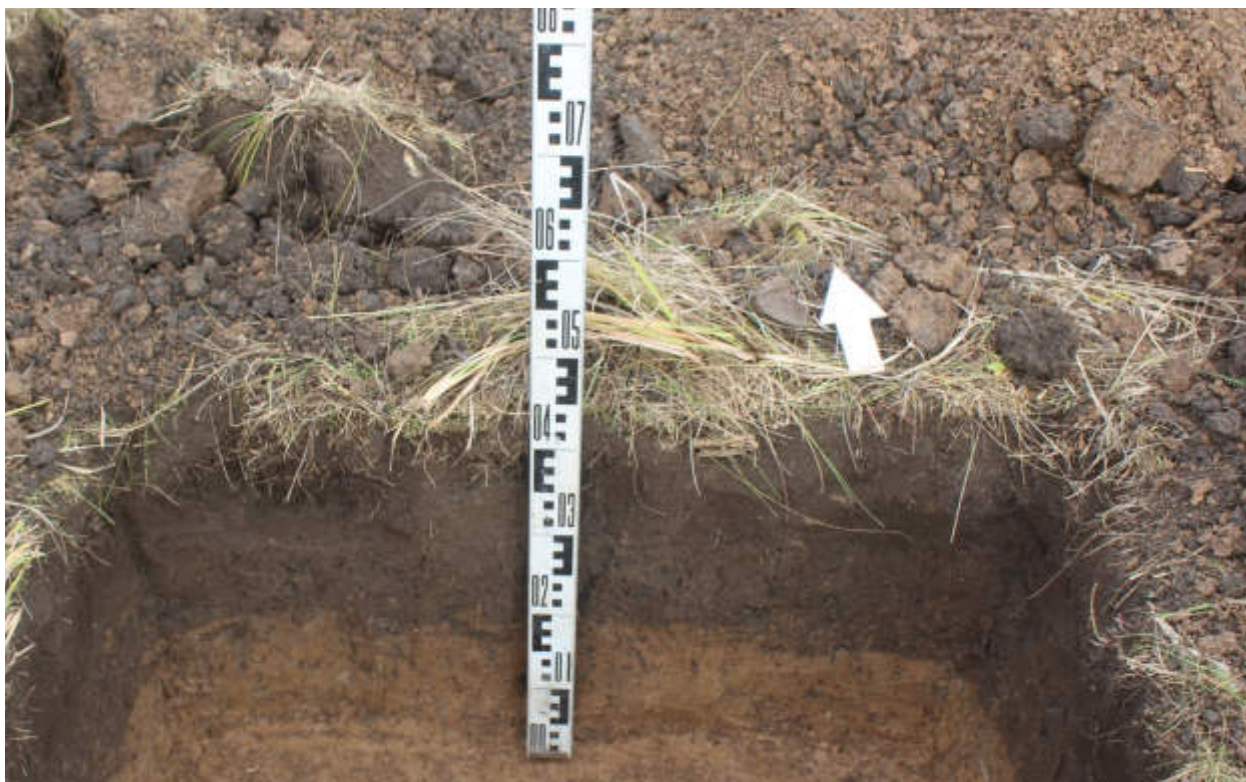
Рис.298. "Газопровод распределительный в пгт Туза Тужинского муниципального района Кировской области" в пгт Туза Тужинского муниципального района Кировской области. Шурф 34. Северный борт. Вид с Ю.
