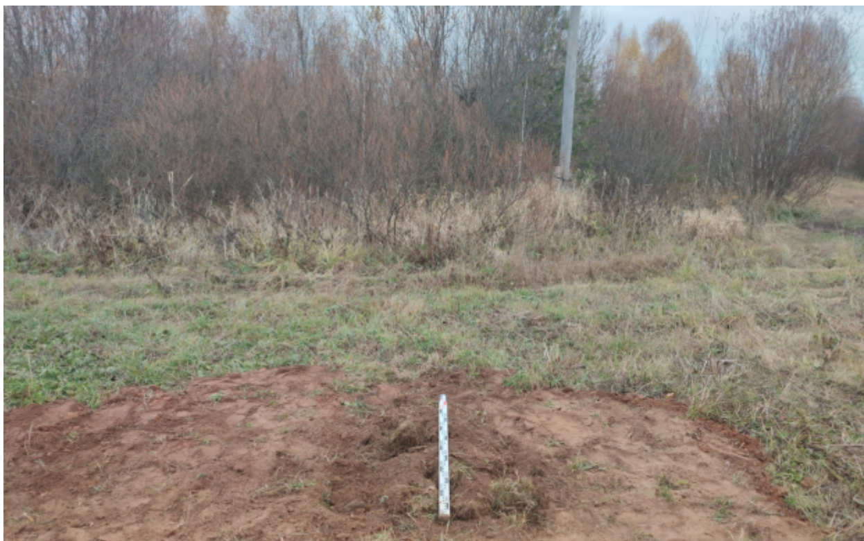
Рис.240. "Газопровод распределительный в пгт Тужа Тужинского муниципального района Кировской области" в пгт Тужа Тужинского муниципального района Кировской области. Шурф 22. Рекультивация. Вид с Ю.
