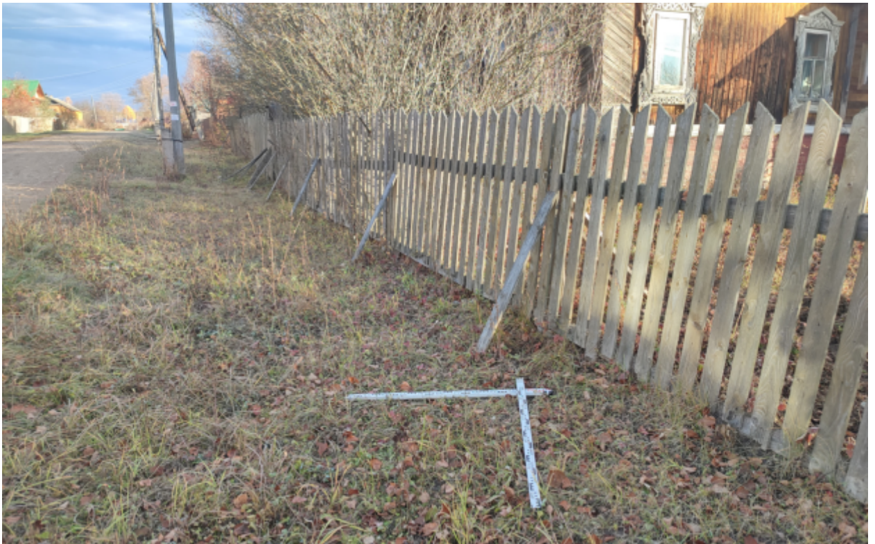
Рис.146. "Газопровод распределительный в пгт Тужа Тужинского муниципального района Кировской области" в пгт Тужа Тужинского муниципального района Кировской области. Шурф 4. Закладка. Вид с Ю.
