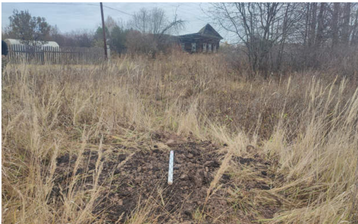
Рис.145. "Газопровод распределительный в пгт Тужа Тужинского муниципального района Кировской области" в пгт Тужа Тужинского муниципального района Кировской области. Шурф 3. Рекультивация. Вид с Ю.
