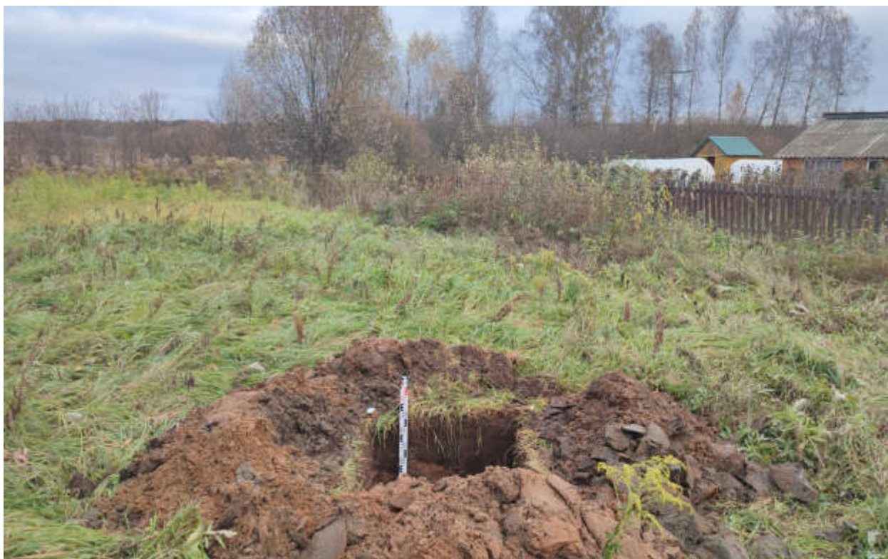
Рис.367. "Газопровод распределительный в пгт Тужа Тужинского муниципального района Кировской области" в пгт Тужа Тужинского муниципального района Кировской области. Шурф 48. Антураж. Вид с Ю.
