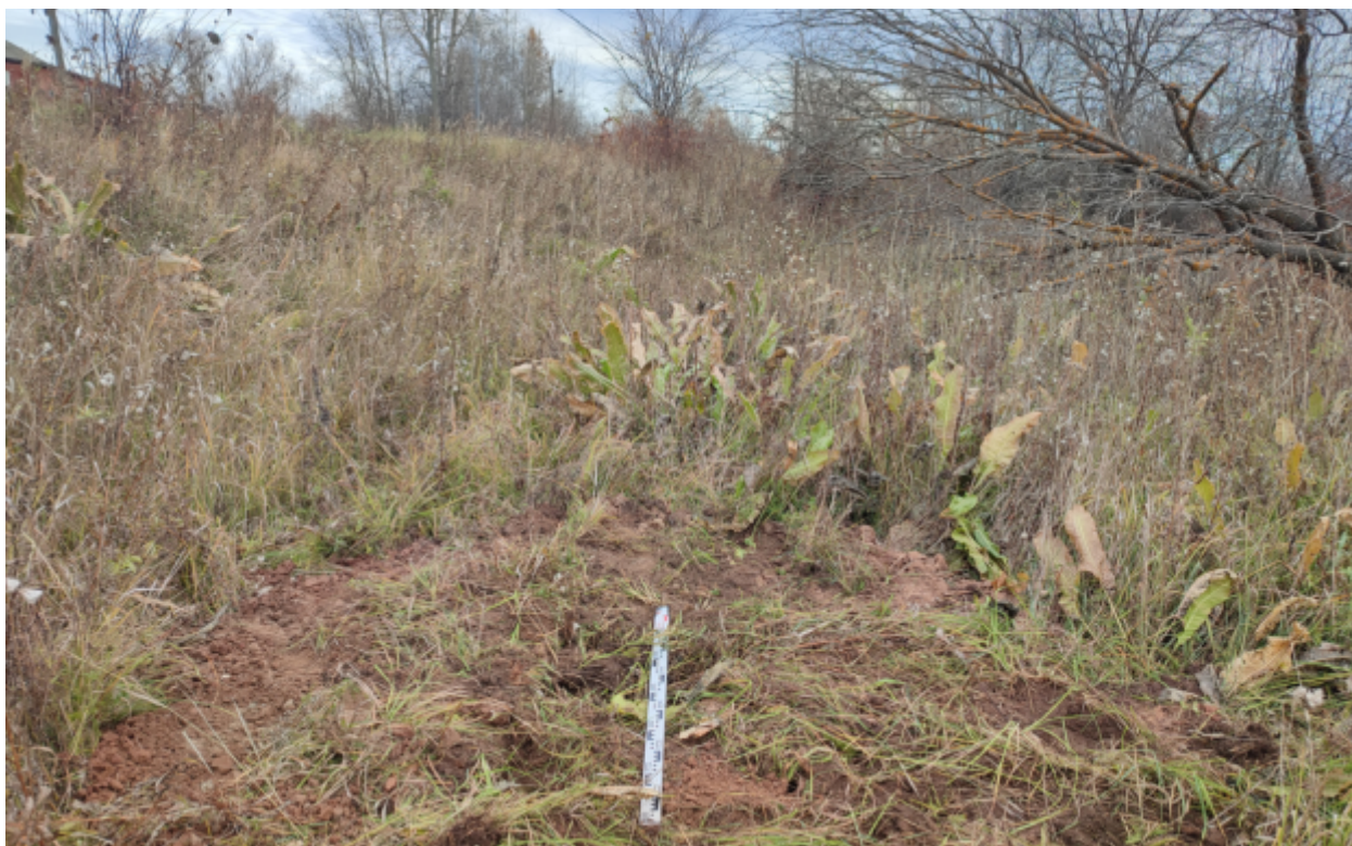
Рис.170. "Газопровод распределительный в пгт Тужа Тужинского муниципального района Кировской области" в пгт Тужа Тужинского муниципального района Кировской области. Шурф 8. Рекультивация. Вид с Ю.
