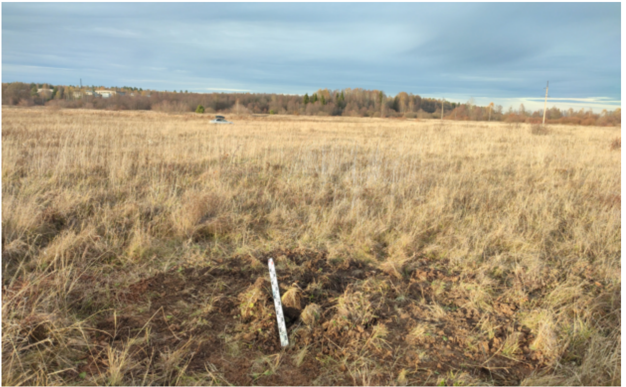
Рис.200. "Газопровод распределительный в пгт Тужа Тужинского муниципального района Кировской области" в пгт Тужа Тужинского муниципального района Кировской области. Шурф 14. Рекультивация. Вид с Ю.
