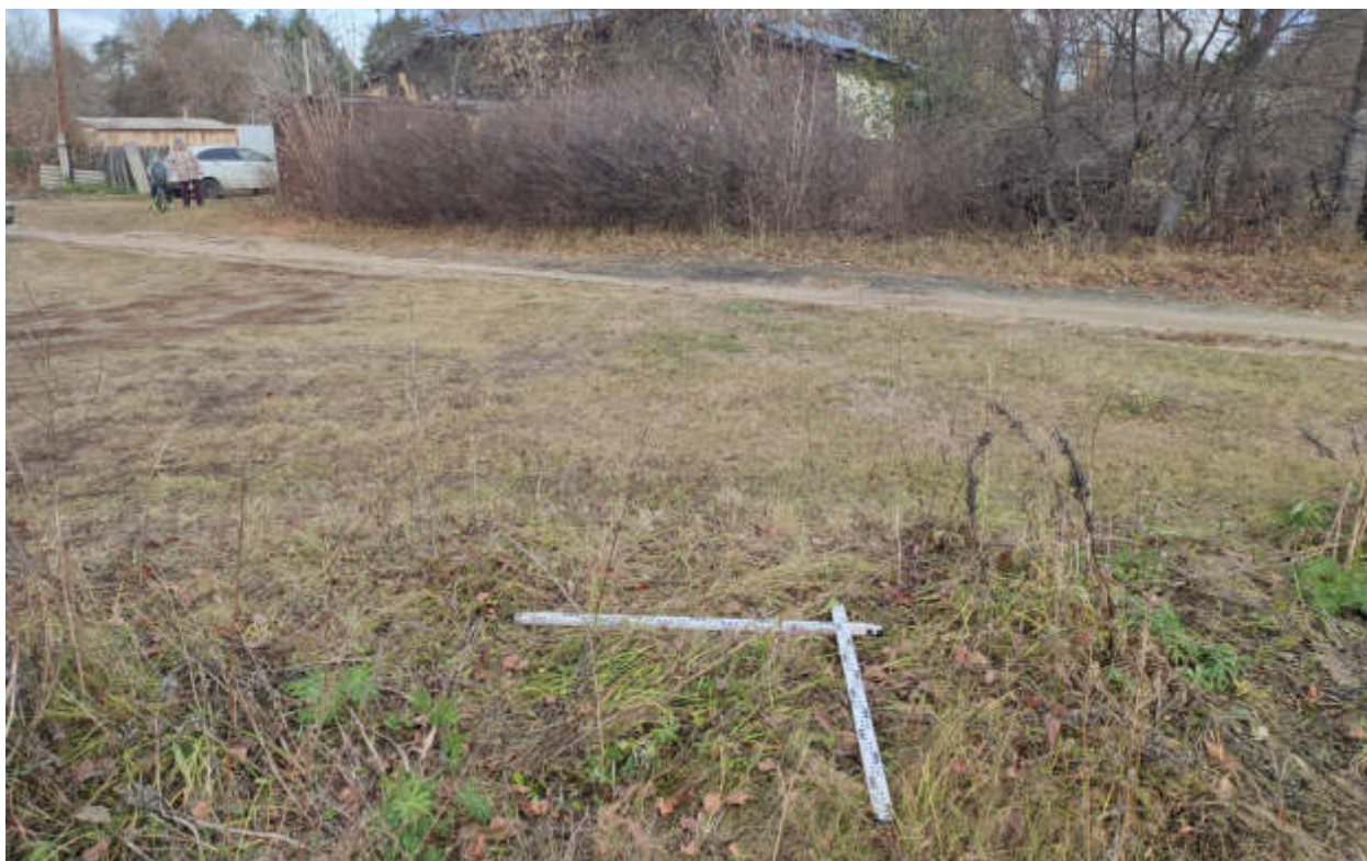
Рис.176. "Газопровод распределительный в пгт Туза Тужинского муниципального района Кировской области" в пгт Туза Тужинского муниципального района Кировской области. Шурф 10. Закладка. Вид с Ю.
