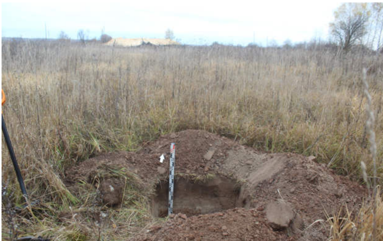
Рис.292. "Газопровод распределительный в пгт Тужа Тужинского муниципального района Кировской области" в пгт Тужа Тужинского муниципального района Кировской области. Шурф 33. Антураж. Вид с Ю.
