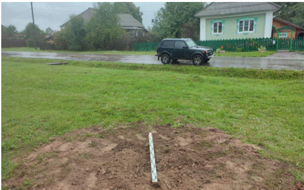
Рис.335. "Газопровод распределительный в пгт Тужа Тужинского муниципального района Кировской области" в пгт Тужа Тужинского муниципального района Кировской области. Шурф 41. Рекультивация. Вид с Ю.
