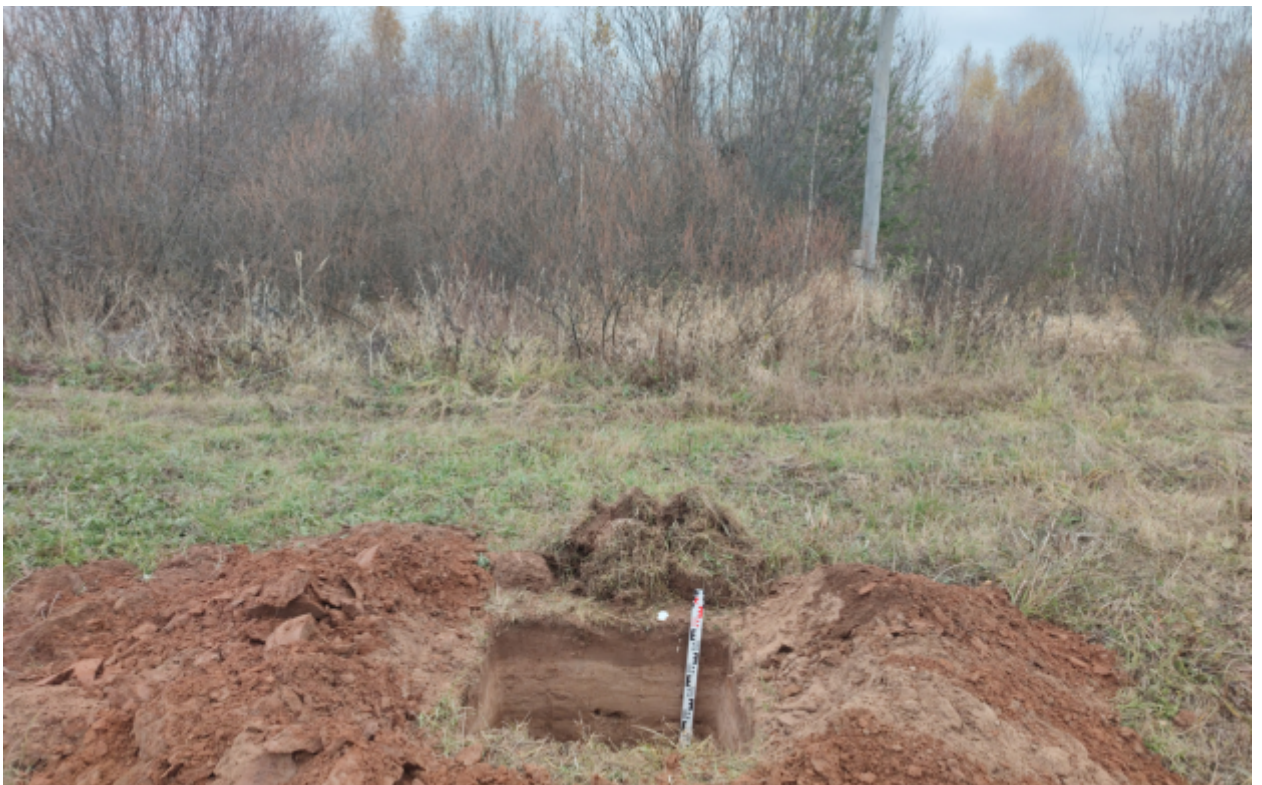
Рис.237. "Газопровод распределительный в пгт Тужа Тужинского муниципального района Кировской области" в пгт Тужа Тужинского муниципального района Кировской области. Шурф 22. Антураж. Вид с Ю.
