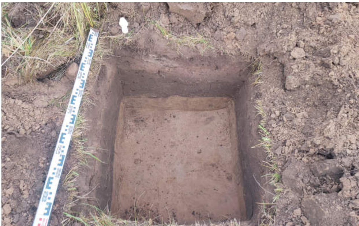
Рис.159. "Газопровод распределительный в пгт Туза Тужинского муниципального района Кировской области" в пгт Туза Тужинского муниципального района Кировской области. Шурф 6. Материк. Вид с Ю.
