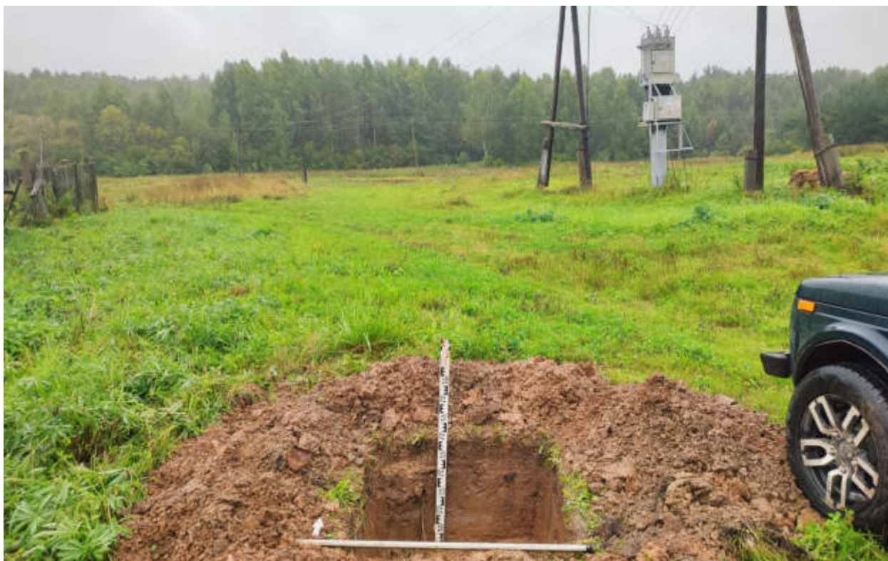
Рис.312. "Газопровод распределительный в пгт Тужа Тужинского муниципального района Кировской области" в пгт Тужа Тужинского муниципального района Кировской области. Шурф 37. Антураж. Вид с Ю.
