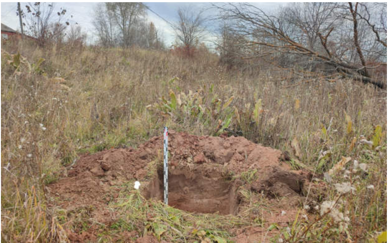
Рис.167. "Газопровод распределительный в пгт Тужа Тужинского муниципального района Кировской области" в пгт Тужа Тужинского муниципального района Кировской области. Шурф 8. Антураж. Вид с Ю.
