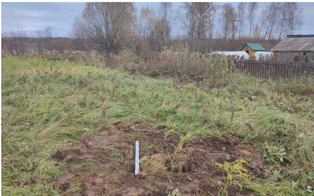
Рис.370. "Газопровод распределительный в пгт Тужа Тужинского муниципального района Кировской области" в пгт Тужа Тужинского муниципального района Кировской области. Шурф 48. Рекультивация. Вид с Ю.
