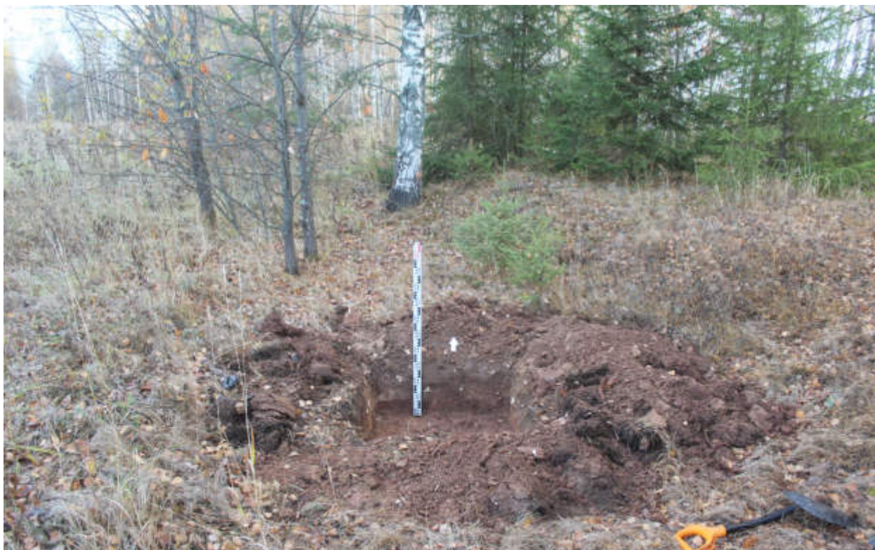
Рис.282. "Газопровод распределительный в пгт Тужа Тужинского муниципального района Кировской области" в пгт Тужа Тужинского муниципального района Кировской области. Шурф 31. Антураж. Вид с Ю.
