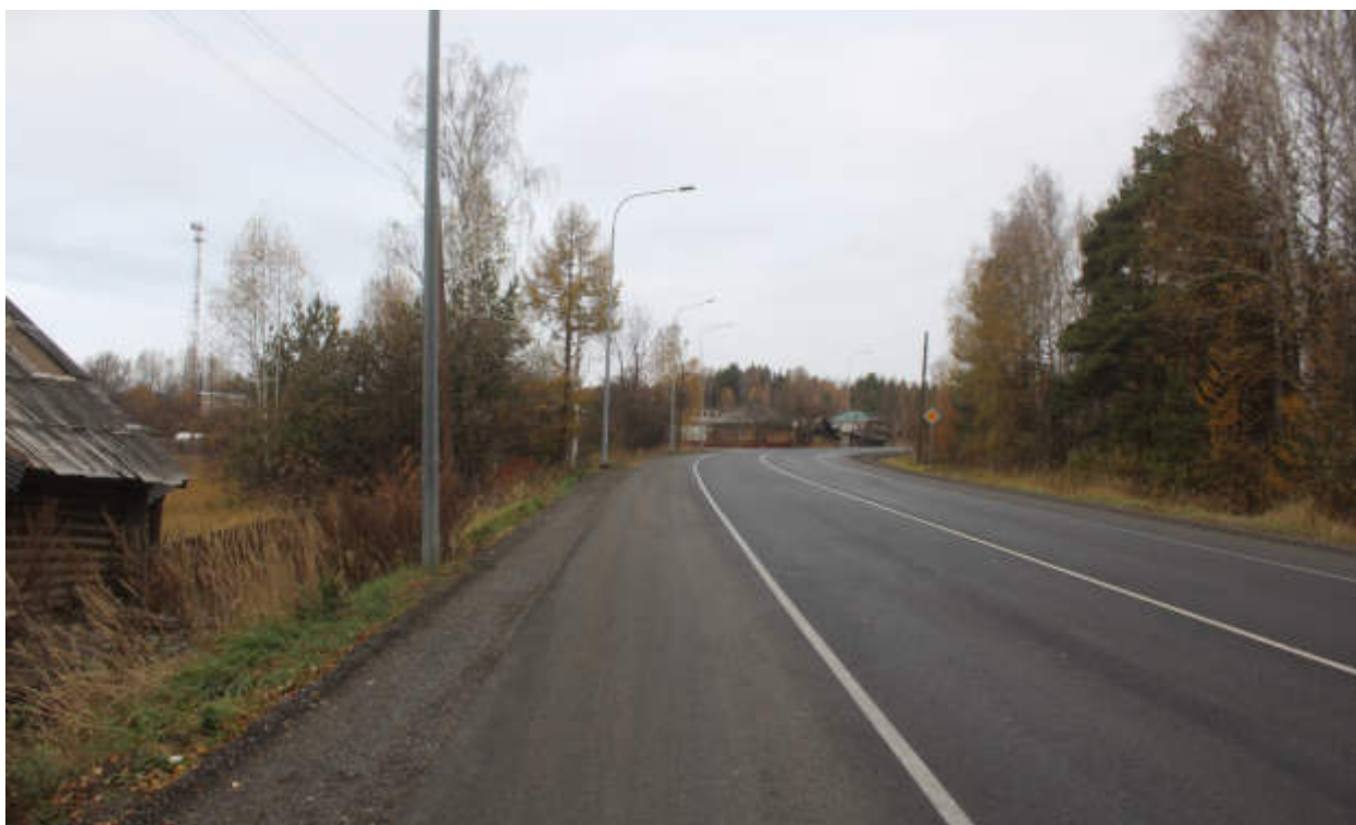
Рис.64. "Газопровод распределительный в пгт Туза Тужинского муниципального района Кировской области" в пгт Туза Тужинского муниципального района Кировской области. Рельеф местности и характер растительности участка обследования. Точка фотофиксации 10, вид с ЮВ.
