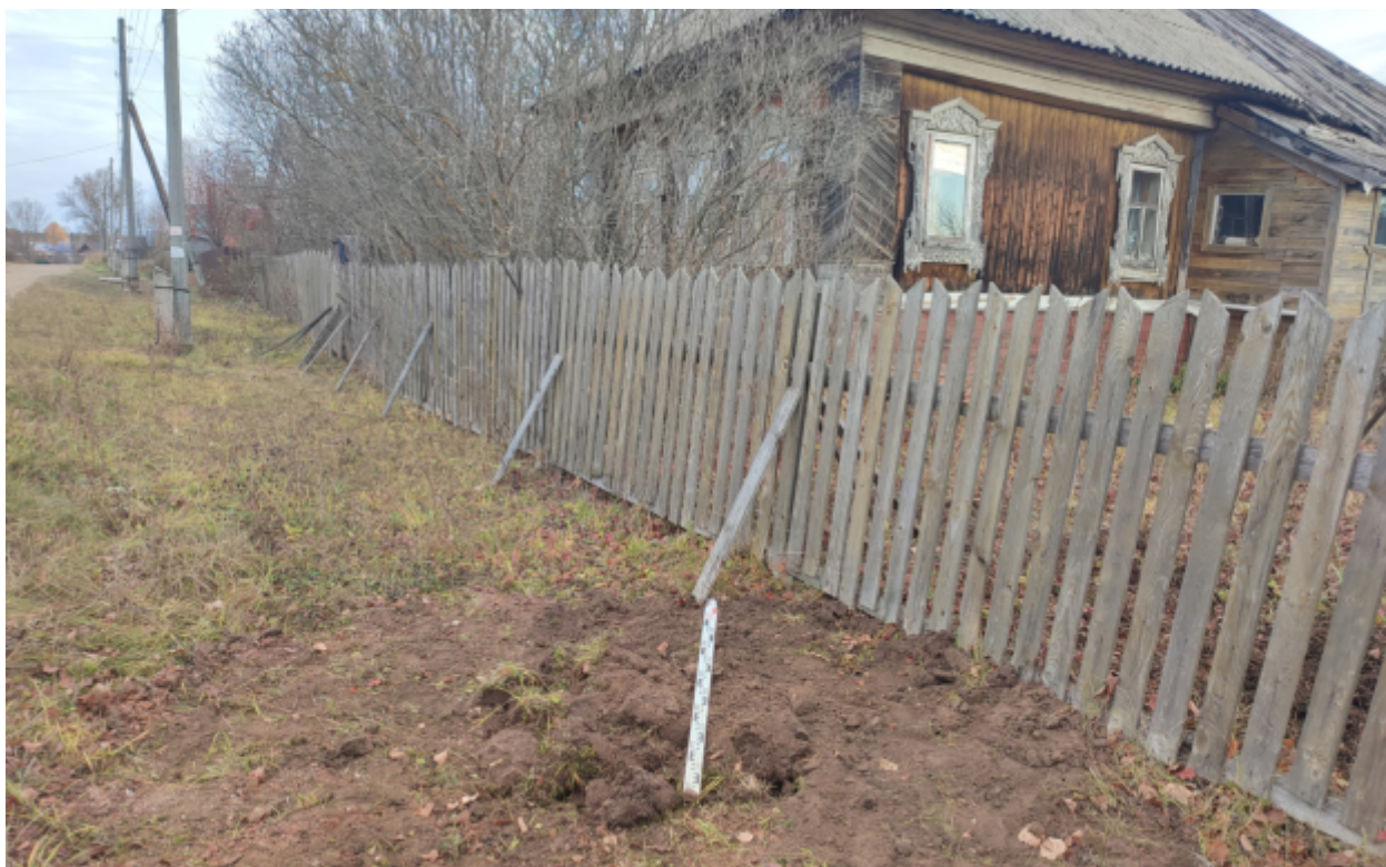
Рис.150. "Газопровод распределительный в пгт Тужа Тужинского муниципального района Кировской области" в пгт Тужа Тужинского муниципального района Кировской области. Шурф 4. Рекультивация. Вид с Ю.
