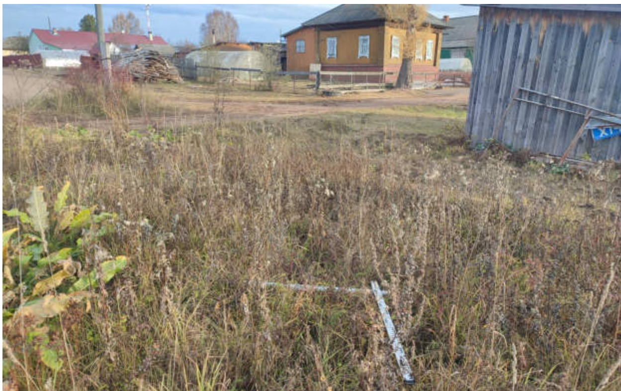
Рис.356. "Газопровод распределительный в пгт Тужа Тужинского муниципального района Кировской области" в пгт Тужа Тужинского муниципального района Кировской области. Шурф 46. Закладка. Вид с Ю.
