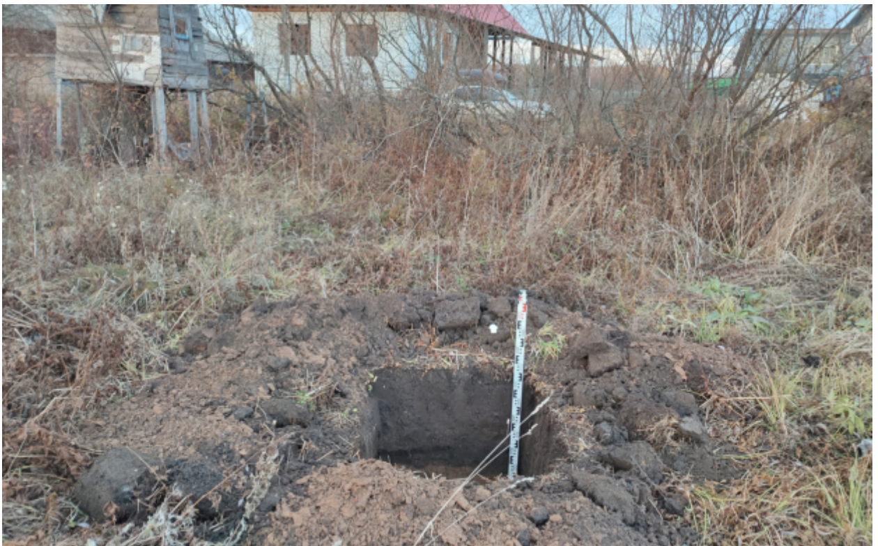
Рис.222. "Газопровод распределительный в пгт Тужа Тужинского муниципального района Кировской области" в пгт Тужа Тужинского муниципального района Кировской области. Шурф 19. Антураж. Вид с Ю.
