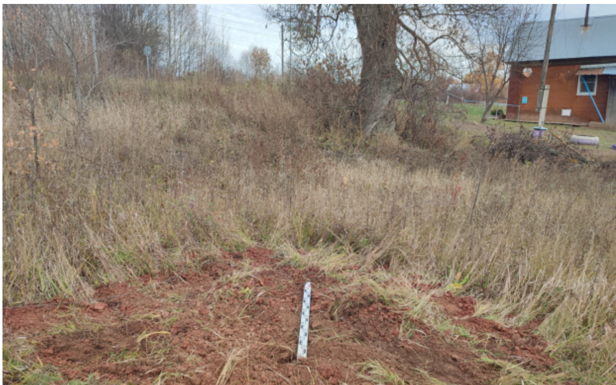
Рис.175. "Газопровод распределительный в пгт Тужа Тужинского муниципального района Кировской области" в пгт Тужа Тужинского муниципального района Кировской области. Шурф 9. Рекультивация. Вид с Ю.
