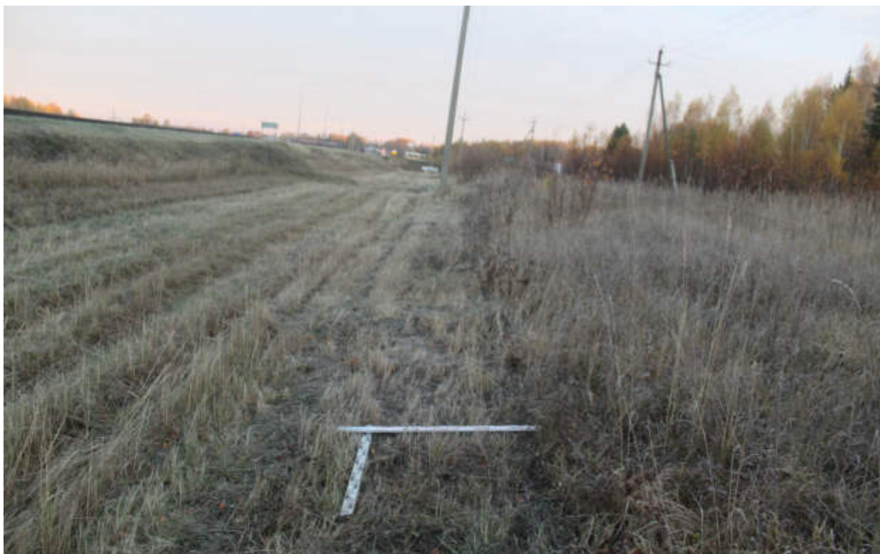
Рис.376. "Газопровод распределительный в пгт Тужа Тужинского муниципального района Кировской области" в пгт Тужа Тужинского муниципального района Кировской области. Шурф 50. Закладка. Вид с Ю.
