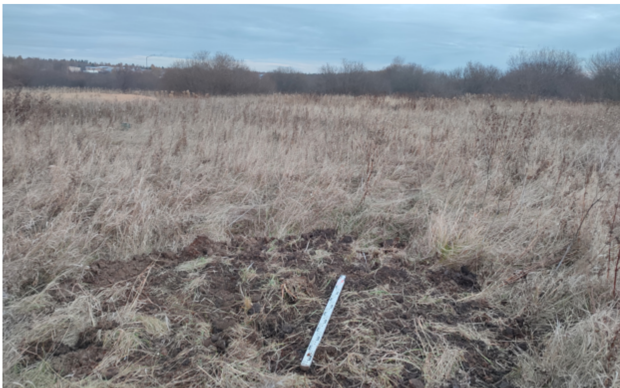
Рис.365. "Газопровод распределительный в пгт Тужа Тужинского муниципального района Кировской области" в пгт Тужа Тужинского муниципального района Кировской области. Шурф 47. Рекультивация. Вид с Ю.
