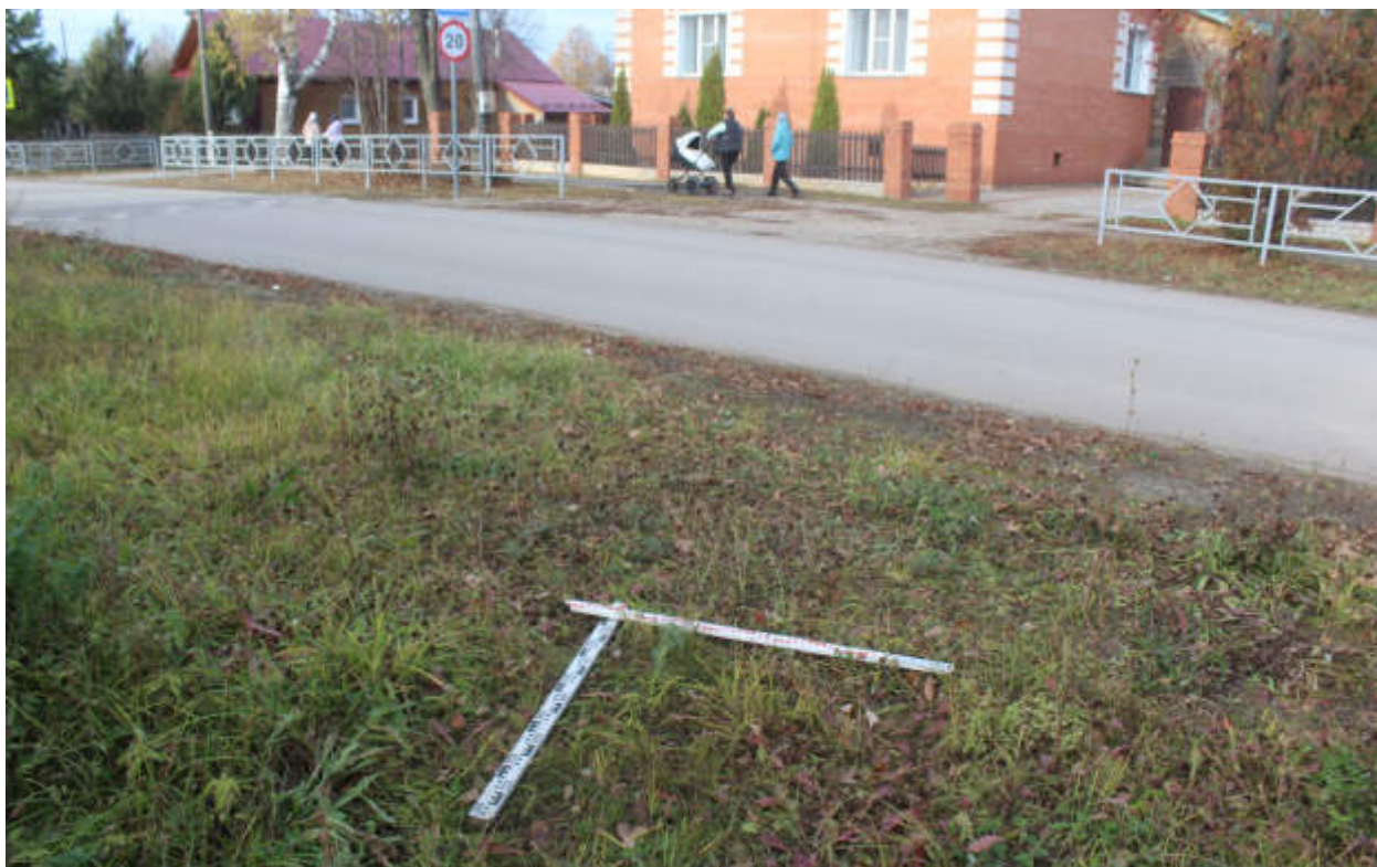
Рис.301. "Газопровод распределительный в пгт Тужа Тужинского муниципального района Кировской области" в пгт Тужа Тужинского муниципального района Кировской области. Шурф 35. Закладка. Вид с Ю.
