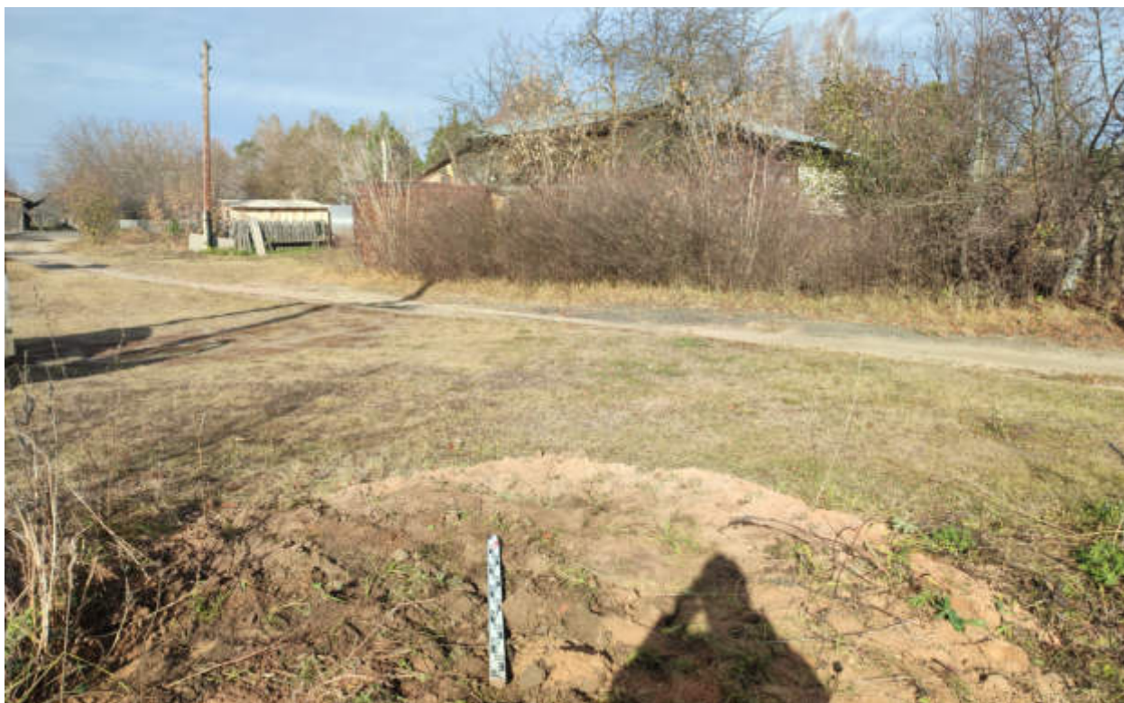
Рис.180. "Газопровод распределительный в пгт Тужа Тужинского муниципального района Кировской области" в пгт Тужа Тужинского муниципального района Кировской области. Шурф 10. Рекультивация. Вид с Ю.
