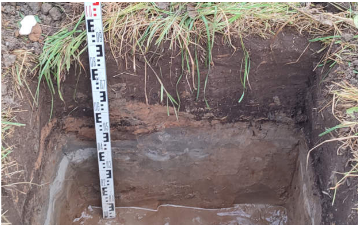
Рис.368. "Газопровод распределительный в пгт Тужа Тужинского муниципального района Кировской области" в пгт Тужа Тужинского муниципального района Кировской области. Шурф 48. Северный борт. Вид с Ю.
