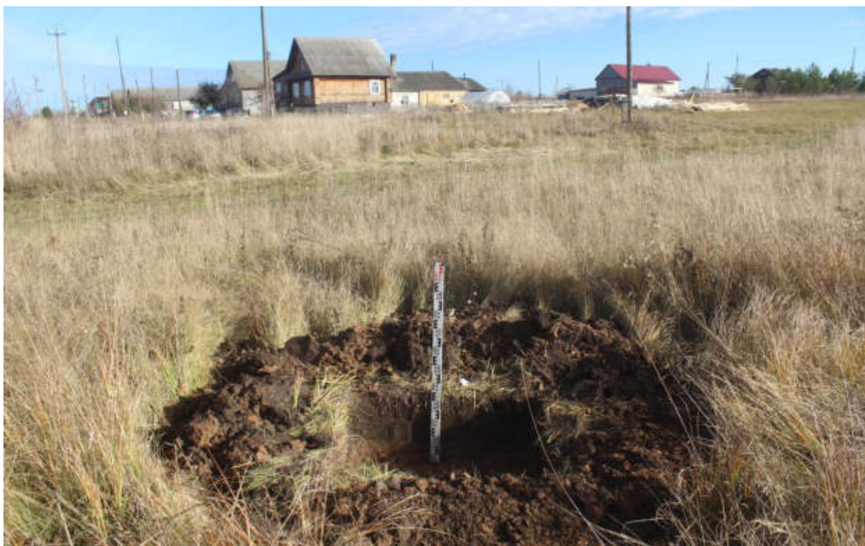
Рис.152. "Газопровод распределительный в пгт Тужа Тужинского муниципального района Кировской области" в пгт Тужа Тужинского муниципального района Кировской области. Шурф 5. Антураж. Вид с Ю.
