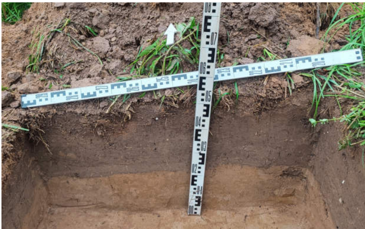
Рис.348. "Газопровод распределительный в пгт Тужа Тужинского муниципального района Кировской области" в пгт Тужа Тужинского муниципального района Кировской области. Шурф 44. Северный борт. Вид с Ю.
