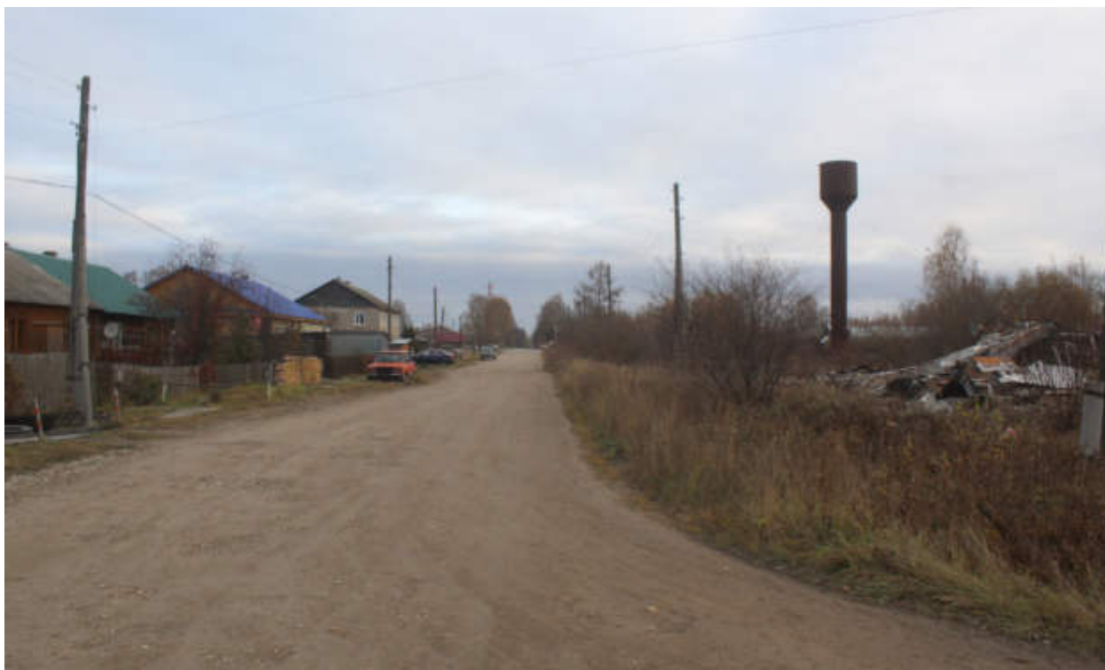
Рис.117. "Газопровод распределительный в пгт Тужа Тужинского муниципального района Кировской области" в пгт Тужа Тужинского муниципального района Кировской области. Рельеф местности и характер растительности участка обследования. Точка фотофиксации 63, вид с ЮЮЗ.
