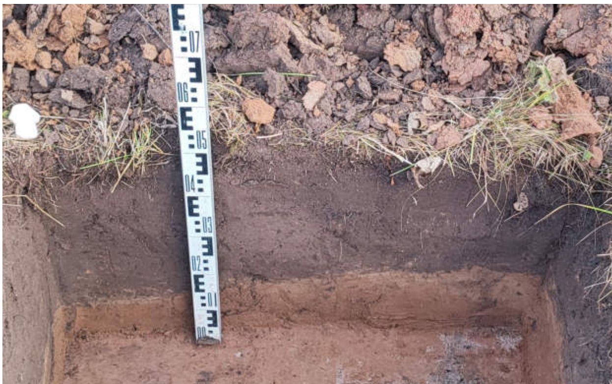
Рис.133. "Газопровод распределительный в пгт Тужа Тужинского муниципального района Кировской области" в пгт Тужа Тужинского муниципального района Кировской области. Шурф 1. Северный борт. Вид с Ю.
