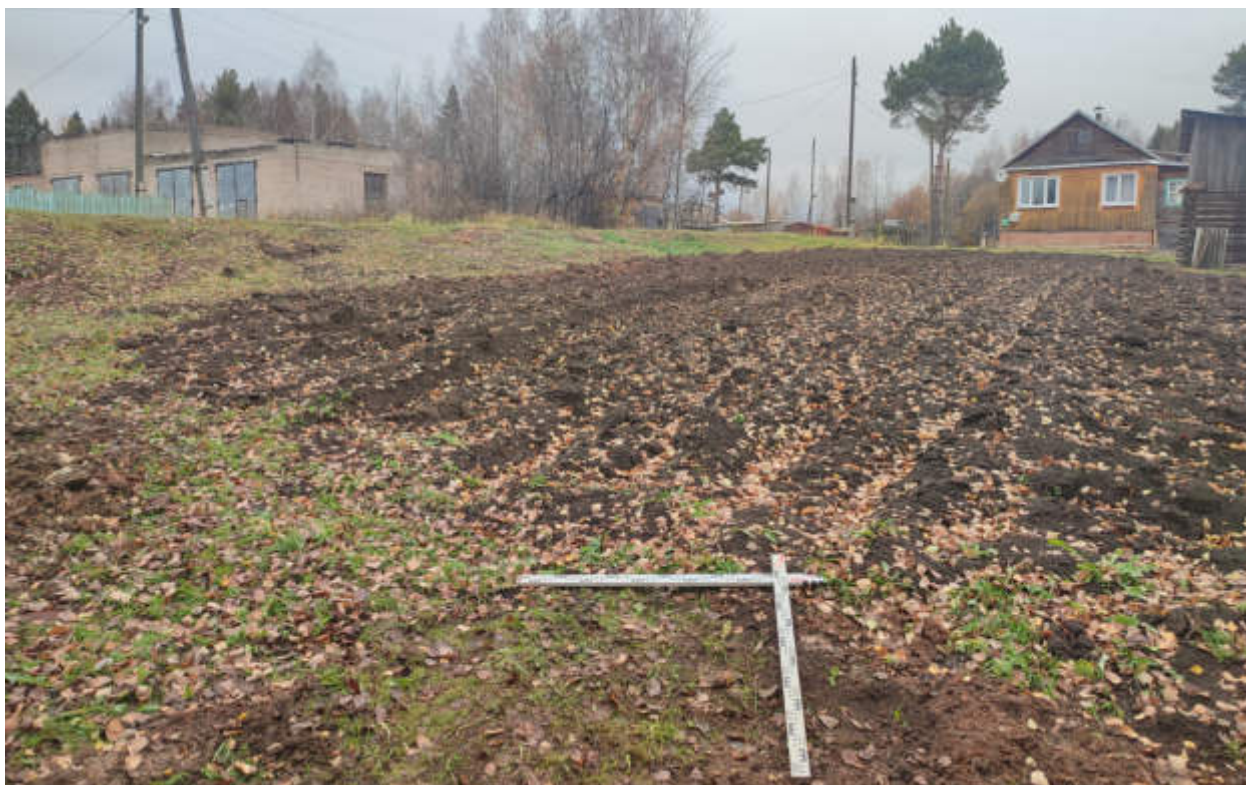
Рис.386. "Газопровод распределительный в пгт Туза Тужинского муниципального района Кировской области" в пгт Туза Тужинского муниципального района Кировской области. Шурф 52. Закладка. Вид с В.
