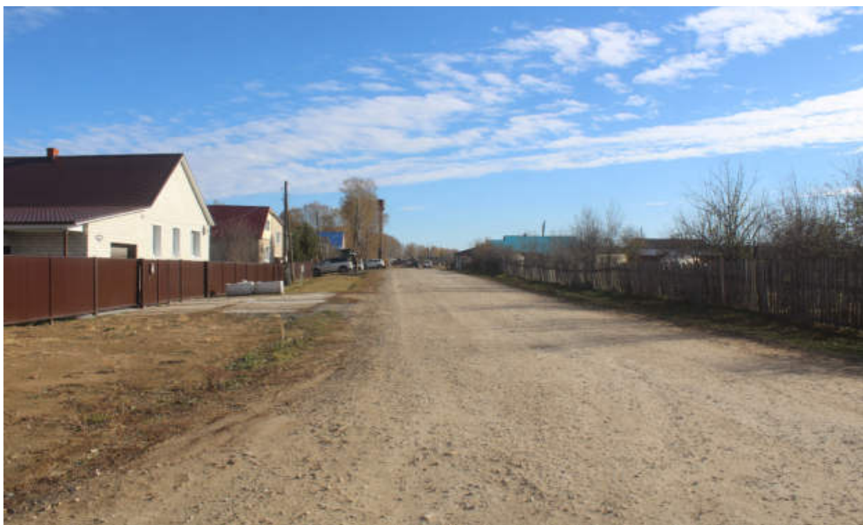
Рис.100. "Газопровод распределительный в пгт Тужа Тужинского муниципального района Кировской области" в пгт Тужа Тужинского муниципального района Кировской области. Рельеф местности и характер растительности участка обследования. Точка фотофиксации 46, вид с ЗСЗ.
