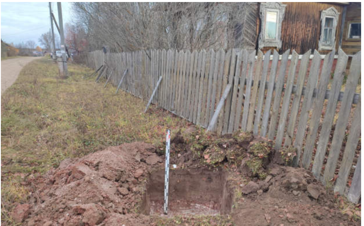
Рис.147. "Газопровод распределительный в пгт Тужа Тужинского муниципального района Кировской области" в пгт Тужа Тужинского муниципального района Кировской области. Шурф 4. Антураж. Вид с Ю.
