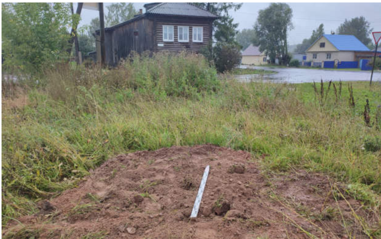
Рис.340. "Газопровод распределительный в пгт Туза Тужинского муниципального района Кировской области" в пгт Туза Тужинского муниципального района Кировской области. Шурф 42. Рекультивация. Вид с Ю.
