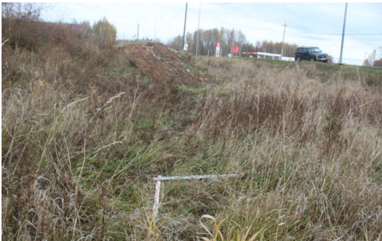
Рис.216. "Газопровод распределительный в пгт Тужа Тужинского муниципального района Кировской области" в пгт Тужа Тужинского муниципального района Кировской области. Шурф 18. Закладка. Вид с Ю.
