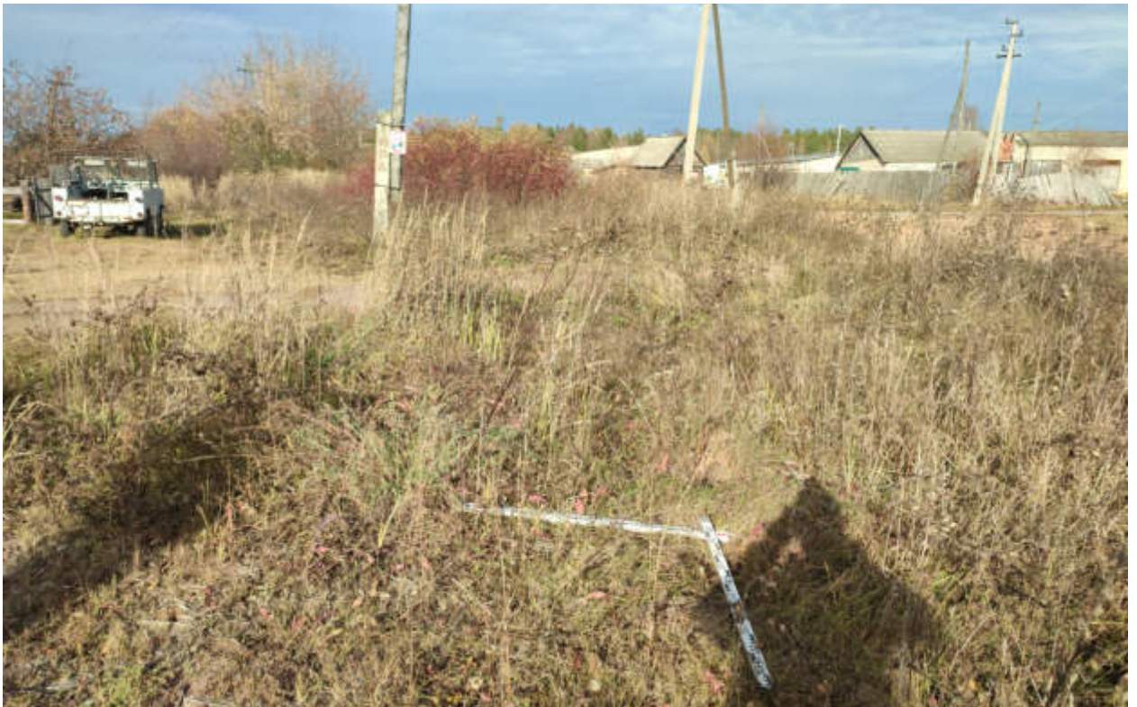
Рис.191. "Газопровод распределительный в пгт Тужа Тужинского муниципального района Кировской области" в пгт Тужа Тужинского муниципального района Кировской области. Шурф 13. Закладка. Вид с Ю.
