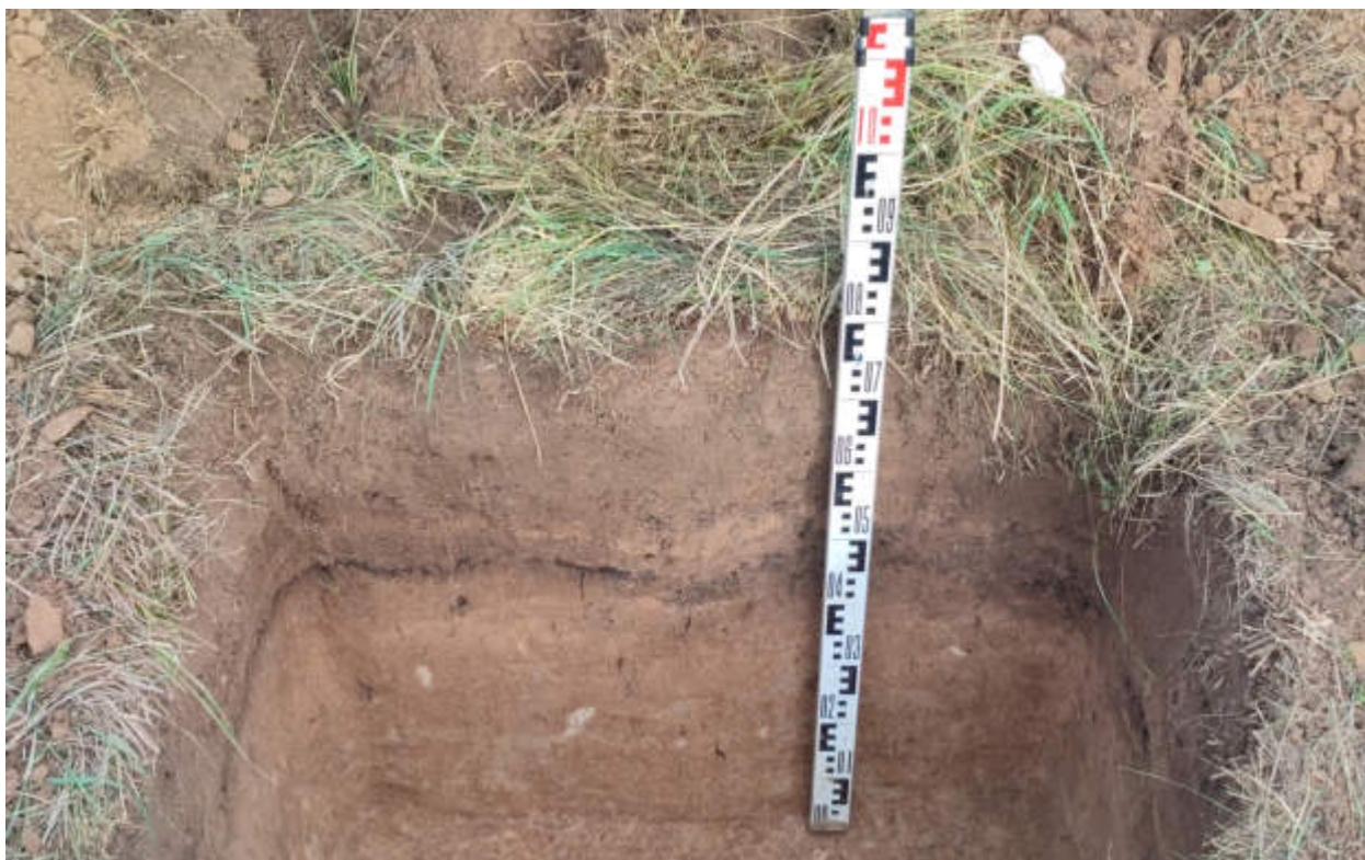
Рис.273. "Газопровод распределительный в пгт Тужа Тужинского муниципального района Кировской области" в пгт Тужа Тужинского муниципального района Кировской области. Шурф 29. Северный борт. Вид с Ю.
