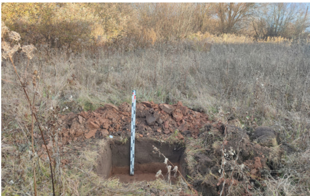
Рис.132. "Газопровод распределительный в пгт Тужа Тужинского муниципального района Кировской области" в пгт Тужа Тужинского муниципального района Кировской области. Шурф 1. Антураж. Вид с Ю.
