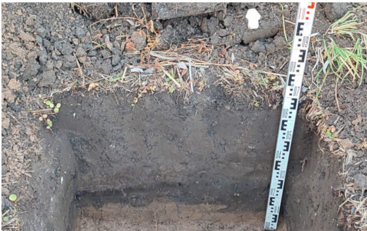
Рис.223. "Газопровод распределительный в пгт Тужа Тужинского муниципального района Кировской области" в пгт Тужа Тужинского муниципального района Кировской области. Шурф 19. Северный борт. Вид с Ю.
