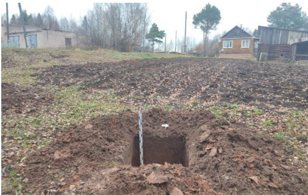
Рис.387. "Газопровод распределительный в пгт Туза Тужинского муниципального района Кировской области" в пгт Туза Тужинского муниципального района Кировской области. Шурф 52. Антураж. Вид с В.
