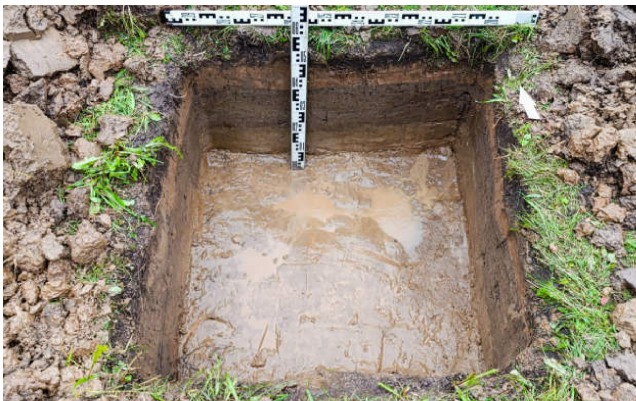
Рис.354. "Газопровод распределительный в пгт Тужа Тужинского муниципального района Кировской области" в пгт Тужа Тужинского муниципального района Кировской области. Шурф 45. Материк. Вид с Ю.
