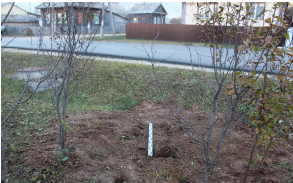
Рис.260. "Газопровод распределительный в пгт Тужа Тужинского муниципального района Кировской области" в пгт Тужа Тужинского муниципального района Кировской области. Шурф 26. Рекультивация. Вид с Ю.
