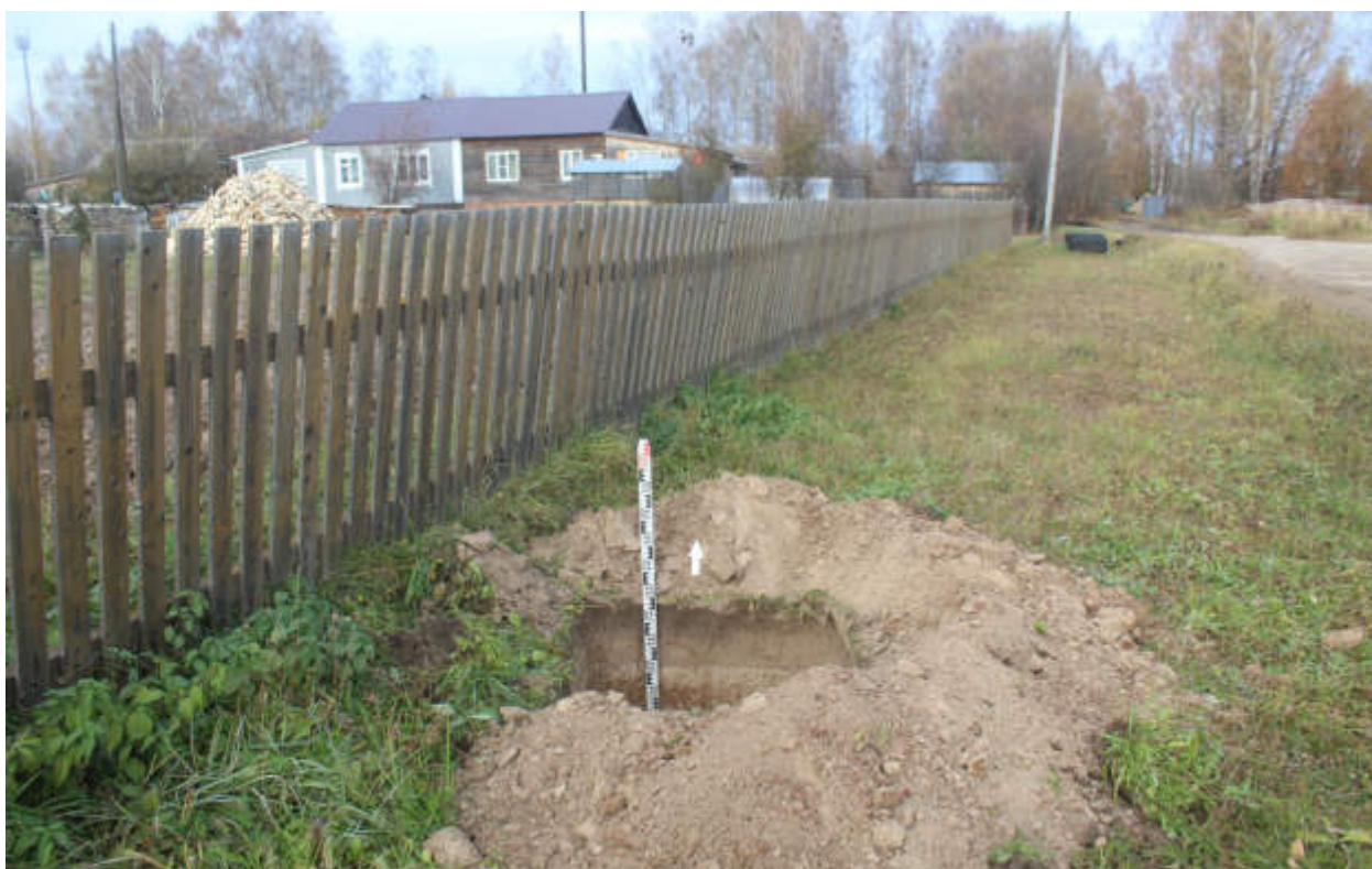
Рис.227. "Газопровод распределительный в пгт Туза Тужинского муниципального района Кировской области" в пгт Туза Тужинского муниципального района Кировской области. Шурф 20. Антураж. Вид с Ю.
