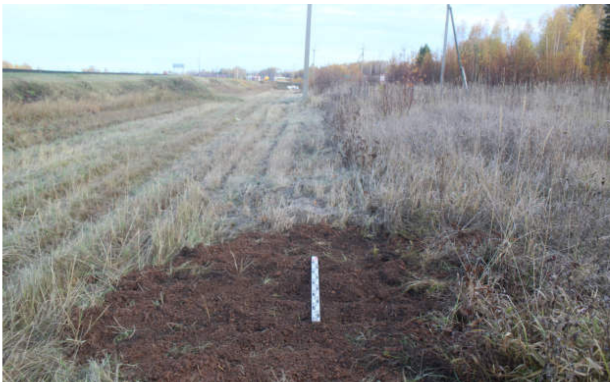
Рис.380. "Газопровод распределительный в пгт Тужа Тужинского муниципального района Кировской области" в пгт Тужа Тужинского муниципального района Кировской области. Шурф 50. Рекультивация. Вид с Ю.
