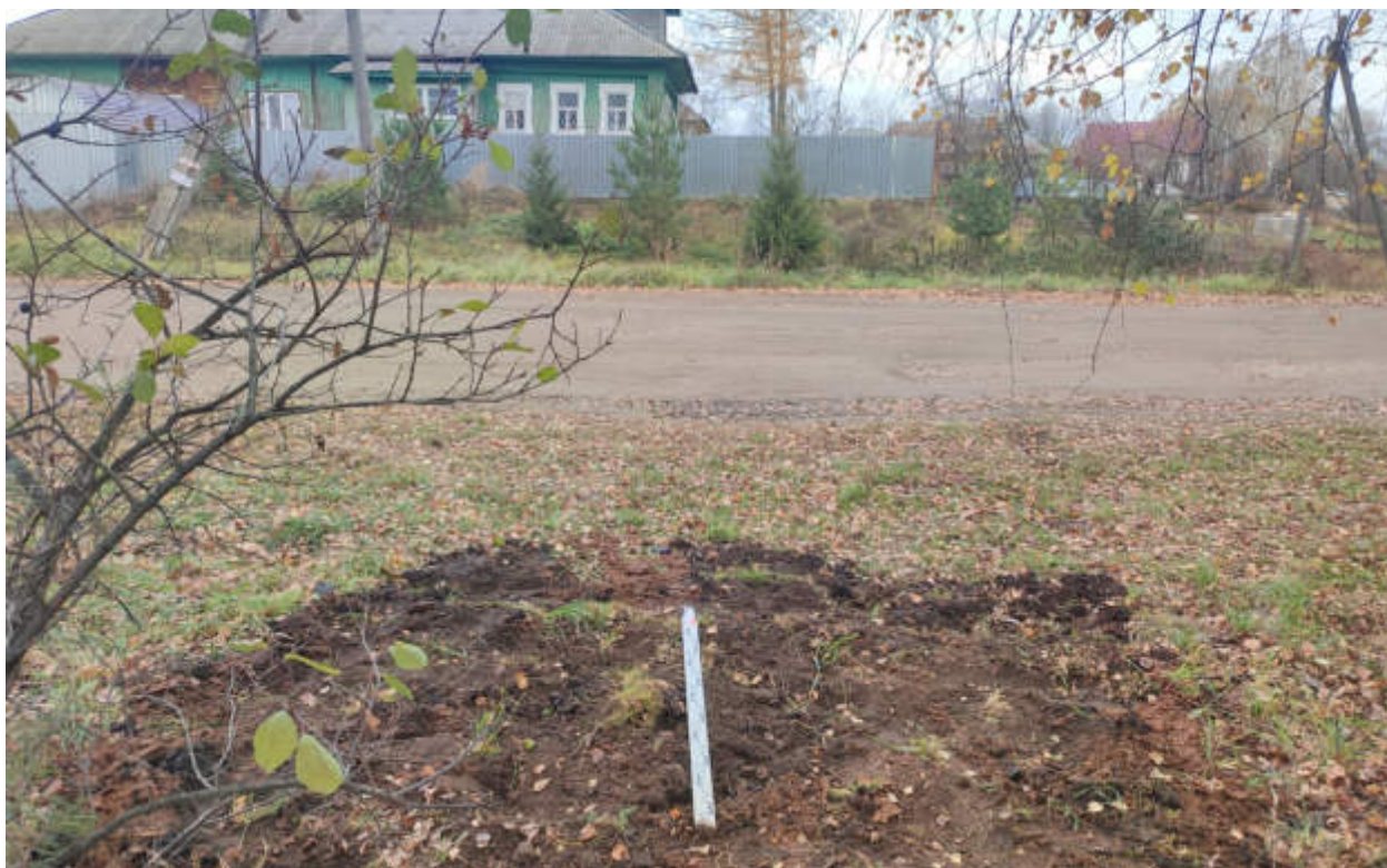
Рис.250. "Газопровод распределительный в пгт Тужа Тужинского муниципального района Кировской области" в пгт Тужа Тужинского муниципального района Кировской области. Шурф 24. Рекультивация. Вид с Ю.
