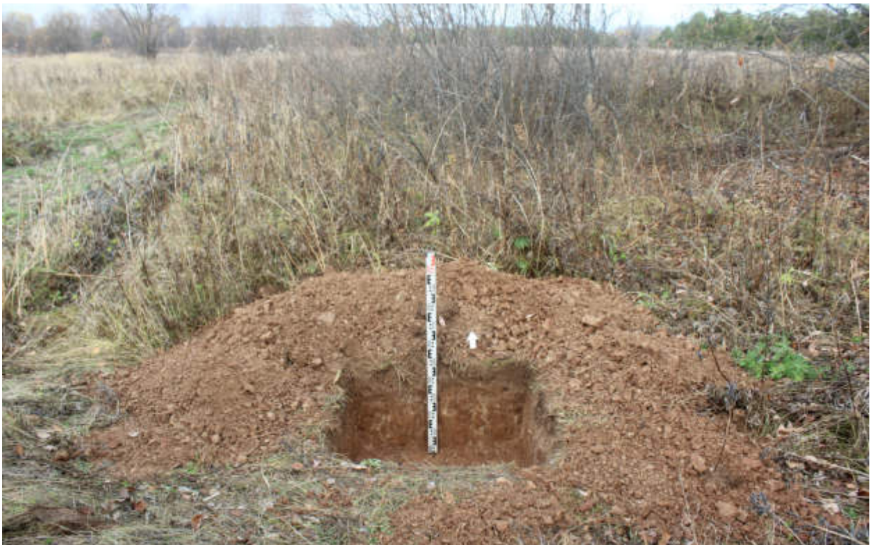
Рис.267. "Газопровод распределительный в пгт Тужа Тужинского муниципального района Кировской области" в пгт Тужа Тужинского муниципального района Кировской области. Шурф 28. Антураж. Вид с Ю.
