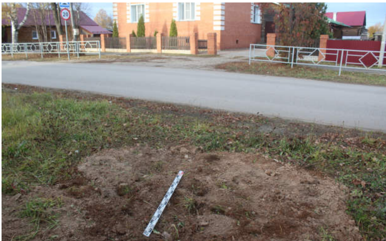
Рис.305. "Газопровод распределительный в пгт Тужа Тужинского муниципального района Кировской области" в пгт Тужа Тужинского муниципального района Кировской области. Шурф 35. Рекультивация. Вид с Ю.
