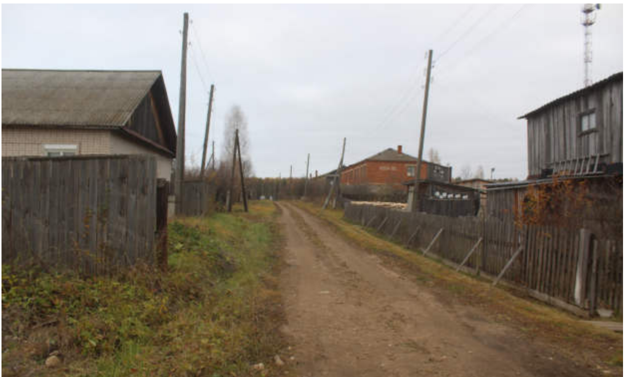
Рис.58. "Газопровод распределительный в пгт Тужа Тужинского муниципального района Кировской области" в пгт Тужа Тужинского муниципального района Кировской области. Рельеф местности и характер растительности участка обследования. Точка фотофиксации 4, вид с ВСВ.
