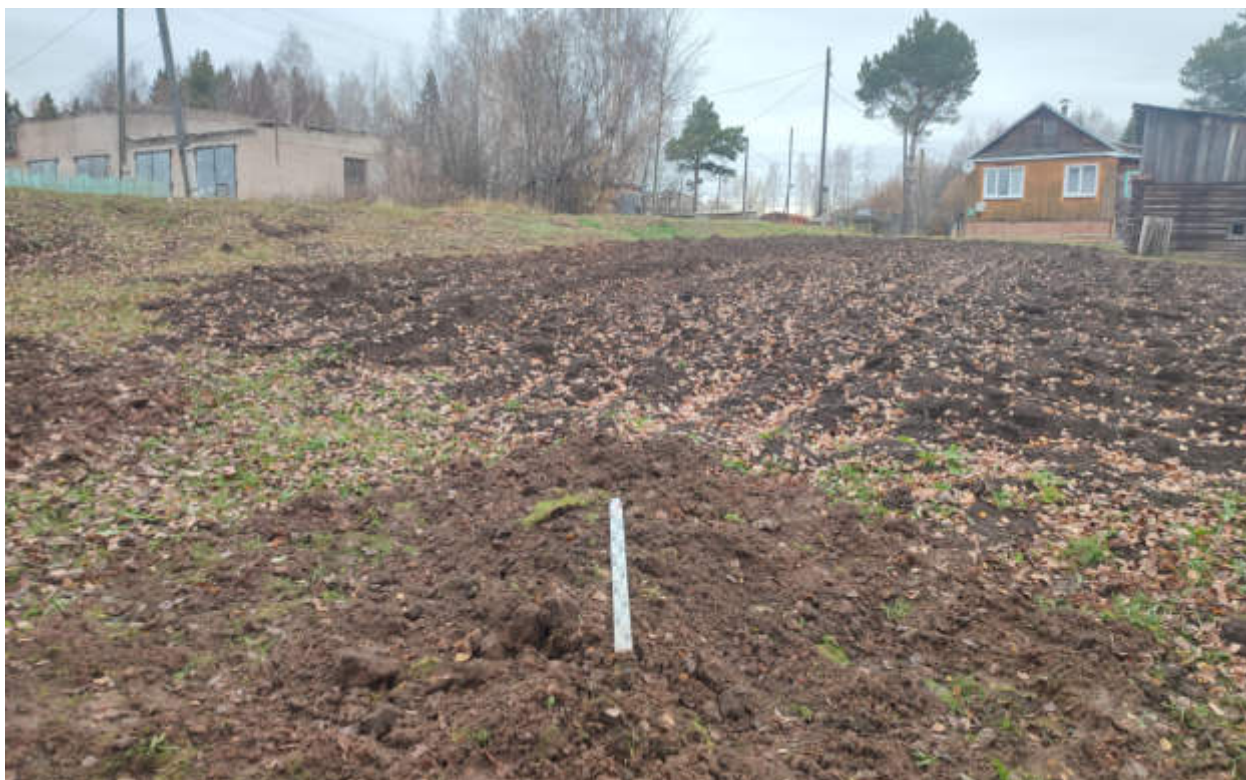
Рис.390. "Газопровод распределительный в пгт Тужа Тужинского муниципального района Кировской области" в пгт Тужа Тужинского муниципального района Кировской области. Шурф 52. Рекультивация. Вид с В.
