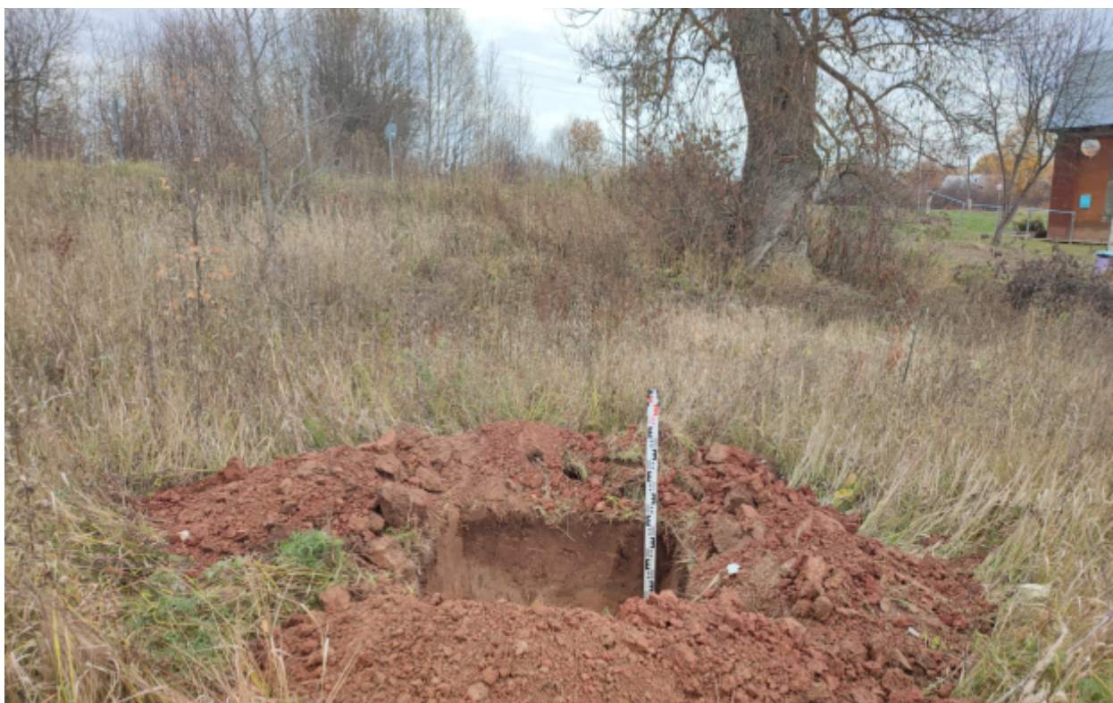
Рис.172. "Газопровод распределительный в пгт Тужа Тужинского муниципального района Кировской области" в пгт Тужа Тужинского муниципального района Кировской области. Шурф 9. Антураж. Вид с Ю.
