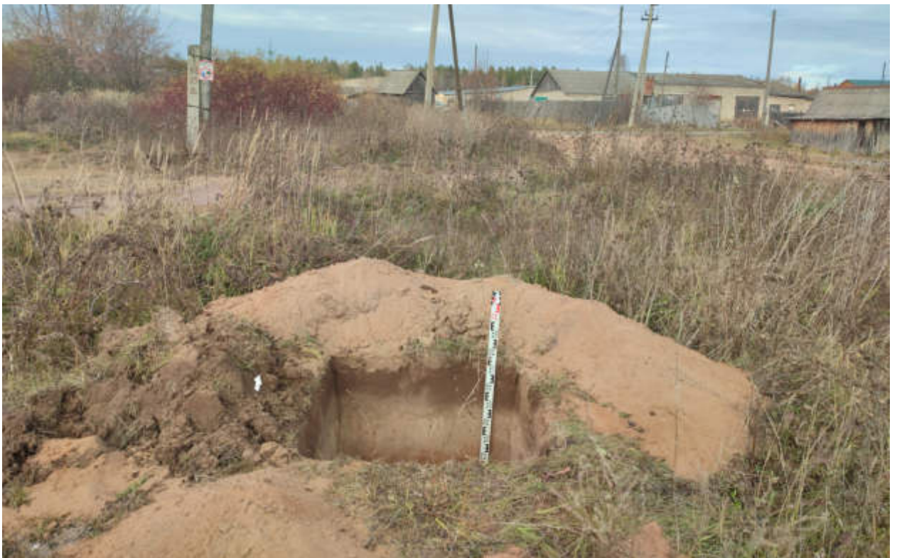
Рис.192. "Газопровод распределительный в пгт Тужа Тужинского муниципального района Кировской области" в пгт Тужа Тужинского муниципального района Кировской области. Шурф 13. Антураж. Вид с Ю.
