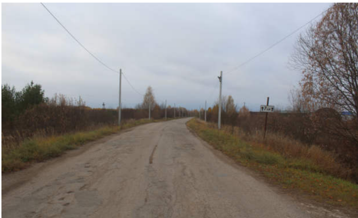
Рис.118. "Газопровод распределительный в пгт Тужа Тужинского муниципального района Кировской области" в пгт Тужа Тужинского муниципального района Кировской области. Рельеф местности и характер растительности участка обследования. Точка фотофиксации 64, вид с СВ.
