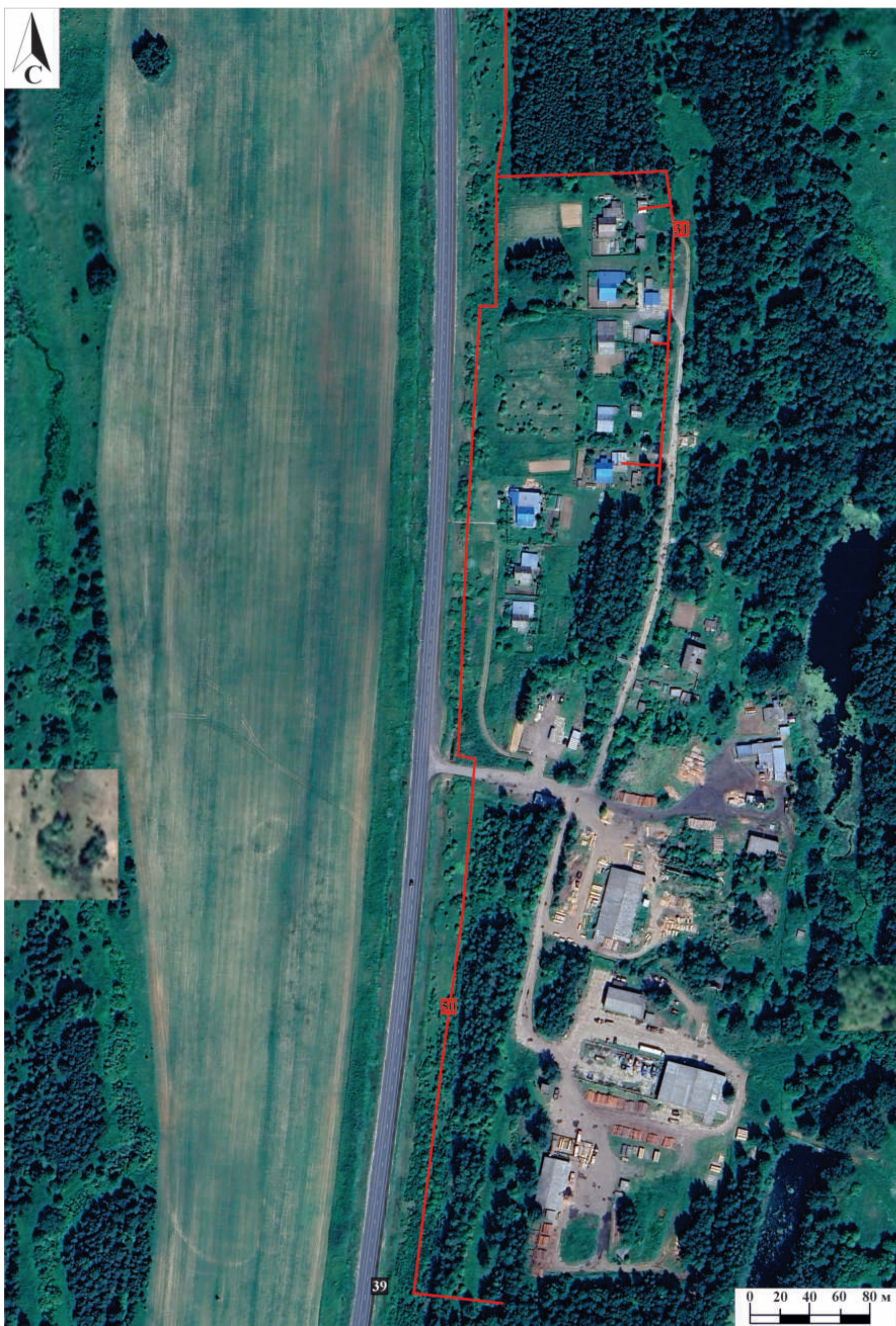
Рис.54. "Газопровод распределительный в пгт Туза Тужинского муниципального района Кировской области" в пгт Туза Тужинского муниципального района Кировской области. Обследованная территория на спутниковом снимке (сервис Google Планета Земля) с указанием точек фотофиксации и местоположения разведочных шурфов (23). Дата обращения: 10.09.2025 г. Дата снимка: июль, 2025 г.
