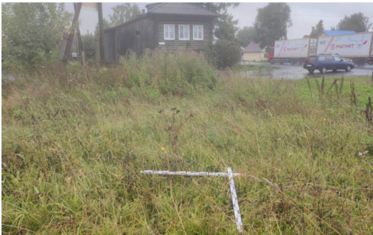
Рис.336. "Газопровод распределительный в пгт Тужа Тужинского муниципального района Кировской области" в пгт Тужа Тужинского муниципального района Кировской области. Шурф 42. Закладка. Вид с Ю.
