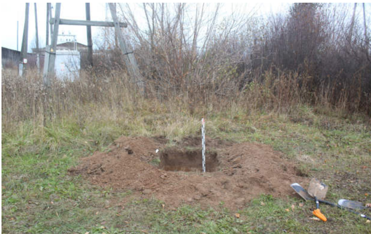
Рис.287. "Газопровод распределительный в пгт Тужа Тужинского муниципального района Кировской области" в пгт Тужа Тужинского муниципального района Кировской области. Шурф 32. Антураж. Вид с Ю.
