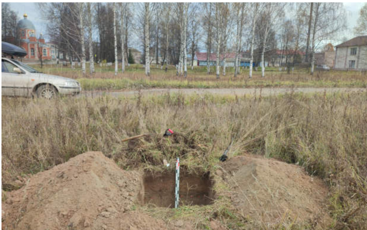
Рис.372. "Газопровод распределительный в пгт Тужа Тужинского муниципального района Кировской области" в пгт Тужа Тужинского муниципального района Кировской области. Шурф 49. Антураж. Вид с Ю.
