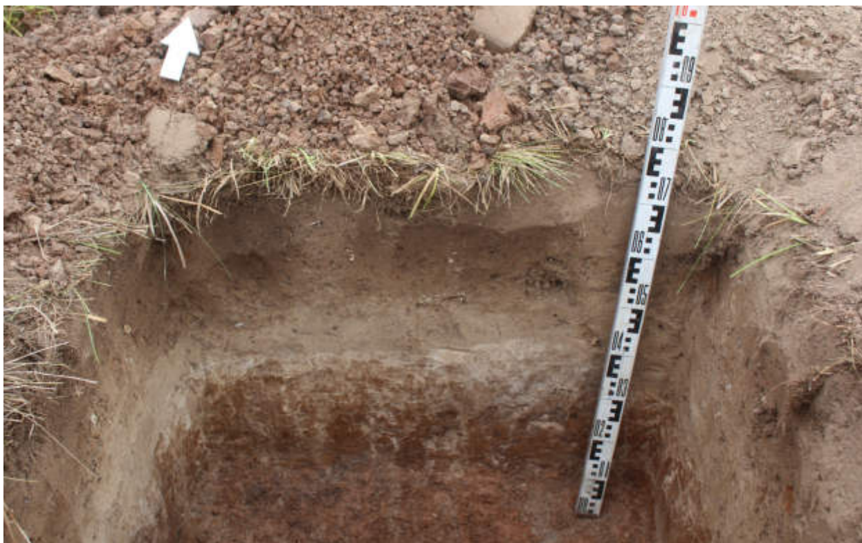
Рис.293. "Газопровод распределительный в пгт Тужа Тужинского муниципального района Кировской области" в пгт Тужа Тужинского муниципального района Кировской области. Шурф 33. Северный борт. Вид с Ю.
