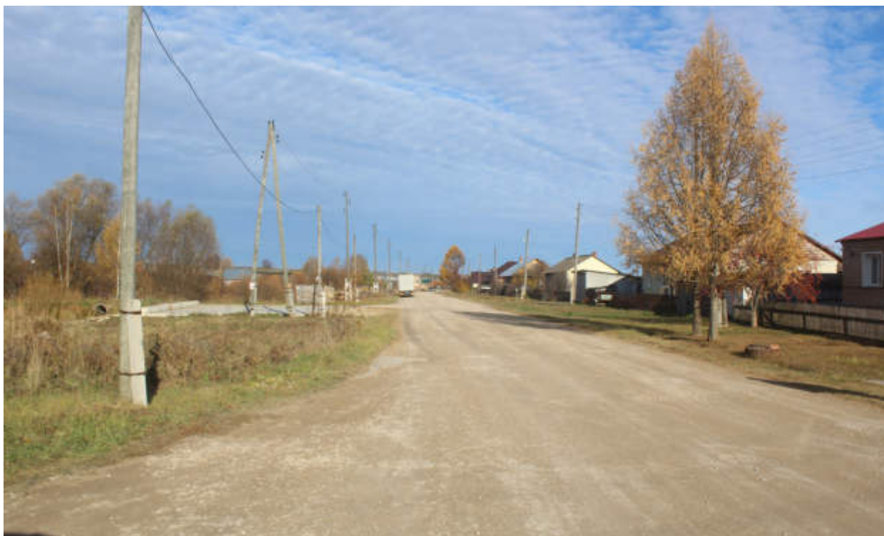
Рис.101. "Газопровод распределительный в пгт Тужа Тужинского муниципального района Кировской области" в пгт Тужа Тужинского муниципального района Кировской области. Рельеф местности и характер растительности участка обследования. Точка фотофиксации 47, вид с ЮЮЗ.
