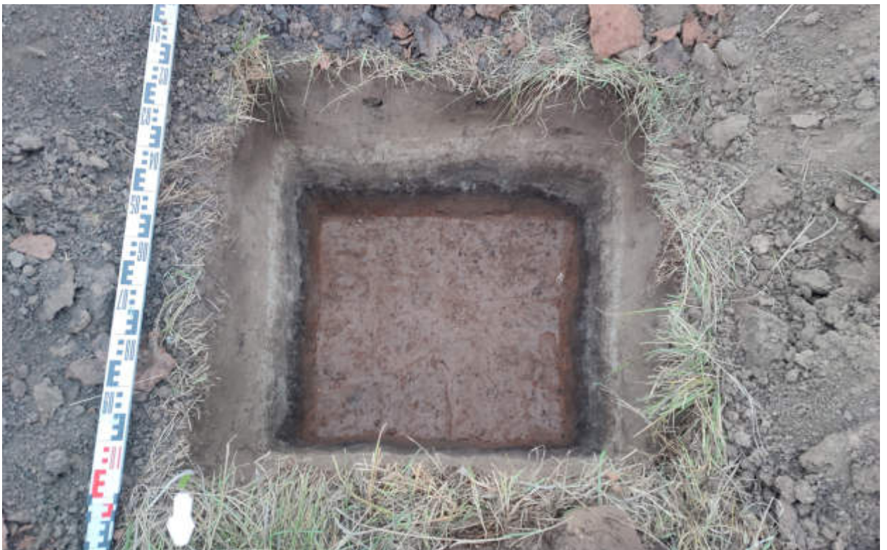
Рис.214. "Газопровод распределительный в пгт Тужа Тужинского муниципального района Кировской области" в пгт Тужа Тужинского муниципального района Кировской области. Шурф 17. Материк. Вид с С.
