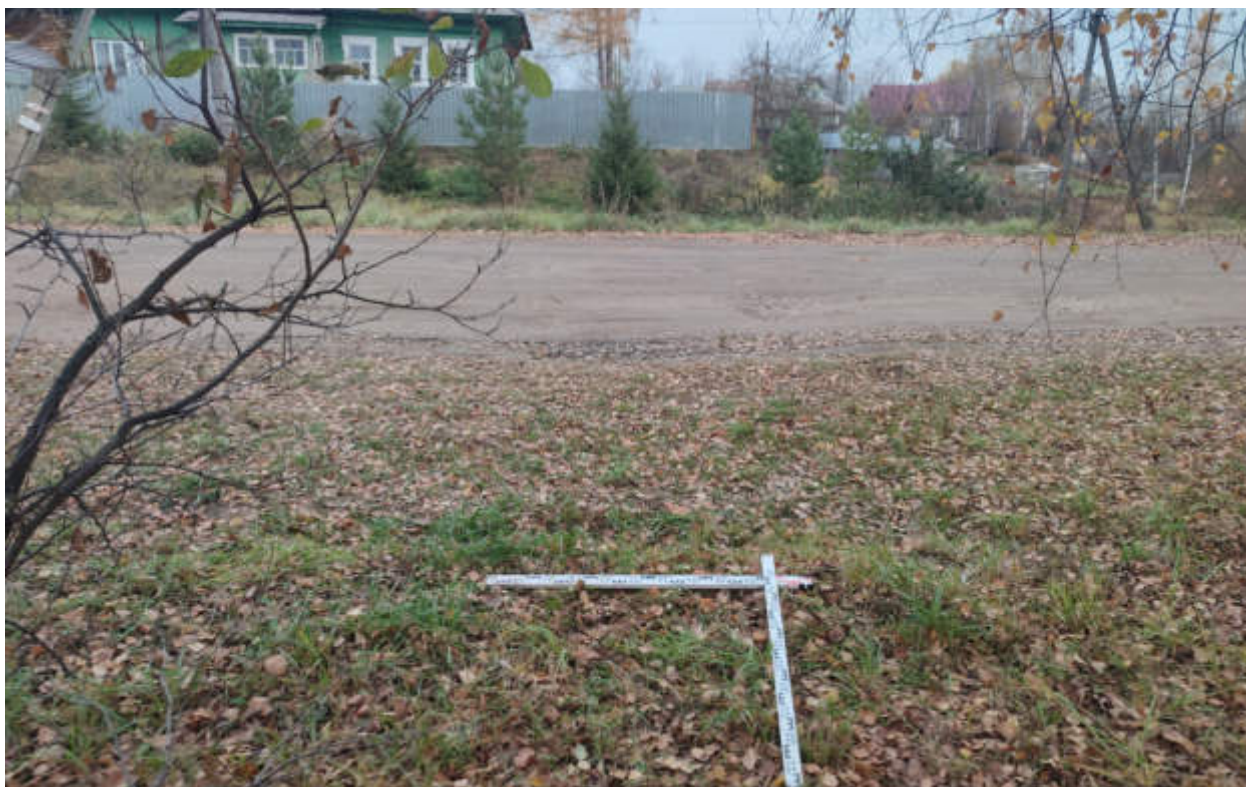
Рис.246. "Газопровод распределительный в пгт Туза Тужинского муниципального района Кировской области" в пгт Туза Тужинского муниципального района Кировской области. Шурф 24. Закладка. Вид с Ю.
