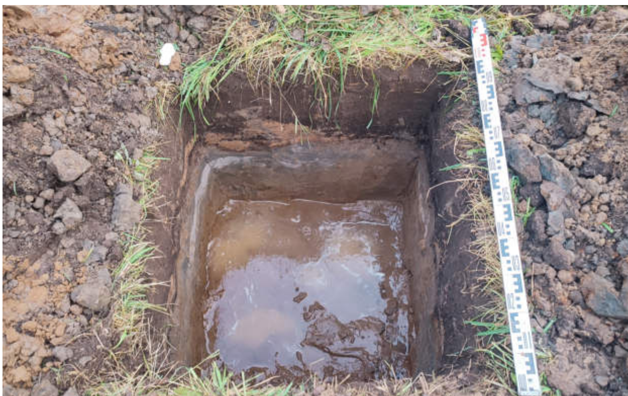
Рис.369. "Газопровод распределительный в пгт Тужа Тужинского муниципального района Кировской области" в пгт Тужа Тужинского муниципального района Кировской области. Шурф 48. Материк. Вид с Ю.
