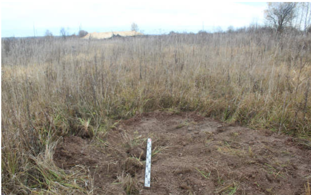
Рис.295. "Газопровод распределительный в пгт Тужа Тужинского муниципального района Кировской области" в пгт Тужа Тужинского муниципального района Кировской области. Шурф 33. Рекультивация. Вид с Ю.
