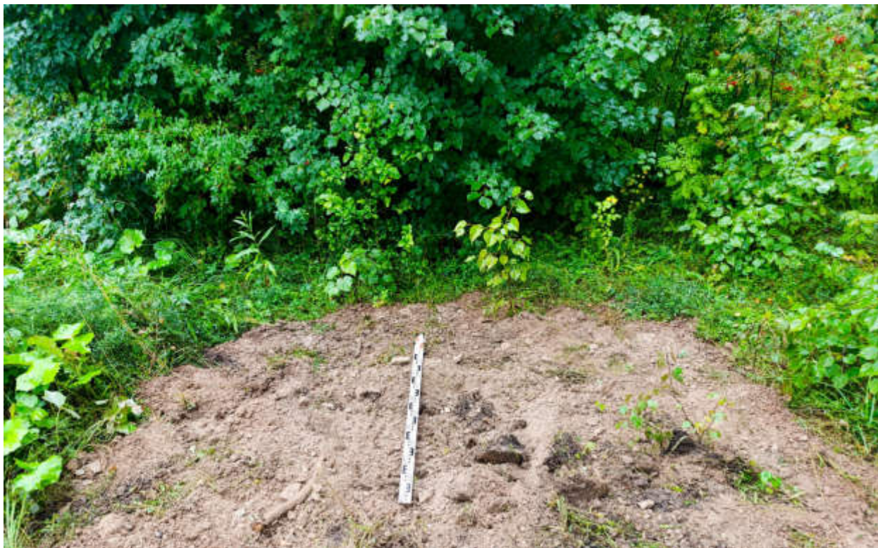
Рис.345. "Газопровод распределительный в пгт Тужа Тужинского муниципального района Кировской области" в пгт Тужа Тужинского муниципального района Кировской области. Шурф 43. Рекультивация. Вид с Ю.
