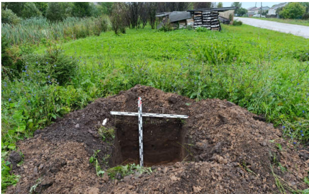
Рис.317. "Газопровод распределительный в пгт Тужа Тужинского муниципального района Кировской области" в пгт Тужа Тужинского муниципального района Кировской области. Шурф 38. Антураж. Вид с Ю.
