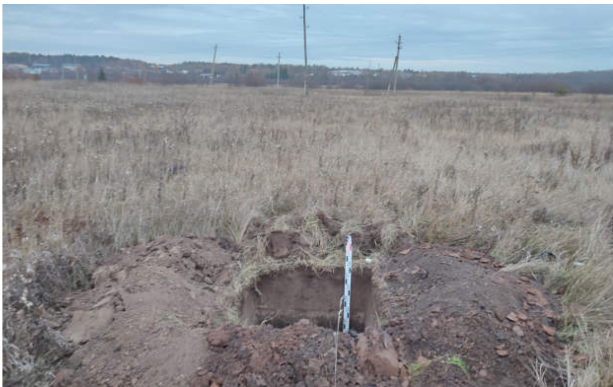
Рис.212. "Газопровод распределительный в пгт Тужа Тужинского муниципального района Кировской области" в пгт Тужа Тужинского муниципального района Кировской области. Шурф 17. Антураж. Вид с Ю.
