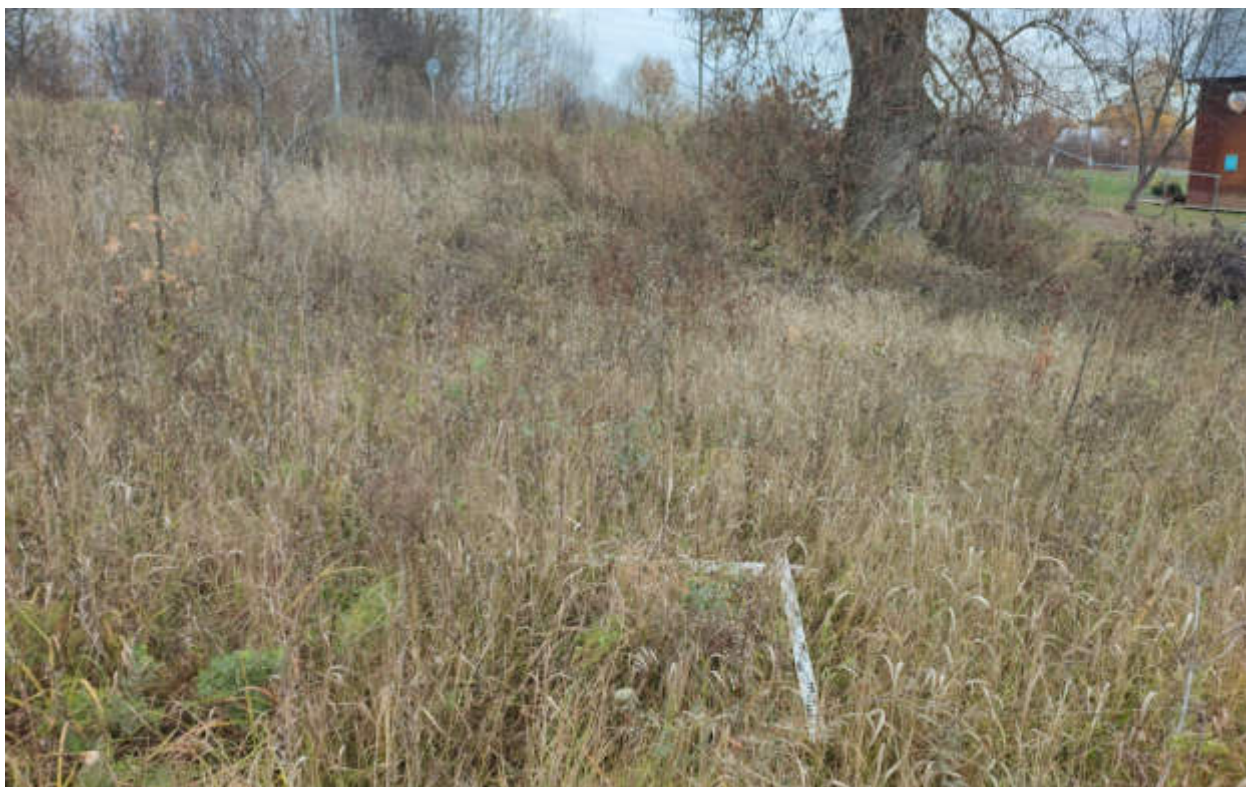
Рис.171. "Газопровод распределительный в пгт Тужа Тужинского муниципального района Кировской области" в пгт Тужа Тужинского муниципального района Кировской области. Шурф 9. Закладка. Вид с Ю.
