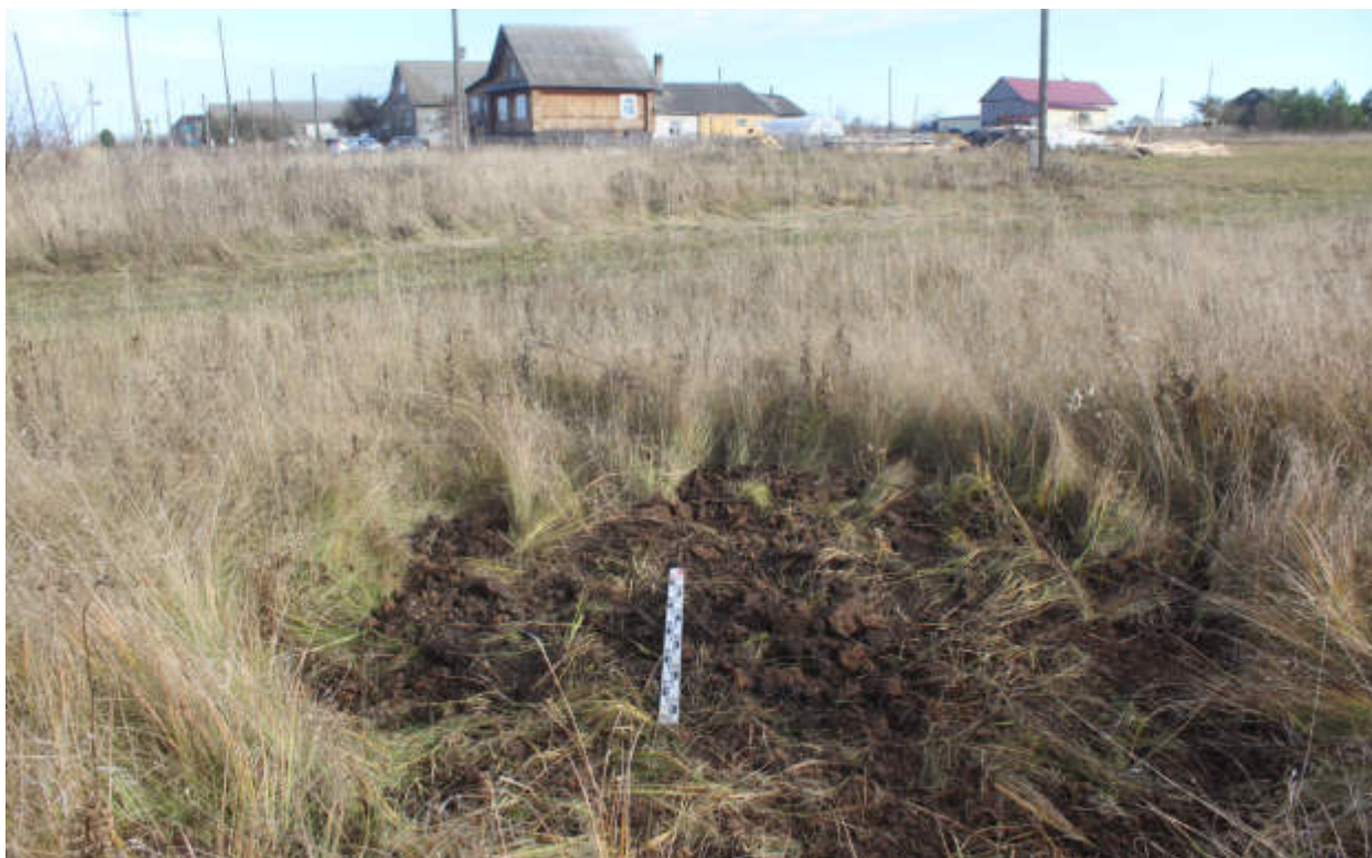
Рис.155. "Газопровод распределительный в пгт Тужа Тужинского муниципального района Кировской области" в пгт Тужа Тужинского муниципального района Кировской области. Шурф 5. Рекультивация. Вид с Ю.
