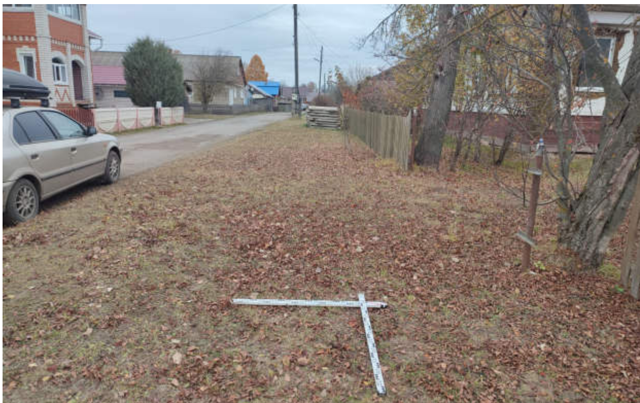
Рис.251. "Газопровод распределительный в пгт Туза Тужинского муниципального района Кировской области" в пгт Туза Тужинского муниципального района Кировской области. Шурф 25. Закладка. Вид с Ю.
