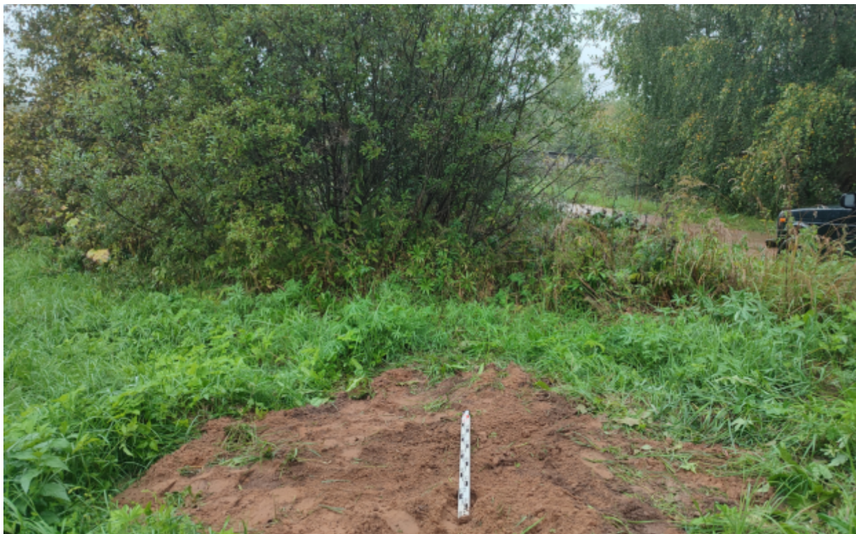
Рис.350. "Газопровод распределительный в пгт Тужа Тужинского муниципального района Кировской области" в пгт Тужа Тужинского муниципального района Кировской области. Шурф 44. Рекультивация. Вид с Ю.
