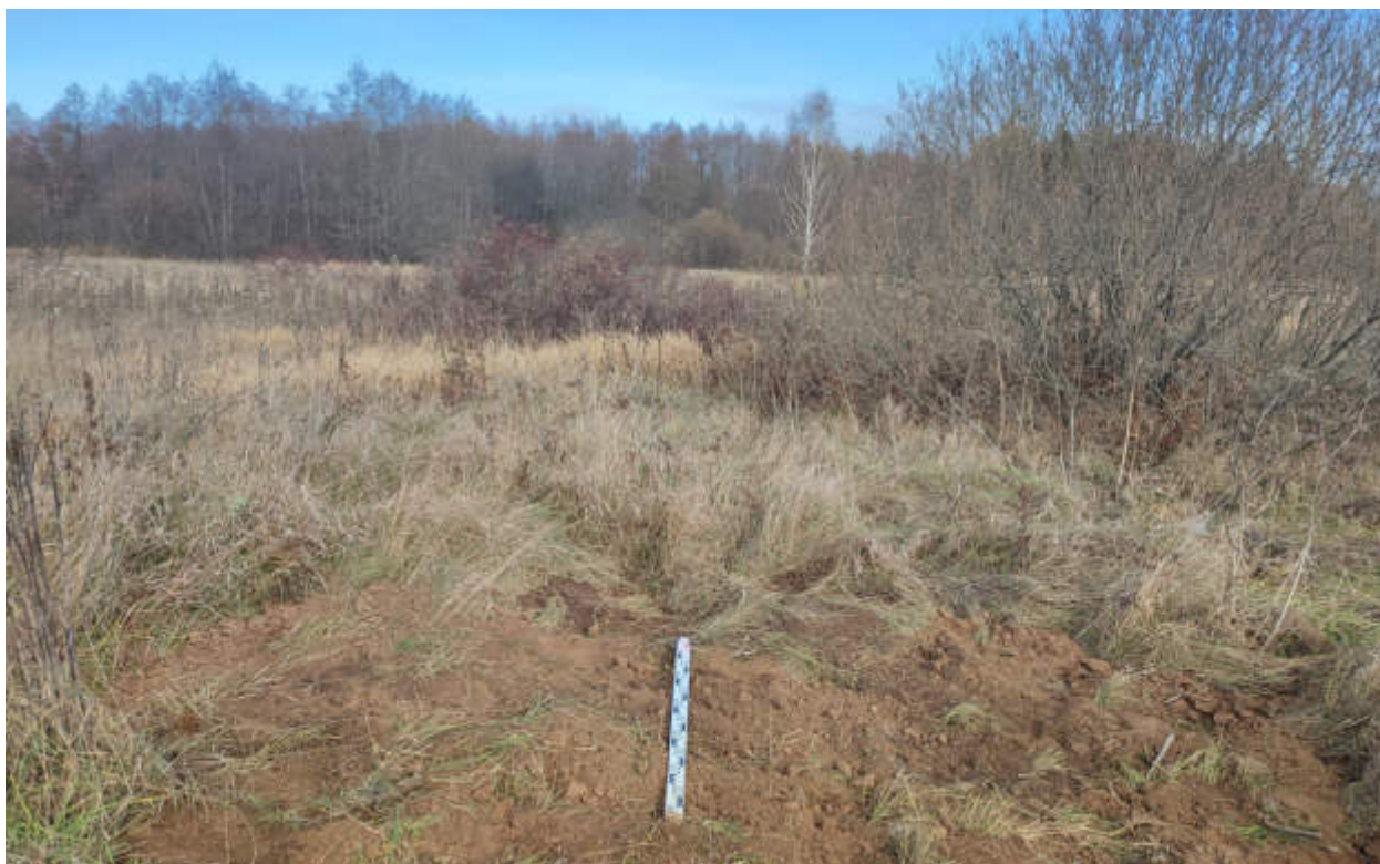
Рис.275. "Газопровод распределительный в пгт Тужа Тужинского муниципального района Кировской области" в пгт Тужа Тужинского муниципального района Кировской области. Шурф 29. Рекультивация. Вид с Ю.
