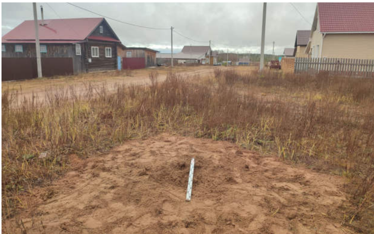
Рис.395. "Газопровод распределительный в пгт Тужа Тужинского муниципального района Кировской области" в пгт Тужа Тужинского муниципального района Кировской области. Шурф 53. Рекультивация. Вид с Ю.
