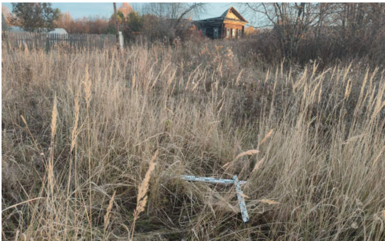
Рис.141. "Газопровод распределительный в пгт Тужа Тужинского муниципального района Кировской области" в пгт Тужа Тужинского муниципального района Кировской области. Шурф 3. Закладка. Вид с Ю.
