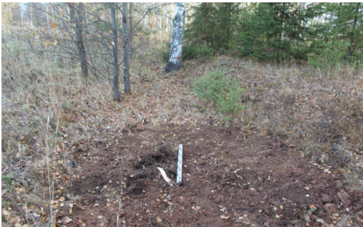
Рис.285. "Газопровод распределительный в пгт Тужа Тужинского муниципального района Кировской области" в пгт Тужа Тужинского муниципального района Кировской области. Шурф 31. Рекультивация. Вид с Ю.
