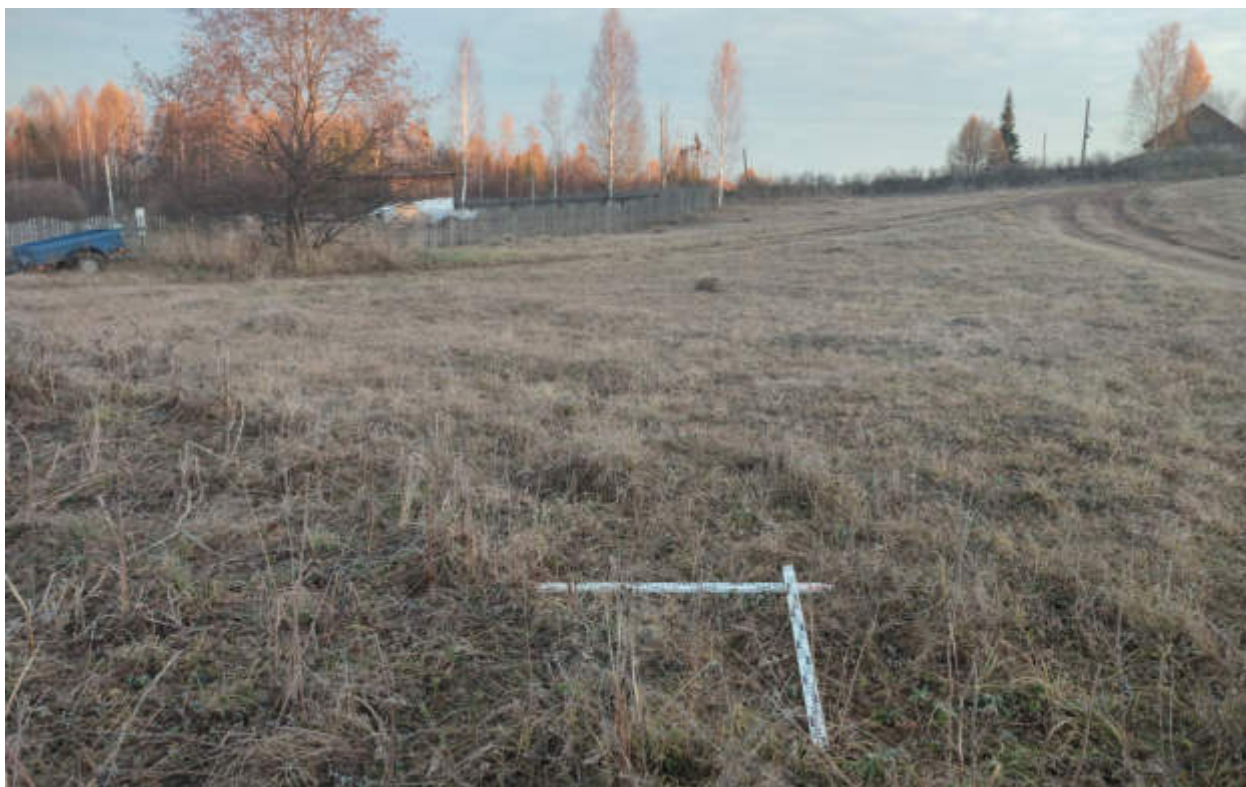
Рис.136. "Газопровод распределительный в пгт Тужа Тужинского муниципального района Кировской области" в пгт Тужа Тужинского муниципального района Кировской области. Шурф 2. Закладка. Вид с Ю.
