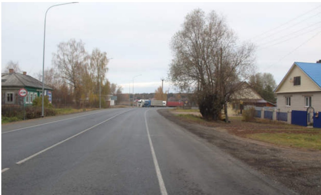
Рис.107. "Газопровод распределительный в пгт Тужа Тужинского муниципального района Кировской области" в пгт Тужа Тужинского муниципального района Кировской области. Рельеф местности и характер растительности участка обследования. Точка фотофиксации 53, вид с ЮЮВ.
