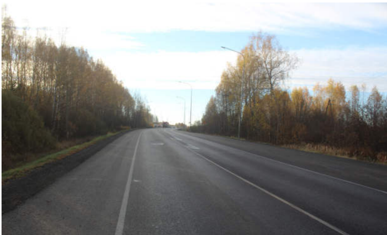
Рис.95. "Газопровод распределительный в пгт Тужа Тужинского муниципального района Кировской области" в пгт Тужа Тужинского муниципального района Кировской области. Рельеф местности и характер растительности участка обследования. Точка фотофиксации 41, вид с ССЗ.
