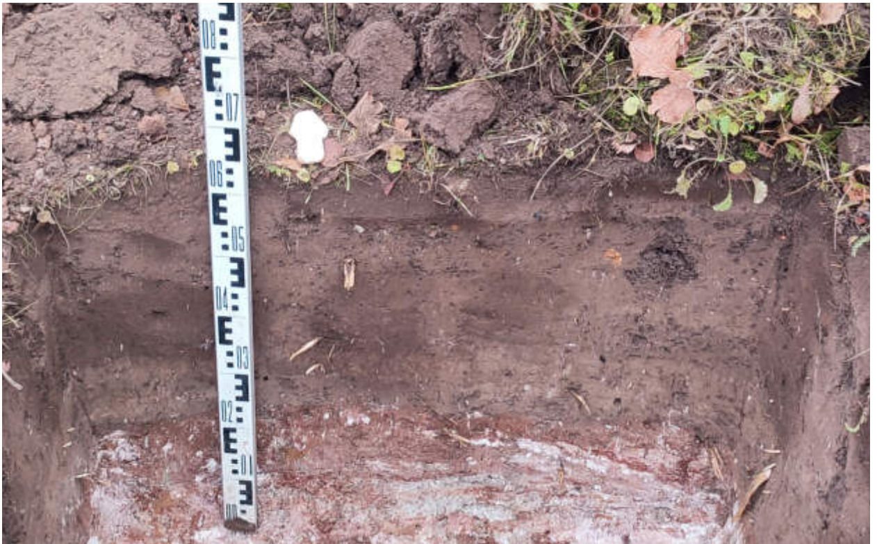
Рис.148. "Газопровод распределительный в пгт Тужа Тужинского муниципального района Кировской области" в пгт Тужа Тужинского муниципального района Кировской области. Шурф 4. Северный борт. Вид с Ю.
