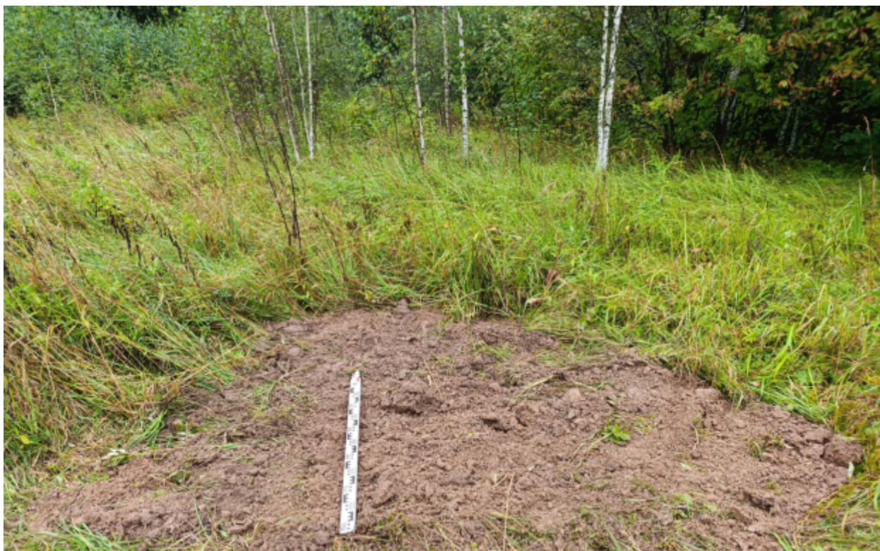
Рис.325. "Газопровод распределительный в пгт Тужа Тужинского муниципального района Кировской области" в пгт Тужа Тужинского муниципального района Кировской области. Шурф 39. Рекультивация. Вид с Ю.
