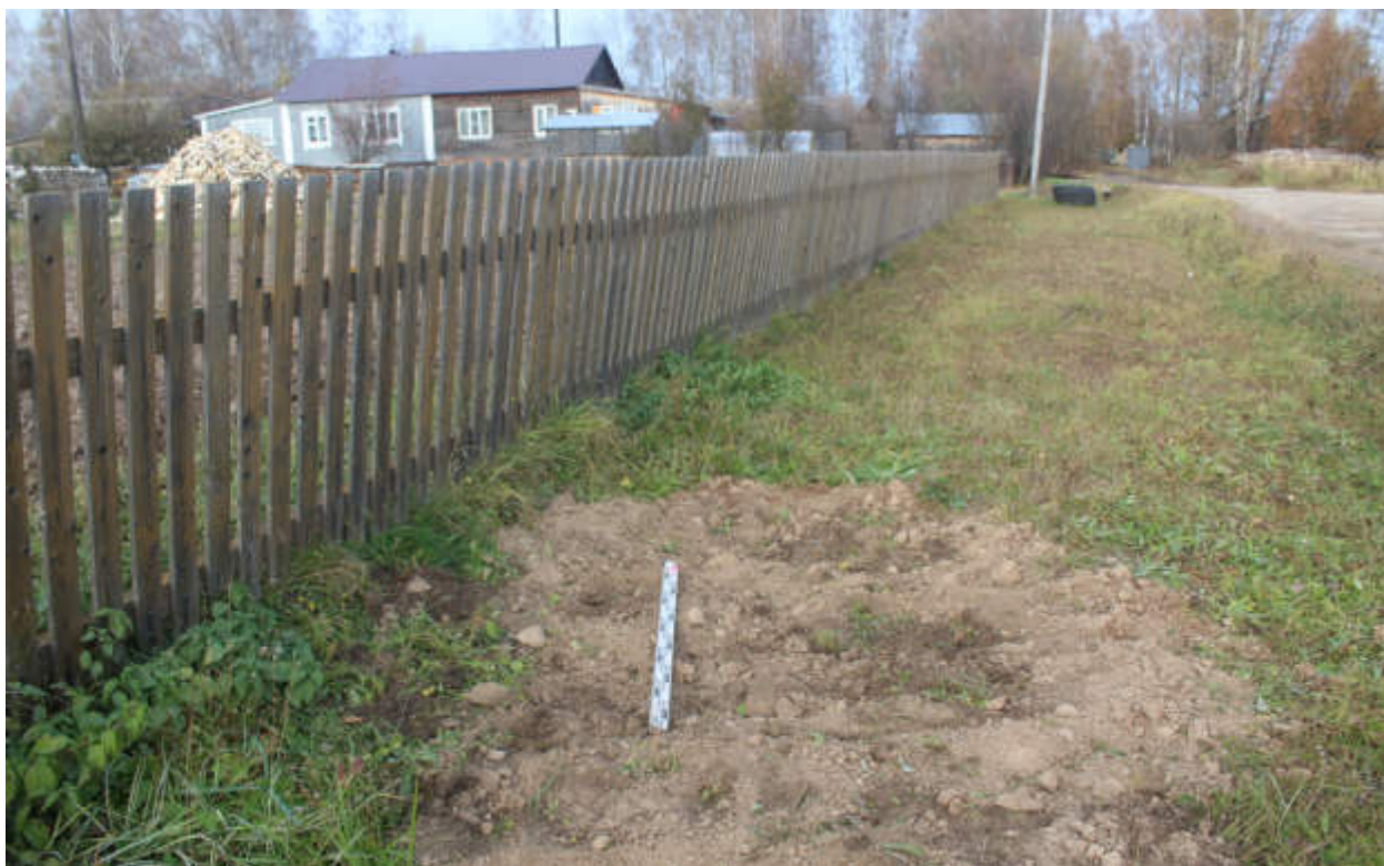
Рис.230. "Газопровод распределительный в пгт Тужа Тужинского муниципального района Кировской области" в пгт Тужа Тужинского муниципального района Кировской области. Шурф 20. Рекультивация. Вид с Ю.
