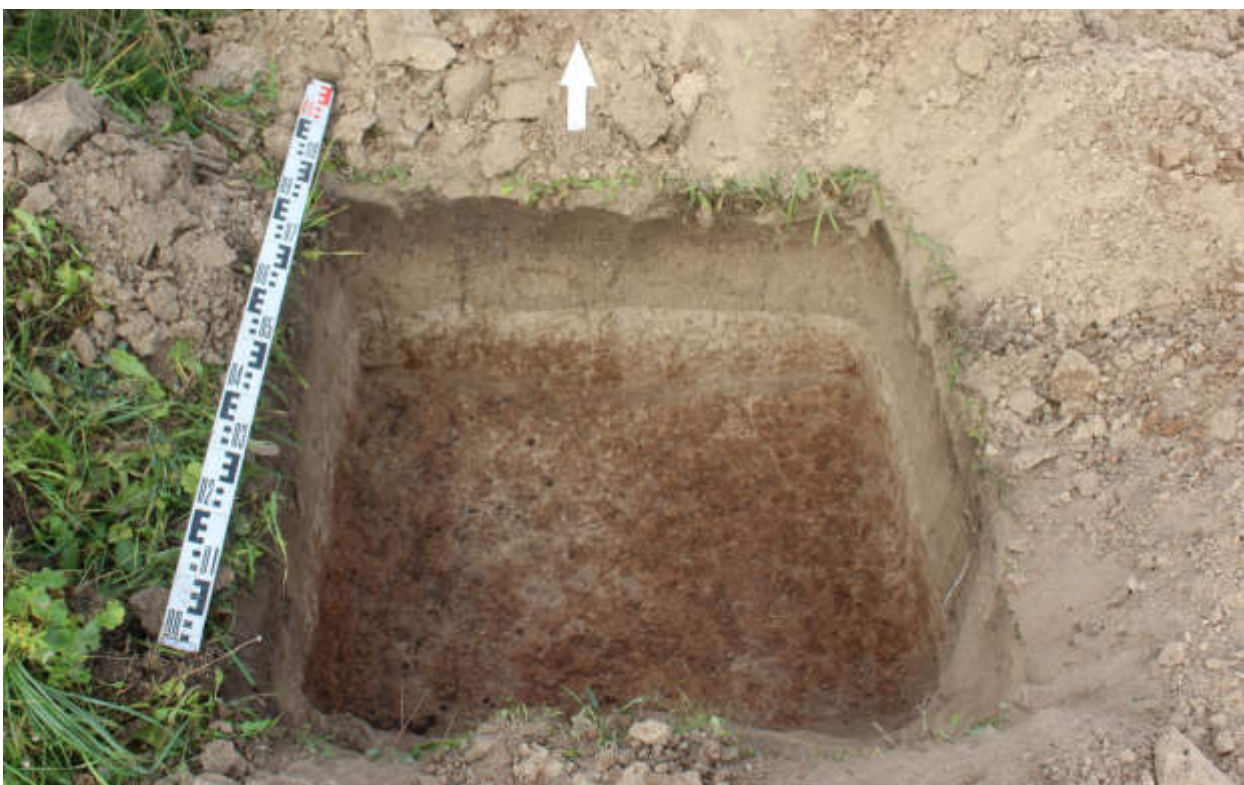
Рис.229. "Газопровод распределительный в пгт Тужа Тужинского муниципального района Кировской области" в пгт Тужа Тужинского муниципального района Кировской области. Шурф 20. Материк. Вид с Ю.
