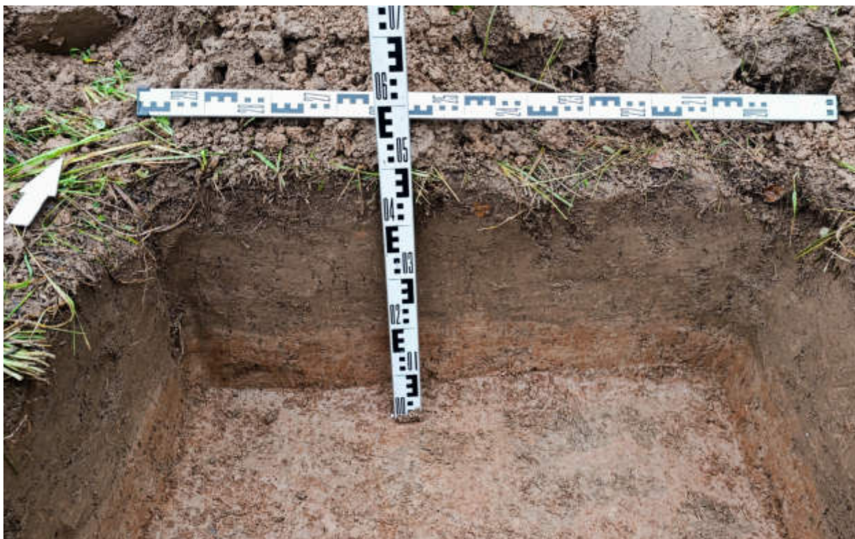
Рис.323. "Газопровод распределительный в пгт Тужа Тужинского муниципального района Кировской области" в пгт Тужа Тужинского муниципального района Кировской области. Шурф 39. Северный борт. Вид с Ю.
