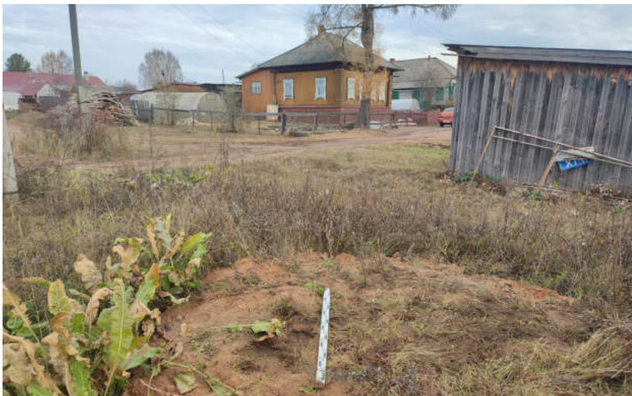
Рис.360. "Газопровод распределительный в пгт Тужа Тужинского муниципального района Кировской области" в пгт Тужа Тужинского муниципального района Кировской области. Шурф 46. Рекультивация. Вид с Ю.
