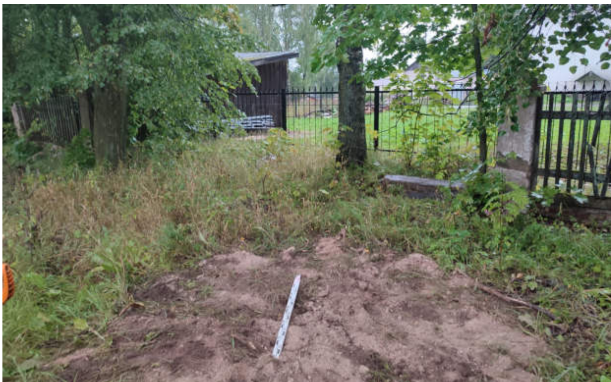
Рис.385. "Газопровод распределительный в пгт Тужа Тужинского муниципального района Кировской области" в пгт Тужа Тужинского муниципального района Кировской области. Шурф 51. Рекультивация. Вид с С.
