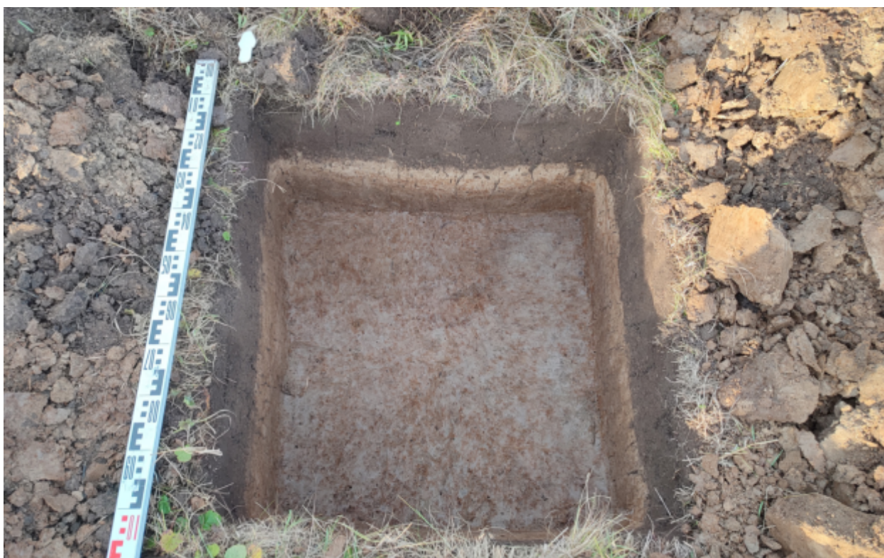
Рис.199. "Газопровод распределительный в пгт Тужа Тужинского муниципального района Кировской области" в пгт Тужа Тужинского муниципального района Кировской области. Шурф 14. Материк. Вид с Ю.
