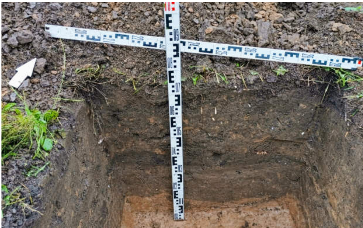
Рис.318. "Газопровод распределительный в пгт Тужа Тужинского муниципального района Кировской области" в пгт Тужа Тужинского муниципального района Кировской области. Шурф 38. Северный борт. Вид с Ю.
