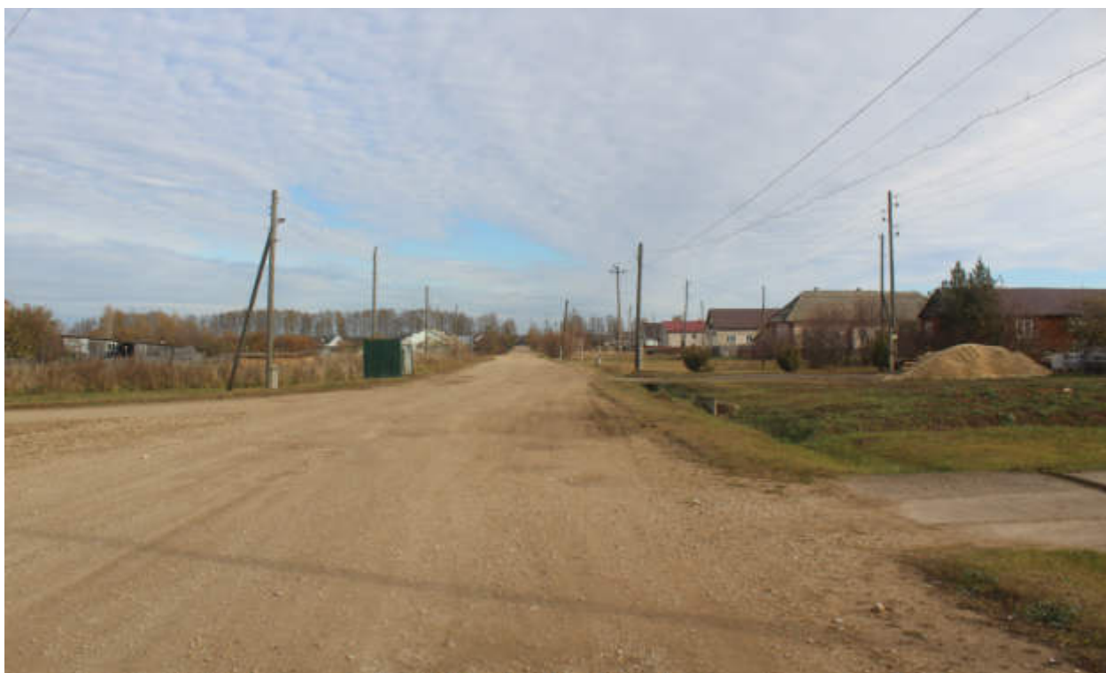
Рис.98. "Газопровод распределительный в пгт Туза Тужинского муниципального района Кировской области" в пгт Туза Тужинского муниципального района Кировской области. Рельеф местности и характер растительности участка обследования. Точка фотофиксации 44, вид с ЮЗ.
