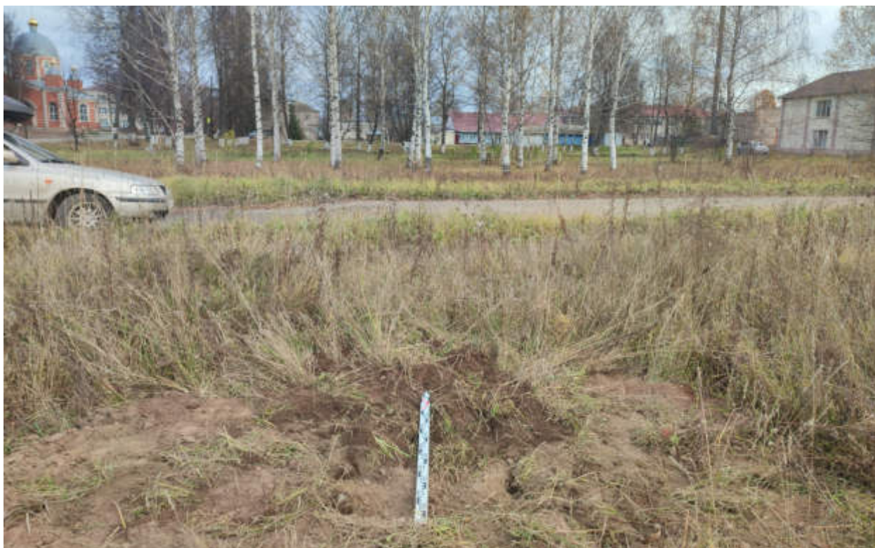
Рис.375. "Газопровод распределительный в пгт Тужа Тужинского муниципального района Кировской области" в пгт Тужа Тужинского муниципального района Кировской области. Шурф 49. Рекультивация. Вид с Ю.
