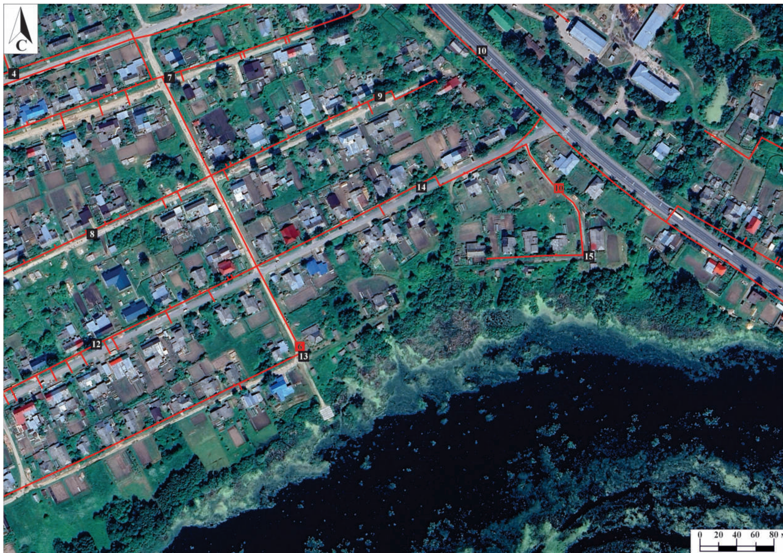
Рис.37. "Газопровод распределительный в пгт Туза Тужинского муниципального района Кировской области" в пгт Туза Тужинского муниципального района Кировской области. Обследованная территория на спутниковом снимке (сервис Google Планета Земля) с указанием точек фотофиксации и местоположения разведочных шурфов (6). Дата обращения: 10.09.2025 г. Дата снимка: июль, 2025 г.
