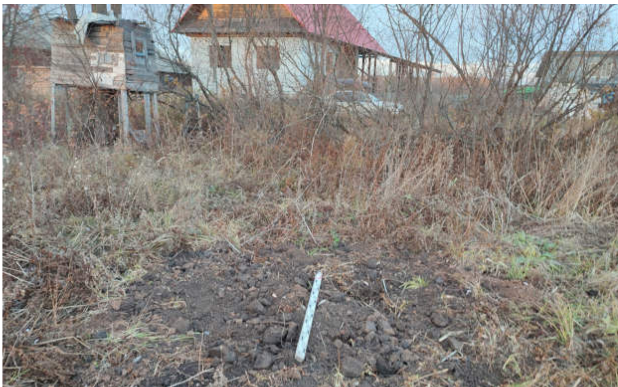
Рис.225. "Газопровод распределительный в пгт Тужа Тужинского муниципального района Кировской области" в пгт Тужа Тужинского муниципального района Кировской области. Шурф 19. Рекультивация. Вид с Ю.
