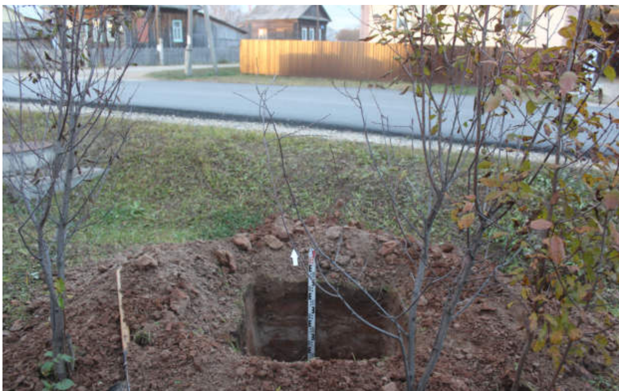
Рис.257. "Газопровод распределительный в пгт Тужа Тужинского муниципального района Кировской области" в пгт Тужа Тужинского муниципального района Кировской области. Шурф 26. Антураж. Вид с Ю.
