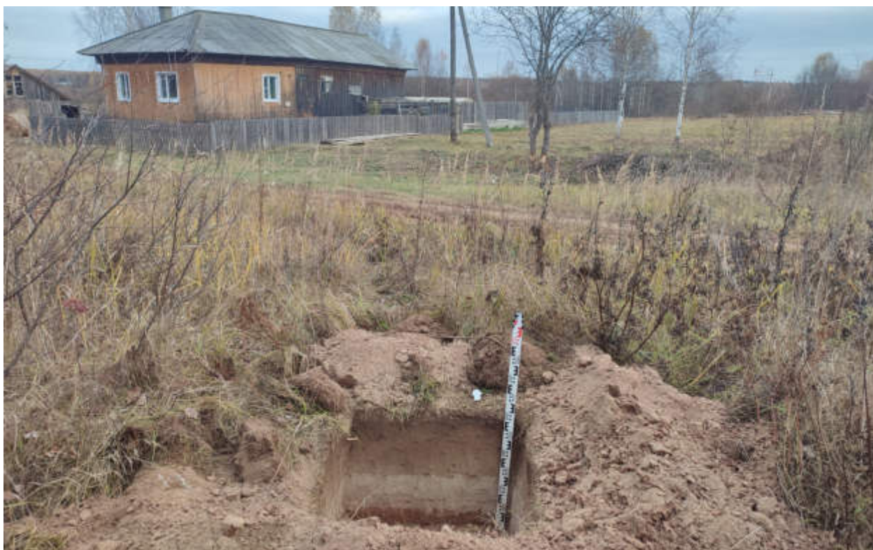
Рис.242. "Газопровод распределительный в пгт Тужа Тужинского муниципального района Кировской области" в пгт Тужа Тужинского муниципального района Кировской области. Шурф 23. Антураж. Вид с Ю.
