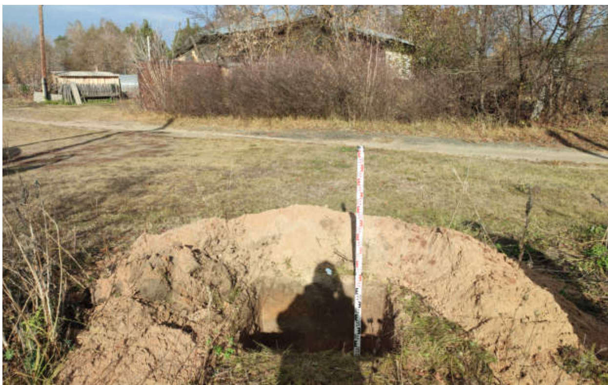
Рис.177. "Газопровод распределительный в пгт Туза Тужинского муниципального района Кировской области" в пгт Туза Тужинского муниципального района Кировской области. Шурф 10. Антураж. Вид с Ю.
