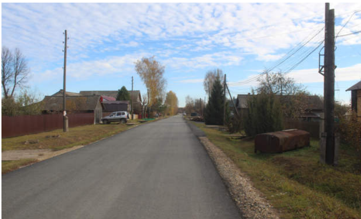
Рис.104. "Газопровод распределительный в пгт Тужа Тужинского муниципального района Кировской области" в пгт Тужа Тужинского муниципального района Кировской области. Рельеф местности и характер растительности участка обследования. Точка фотофиксации 50, вид с ЗСЗ.
