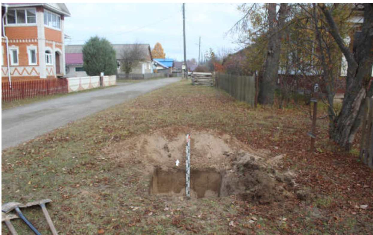
Рис.252. "Газопровод распределительный в пгт Туза Тужинского муниципального района Кировской области" в пгт Туза Тужинского муниципального района Кировской области. Шурф 25. Антураж. Вид с Ю.
