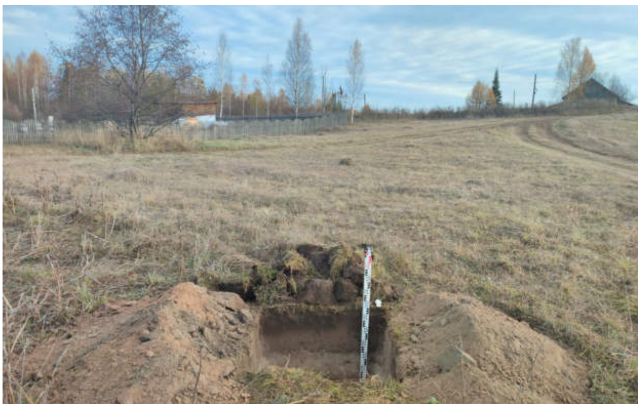
Рис.137. "Газопровод распределительный в пгт Тужа Тужинского муниципального района Кировской области" в пгт Тужа Тужинского муниципального района Кировской области. Шурф 2. Антураж. Вид с Ю.
