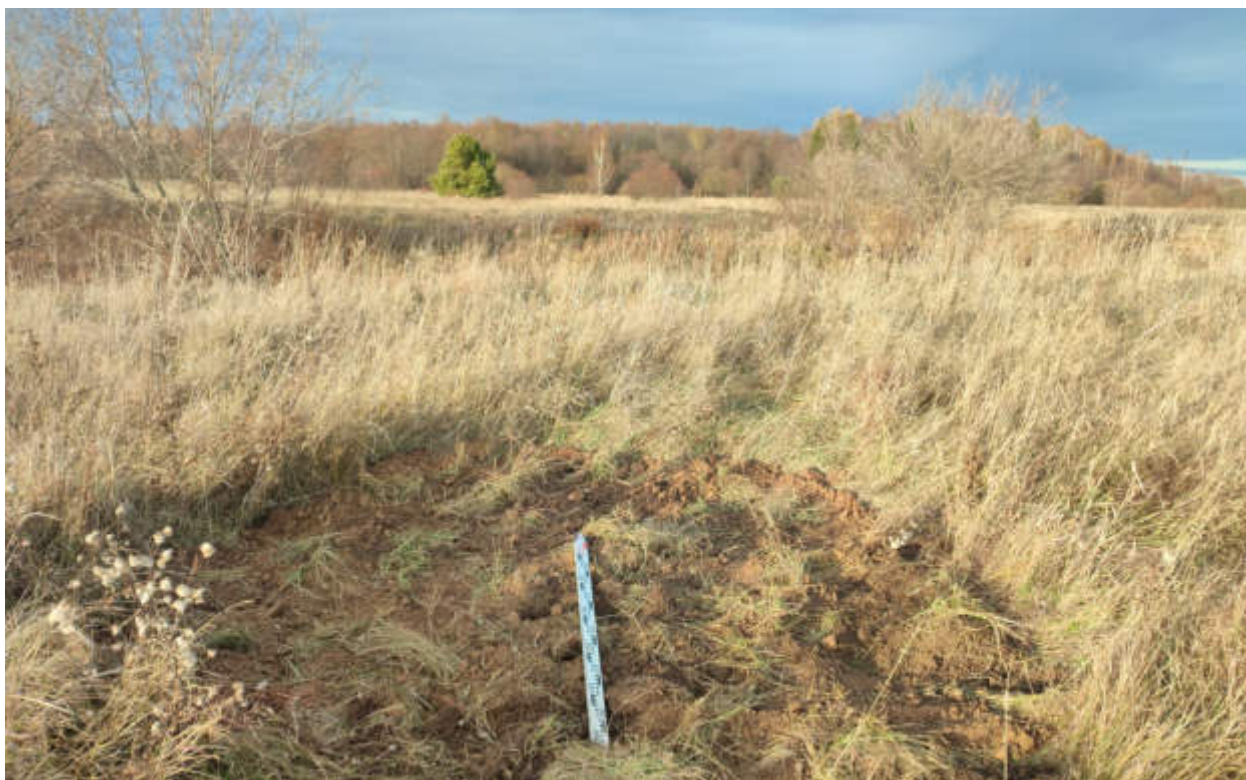
Рис.205. "Газопровод распределительный в пгт Тужа Тужинского муниципального района Кировской области" в пгт Тужа Тужинского муниципального района Кировской области. Шурф 15. Рекультивация. Вид с Ю.
