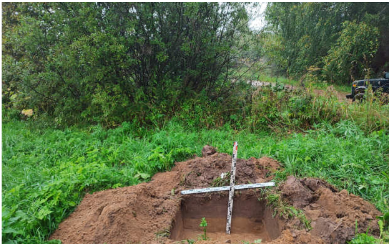
Рис.347. "Газопровод распределительный в пгт Тужа Тужинского муниципального района Кировской области" в пгт Тужа Тужинского муниципального района Кировской области. Шурф 44. Антураж. Вид с Ю.
