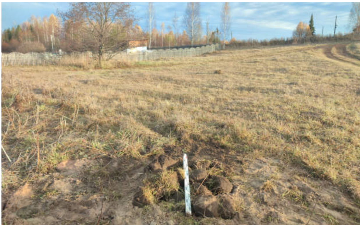
Рис.140. "Газопровод распределительный в пгт Тужа Тужинского муниципального района Кировской области" в пгт Тужа Тужинского муниципального района Кировской области. Шурф 2. Рекультивация. Вид с Ю.
