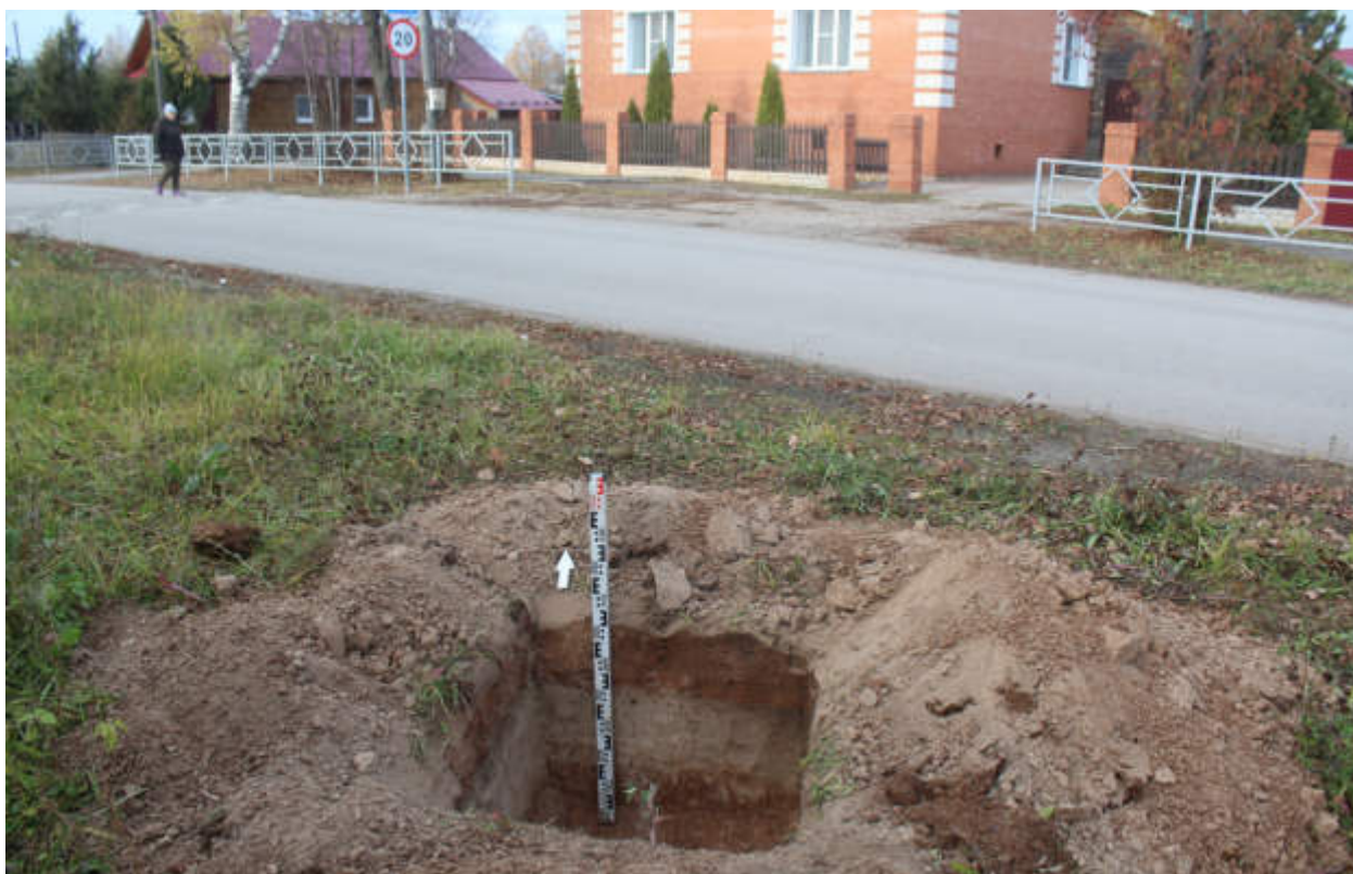
Рис.302. "Газопровод распределительный в пгт Тужа Тужинского муниципального района Кировской области" в пгт Тужа Тужинского муниципального района Кировской области. Шурф 35. Антураж. Вид с Ю.
