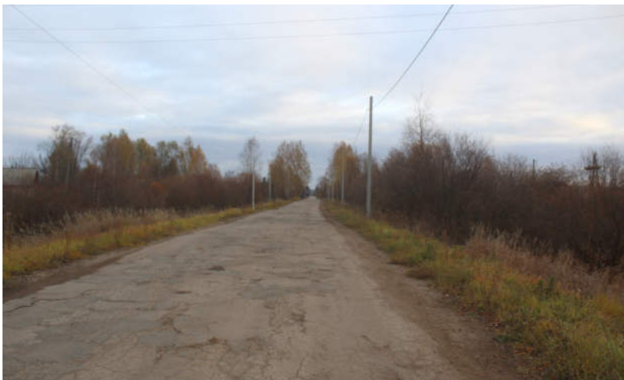
Рис.128. "Газопровод распределительный в пгт Тужа Тужинского муниципального района Кировской области" в пгт Тужа Тужинского муниципального района Кировской области. Рельеф местности и характер растительности участка обследования. Точка фотофиксации 74, вид с СВ.
