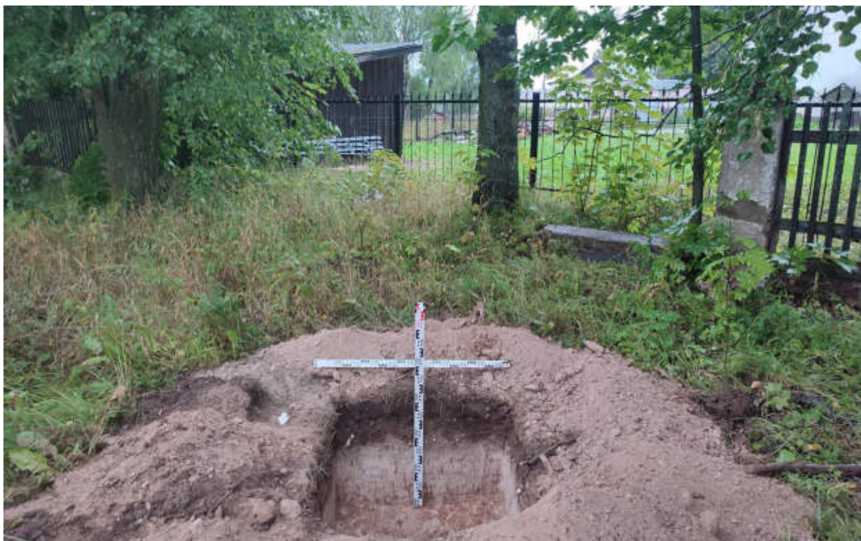
Рис.382. "Газопровод распределительный в пгт Тужа Тужинского муниципального района Кировской области" в пгт Тужа Тужинского муниципального района Кировской области. Шурф 51. Антураж. Вид с С.
