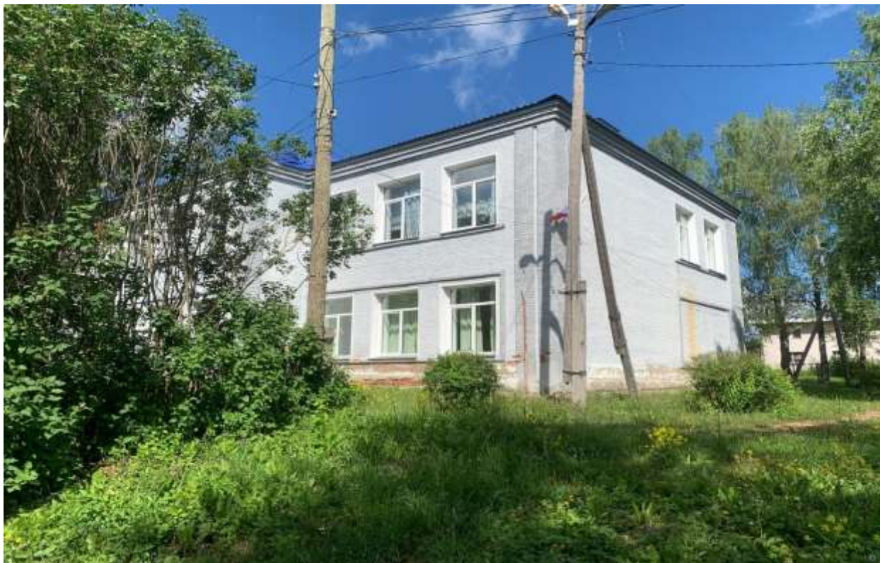
Фото 5. Здание школы. Фото Архипова П.В., 18.06.2024
