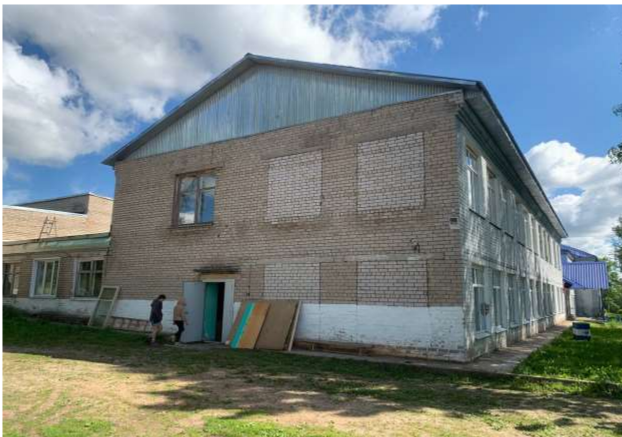
Фото 12. Здание школы(пристрой). Фото Архипова П.В., 18.06.2024
