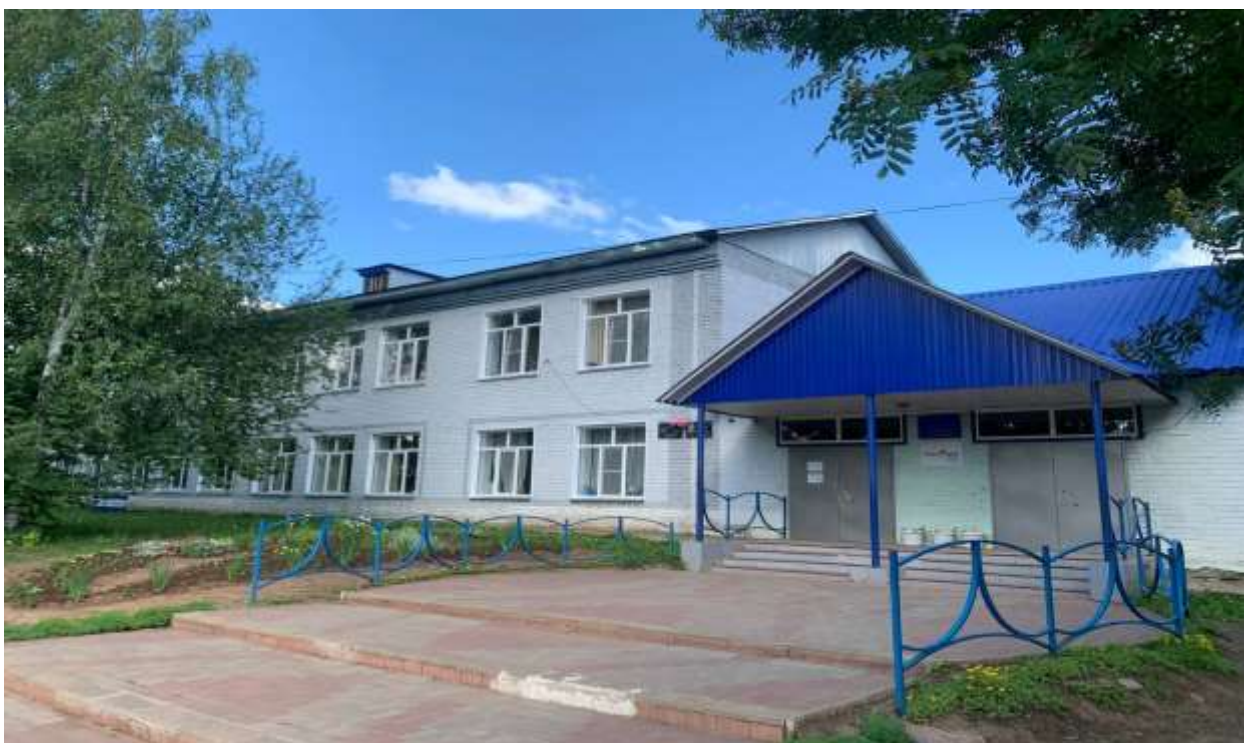
Фото 7. Здание школы. Фото Архипова П.В., 18.06.2024
