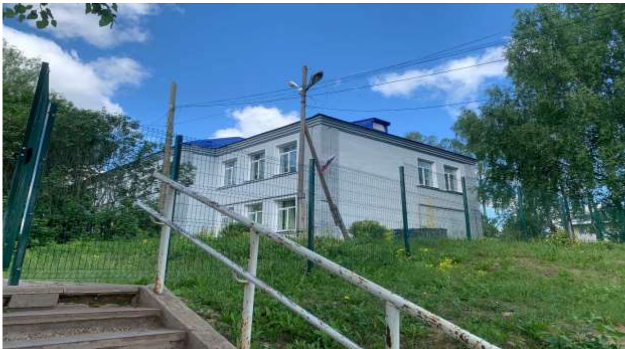
Фото 1. Здание школы. Фото Архипова П.В., 18.06.2024
