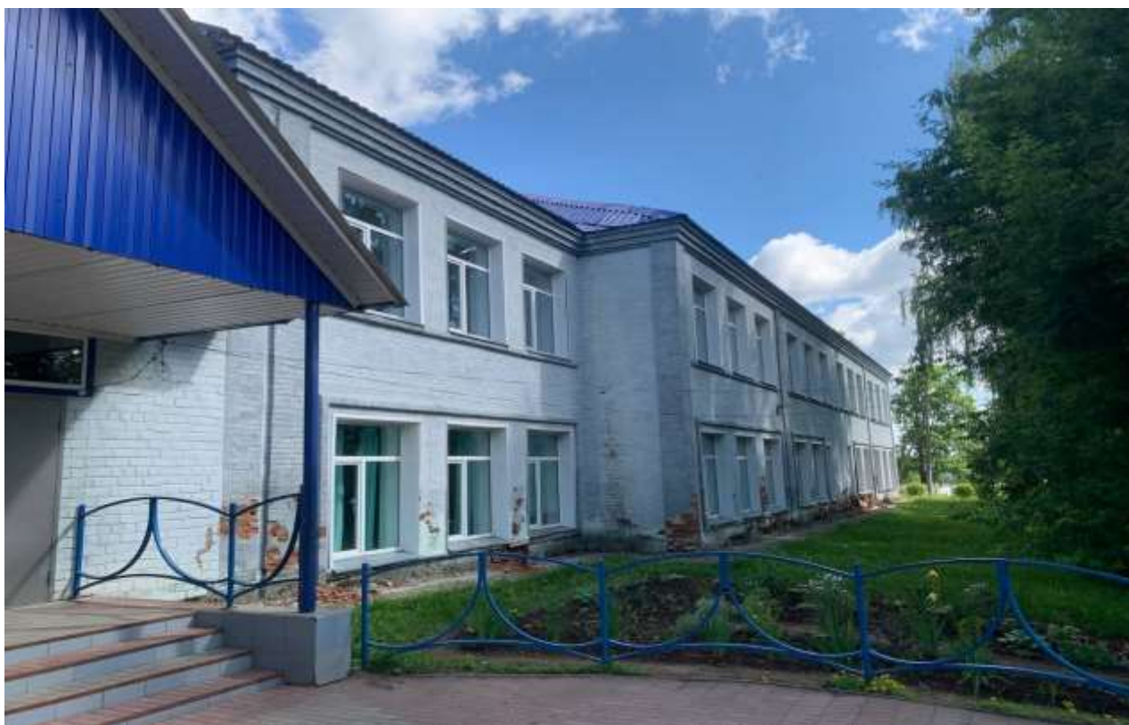
Фото 9. Здание школы. Фото Архипова П.В., 18.06.2024
