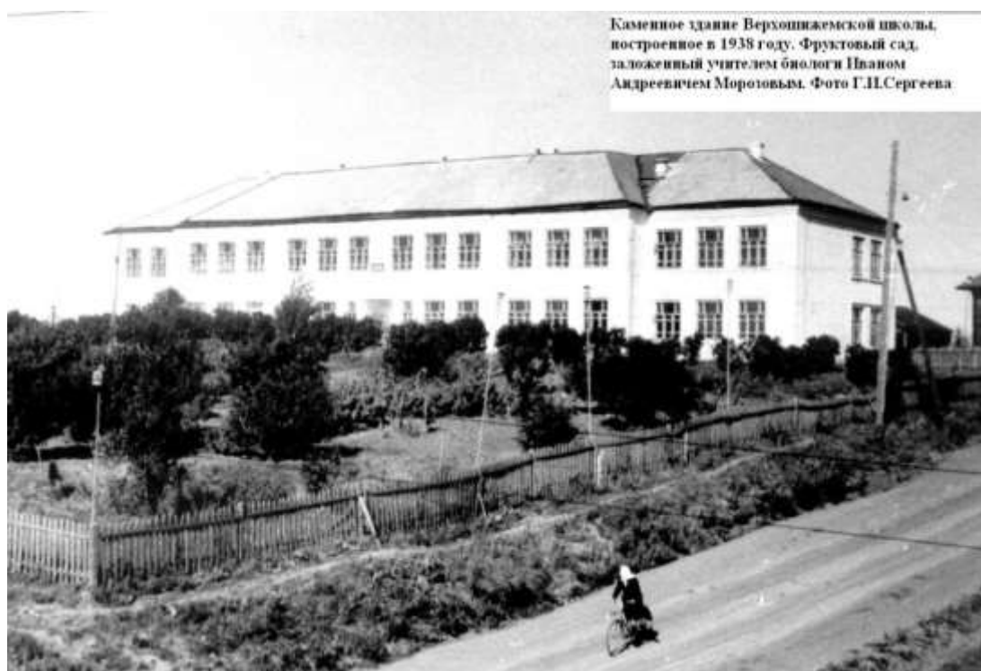
Рис. 4. Фотография первоначальной конструкции Объекта. Фото 1938 г.
