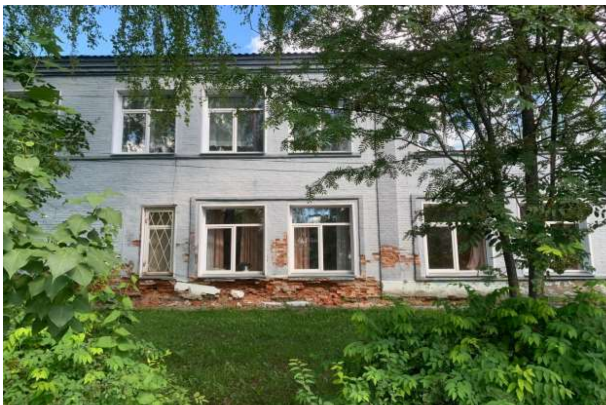
Фото 8. Здание школы. Фото Архипова П.В., 18.06.2024
