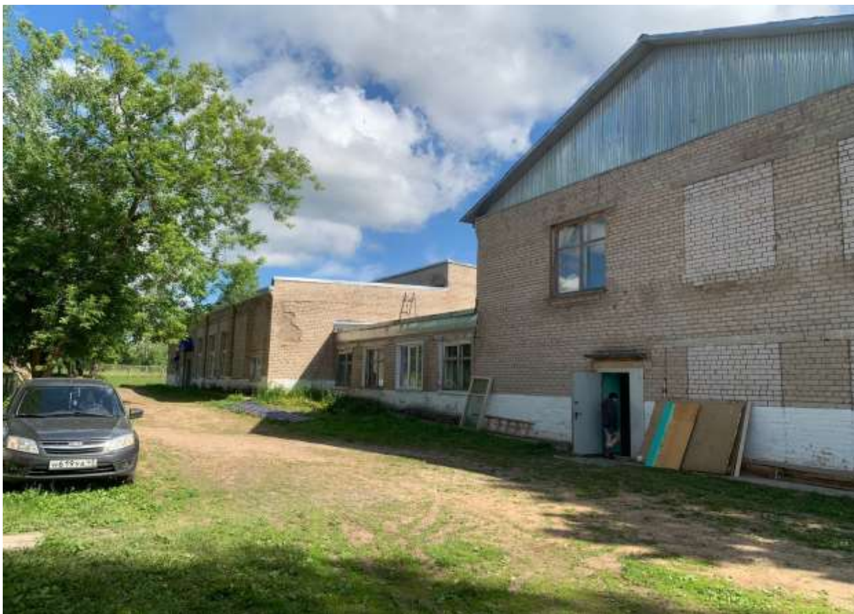
Фото 13. Здание школы (переход между зданиями). Фото Архипова П.В., 18.06.2024
