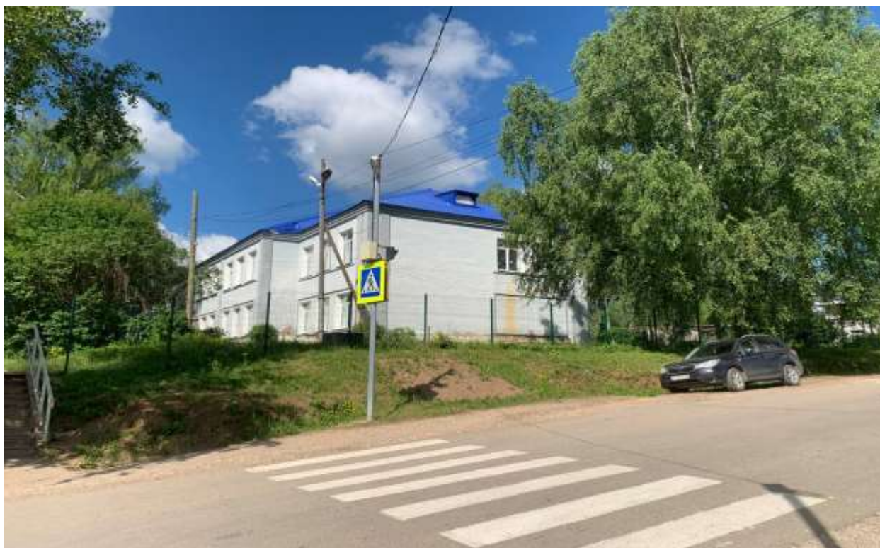
Фото 2. Здание школы. Фото Архипова П.В., 18.06.2024
