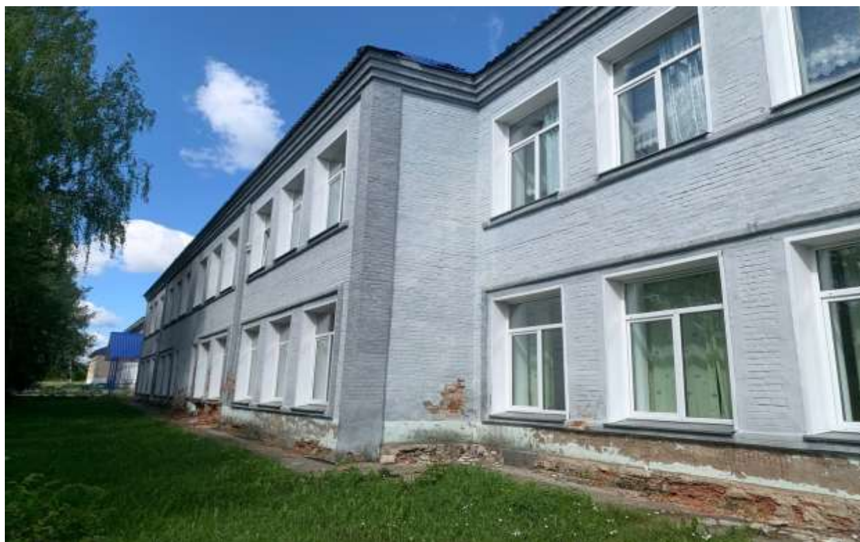
Фото 6. Здание школы. Фото Архипова П.В., 18.06.2024
