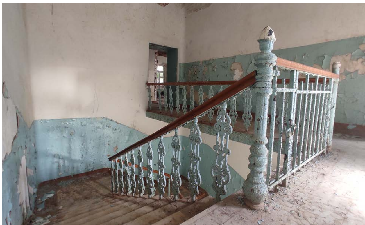
Фото 10. Южное крыло. Междуетажная лестница. Вид со второго этажа. Автор съемки – Баруткина Е.Е., дата съемки – 2022 г.
