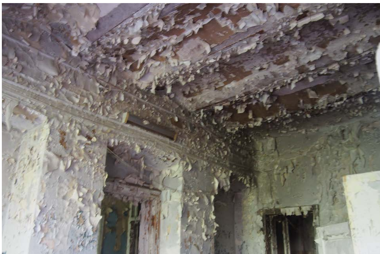
Фото 8. Северное крыло. Первый этаж. Сводчатые перекрытия типа «Монье». Автор съемки – Баруткина Е.Е., дата съемки – 2022 г.
