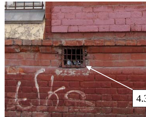
Фото 21. Вентиляционное отверстие с металлической решеткой над цоколем
