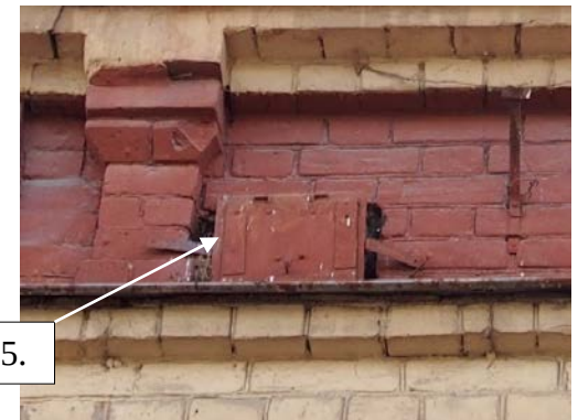
Фото 22. Вентиляционное отверстие в уровне второго этажа
