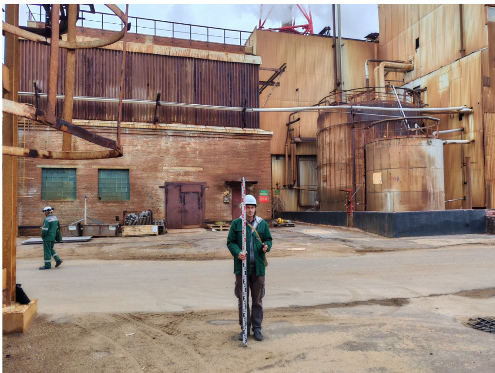
Илл.16. Земельный участок, отводимый под объект: «Реконструкция с техническим перевооружением агрегата АС-72 №1 с расширением мощности производства гранулированной аммиачной селитры до 2200 т/сутки» в г. Кирово-Чепецк Кировской области. Пикет фотосъемки 2. Вид с С.
