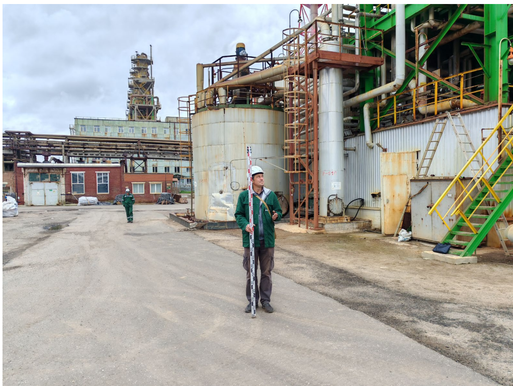
Илл.24. Земельный участок, отводимый под объект: «Реконструкция с техническим перевооружением агрегата АС-72 №1 с расширением мощности производства гранулированной аммиачной селитры до 2200 т/сутки» в г. Кирово-Чепецк Кировской области. Пикет фотосъемки 4. Вид с С.
