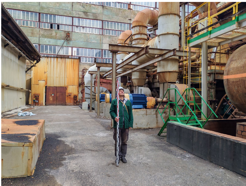
Илл.10. Земельный участок, отводимый под объект: «Реконструкция с техническим перевооружением агрегата АС-72 №1 с расширением мощности производства гранулированной аммиачной селитры до 2200 т/сутки» в г. Кирово-Чепецк Кировской области. Пикет фотосъемки 1. Вид с Ю.
