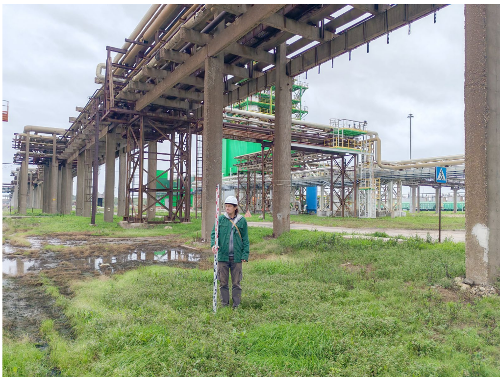
Илл.26. Земельный участок, отводимый под объект: «Реконструкция с техническим перевооружением агрегата АС-72 №1 с расширением мощности производства гранулированной аммиачной селитры до 2200 т/сутки» в г. Кирово-Чепецк Кировской области. Пикет фотосъемки 5. Вид с Ю.
