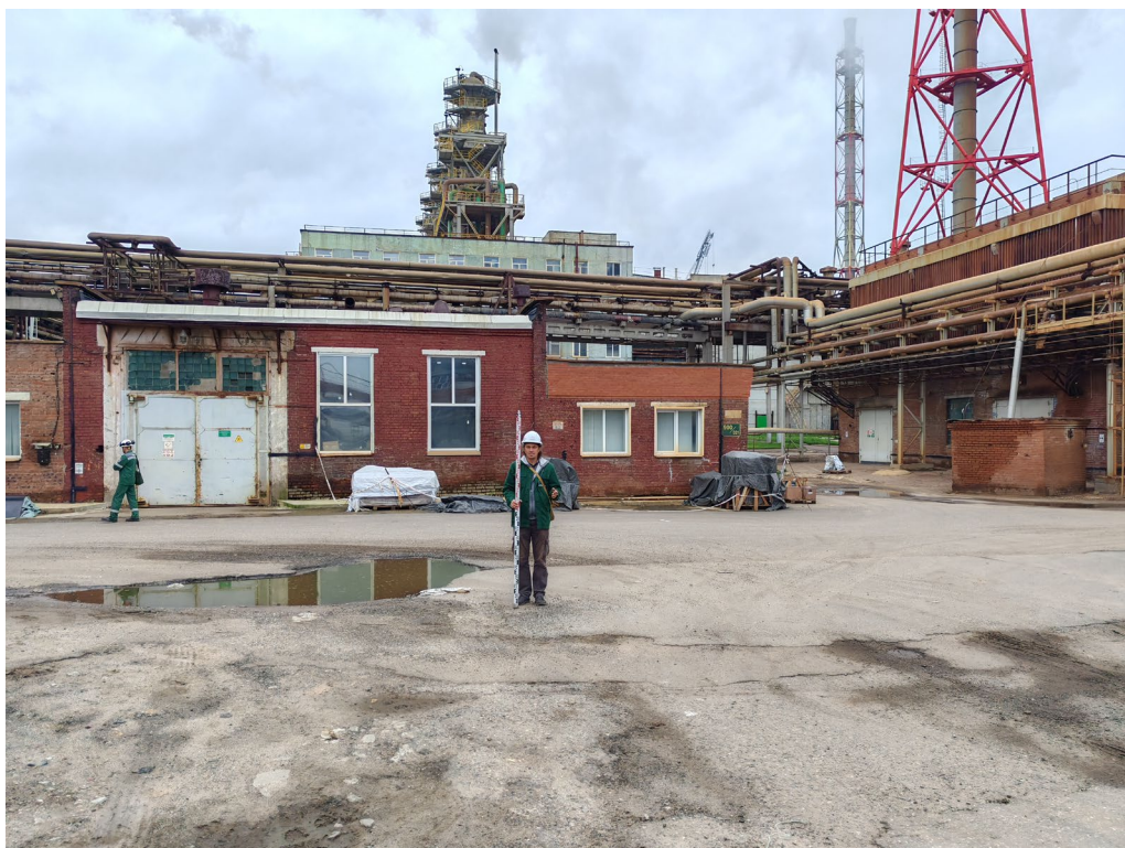
Илл.20. Земельный участок, отводимый под объект: «Реконструкция с техническим перевооружением агрегата АС-72 №1 с расширением мощности производства гранулированной аммиачной селитры до 2200 т/сутки» в г. Кирово-Чепецк Кировской области. Пикет фотосъемки 3. Вид с С.
