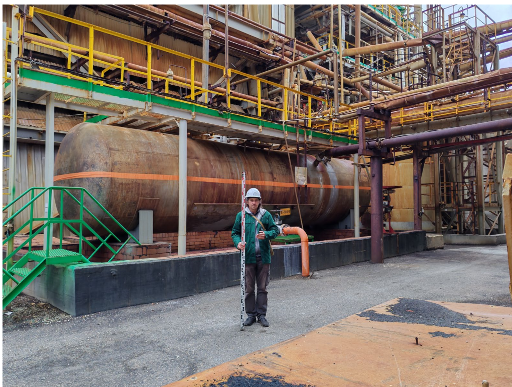
Илл.11. Земельный участок, отводимый под объект: «Реконструкция с техническим перевооружением агрегата АС-72 №1 с расширением мощности производства гранулированной аммиачной селитры до 2200 т/сутки» в г. Кирово-Чепецк Кировской области. Пикет фотосъемки 1. Вид с З.
