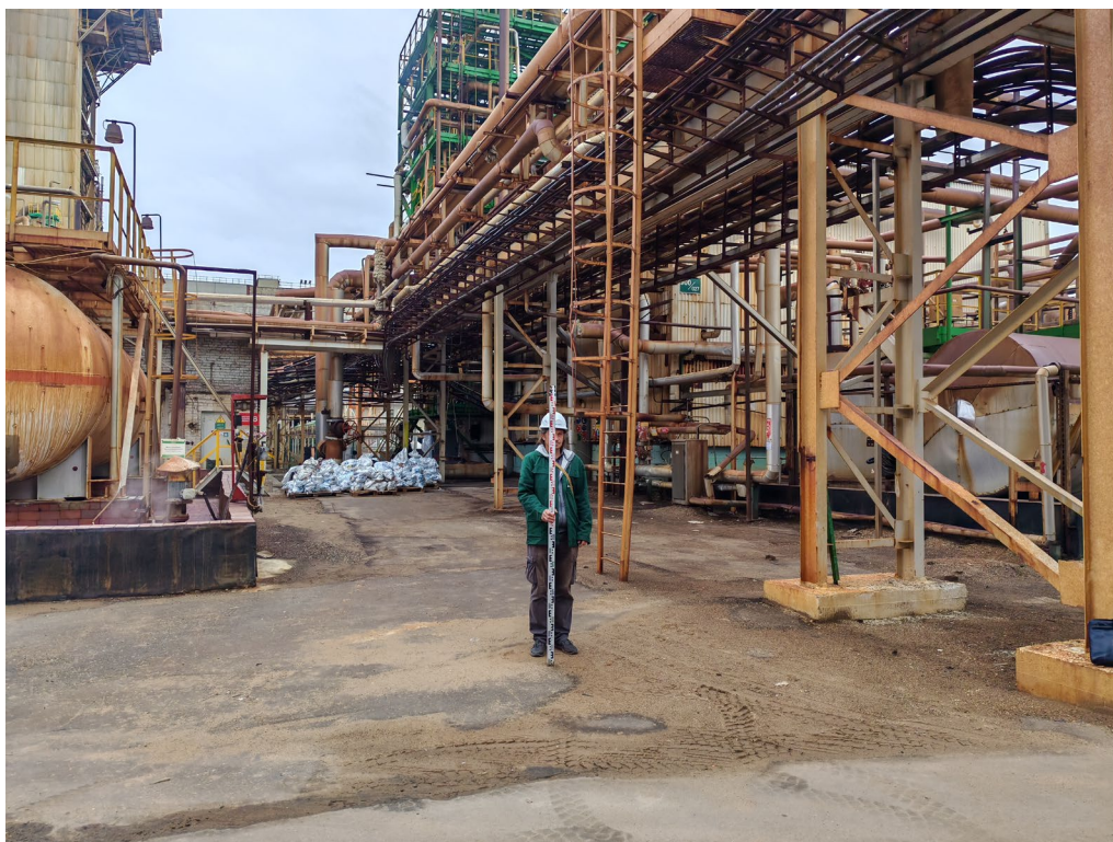
Илл.14. Земельный участок, отводимый под объект: «Реконструкция с техническим перевооружением агрегата АС-72 №1 с расширением мощности производства гранулированной аммиачной селитры до 2200 т/сутки» в г. Кирово-Чепецк Кировской области. Пикет фотосъемки 2. Вид с Ю.
