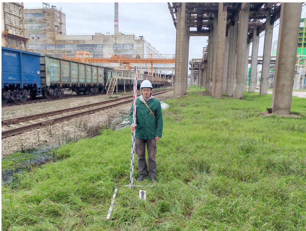
Илл.30. Земельный участок, отводимый под объект: «Реконструкция с техническим перевооружением агрегата АС-72 №1 с расширением мощности производства гранулированной аммиачной селитры до 2200 т/сутки» в г. Кирово-Чепецк Кировской области. Шурф 1. Место закладки. Вид с Ю.
