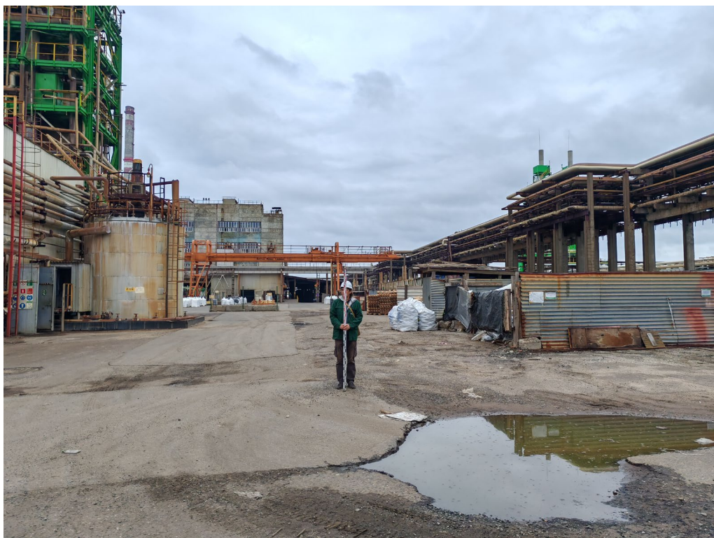
Илл.18. Земельный участок, отводимый под объект: «Реконструкция с техническим перевооружением агрегата АС-72 №1 с расширением мощности производства гранулированной аммиачной селитры до 2200 т/сутки» в г. Кирово-Чепецк Кировской области. Пикет фотосъемки 3. Вид с Ю.
