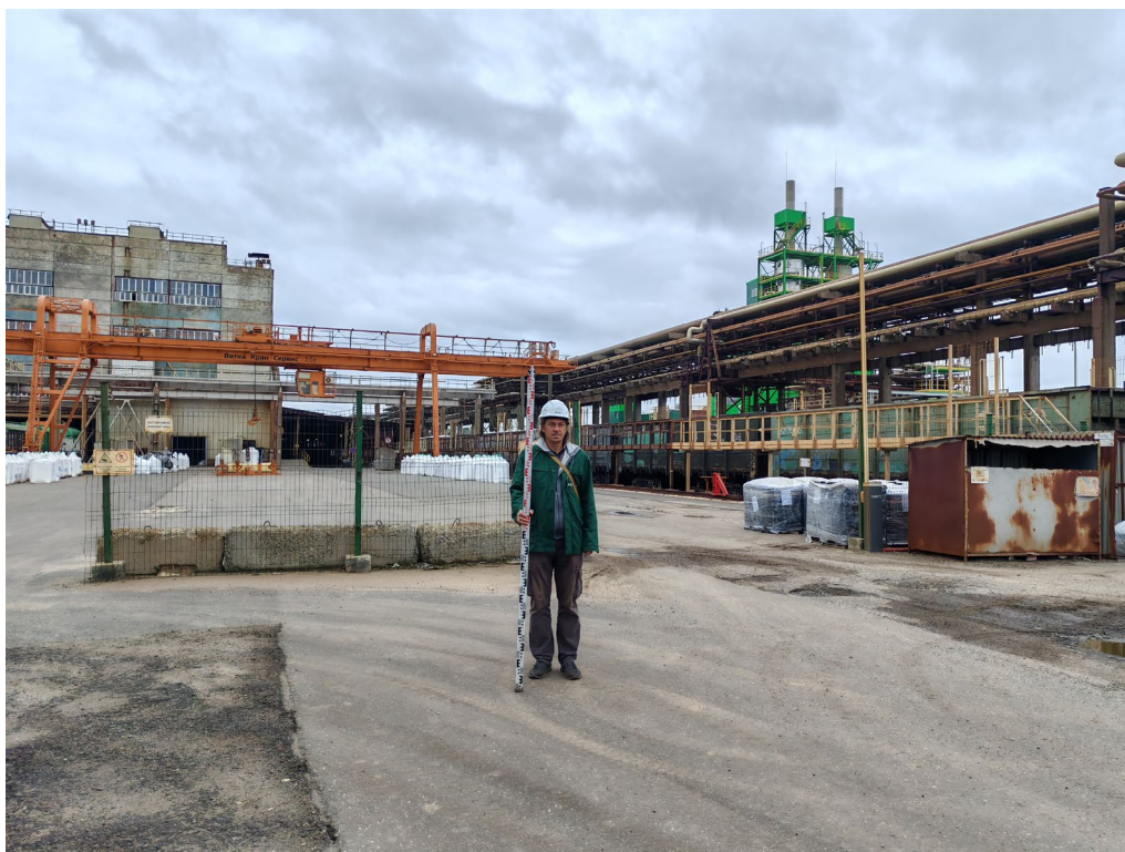
Илл.22. Земельный участок, отводимый под объект: «Реконструкция с техническим перевооружением агрегата АС-72 №1 с расширением мощности производства гранулированной аммиачной селитры до 2200 т/сутки» в г. Кирово-Чепецк Кировской области. Пикет фотосъемки 4. Вид с Ю.
