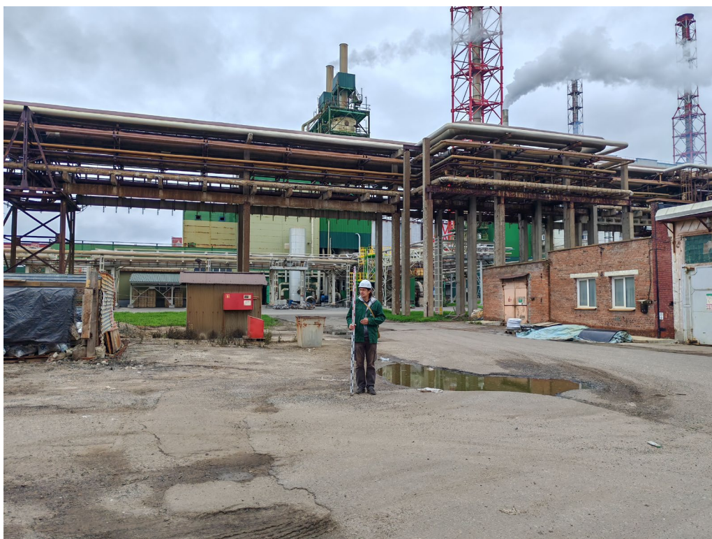
Илл.19. Земельный участок, отводимый под объект: «Реконструкция с техническим перевооружением агрегата АС-72 №1 с расширением мощности производства гранулированной аммиачной селитры до 2200 т/сутки» в г. Кирово-Чепецк Кировской области. Пикет фотосъемки 3. Вид с З.
