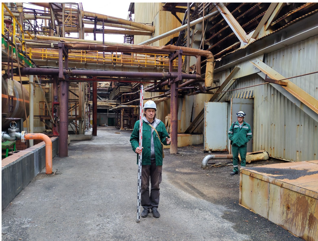
Илл.12. Земельный участок, отводимый под объект: «Реконструкция с техническим перевооружением агрегата АС-72 №1 с расширением мощности производства гранулированной аммиачной селитры до 2200 т/сутки» в г. Кирово-Чепецк Кировской области. Пикет фотосъемки 1. Вид с С.
