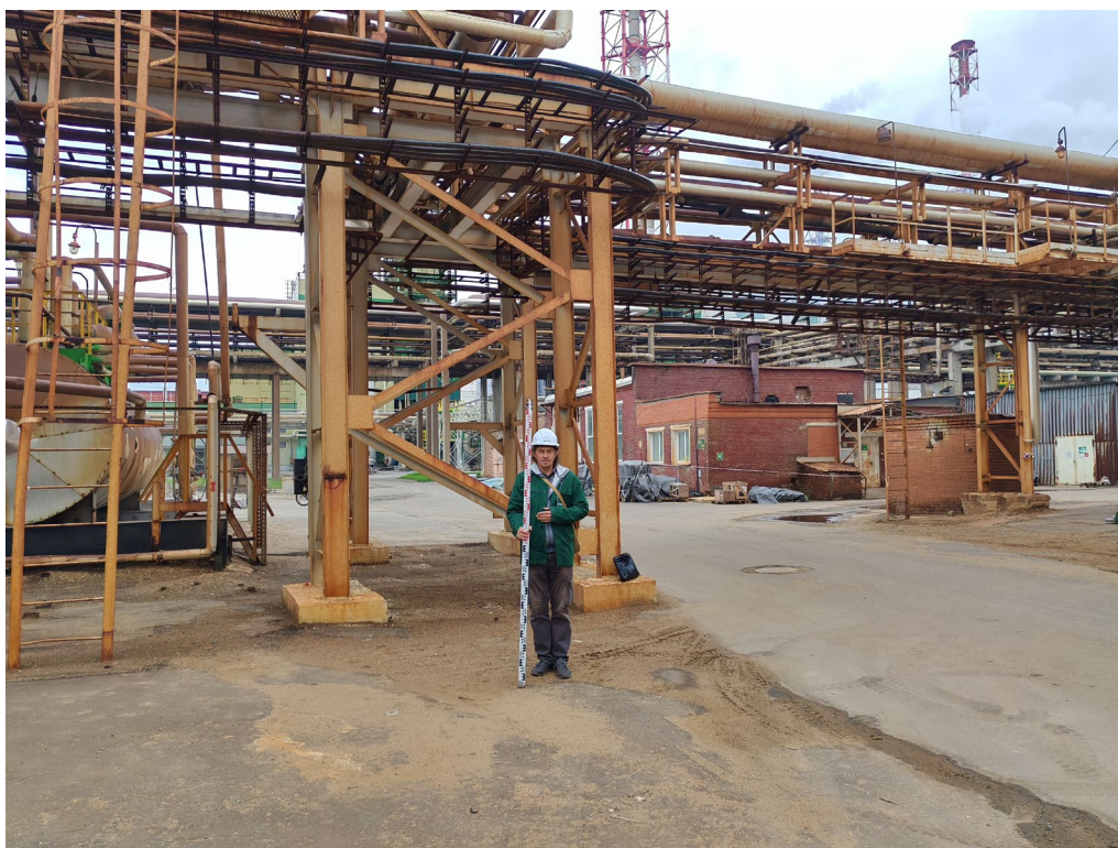
Илл.15. Земельный участок, отводимый под объект: «Реконструкция с техническим перевооружением агрегата АС-72 №1 с расширением мощности производства гранулированной аммиачной селитры до 2200 т/сутки» в г. Кирово-Чепецк Кировской области. Пикет фотосъемки 2. Вид с З.
