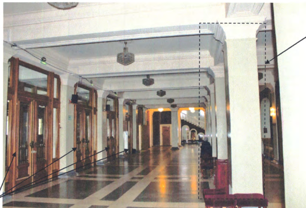
Фото 48. 1 этаж. Вестибюль. Общий вид. Фотосъемка 2019 г.
