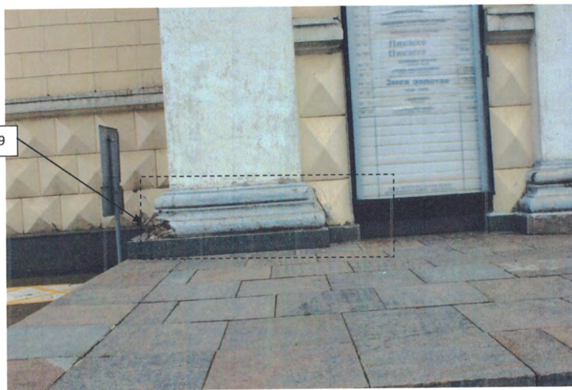
Фото 6. Фрагмент южного фасада. Фотосъемка 2019 г.
