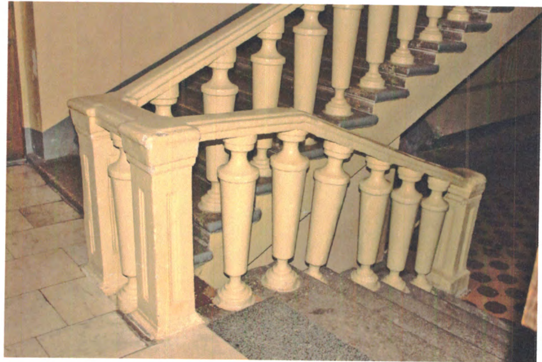
Фото 70. Лестничная клетка. Фотосъемка 2019 г.
