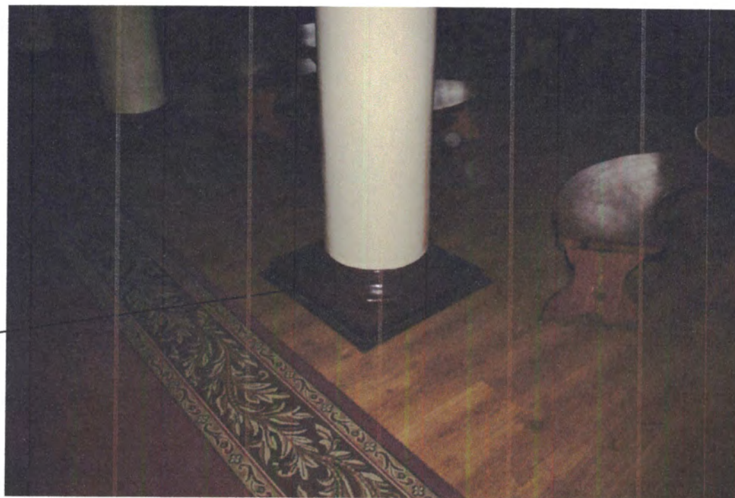
Фото 54. 1 этаж. Фойе. База колонны. Фотосъемка 2019 г.
