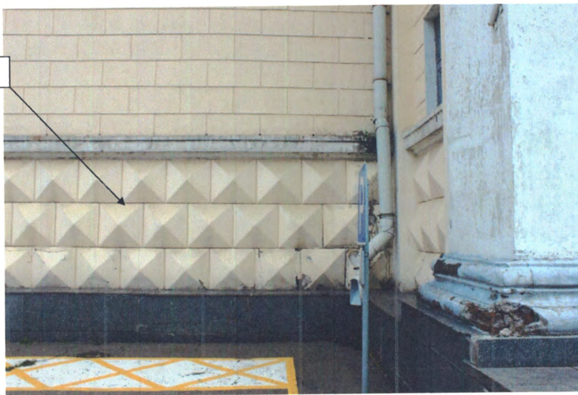
Фото 8. Фрагмент южного фасада. Фотосъемка 2019 г.
