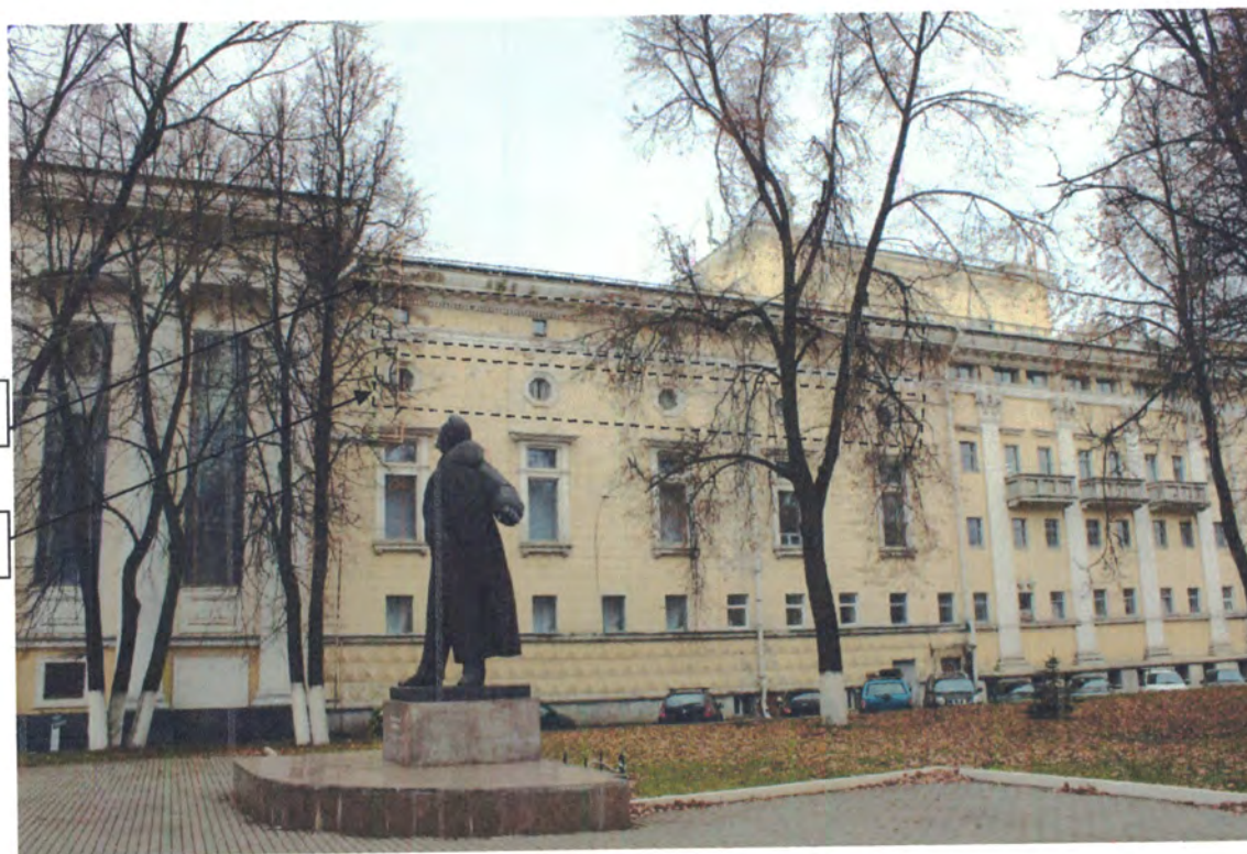
Фото 20. Восточный фасад. Окна восточного фасада верхних этажей. Фотосъемка 2019 г.
