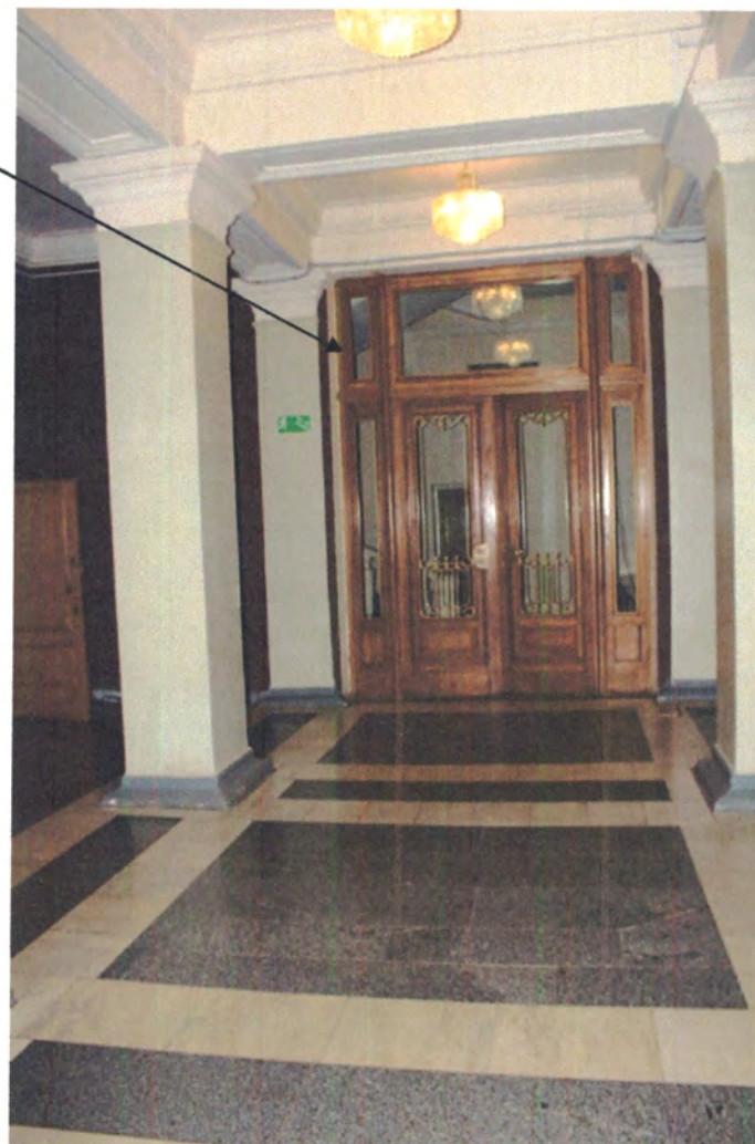
Фото 46. 1 этаж. Вестибюль. Дубовая остекленная дверь с декоративными решетками, ведущая на лестничную клетку. Фотосъемка 2019 г.
