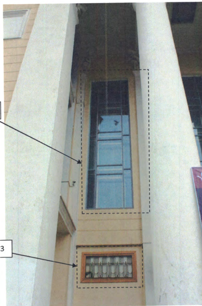
Фото 9. Фрагмент южного фасада. Фотосъемка 2019 г.
