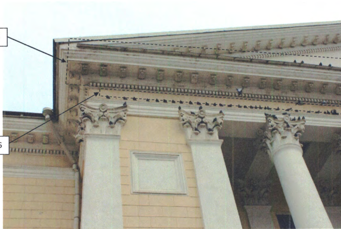
Фото 4. Фрагмент южного фасада. Фотосъемка 2019 г.
