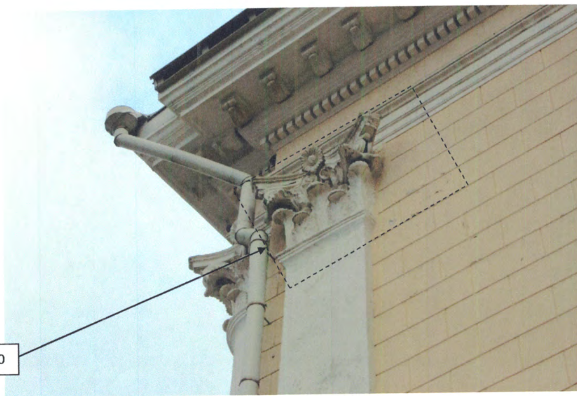
Фото 7. Фрагмент южного фасада. Фотосъемка 2019 г.
