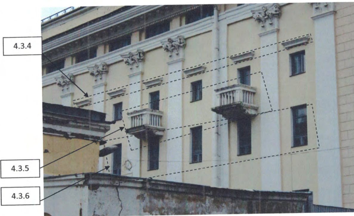
Фото 31. Фрагмент северного фасада. Фотосъемка 2019 г.
