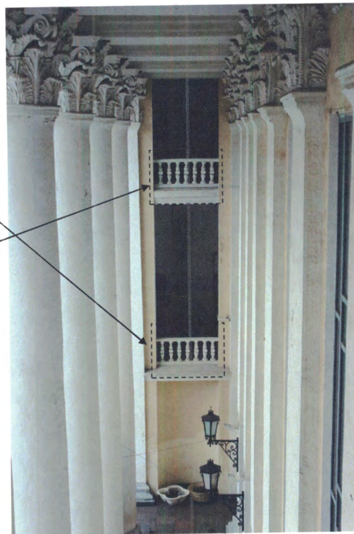
Фото 12. Вид на балконы главного фасада. Фотосъемка 2019 г.
