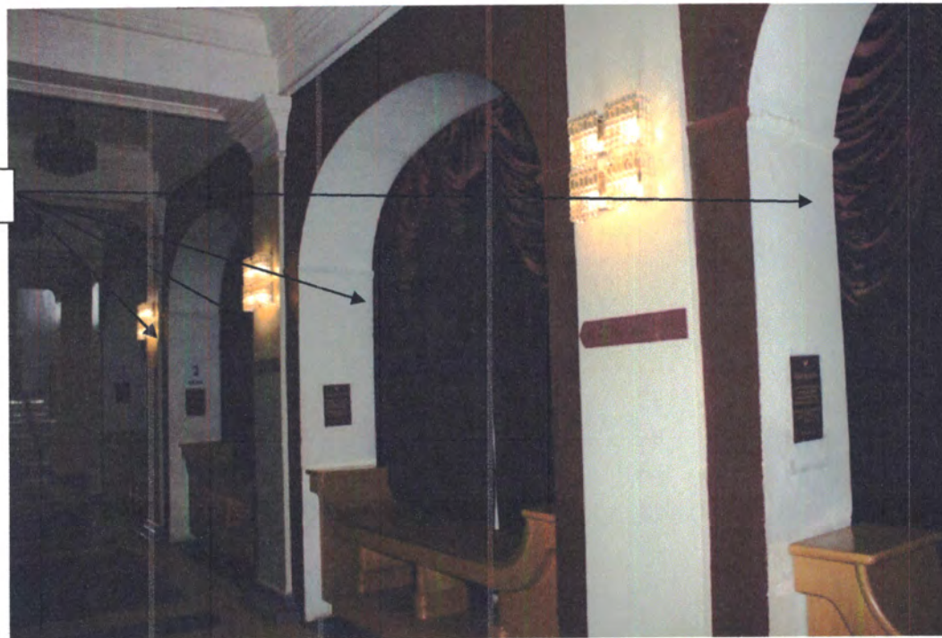
Фото 50. 1 этаж. Вестибюль. Арочные проемы. Фотосъемка 2019 г.
