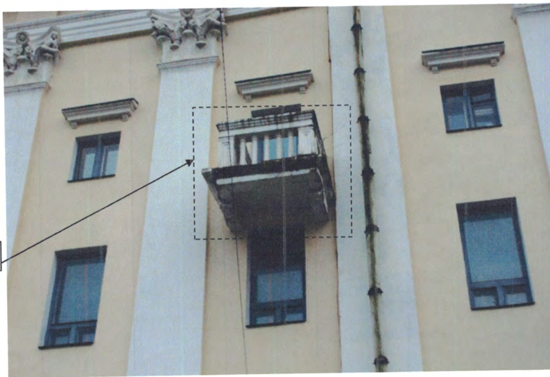
Фото 35. Фрагмент северного фасада. Фотосъемка 2019 г.
