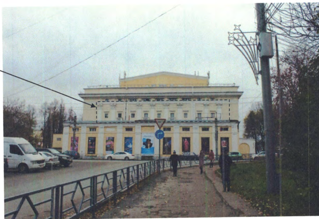
Фото 29. Северный фасад. Общий вид. Фотосъемка 2019 г.
