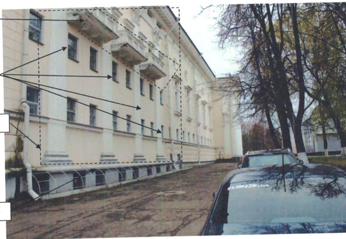
Фото 36. Фрагмент западного фасада. Фотосъемка 2019 г.
