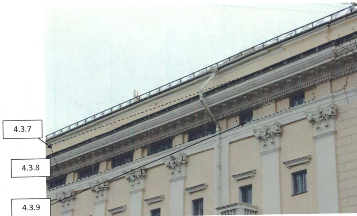
Фото 32. Фрагмент северного фасада. Оконные проемы 4 этажа. Фотосъемка 2019 г.
