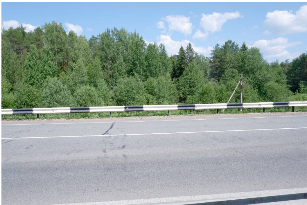
Илл.15. Кировская область, Белохолуницкий район. Земельный участок, отводимый под объект: ««Капитальный ремонт моста через р. Белая Холуница на км 677+630 автомобильной дороги Р-243 Кострома-Шарья-Киров-Пермь, Кировская область». Пикет фотосъемки 4. Вид с 3.
