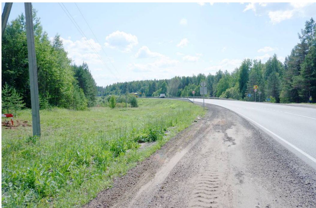
Илл.7. Кировская область, Белохолуницкий район. Земельный участок, отводимый под объект: ««Капитальный ремонт моста через р. Белая Холуница на км 677+630 автомобильной дороги Р-243 Кострома-Шарья-Киров-Пермь, Кировская область». Пикет фотосъемки 1. Вид с С.
