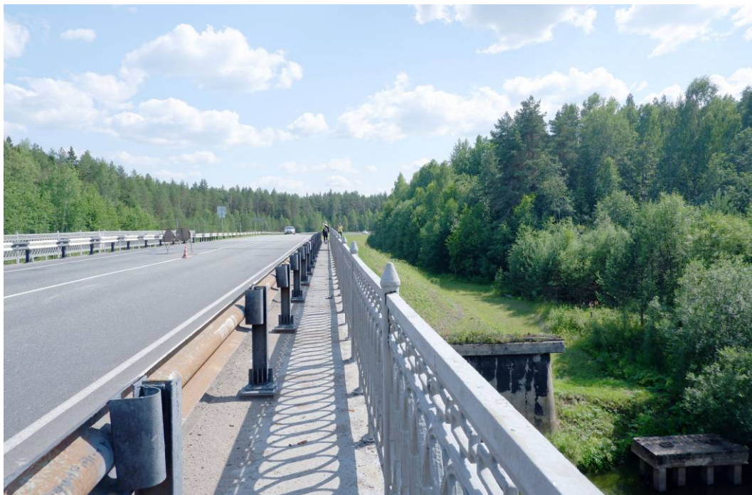
Илл.19. Кировская область, Белохолуницкий район. Земельный участок, отводимый под объект: ««Капитальный ремонт моста через р. Белая Холуница на км 677+630 автомобильной дороги Р-243 Кострома-Шарья-Киров-Пермь, Кировская область». Пикет фотосъемки 5. Вид с ССЗ.
