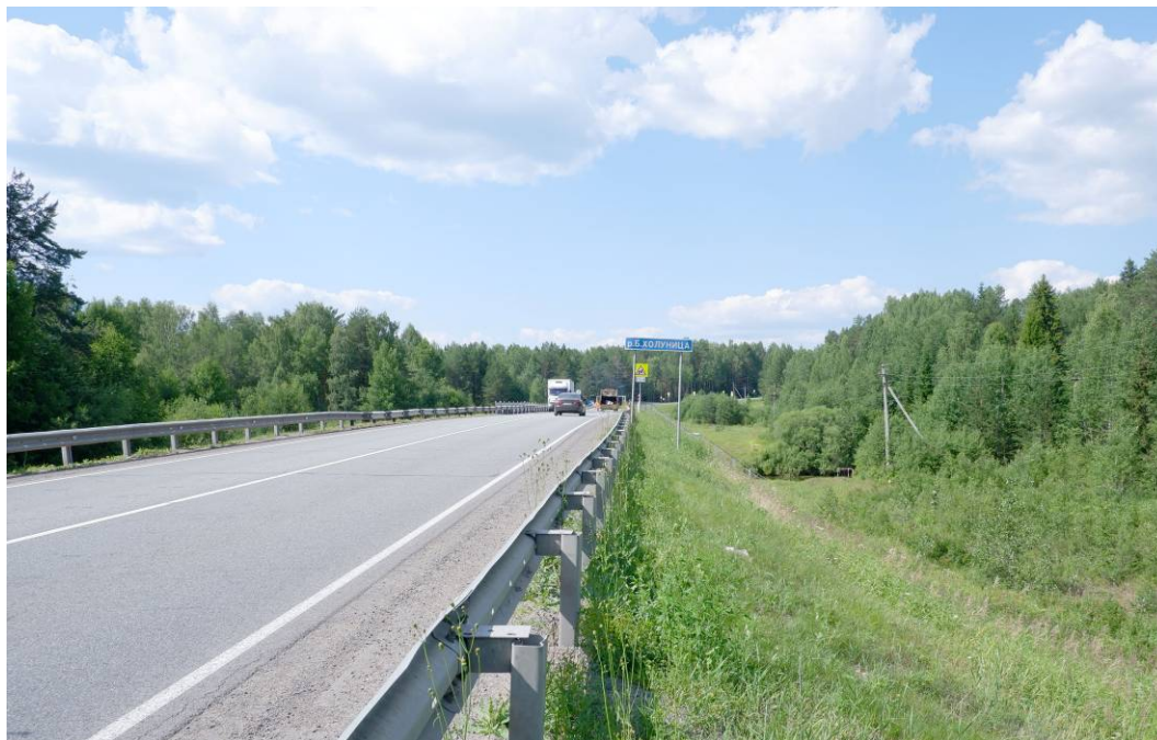
Илл.23. Кировская область, Белохолуницкий район. Земельный участок, отводимый под объект: ««Капитальный ремонт моста через р. Белая Холуница на км 677+630 автомобильной дороги Р-243 Кострома-Шарья-Киров-Пермь, Кировская область». Пикет фотосъемки 7. Вид с ЮЮВ.
