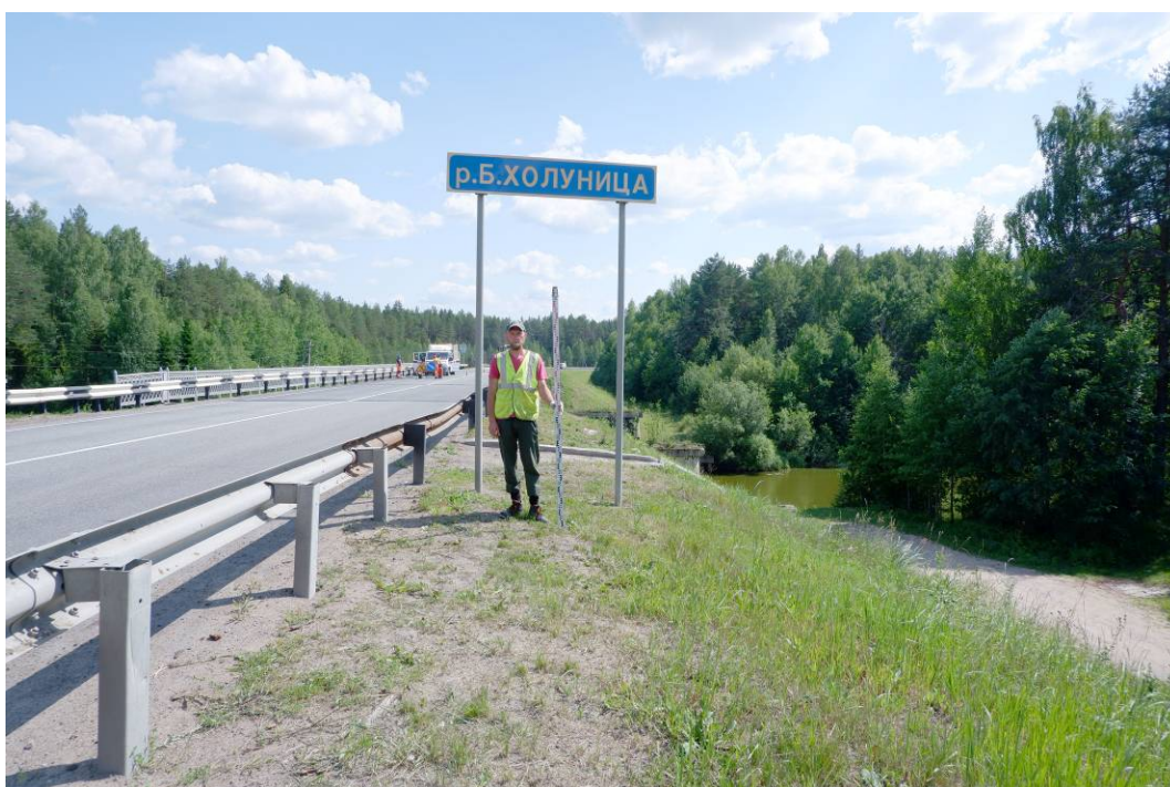
Илл.16. Кировская область, Белохолуницкий район. Земельный участок, отводимый под объект: ««Капитальный ремонт моста через р. Белая Холуница на км 677+630 автомобильной дороги Р-243 Кострома-Шарья-Киров-Пермь, Кировская область». Пикет фотосъемки 4. Вид с ССЗ.
