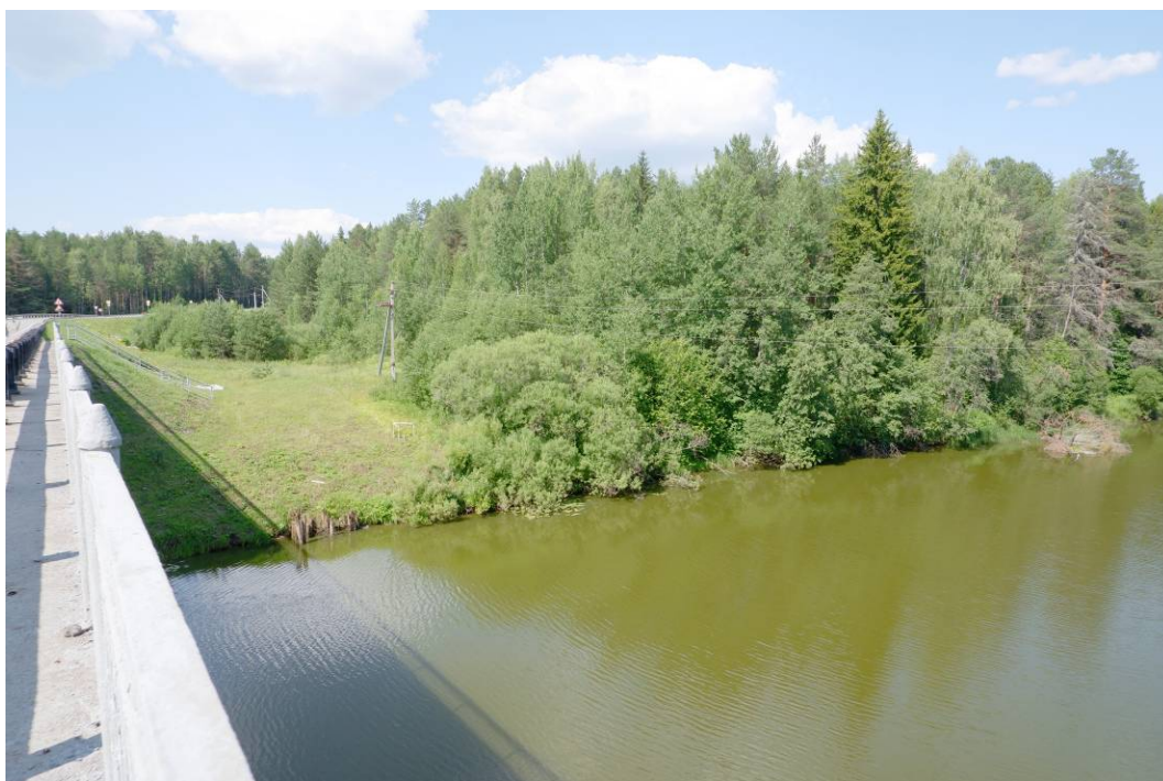
Илл.20. Кировская область, Белохолуницкий район. Земельный участок, отводимый под объект: ««Капитальный ремонт моста через р. Белая Холуница на км 677+630 автомобильной дороги Р-243 Кострома-Шарья-Киров-Пермь, Кировская область». Пикет фотосъемки 6. Вид с ЮЮВ.
