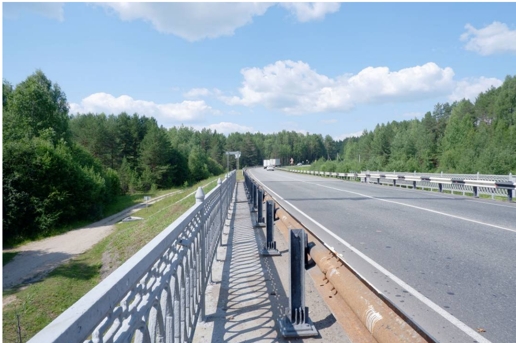
Илл.17. Кировская область, Белохолуницкий район. Земельный участок, отводимый под объект: ««Капитальный ремонт моста через р. Белая Холуница на км 677+630 автомобильной дороги Р-243 Кострома-Шарья-Киров-Пермь, Кировская область». Пикет фотосъемки 5. Вид с ЮЮВ.
