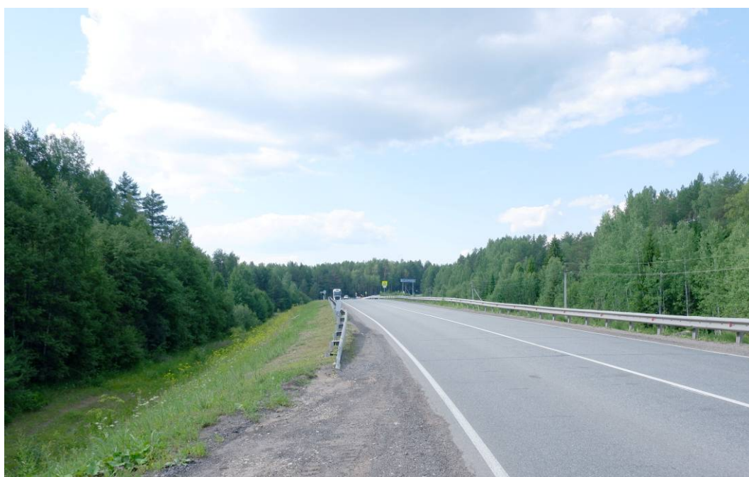
Илл.26. Кировская область, Белохолуницкий район. Земельный участок, отводимый под объект: ««Капитальный ремонт моста через р. Белая Холуница на км 677+630 автомобильной дороги Р-243 Кострома-Шарья-Киров-Пермь, Кировская область». Пикет фотосъемки 8. Вид с ЮЮВ.
