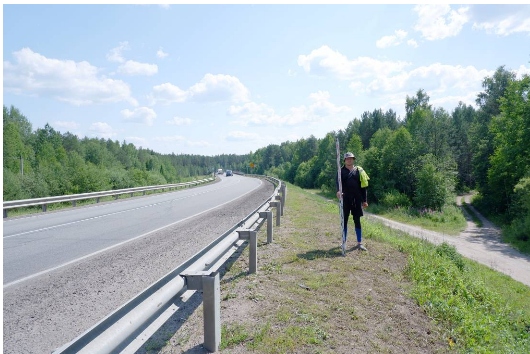
Илл.12. Кировская область, Белохолуницкий район. Земельный участок, отводимый под объект: ««Капитальный ремонт моста через р. Белая Холуница на км 677+630 автомобильной дороги Р-243 Кострома-Шарья-Киров-Пермь, Кировская область». Пикет фотосъемки 3. Вид с ССЗ.
