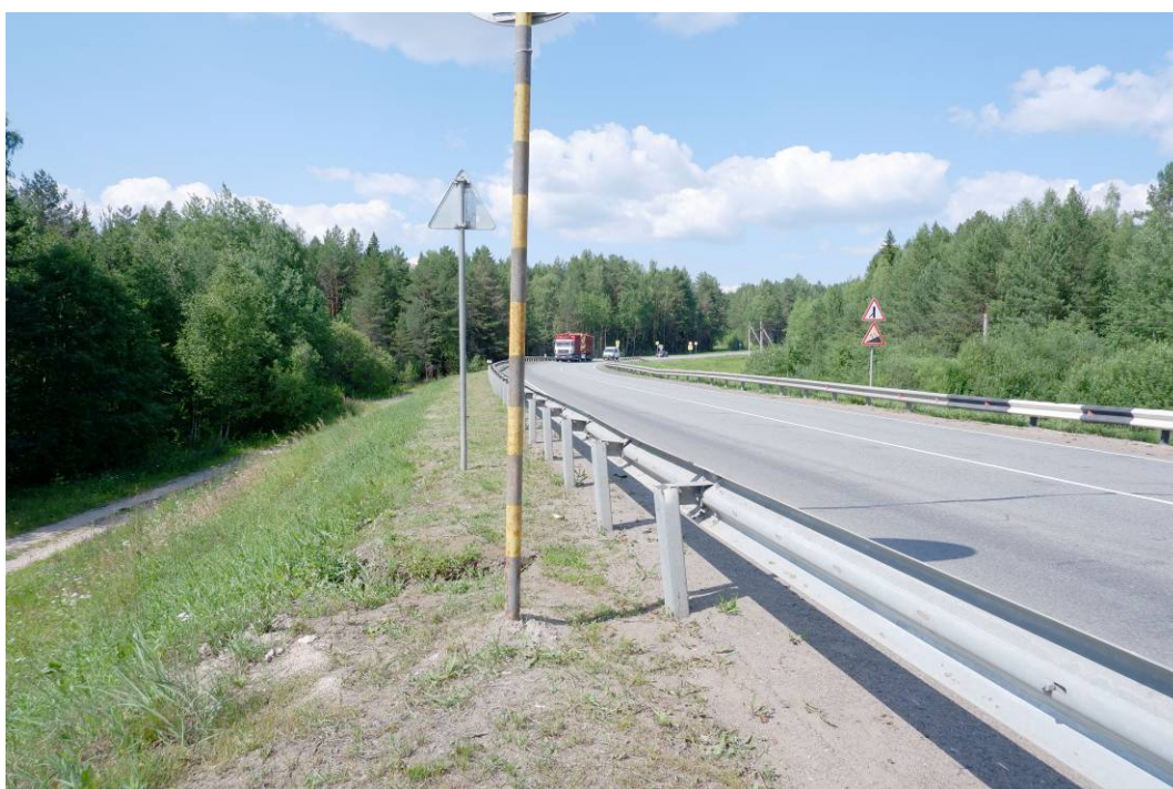
Илл.14. Кировская область, Белохолуницкий район. Земельный участок, отводимый под объект: ««Капитальный ремонт моста через р. Белая Холуница на км 677+630 автомобильной дороги Р-243 Кострома-Шарья-Киров-Пермь, Кировская область». Пикет фотосъемки 4. Вид с ЮЮВ.
