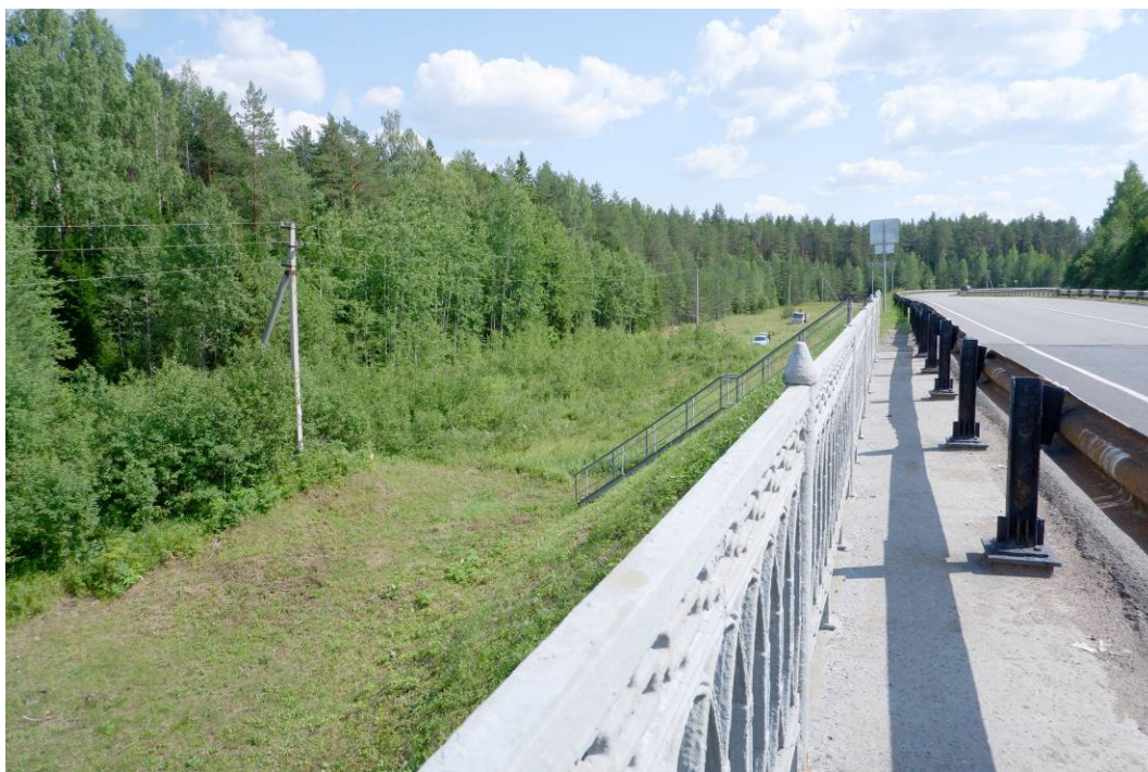
Илл.22. Кировская область, Белохолуницкий район. Земельный участок, отводимый под объект: ««Капитальный ремонт моста через р. Белая Холуница на км 677+630 автомобильной дороги Р-243 Кострома-Шарья-Киров-Пермь, Кировская область». Пикет фотосъемки 6. Вид с ССЗ.
