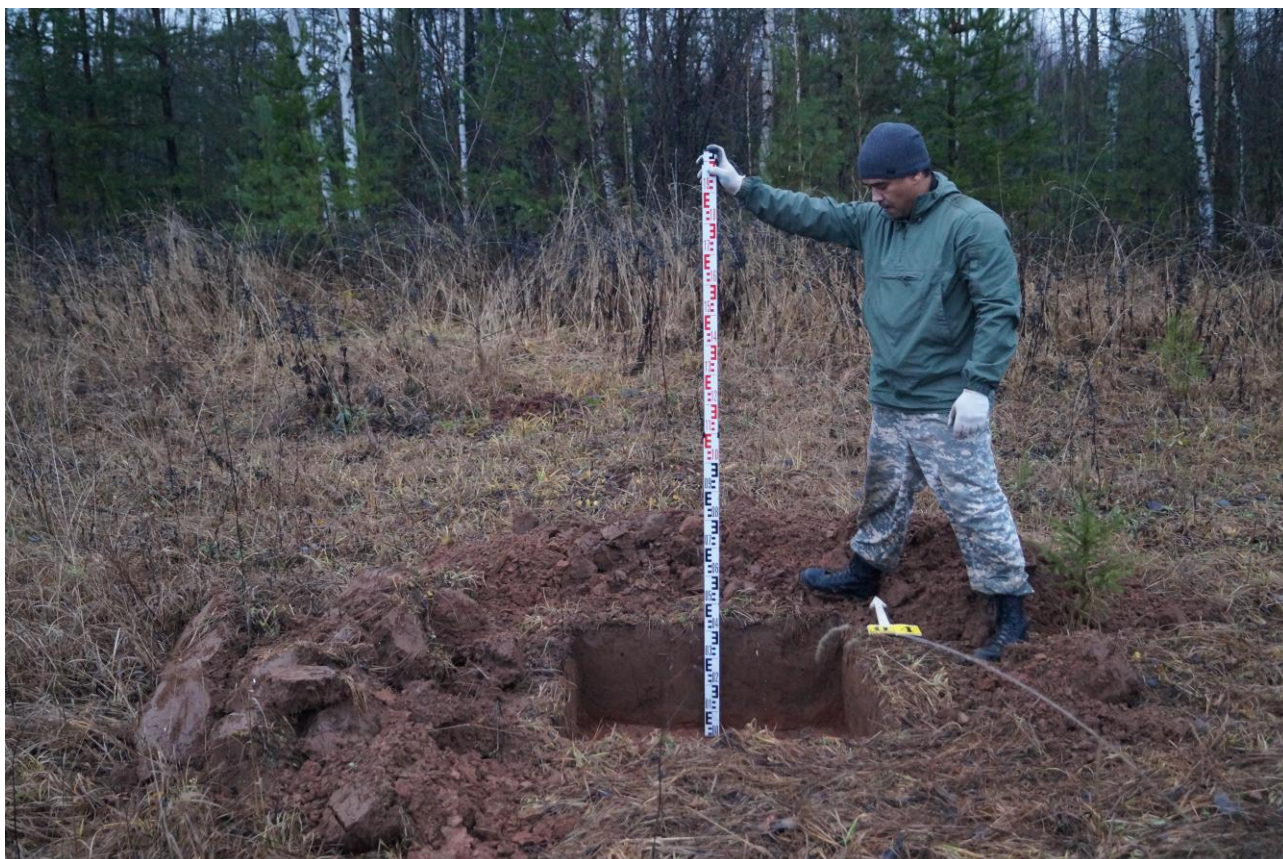
Рис. 31. Кировская область. Куменский район. Объект «Газопровод-отвод и ГРС Нижнеивкино Кировской области». Шурф №4. Общий вид с юга.
