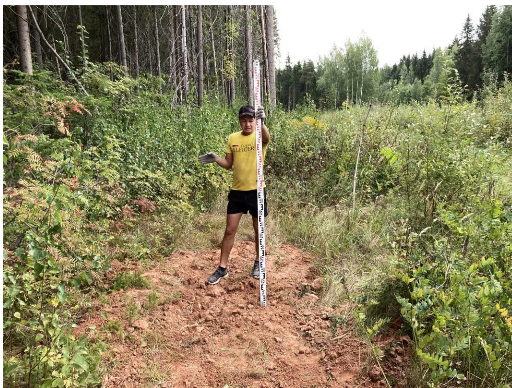
Илл.56. Кировская область, г. Киров. Земельный участок, отводимый под объект: «Реконструкция ГРС ТЭЦ-5».Шурф 5. Рекультивация. Вид с запада.
