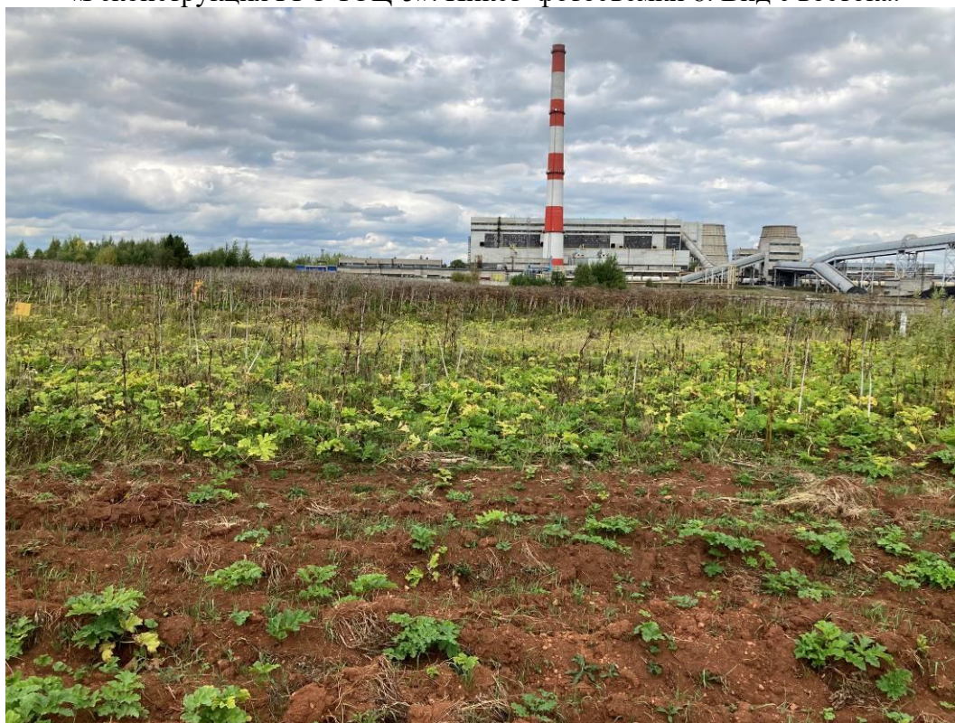
Илл.36. Кировская область, г. Киров. Земельный участок, отводимый под объект: «Реконструкция ГРС ТЭЦ-5». Пикет фотосъемки 8. Вид с юга.
