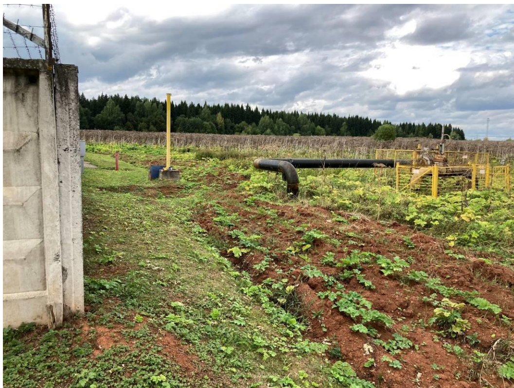
Илл.35. Кировская область, г. Киров. Земельный участок, отводимый под объект: «Реконструкция ГРС ТЭЦ-5». Пикет фотосъемки 8. Вид с востока.
