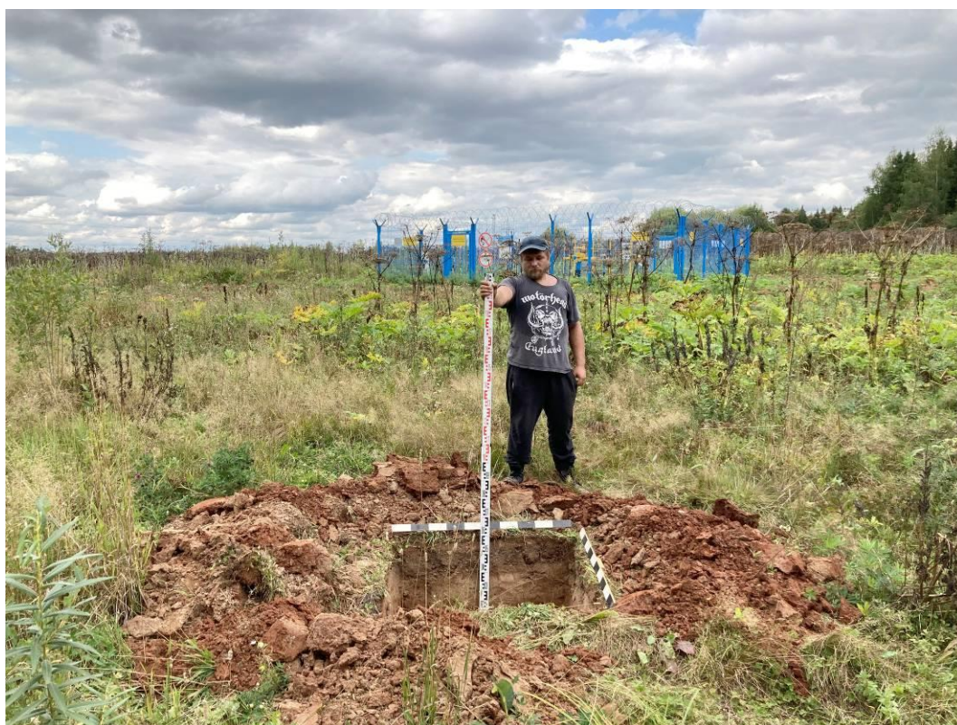
Илл.58. Кировская область, г. Киров. Земельный участок, отводимый под объект: «Реконструкция ГРС ТЭЦ-5».Шурф 6. Общий вид. Вид с юга.
