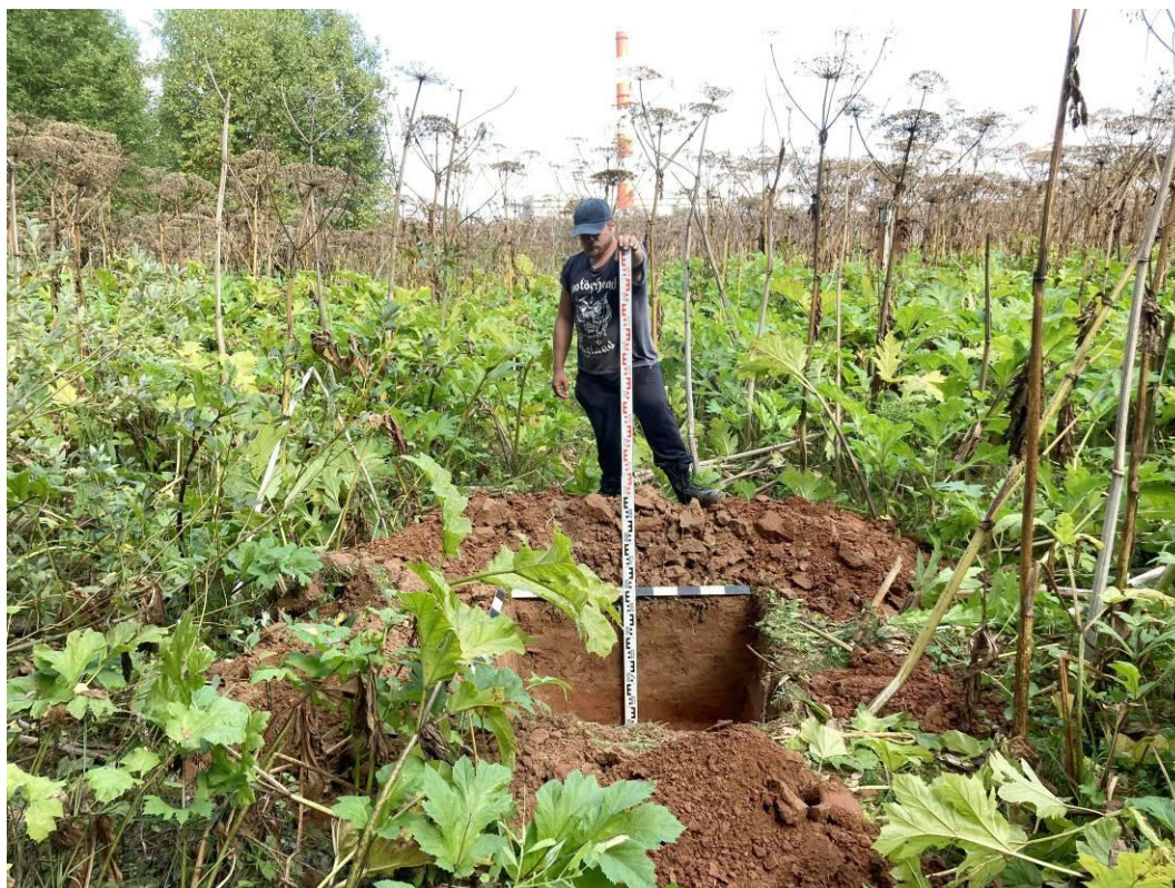
Илл.46. Кировская область, г. Киров. Земельный участок, отводимый под объект: «Реконструкция ГРС ТЭЦ-5».Шурф 3. Общий вид. Вид с юга.
