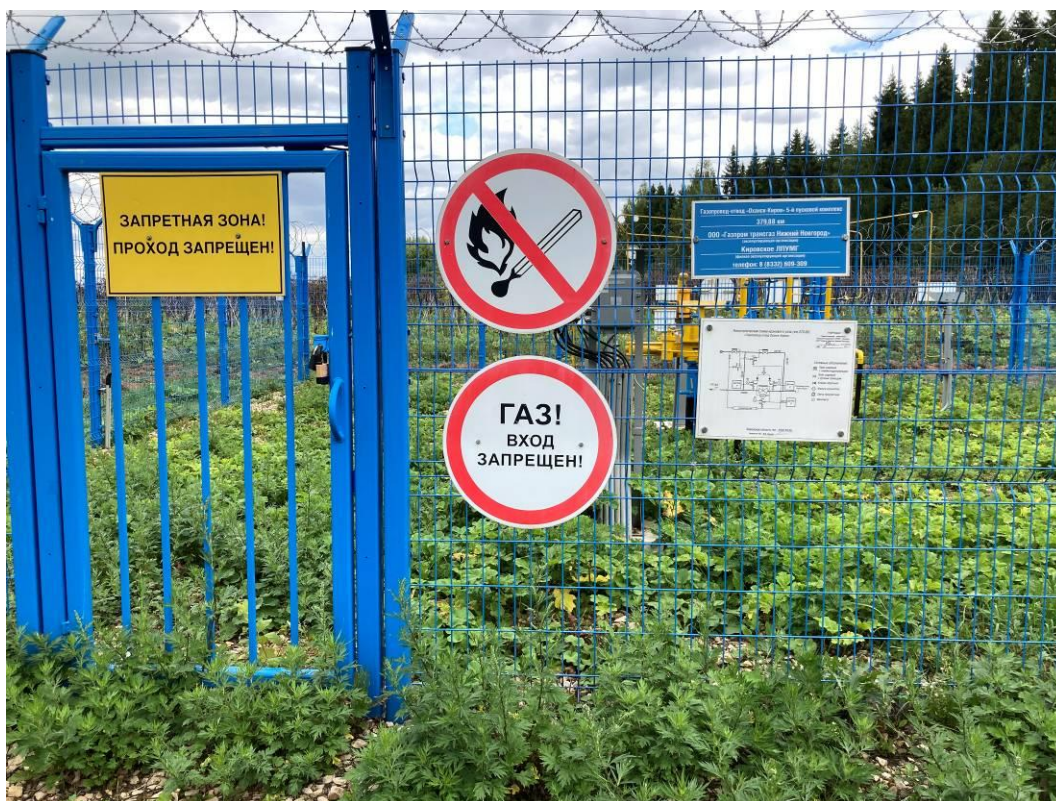
Илл.28. Кировская область, г. Киров. Земельный участок, отводимый под объект: «Реконструкция ГРС ТЭЦ-5». Пикет фотосъемки 6. Вид с юго-юго-запада.
