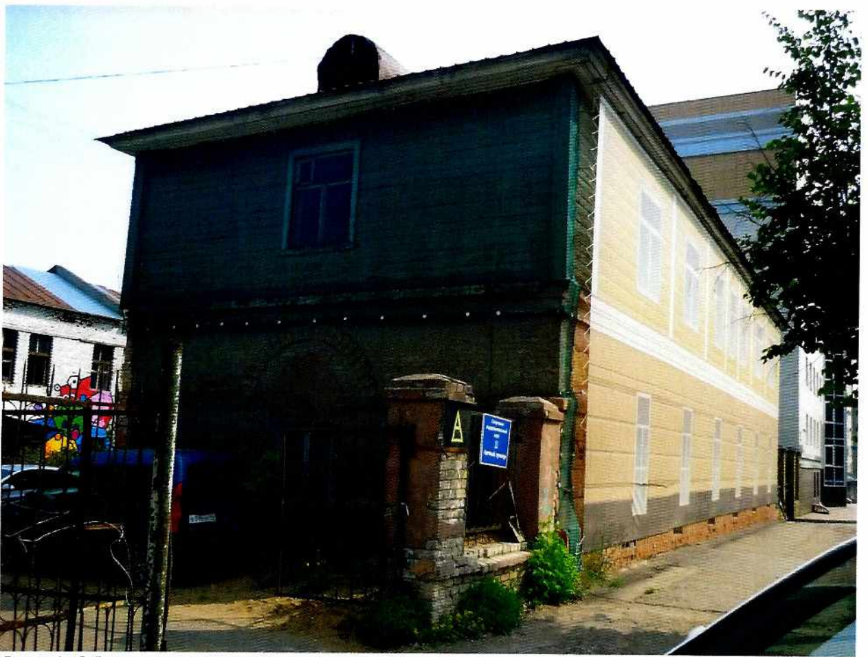
Фото 4. Общий вид с юго-запада на объект культурного наследия. Автор съёмки – Кошелева И.С., дата съёмки – 19 июля 2016 г. Кировская область, г. Киров, ул. Спасская, д.67.
