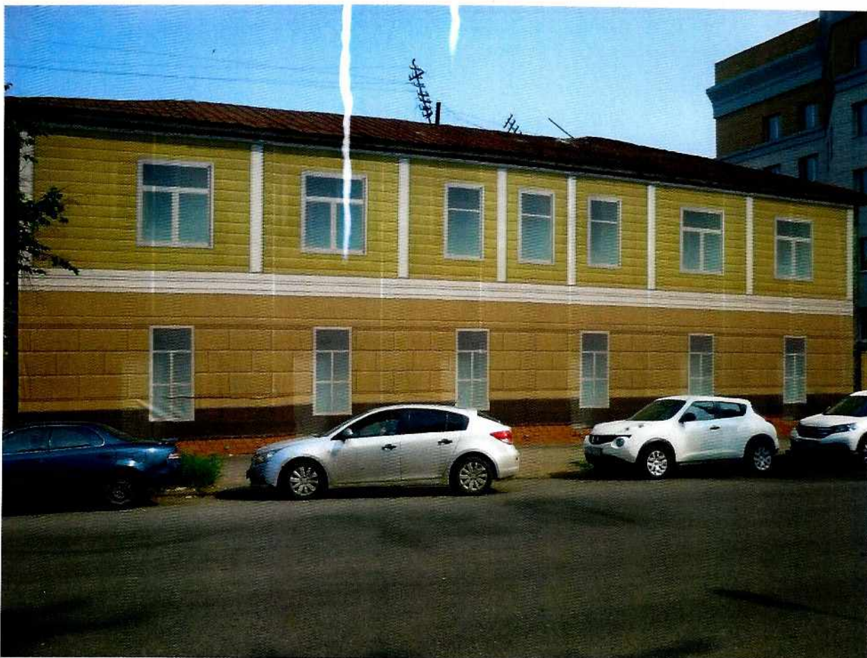
Фото 2. Общий вид с юго-запада на объект культурного наследия. Автор съёмки – Кошелева И.С., дата съёмки – 19 июля 2016 г. Кировская область, г. Киров, ул. Спасская, д.67.
