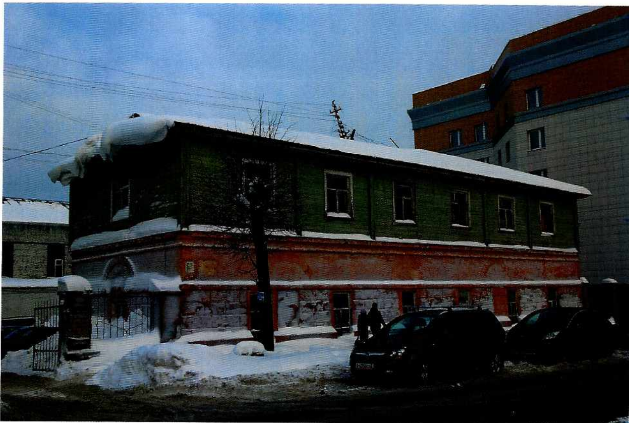
Фото 1. Общий вид с юго-запада на объект культурного наследия. Автор съёмки – Кошелева И.С., дата съёмки – 16 января 2015 г. Кировская область, г. Киров, ул. Спасская, д.67.
