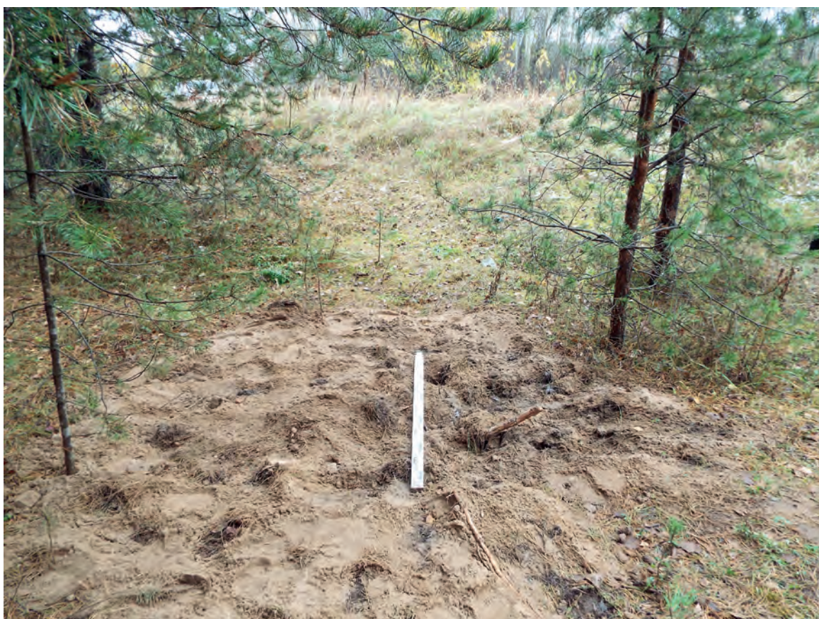
Рис.16. Строительство межпоселкового газопровода к д. Шипицыны Оричевского района Кировской области. Шурф 1. Рекультивация. Вид с Ю.
