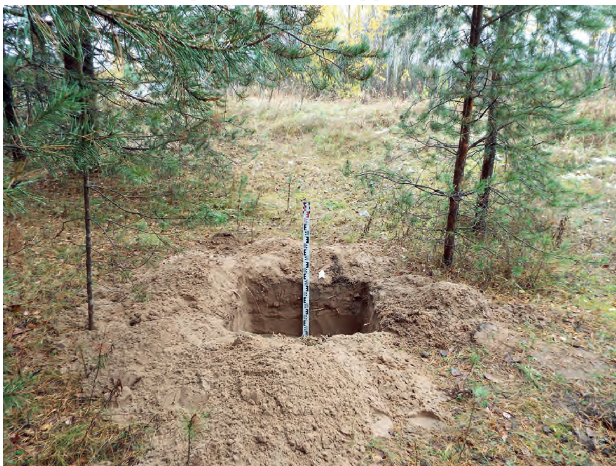
Рис.14. Строительство межпоселкового газопровода к д. Шипицыны Оричевского района Кировской области. Шурф 1. Антураж. Вид с Ю.
