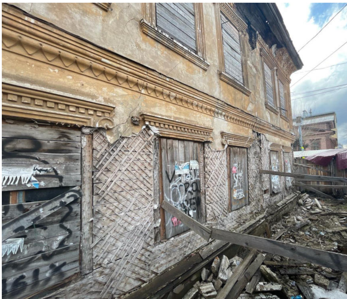
Илл. 35. Облицовка северного фасада на момент обследования. Фото Д.В. Марьин, 2026 г.
