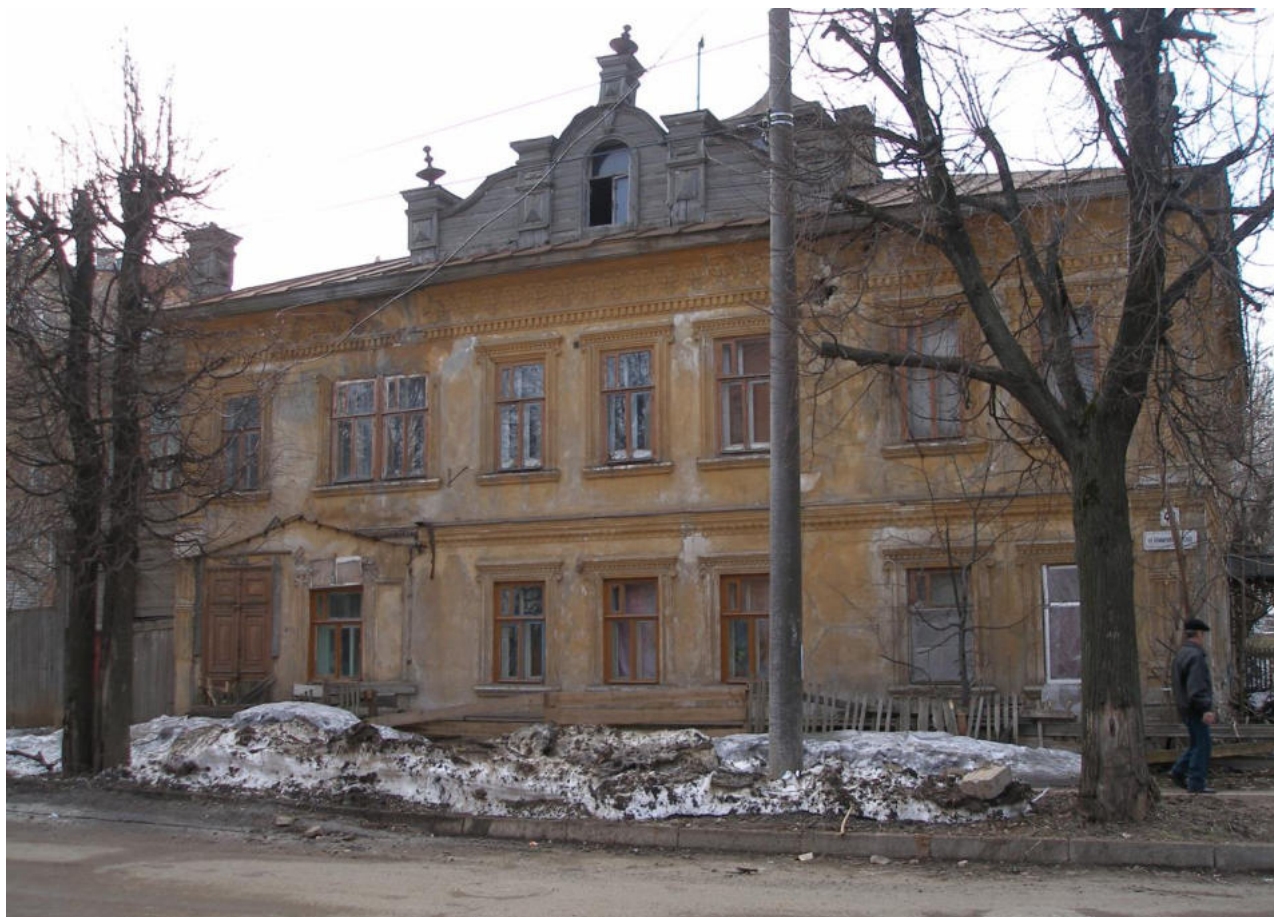
Фото 7. Объект. Вид с Орловской на северный фасад. Дата съемки – 2008 г., автор съемки – Бойчук М.Н.
