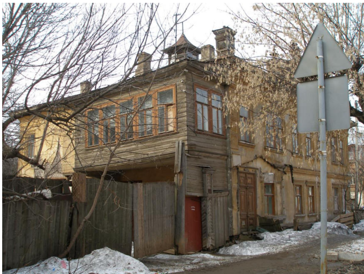
Фото 10. Объект. Восточный (дворовый) и северный (уличный) фасады. Вид с ул. Орловской, с северо-востока. Дата съемки – 2008 г., автор съемки – Бойчук М.Н.
