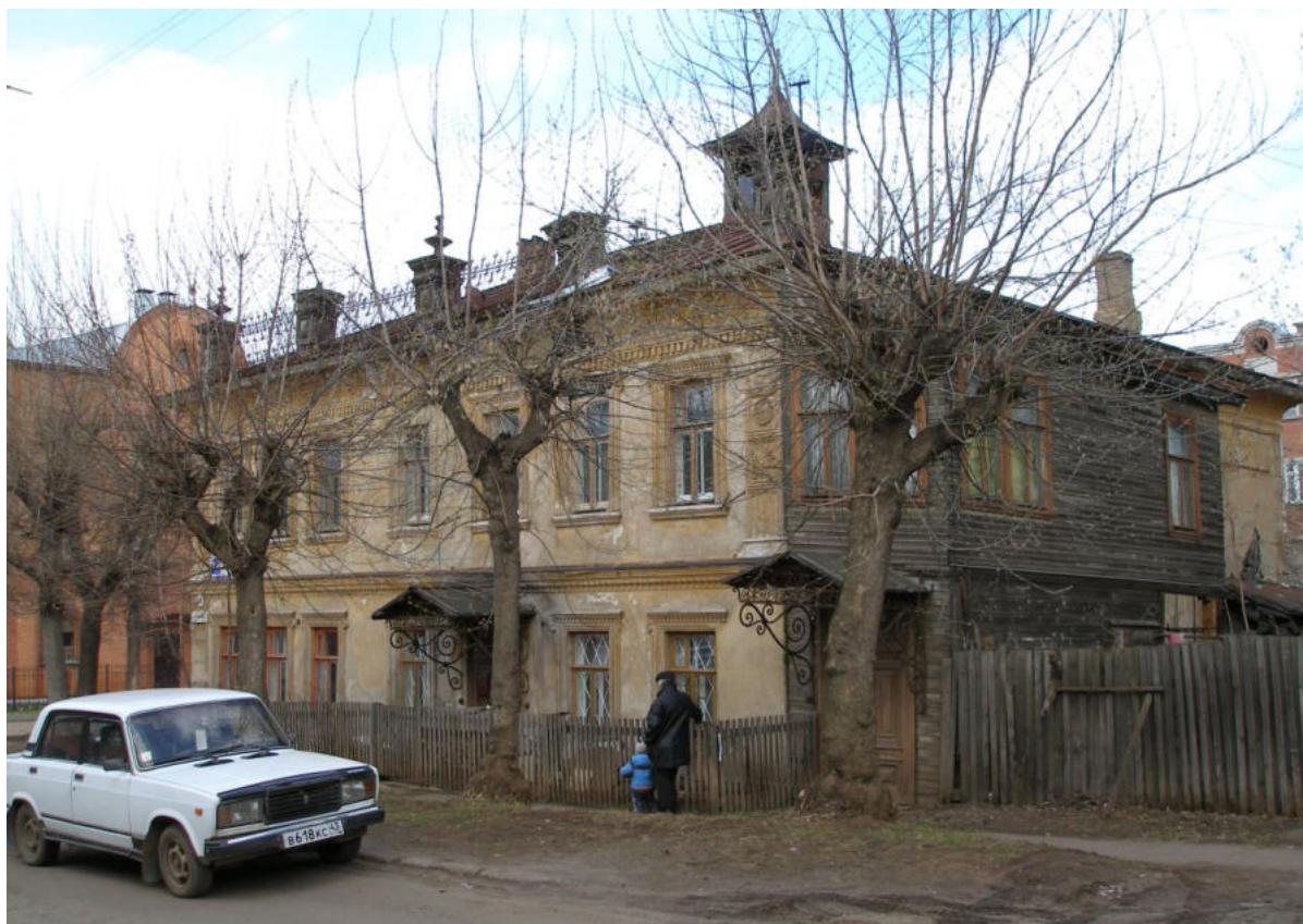
Фото 9. Объект. Западный (уличный) и южный фасады. Вид с ул. Никитской, с юго-запада. Дата съемки – 2008 г., автор съемки – Бойчук М.Н.
