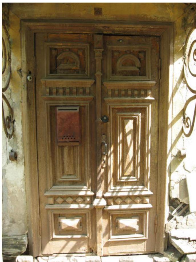
Фото 12. Заполнение дверного проема основного объема западного фасада. Дата съемки – 2007 г., автор съемки – Титова Г.В.
