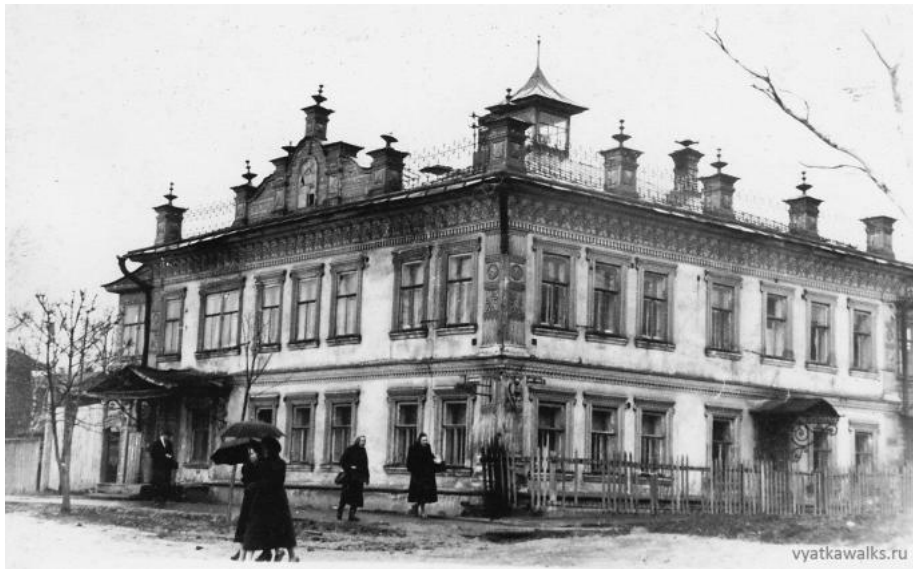
Илл. 24. Уникальная форма крыши с ее декоративными элементами и кованые элементы козырьков. Фото 1958 г.
