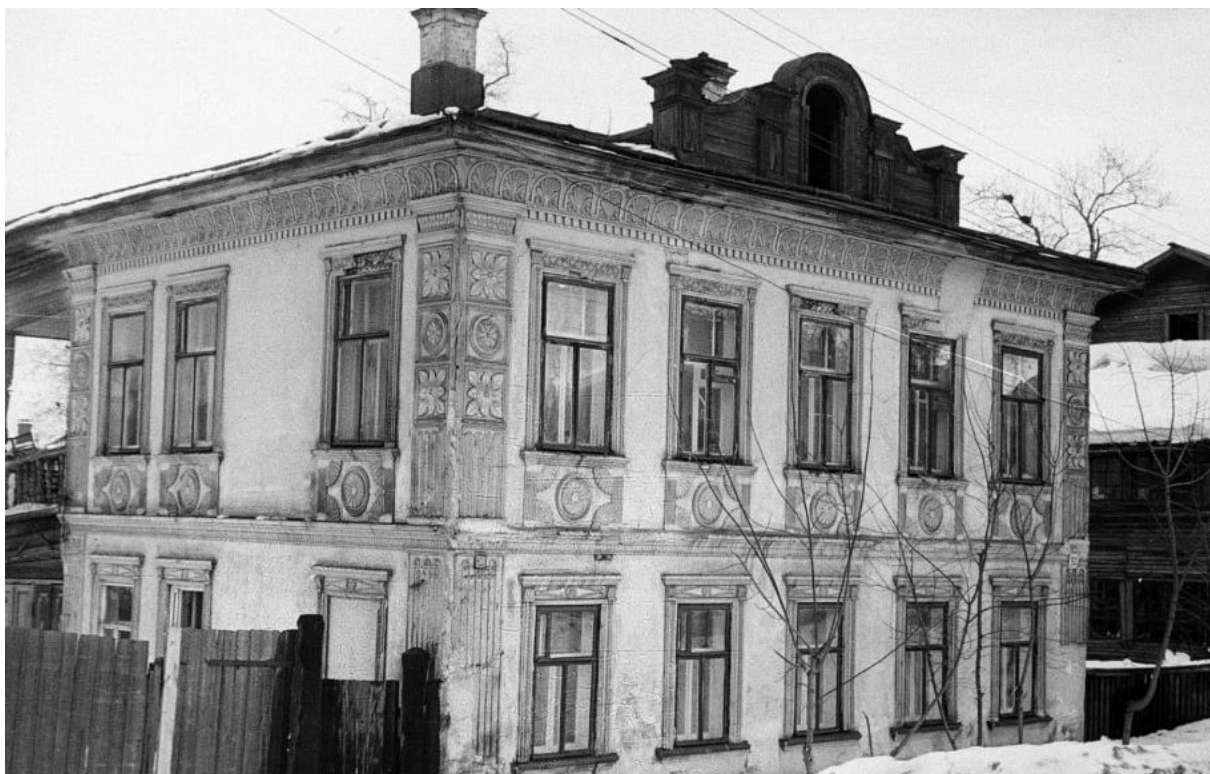
Илл. 18. Флигель Н. И. Семакова (1910-1911 гг.), ул. Дерендяева, 50 (снесен в 1987 г.). Дом с наружной отделкой лепными украшениями, выполненной артелью Н. Г. Джмухадзе. Дата съемки – 1975 г., автор съемки – Горин Леонид
