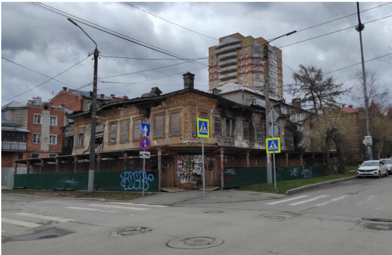
Фото 15. Объект. Вид с перекрестка улиц Орловской и Никитской. Дата съемки – 2026 г., автор съемки – Баруткина Е.Е.
