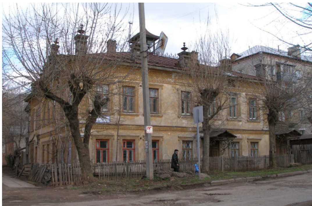
Илл. 13. Дом Е.Д. Мышкина. Вид с северо-запада. Фото М.Н. Бойчук, 2008 г.
