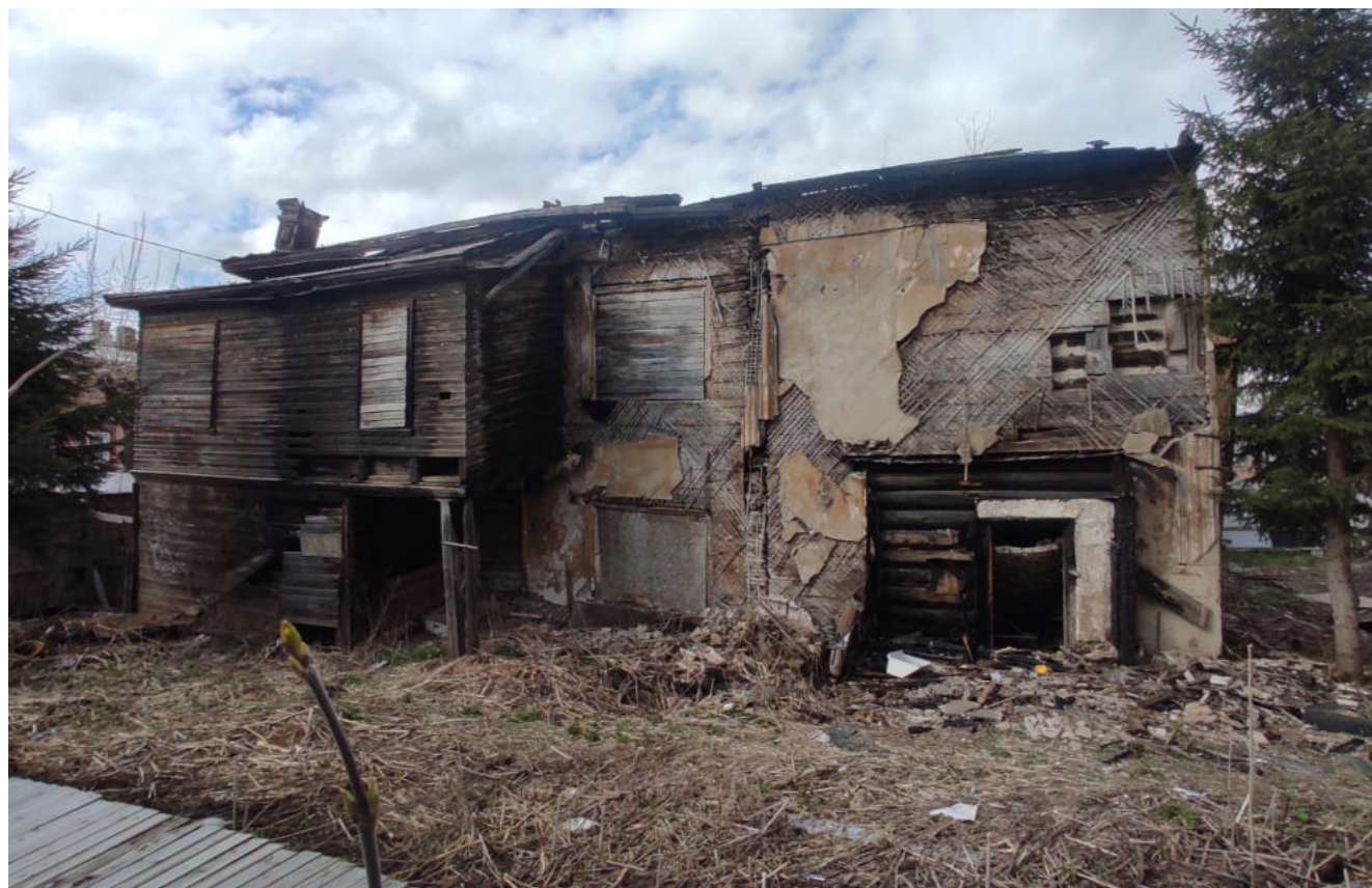
Фото 18. Южный фасад Объекта. Дата съемки – 2026 г., автор съемки – Баруткина Е.Е.
