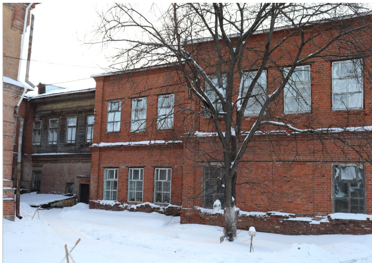
Фото 6. Общий вид дворовых фасадов.
