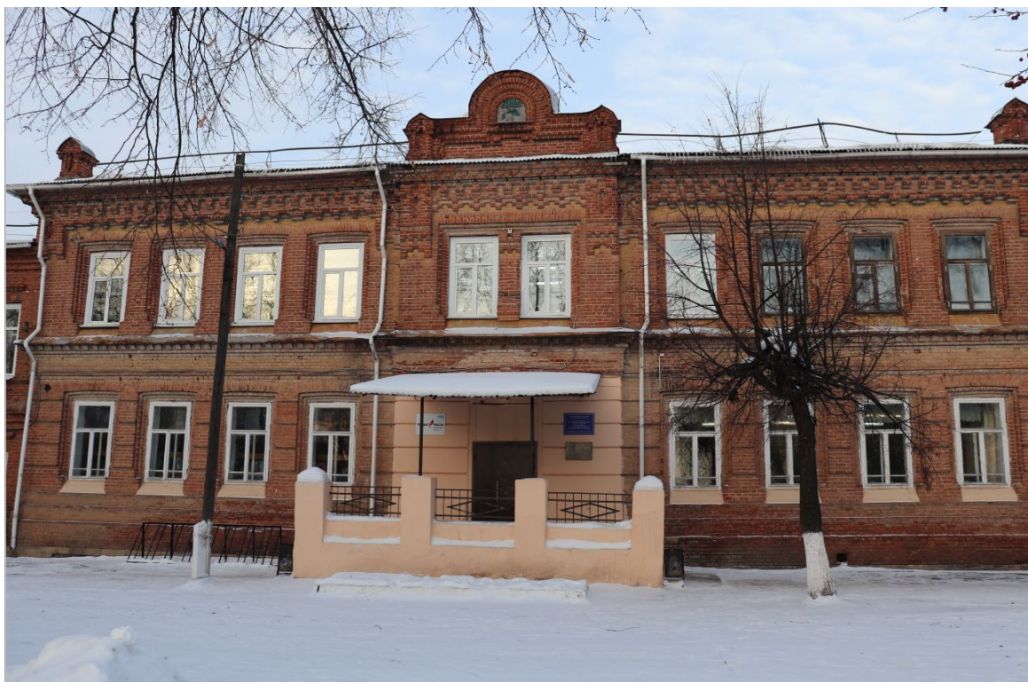
Фото 1. Главный (южный) фасад по ул. Гоголя.
