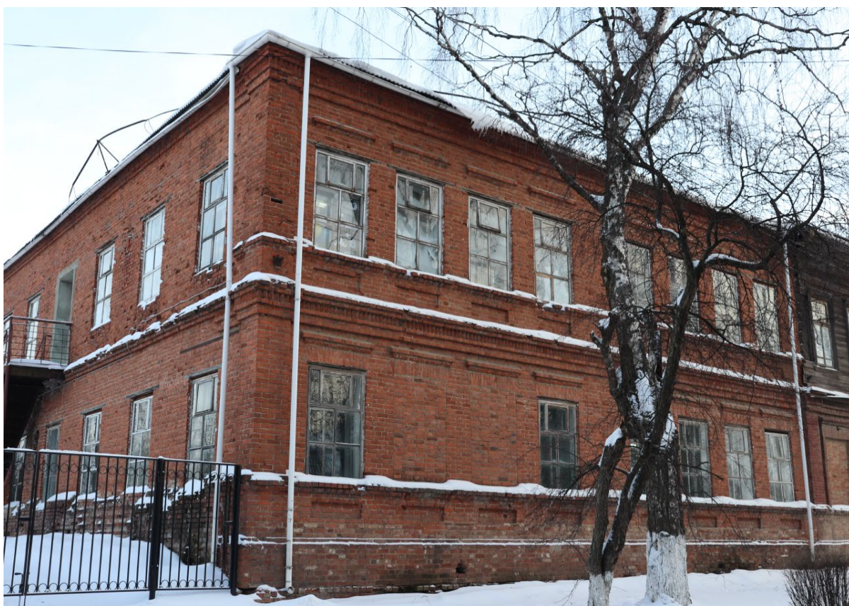
Фото 4. Вид на северо-западный угол здания (фрагмент западного и северного фасада).
