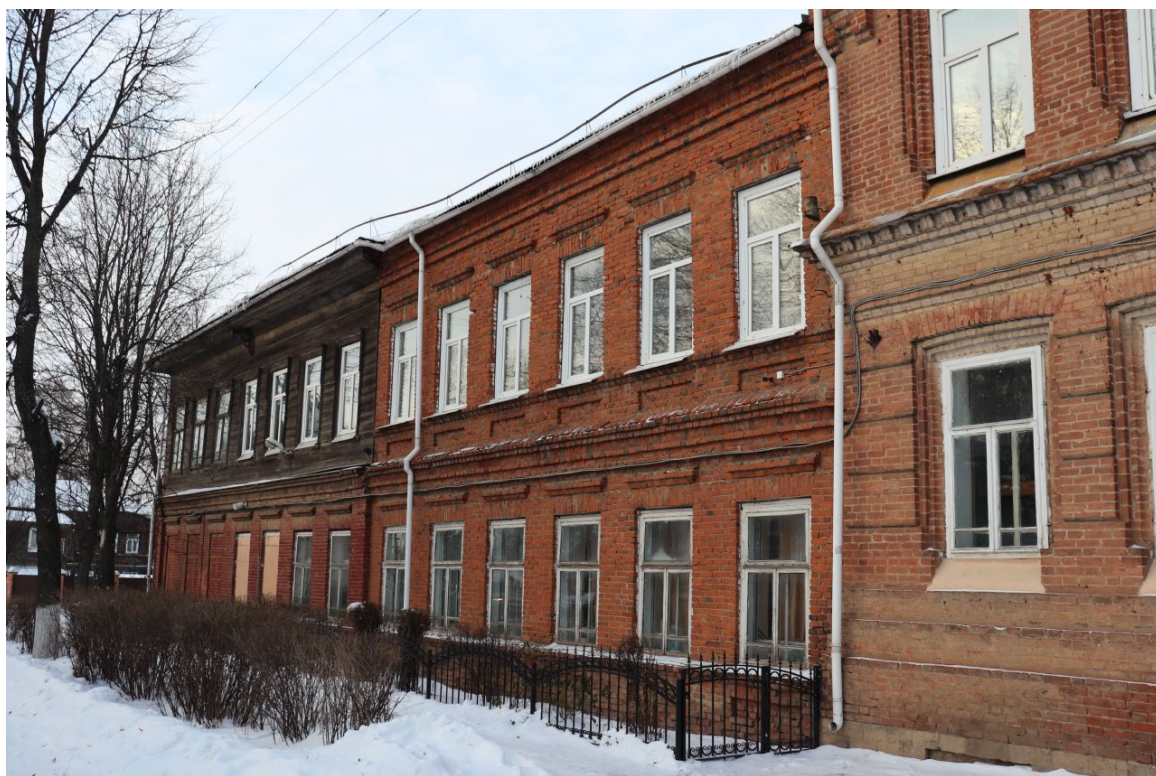
Фото 2. Главный (южный) фасад по ул. Гоголя.
