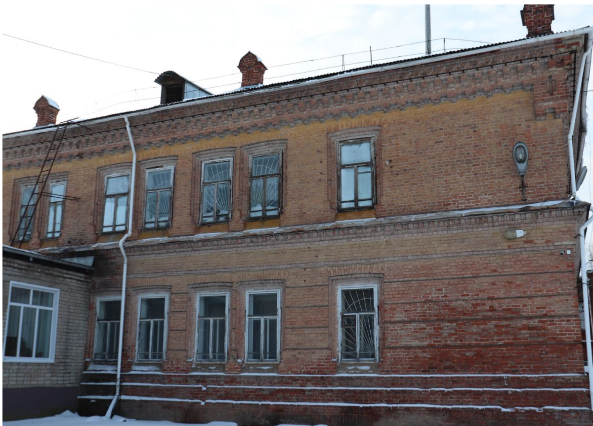
Фото 3. Фрагмент восточного фасада здания. Вид со двора.
