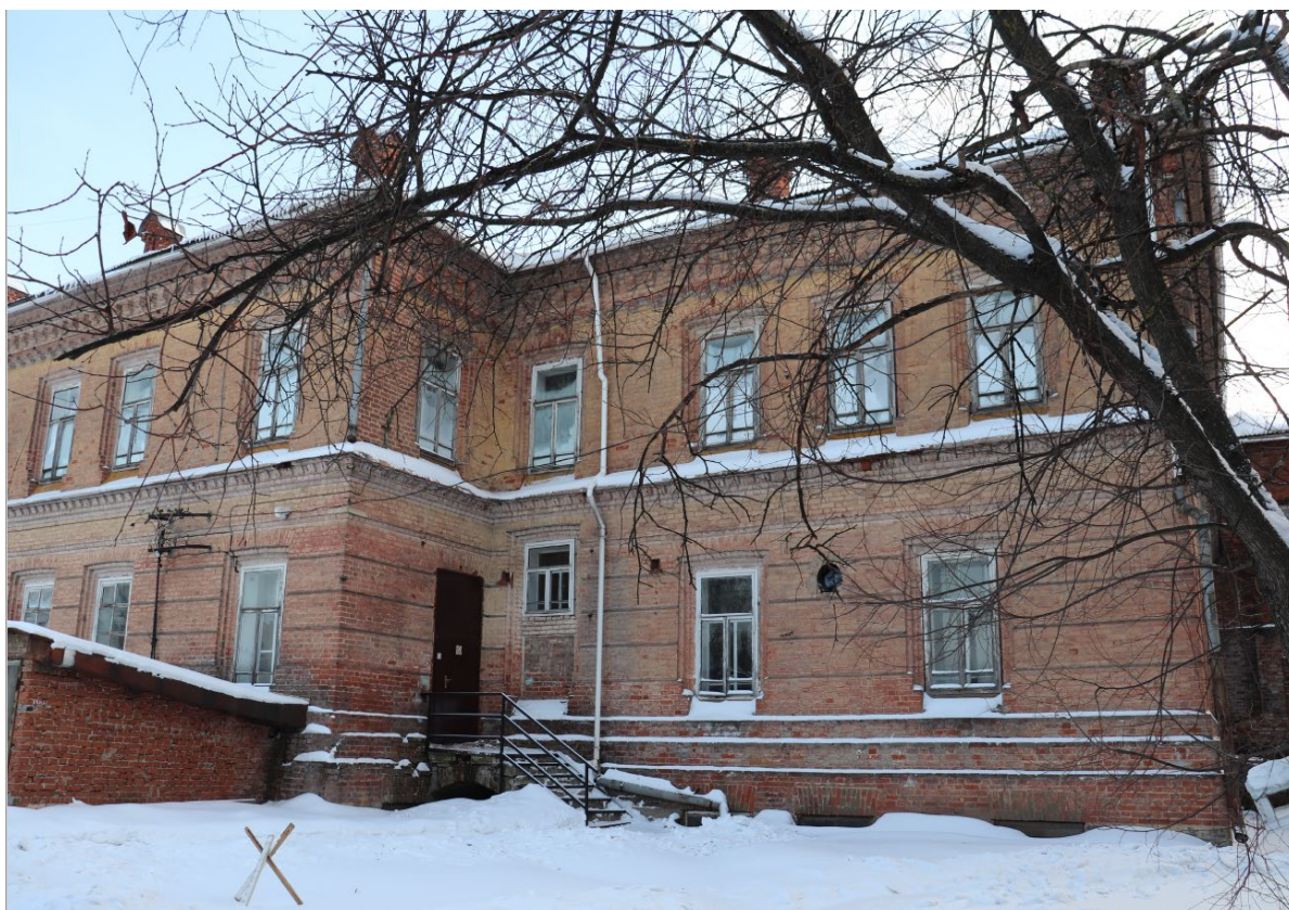
Фото 5. Фрагмент северного (дворового) фасада здания.
