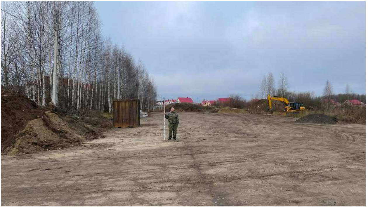
Рис. 9. Фото. Фотофиксация местности на земельном участке с кадастровым номером 43:40:000070:2623 в зоне строительства общеобразовательной школы на 1100 учащихся с бассейном и помещениями физкультурно-оздоровительного назначения в районе п. Ганино в г. Кирове Кировской области. ТФ 1. Вид с востока.
