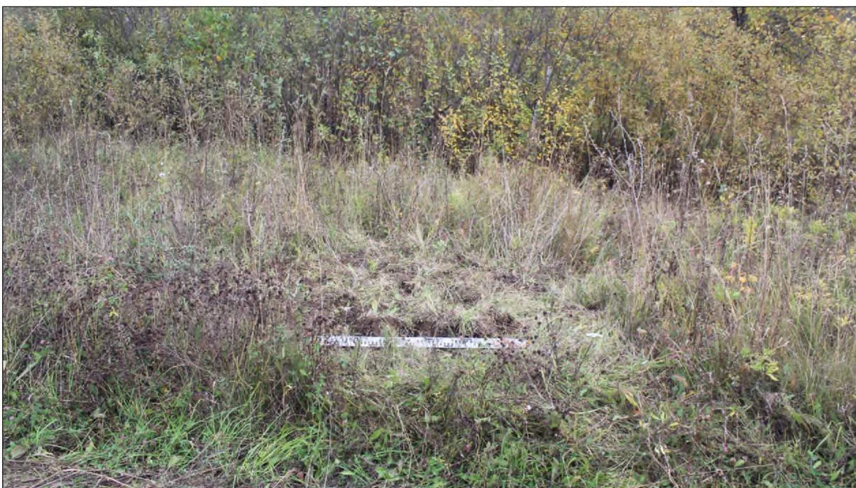
Рис. 37. "Межпоселковый газопровод от ГРС Марийский НПЗ до пгт Килемары Республики Марий Эл". Этап 3 Строительство межпоселкового газопровода от пгт Санчурск Кировской области до границы Республики Марий Эл. Шурф 4. Рекультивация. Вид с запада.
