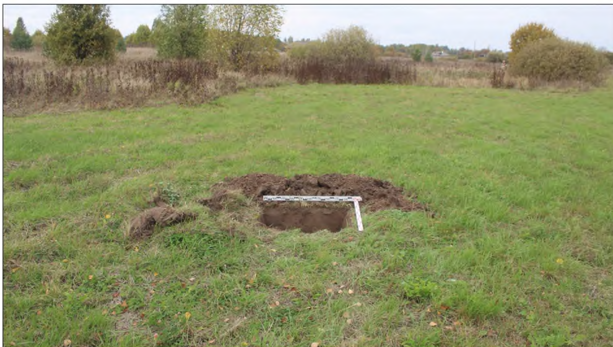
Рис. 27. "Межпоселковый газопровод от ГРС Марийский НПЗ до пгт Килемары Республики Марий Эл". Этап 3 Строительство межпоселкового газопровода от пгт Санчурск Кировской области до границы Республики Марий Эл. Шурф 2. Вид с юга.
