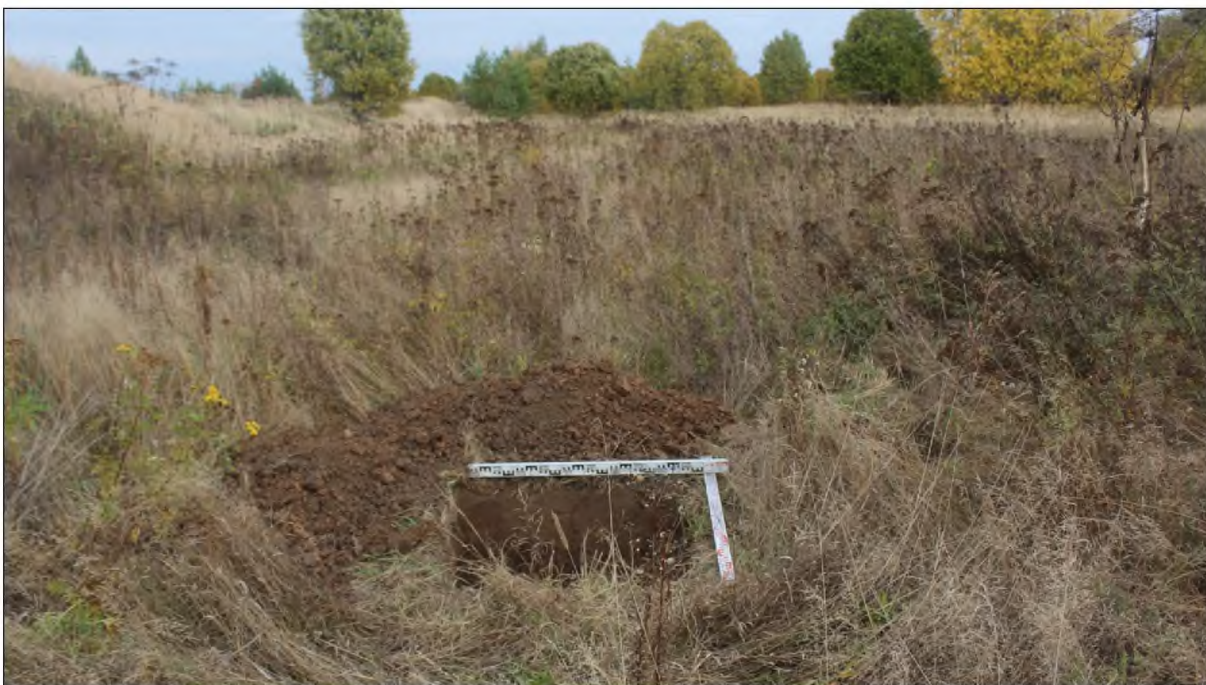
Рис. 51. "Межпоселковый газопровод от ГРС Марийский НПЗ до пгт Килемары Республики Марий Эл". Этап 3 Строительство межпоселкового газопровода от пгт Санчурск Кировской области до границы Республики Марий Эл. Шурф 8. Вид с запада.
