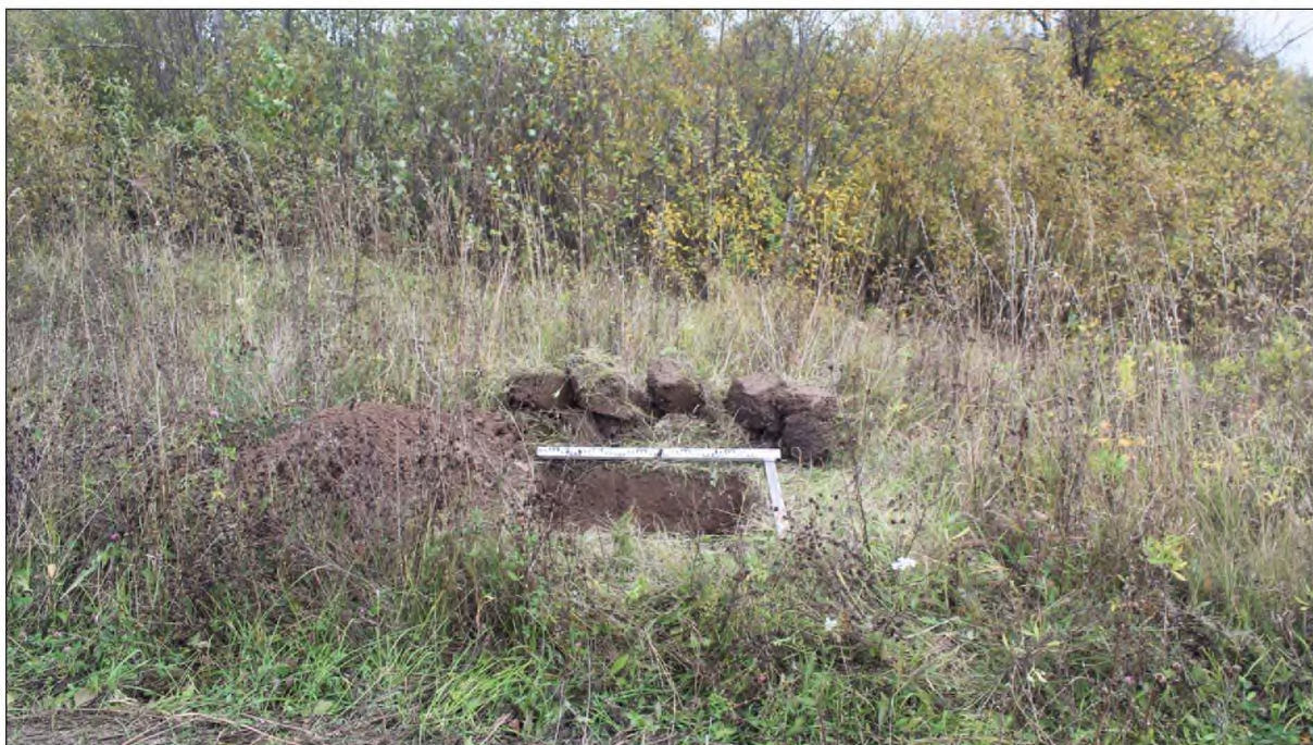
Рис. 35. "Межпоселковый газопровод от ГРС Марийский НПЗ до пгт Килемары Республики Марий Эл". Этап 3 Строительство межпоселкового газопровода от пгт Санчурск Кировской области до границы Республики Марий Эл. Шурф 4. Вид с запада.
