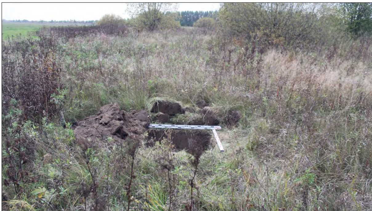
Рис. 31. "Межпоселковый газопровод от ГРС Марийский НПЗ до пгт Килемары Республики Марий Эл". Этап 3 Строительство межпоселкового газопровода от пгт Санчурск Кировской области до границы Республики Марий Эл. Шурф 3. Вид с востока.
