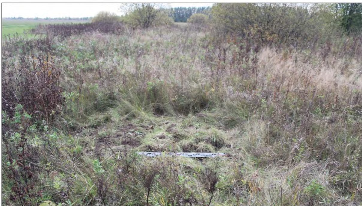
Рис. 33. "Межпоселковый газопровод от ГРС Марийский НПЗ до пгт Килемары Республики Марий Эл". Этап 3 Строительство межпоселкового газопровода от пгт Санчурск Кировской области до границы Республики Марий Эл. Шурф 3. Рекультивация. Вид с востока.
