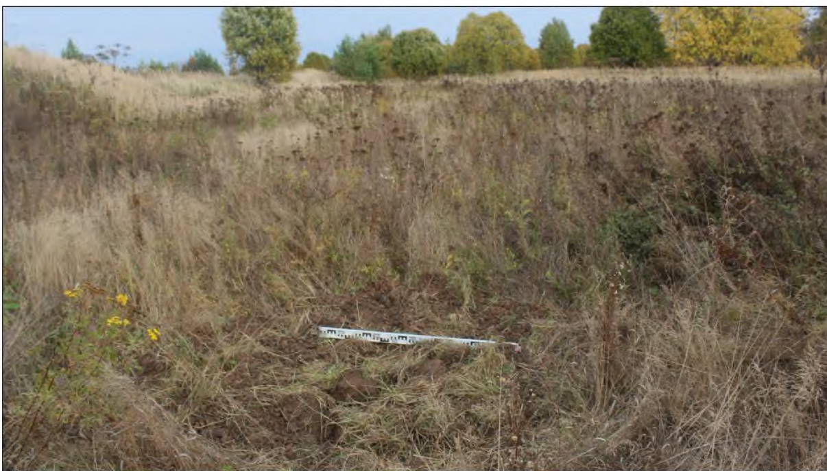
Рис. 53. "Межпоселковый газопровод от ГРС Марийский НПЗ до пгт Килемары Республики Марий Эл". Этап 3 Строительство межпоселкового газопровода от пгт Санчурск Кировской области до границы Республики Марий Эл. Шурф 8. Рекультивация. Вид с запада.
