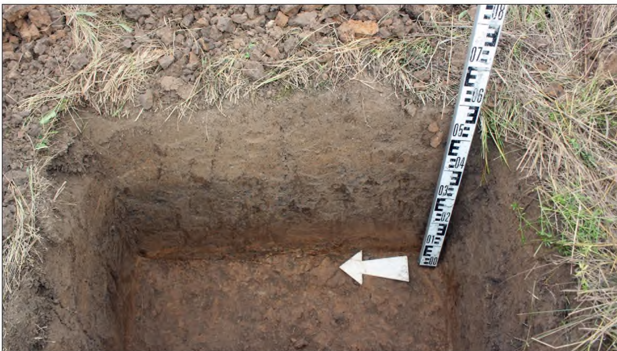
Рис. 52. "Межпоселковый газопровод от ГРС Марийский НПЗ до пгт Килемары Республики Марий Эл". Этап 4. Строительство межпоселкового газопровода от границы Республики Марий Эл до пгт Килемары Республики Марий Эл. Шурф 8. Стратиграфия. Восточная стенка, вид с запада.
