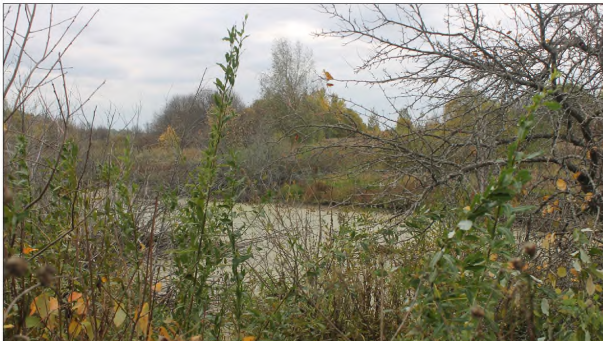
Рис. 14. "Межпоселковый газопровод от ГРС Марийский НПЗ до пгт Килемары Республики Марий Эл". Этап 3 Строительство межпоселкового газопровода от пгт Санчурск Кировской области до границы Республики Марий Эл. Точка фотофиксации 4. Вид с юго-запада.
