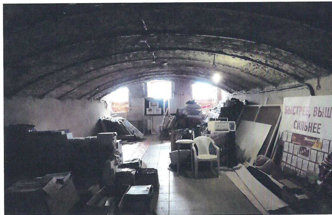
Фото 17. Коробовые своды помещений цокольного этажа. Фотосъемка 2021 г.
