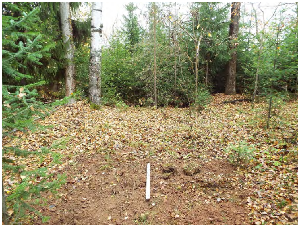
Рис.17. Строительство межпоселкового газопровода к д. Ложкины Кирово-Чепецкого района Кировской области. Шурф 1. Рекультивация. Вид с Ю.
