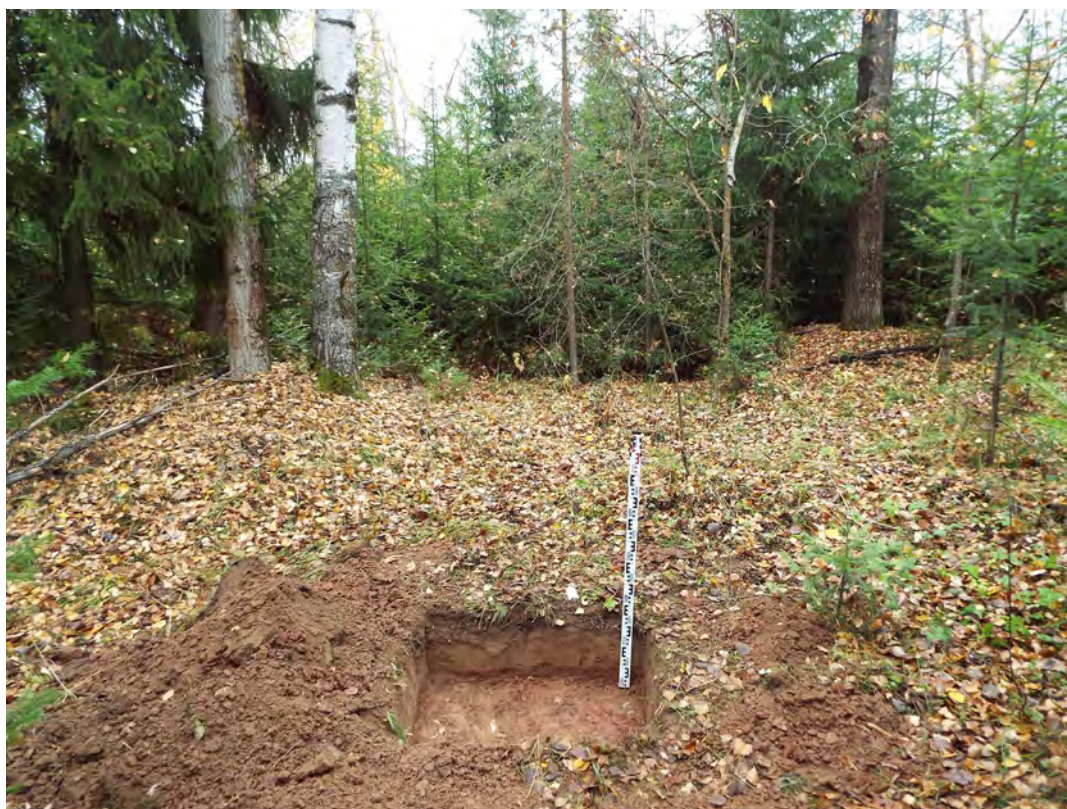
Рис.15. Строительство межпоселкового газопровода к д. Ложкины Кирово-Чепецкого района Кировской области. Шурф 1. Антураж. Вид с Ю.
