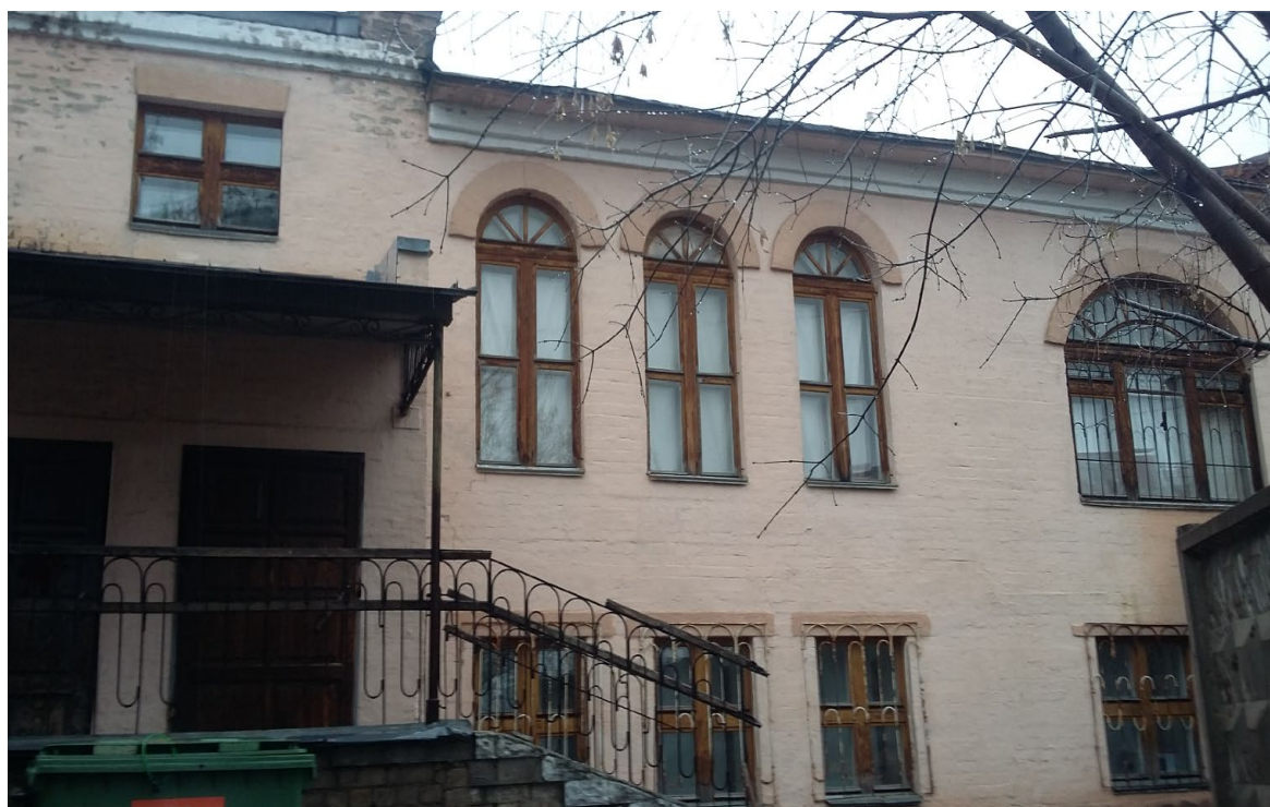
Фото 4. Фрагмент дворового фасада.
