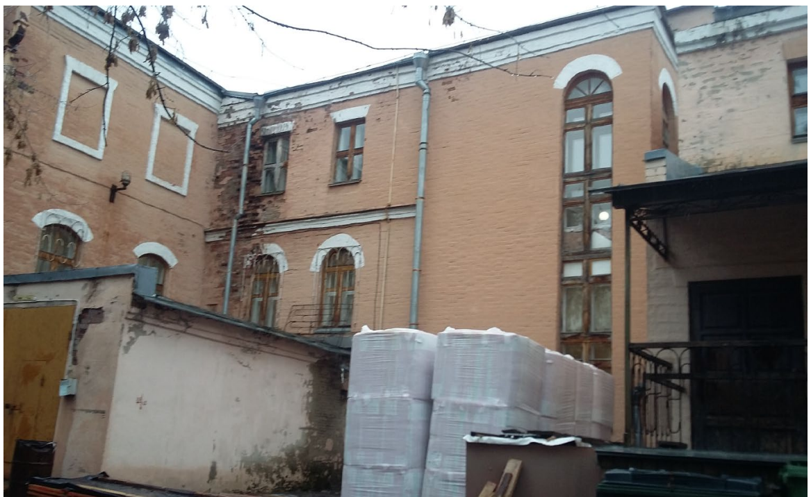
Фото 6. Фрагмент дворового фасада.
