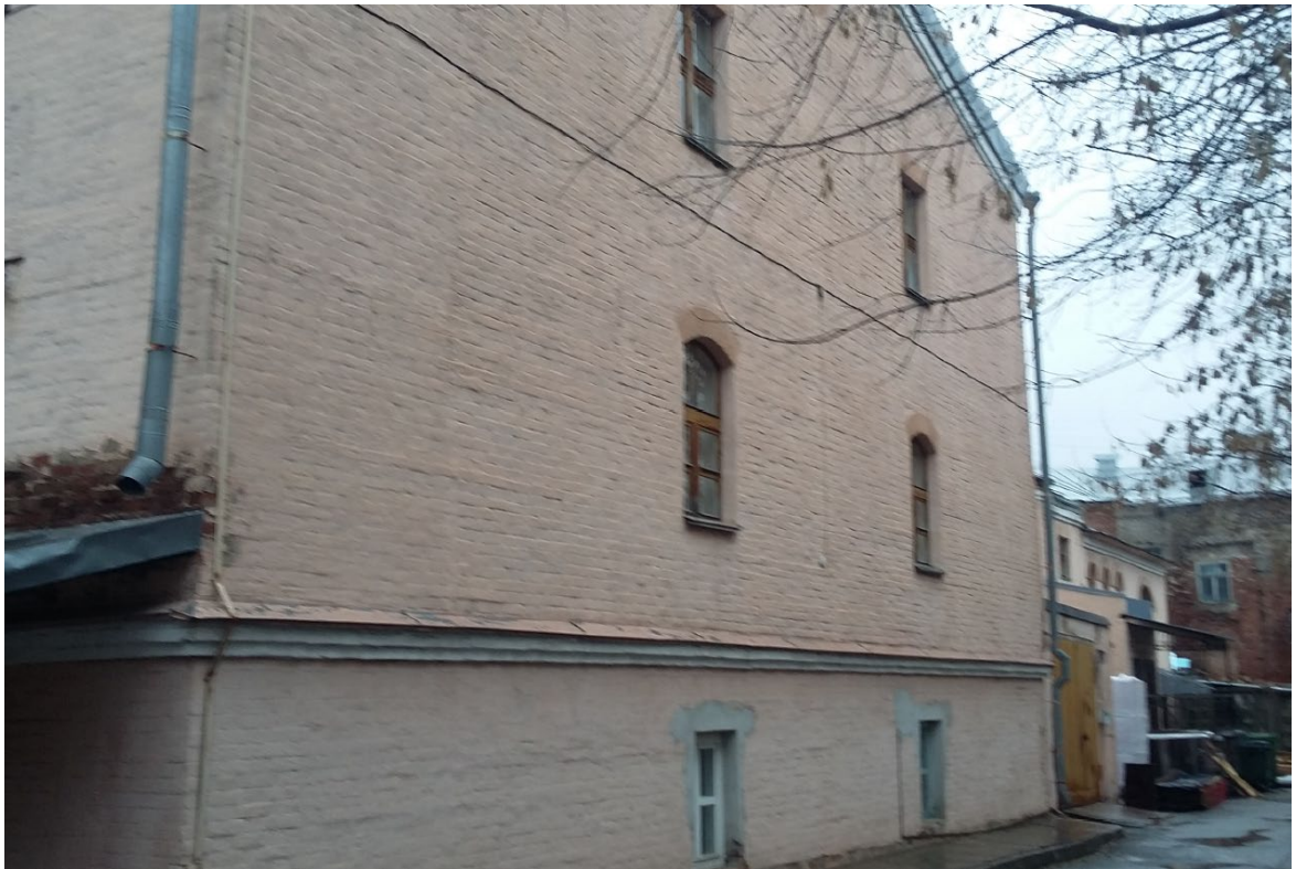
Фото 5. Фрагмент дворового фасада.
