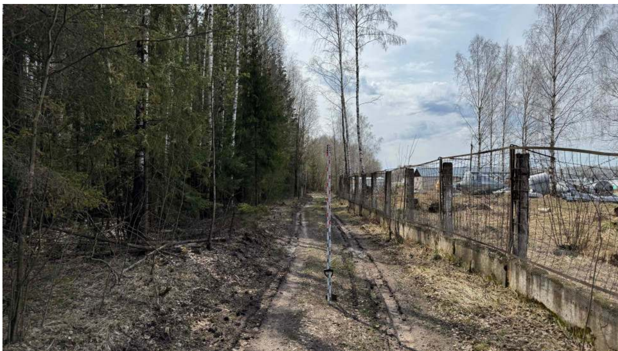
Рис. 92. Фото. Фотофиксация местности на земельных участках в зоне строительства напорного коллектора ОСК Лянгасово – КНС пос. Костино г. Кирова Кировской области. ТФ 31. Вид с северо-востока.
