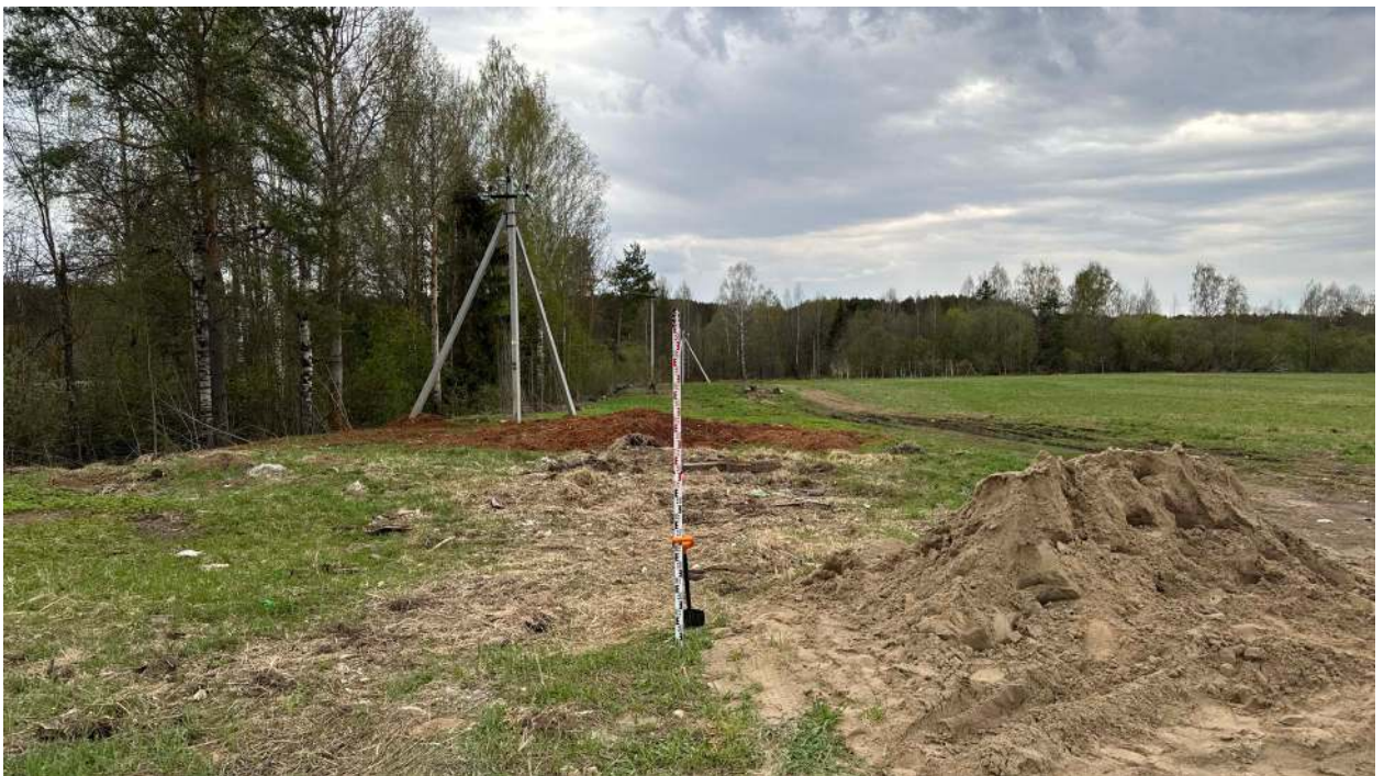
Рис. 47. Фото. Фотофиксация местности на земельных участках в зоне строительства напорного коллектора ОСК Лянгасово – КНС пос. Костино г. Кирова Кировской области. ТФ 6. Вид с северо-востока.
