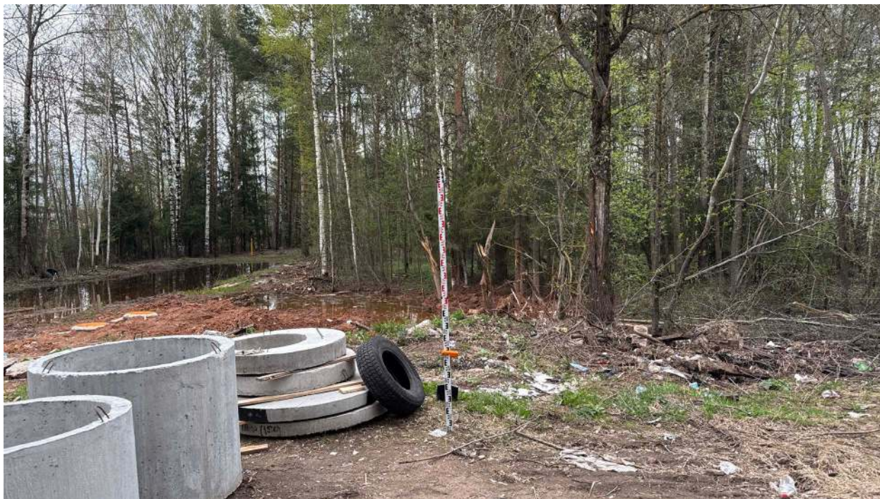
Рис. 50. Фото. Фотофиксация местности на земельных участках в зоне строительства напорного коллектора ОСК Лянгасово – КНС пос. Костино г. Кирова Кировской области. ТФ 8. Вид с юго-востока.
