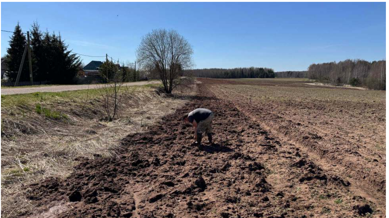
Рис. 35. Фото. Поиск подъемного материала на земельных участках в зоне строительства напорного коллектора ОСК Лянгасово – КНС пос. Костино г. Кирова Кировской области. Вид с юга.
