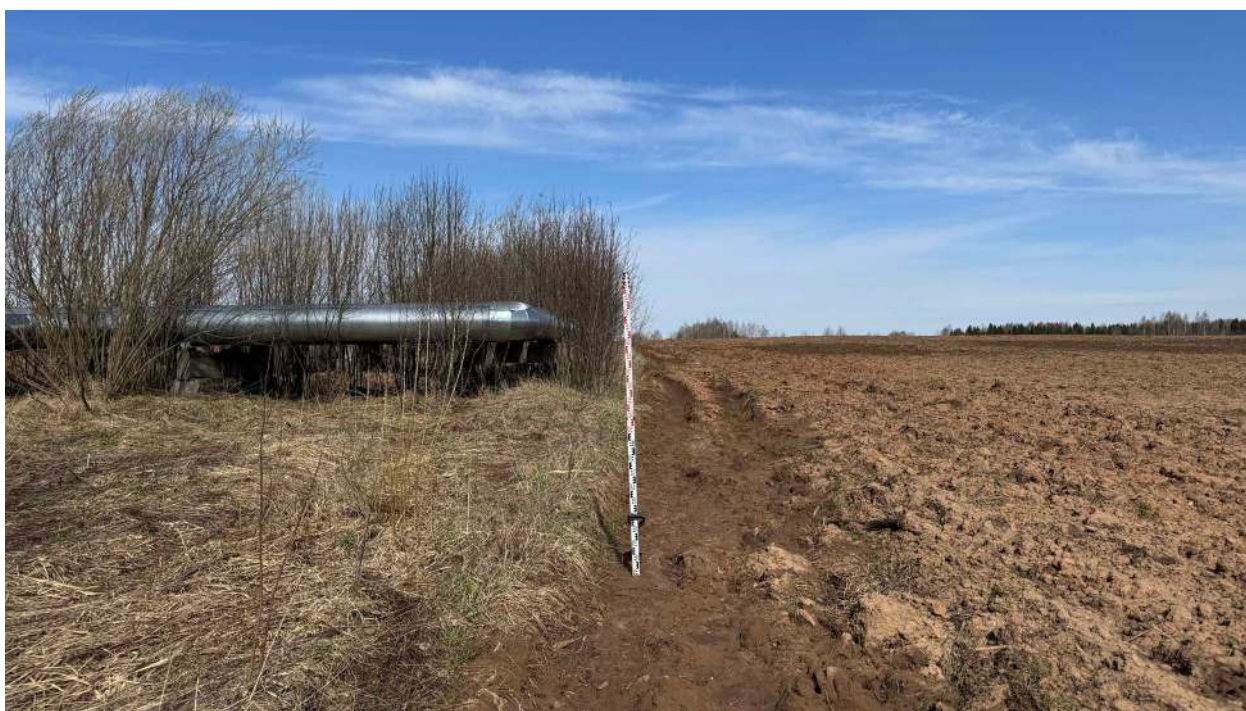
Рис. 87. Фото. Фотофиксация местности на земельных участках в зоне строительства напорного коллектора ОСК Лянгасово – КНС пос. Костино г. Кирова Кировской области. ТФ 28. Вид с юго-востока.
