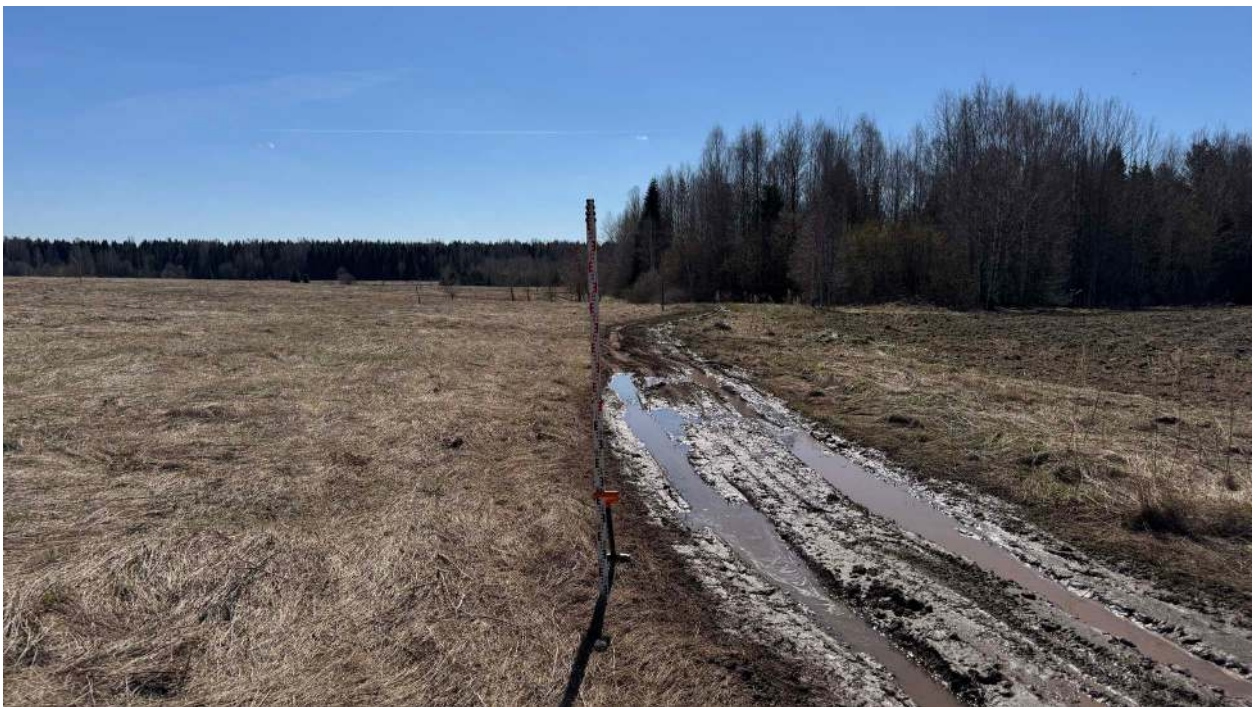
Рис. 69. Фото. Фотофиксация местности на земельных участках в зоне строительства напорного коллектора ОСК Лянгасово – КНС пос. Костино г. Кирова Кировской области. ТФ 18. Вид с северо-востока.
