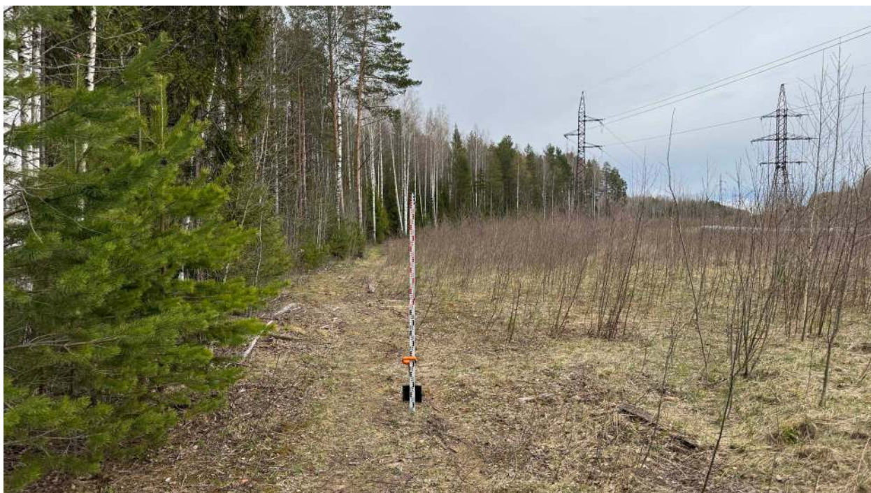
Рис. 84. Фото. Фотофиксация местности на земельных участках в зоне строительства напорного коллектора ОСК Лянгасово – КНС пос. Костино г. Кирова Кировской области. ТФ 26. Вид с северо-запада.
