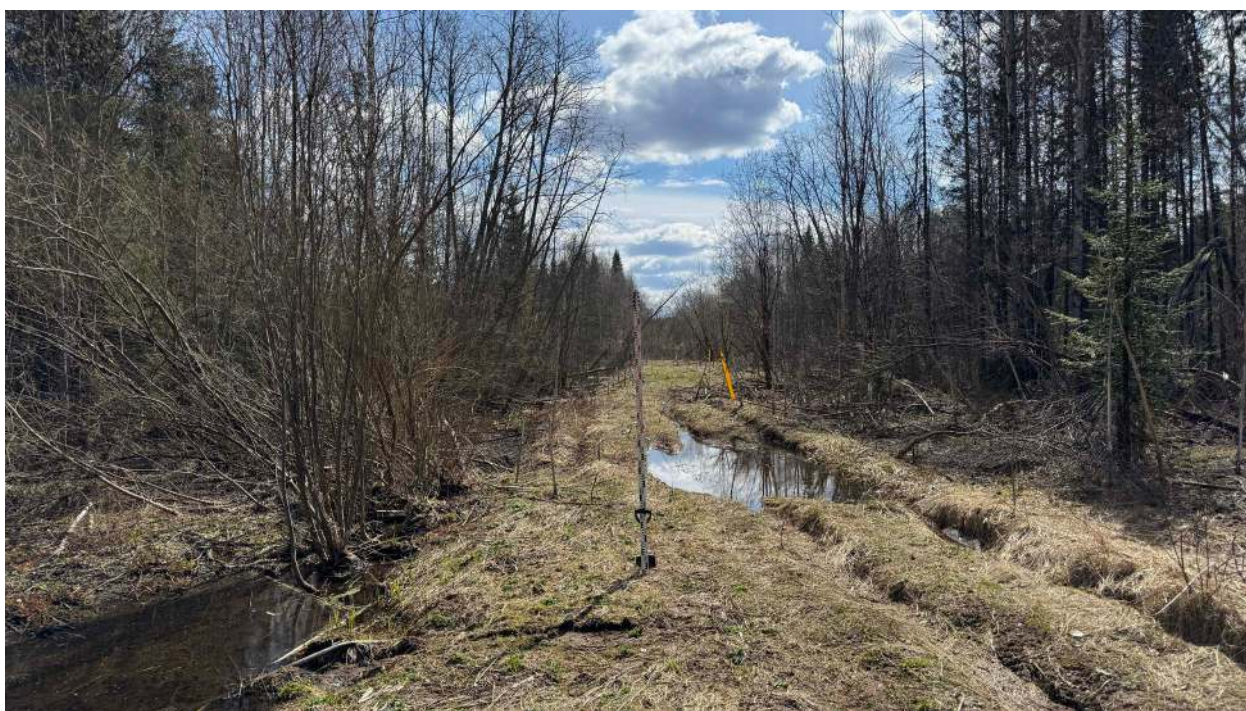
Рис. 61. Фото. Фотофиксация местности на земельных участках в зоне строительства напорного коллектора ОСК Лянгасово – КНС пос. Костино г. Кирова Кировской области. ТФ 13. Вид с северо-запада.
