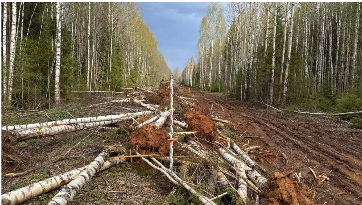
Рис. 62. Фото. Фотофиксация местности на земельных участках в зоне строительства напорного коллектора ОСК Лянгасово – КНС пос. Костино г. Кирова Кировской области. ТФ 14. Вид с юго-востока.
