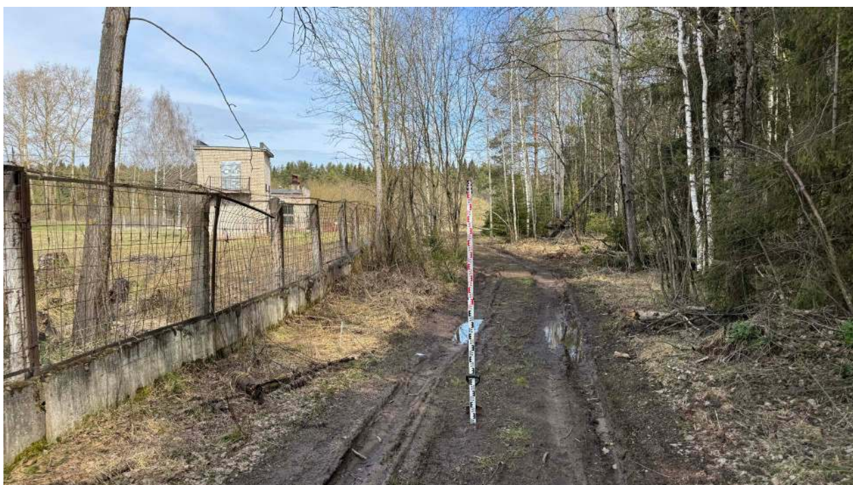
Рис. 93. Фото. Фотофиксация местности на земельных участках в зоне строительства напорного коллектора ОСК Лянгасово – КНС пос. Костино г. Кирова Кировской области. ТФ 31. Вид с юго-востока.
