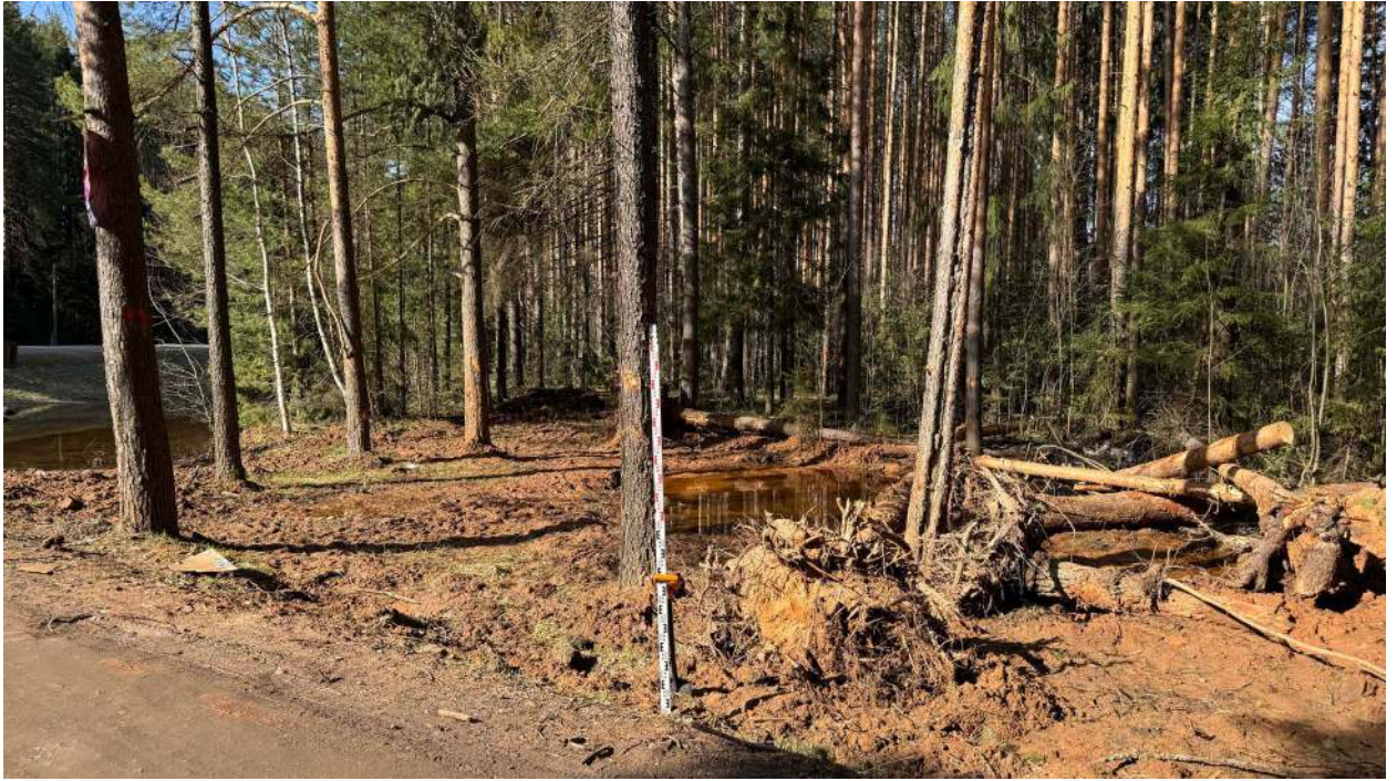
Рис. 42. Фото. Фотофиксация местности на земельных участках в зоне строительства напорного коллектора ОСК Лянгасово – КНС пос. Костино г. Кирова Кировской области. ТФ 4. Вид с северо-востока.
