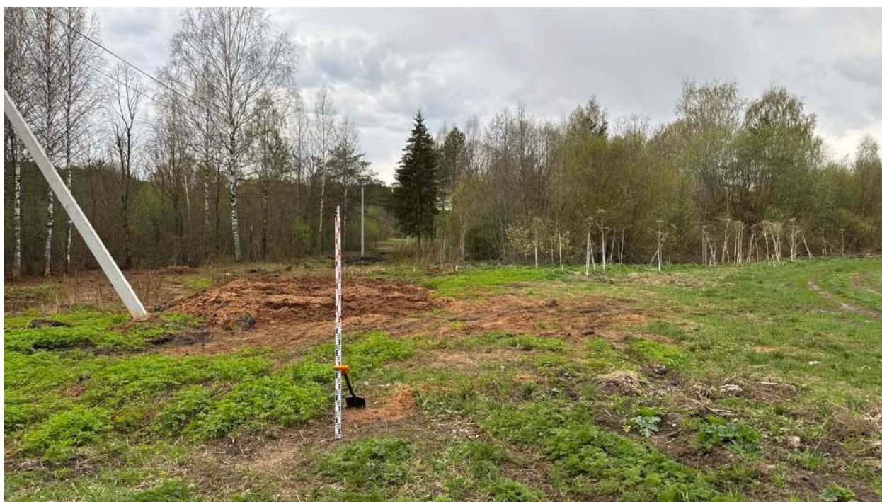
Рис. 45. Фото. Фотофиксация местности на земельных участках в зоне строительства напорного коллектора ОСК Лянгасово – КНС пос. Костино г. Кирова Кировской области. ТФ 5. Вид с северо-востока.
