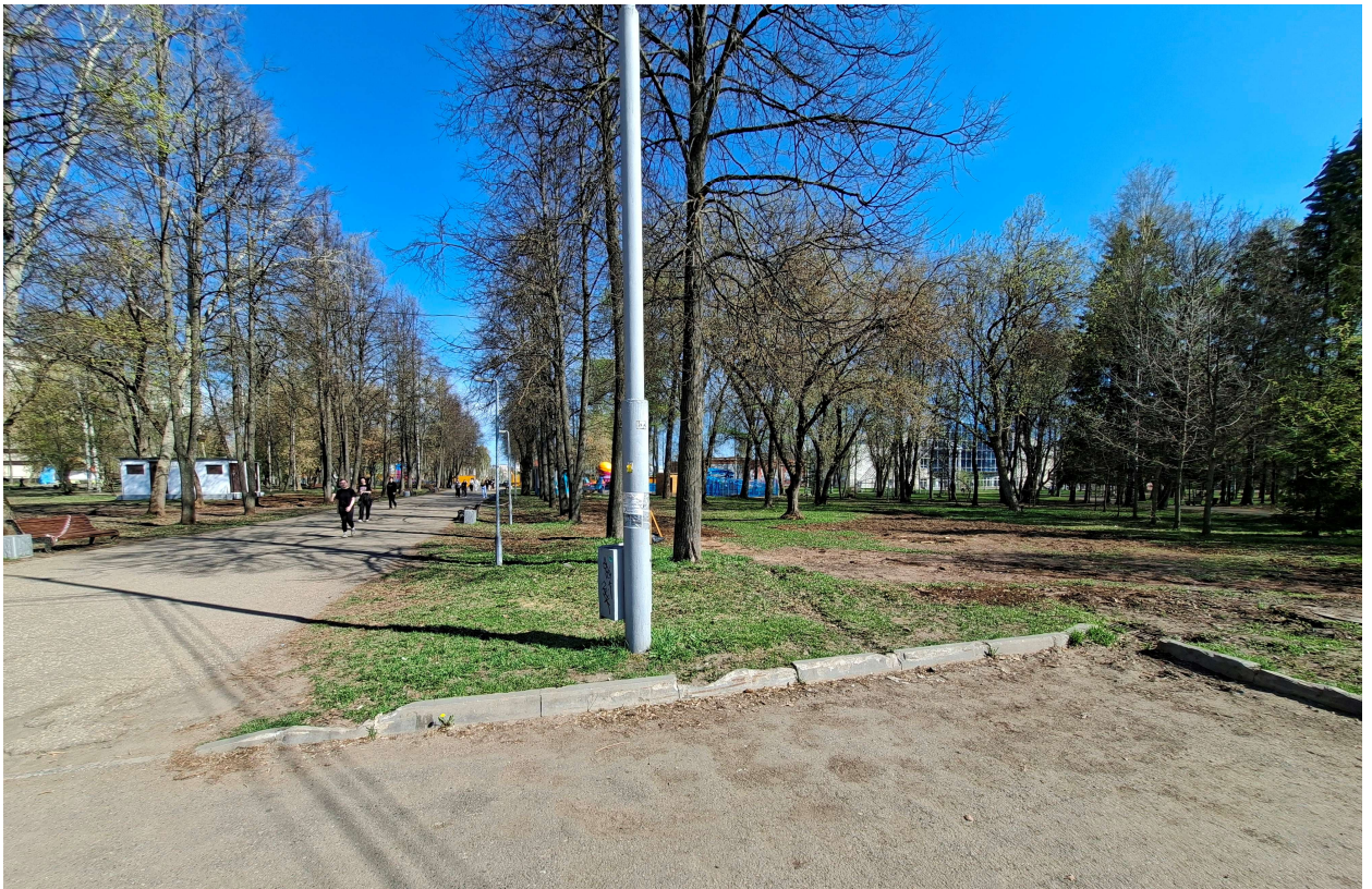
Рис. 21. Общий вид северного участка демонтажа тепловых сетей от ТК5-00 сущ. до ТК5-02 в парке им. Ю. А. Гагарина. Вид с юга.
