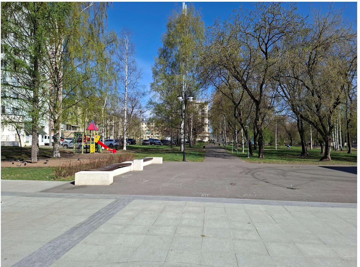
Рис. 24. Общий вид северного участка реконструкции тепловых сетей от ТК6-66 до ТК5-02 в парке им. Ю. А. Гагарина. Вид с юга.
