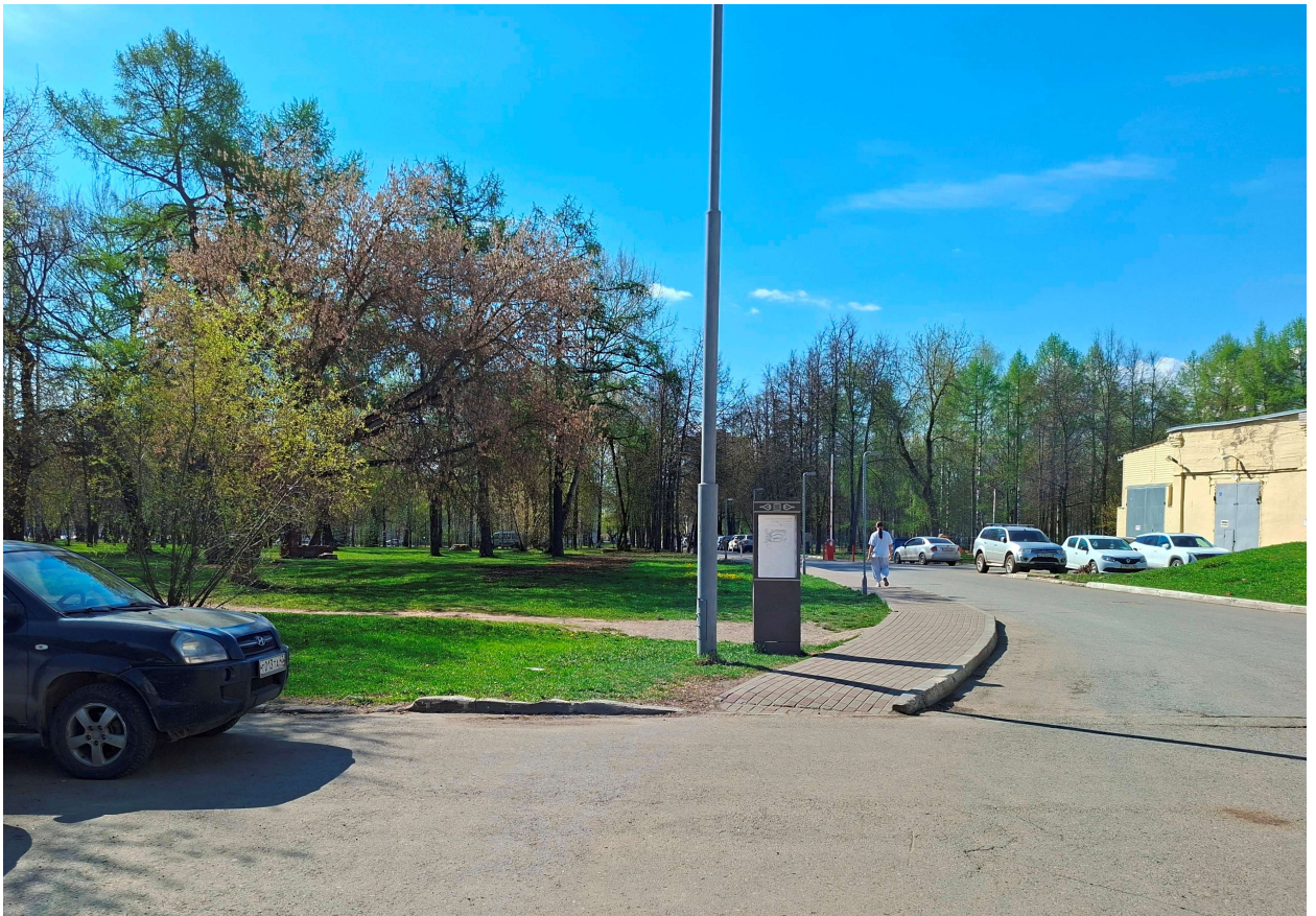
Рис. 23. Общий вид южного участка демонтажа тепловых сетей от ТК5-00 сущ. до ТК5-02 в парке им. Ю. А. Гагарина. Вид с севера.
