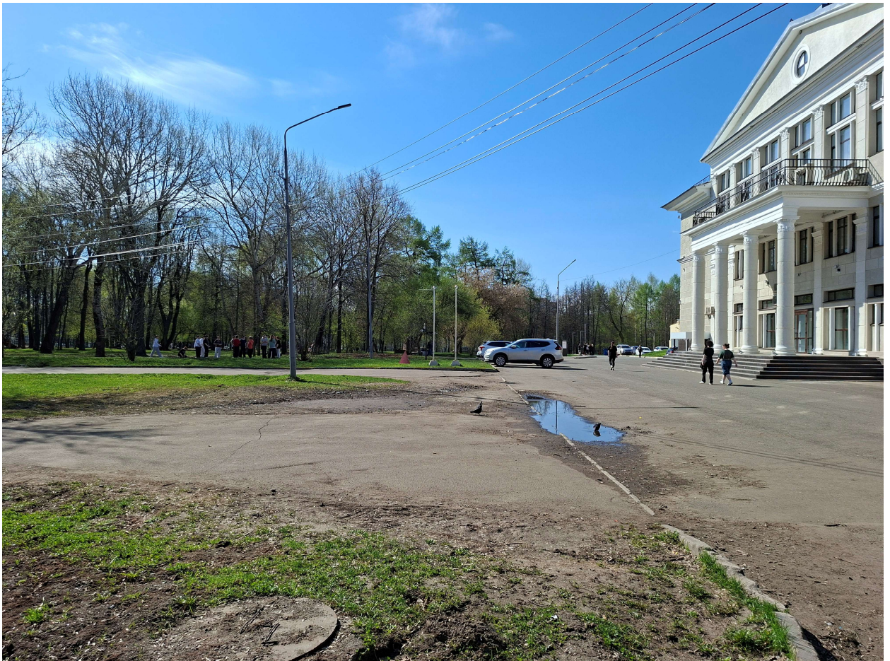
Рис. 22. Общий вид центрального участка демонтажа тепловых сетей от ТК5-00 сущ. до ТК5-02 в парке им. Ю. А. Гагарина. Вид с севера.
