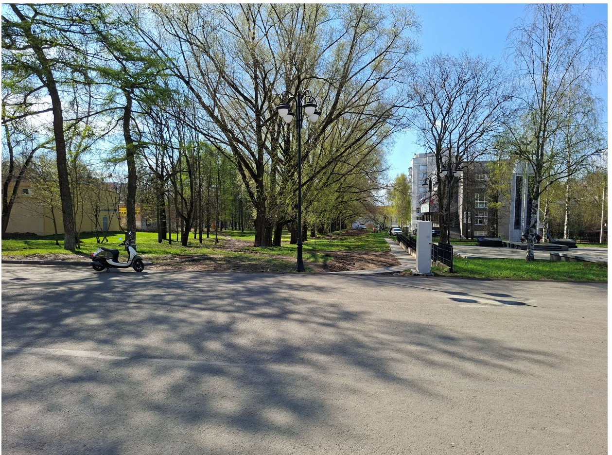
Рис. 26. Общий вид южного участка реконструкции тепловых сетей от ТК6-66 до ТК5-02 в парке им. Ю. А. Гагарина. Вид с севера.
