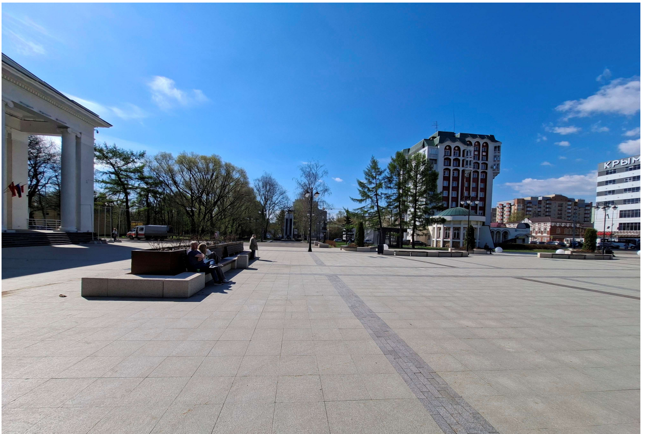
Рис. 25. Общий вид центрального участка реконструкции тепловых сетей от ТК6-66 до ТК5-02 в парке им. Ю. А. Гагарина. Вид с севера.
