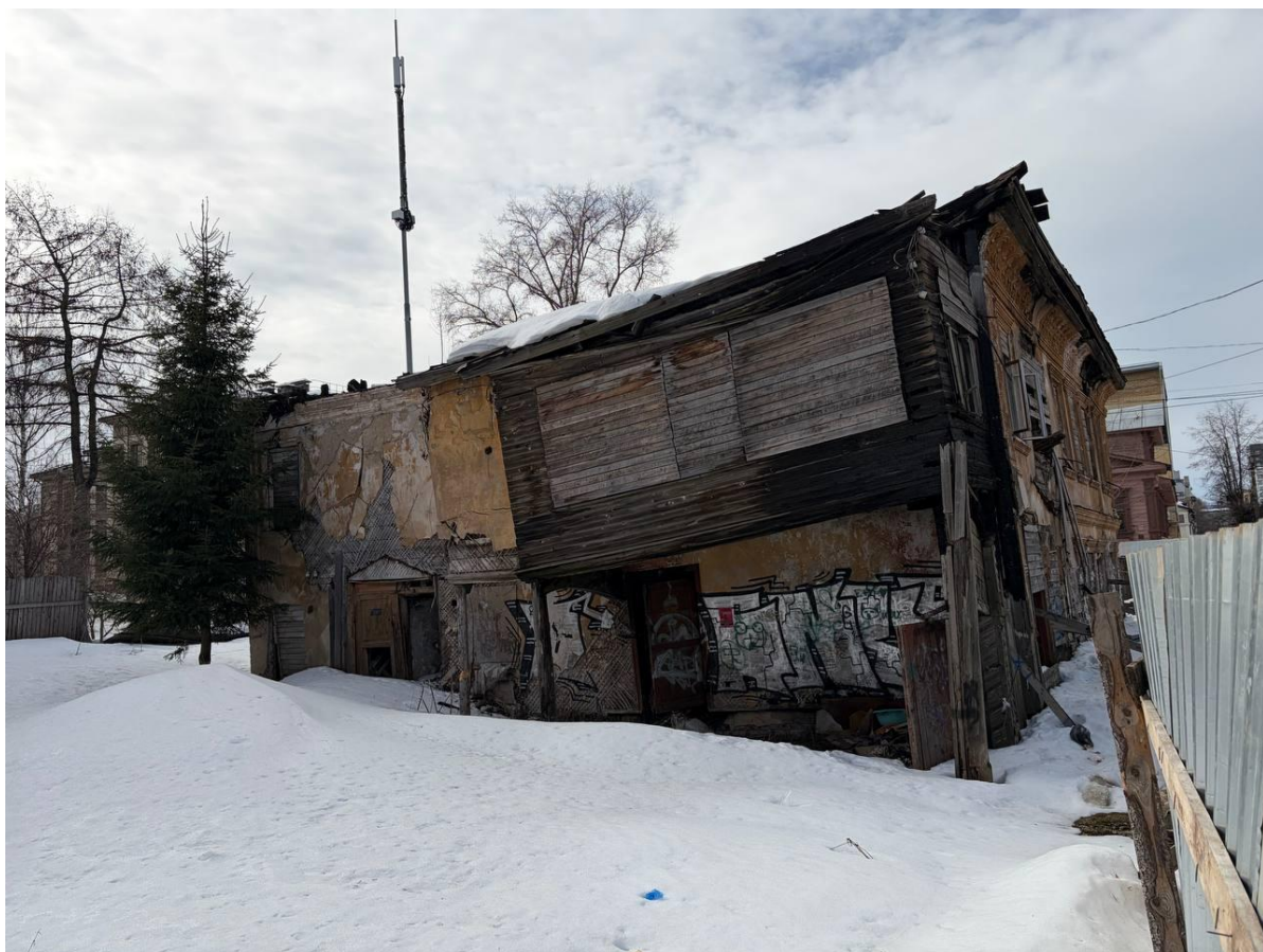
Фото 5. Вид с юга. 10.03.2026
