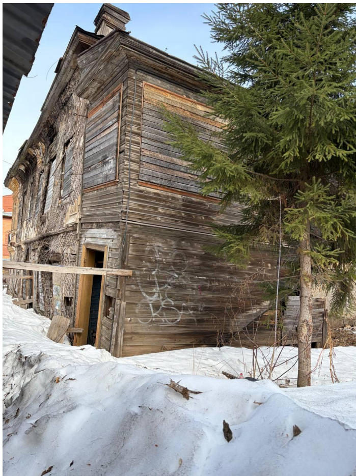
Фото15. Вид с юго-востока. 10.03.2026
