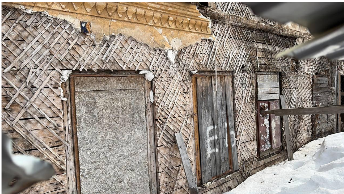
Фото11. Вид востока. Фрагмент фасада. 10.03.2026
