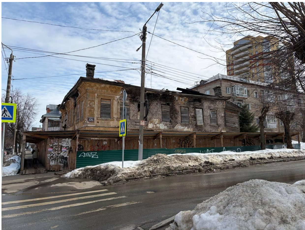
Фото 7. Вид с северо-запада. 10.03.2026
