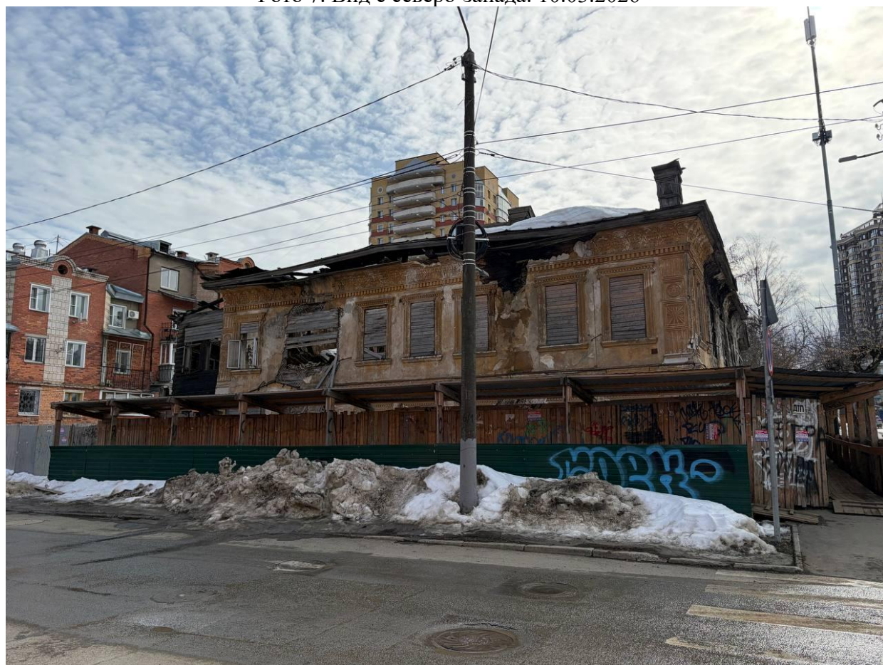
Фото 8. Вид с севера. 10.03.2026
