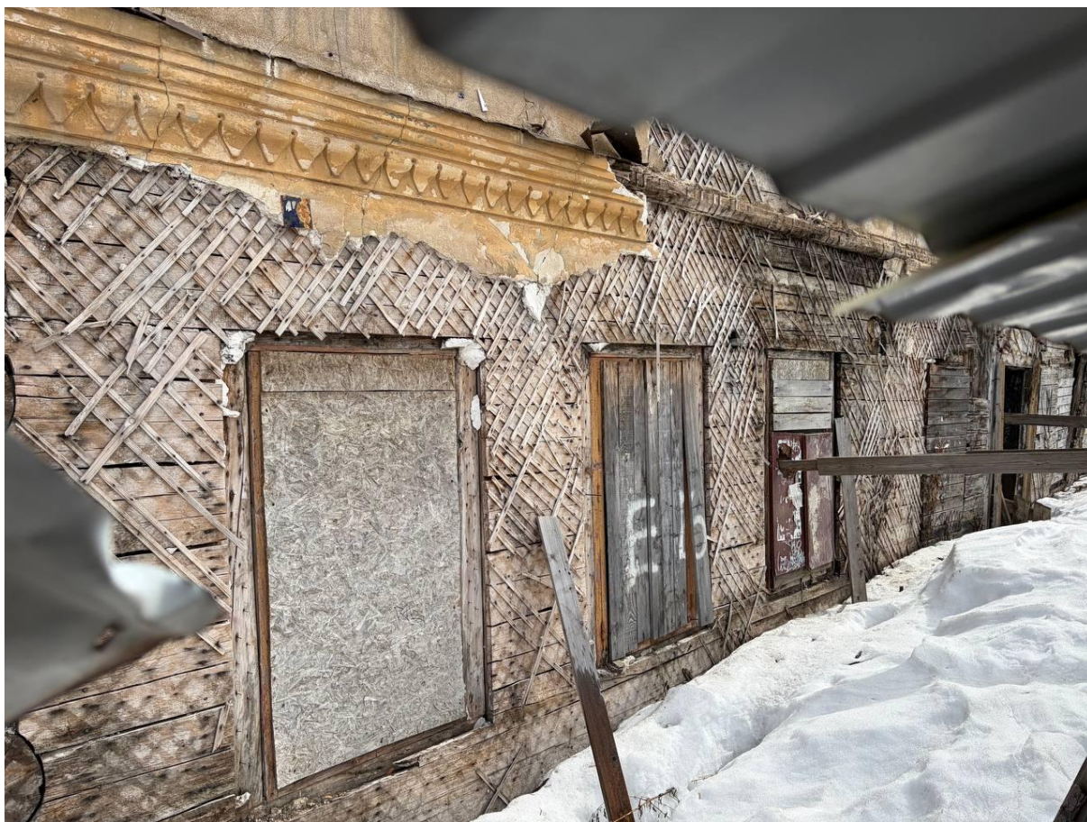
Фото 9. Вид с северо-запада. Фрагмент фасада. 10.03.2026
