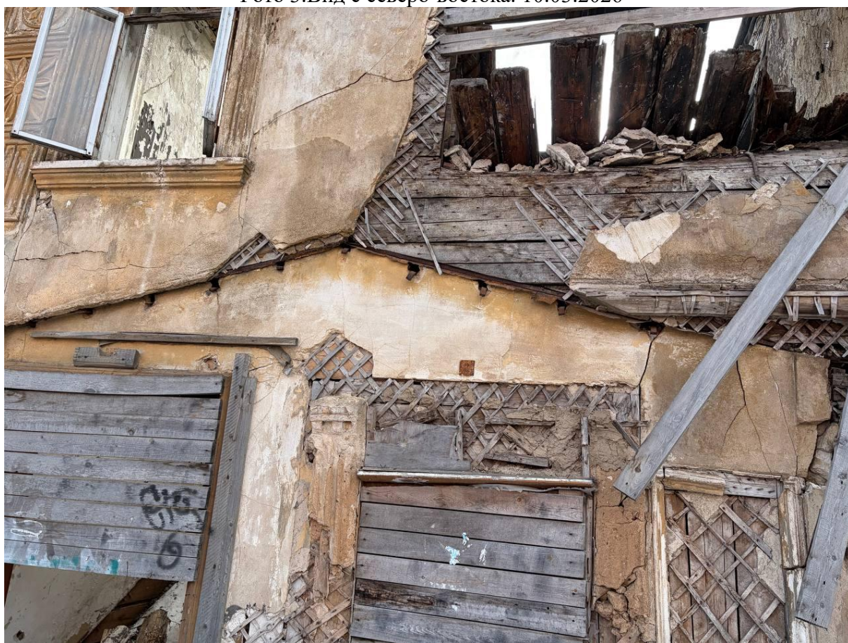
Фото 4. Вид с севера. Фрагмент фасада. 10.03.2026
