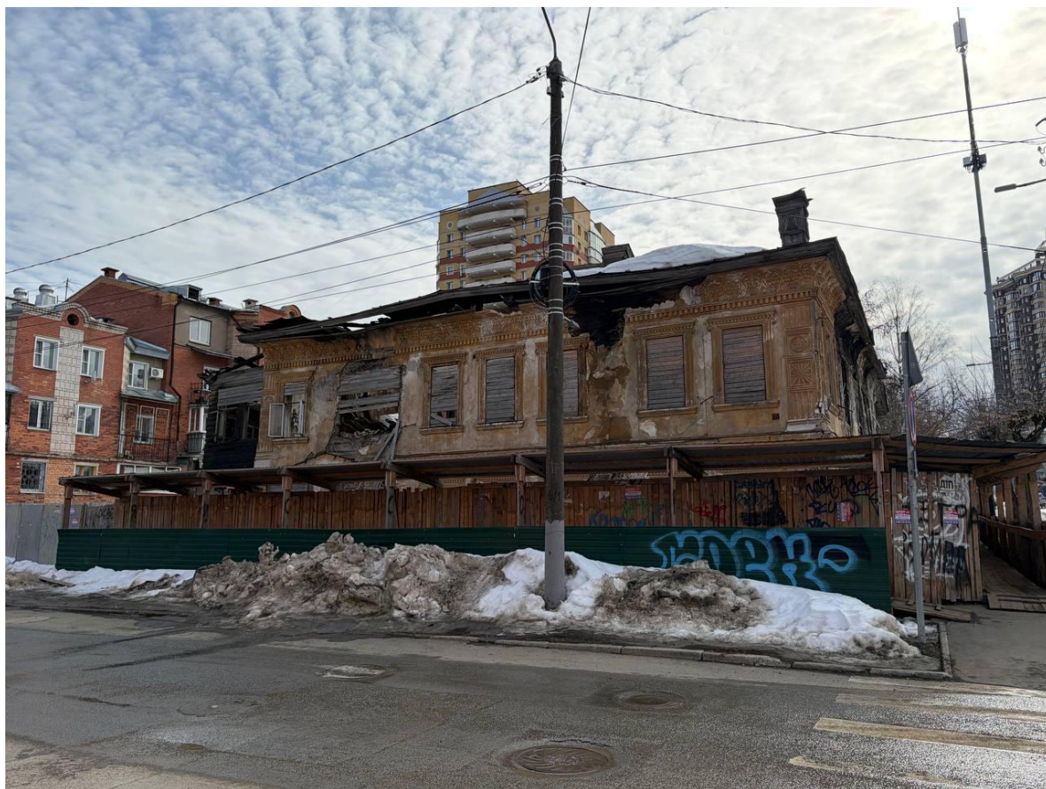
Фото13. Вид с севера. 10.03.2026
