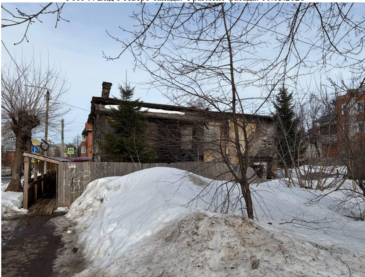
Фото10. Вид с юга. 10.03.2026
