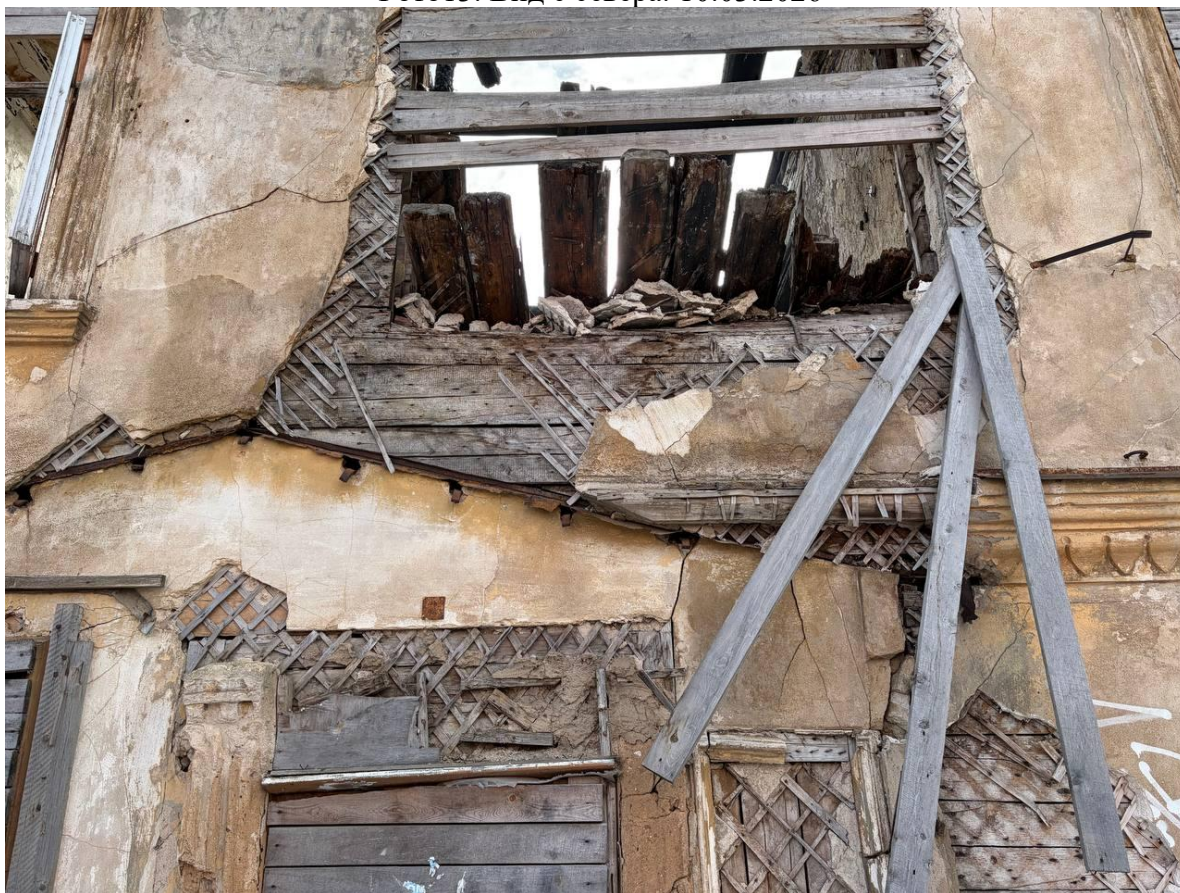
Фото14. Вид с севера. Фрагмент фасада 10.03.2026
