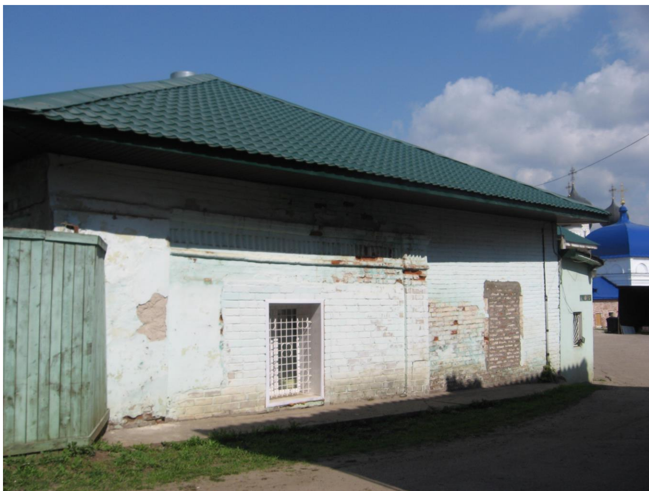
Фото 6. Южный фасад. Вид с юго-запада. Дата съемки – 2016 г.
