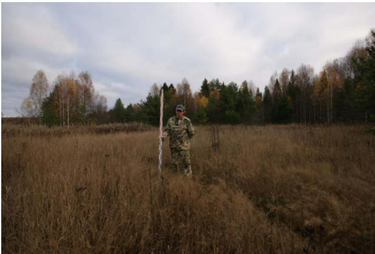
Рис. 40. Археологическая разведка по маршруту строительства автодороги с. Ключи - р. Литовка в Шабалинском районе Кировской области в 2022 г. Шурф № 2. Общий вид до начала работ. Вид с юга.
